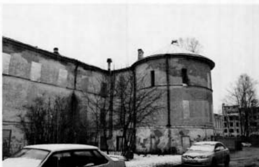
Фото №15. Вид на северную башню со стороны сада.
