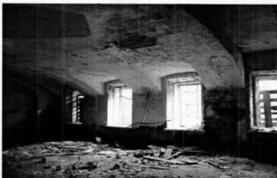
Фото №12. Помещение 1-го этажа южного корпуса.
