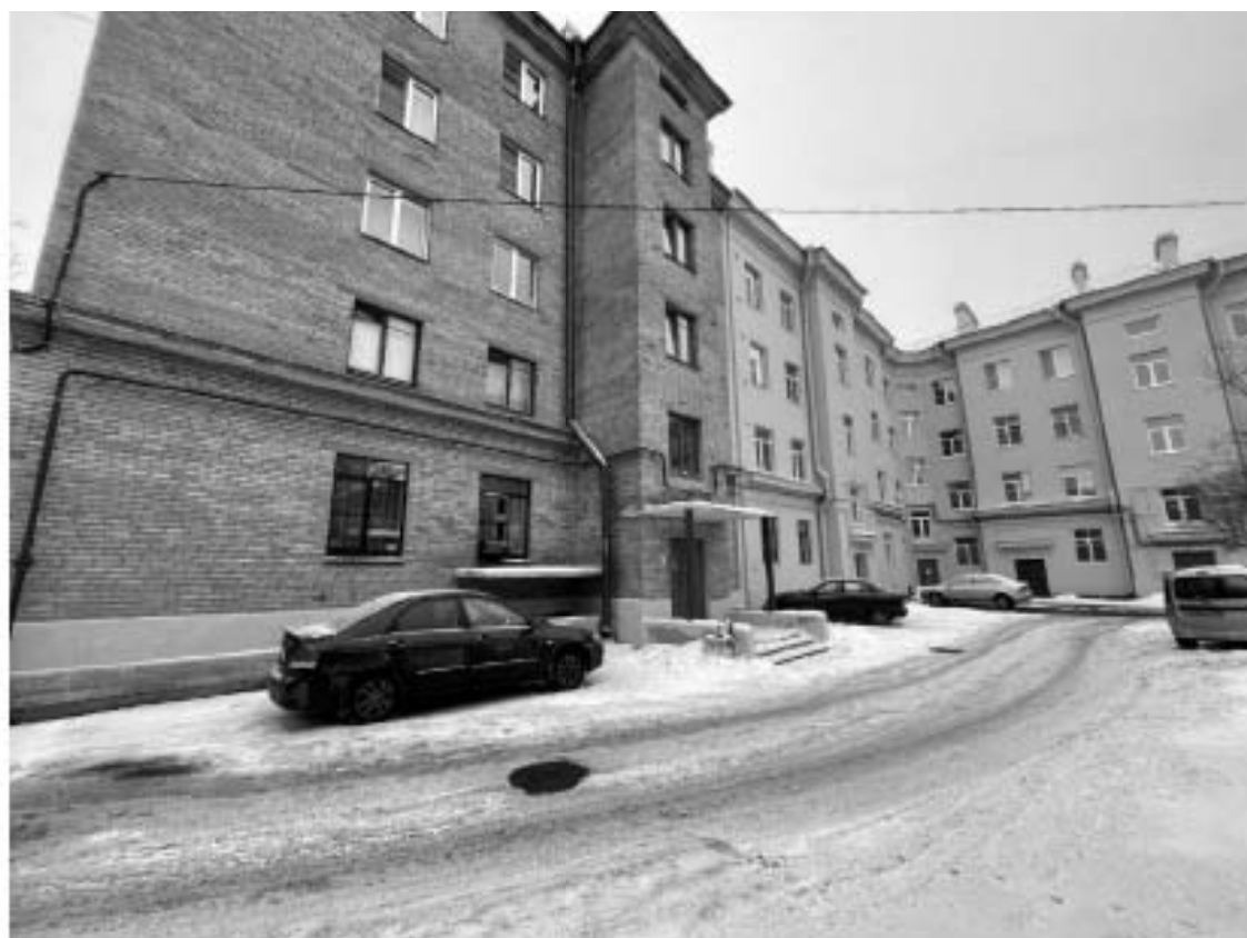
Фото 30. Участок производства работ.
