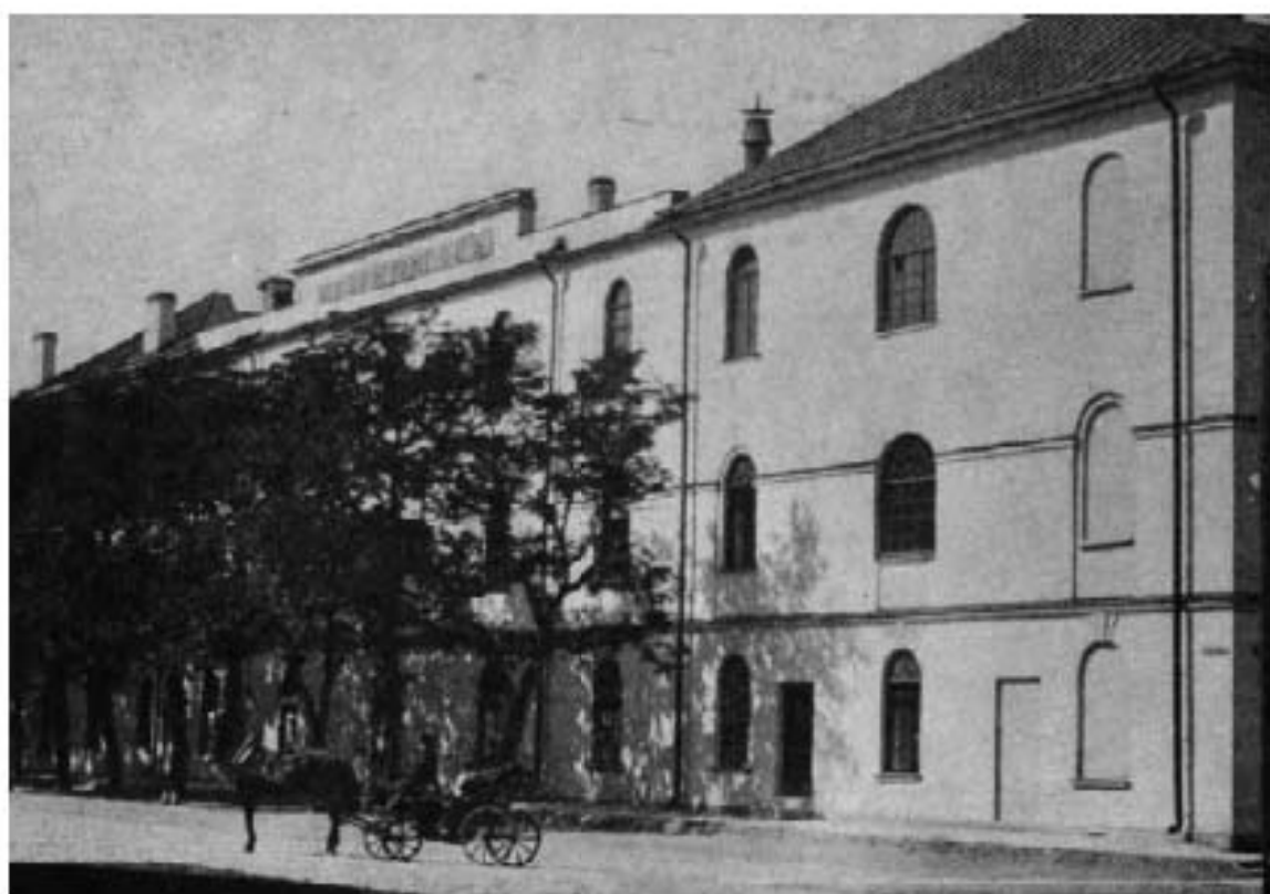
Илл. 19. Школа юнгов. Фото 1910-1914 гг. Объект культурного наследия федерального значения «Дом губернский 7-й» и «Образцовая казарма». Retro View of Mankind's Habitat [Электронный ресурс]. Режим доступа: https://pastvu.com/ .
