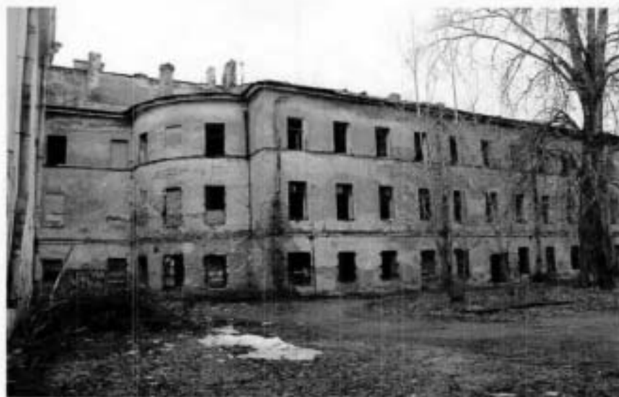
Фото №10. Вид на восточный фасад южного корпуса со стороны сада.
