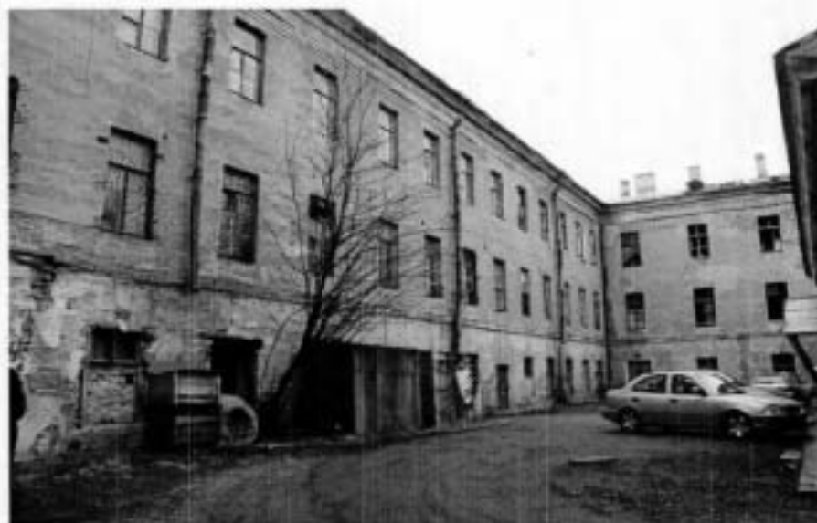
Фото №4. Вид на восточный и северный фасады западного корпуса со стороны двора.
