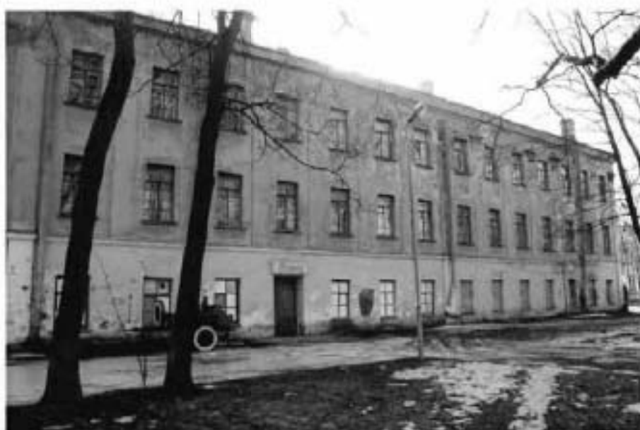
Фото №3. Вид на западный фасад со стороны сада.
