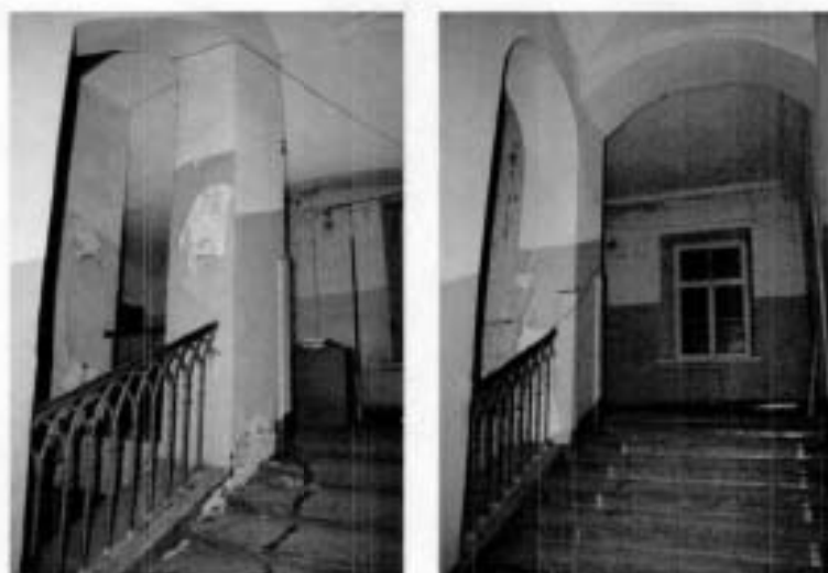
Фото №20, 21. Лестница северного корпуса.
