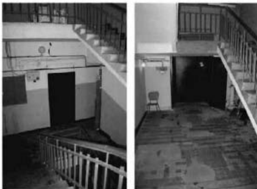
Фото №5, 6. Лестничные клетки.
