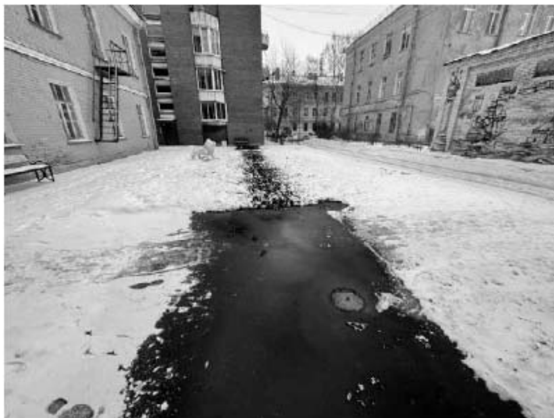
Фото 4. Участок производства работ
