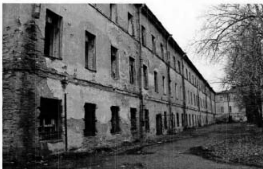
Фото №11. Вид на восточный фасад южного корпуса со стороны сада.
