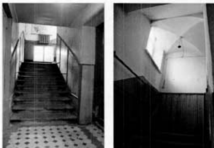
Фото №6, 7. Лестница западного корпуса.
