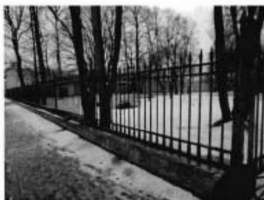
1. Ограда. Вид со стороны Макаровской ул.
