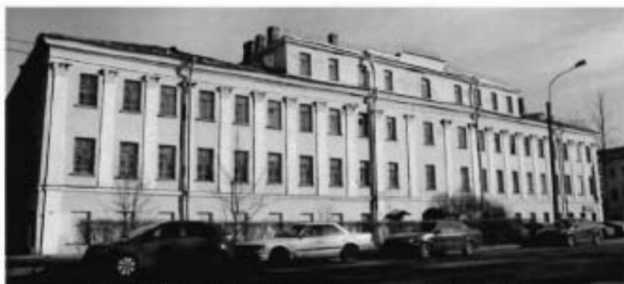
Фото №1. Вид на лицевой (южный) фасад со стороны Макаровской ул.
