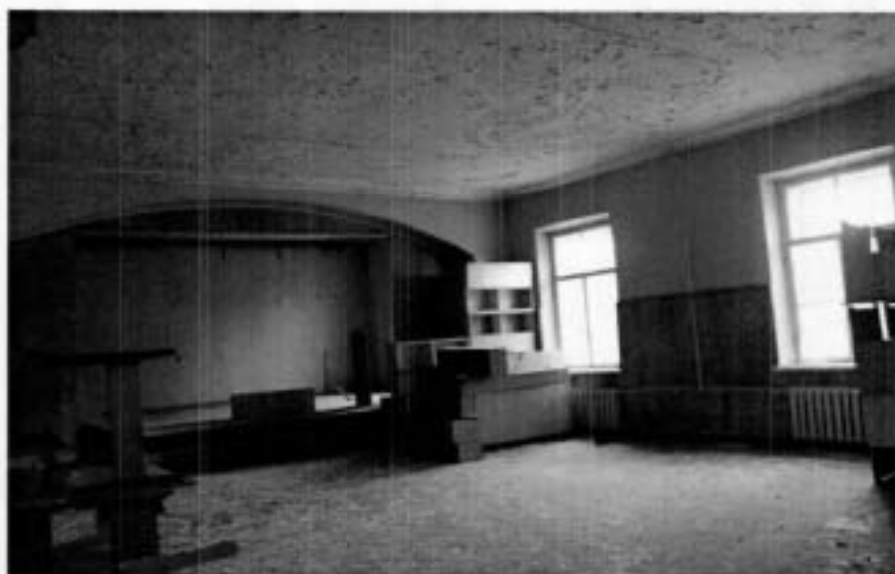
Фото №19. Помещение 3-го этажа северного корпуса.
