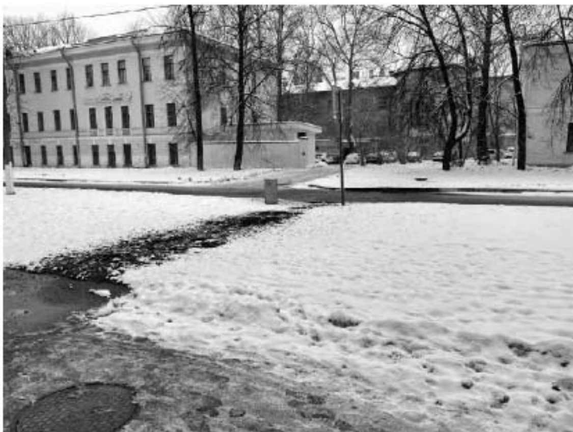
Фото 31. Участок производства работ.
