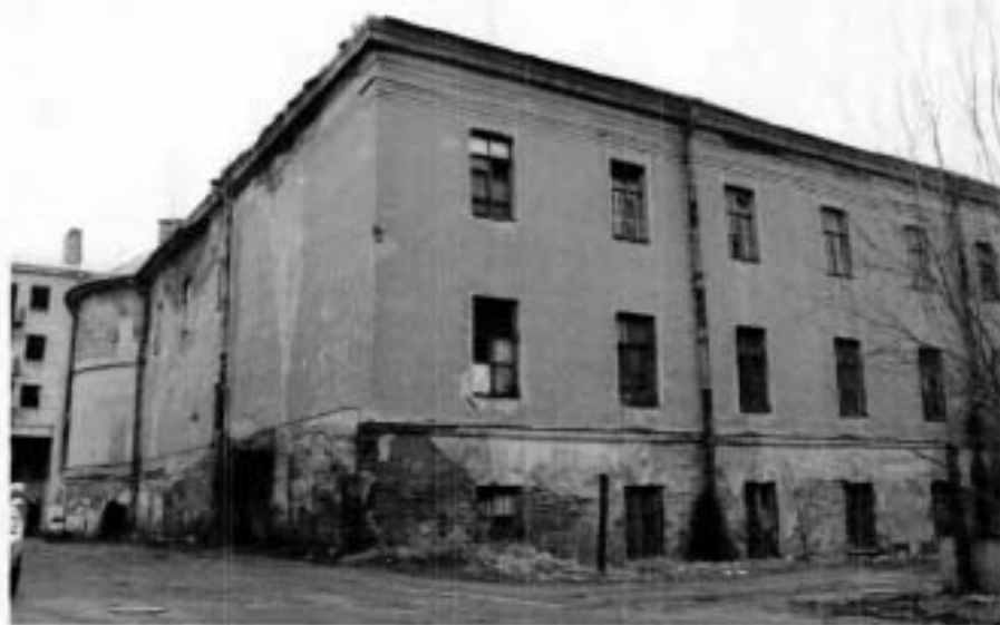
Фото №16. Вид на серверный и западный фасады северного корпуса.
