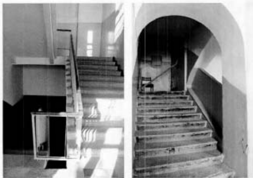
Фото №8, 9. Лестничные марши.
