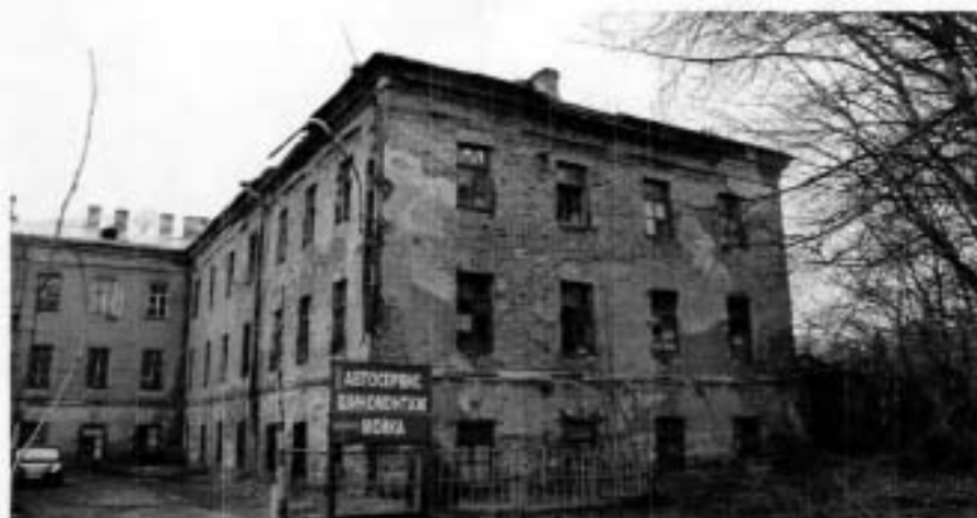
Фото №3. Вид на восточный и северные фасады западного корпуса со стороны двора.
