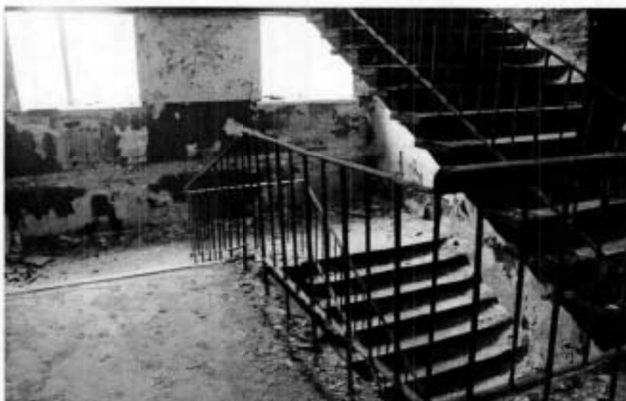
Фото №13. Лестница южного корпуса.
