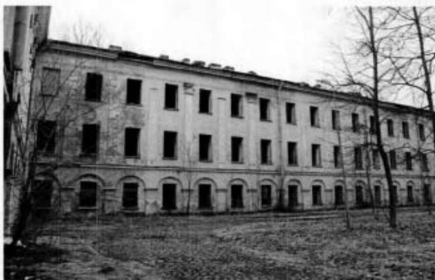
Фото №9. Вид на западный фасад южного корпуса со стороны сада.
