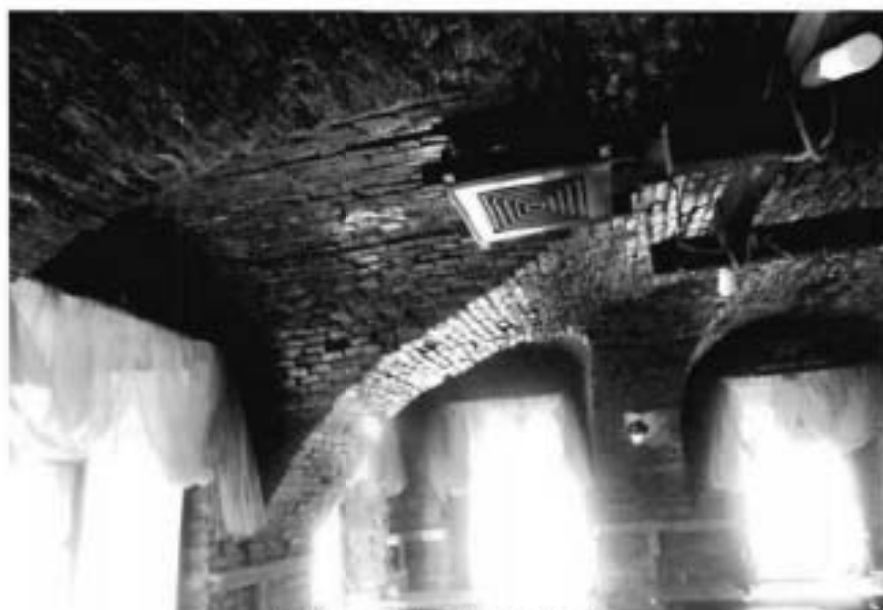
Фото №11. Помещение 1-Н 1-го этажа.
