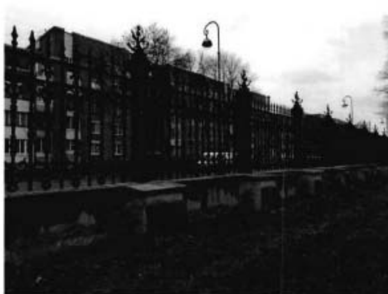
2. Фрагмент ограды. Вид со стороны сада.
