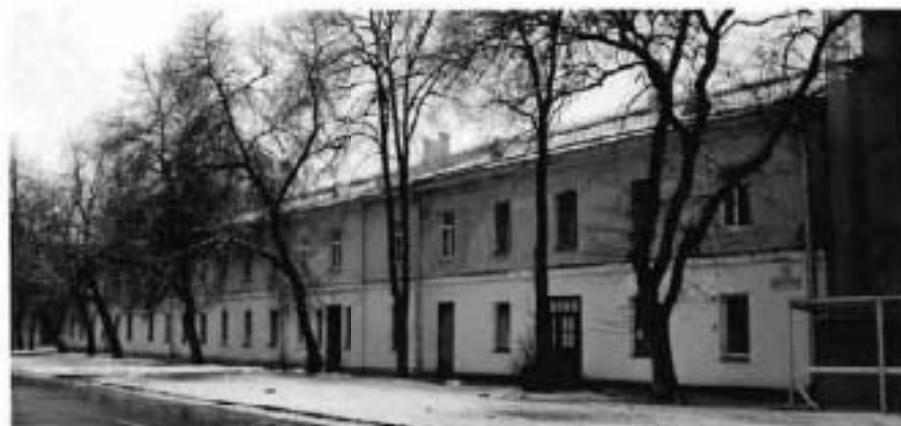
Фото №2. Вид на заднюю (восточный) фасад со стороны Коммунистической ул.
