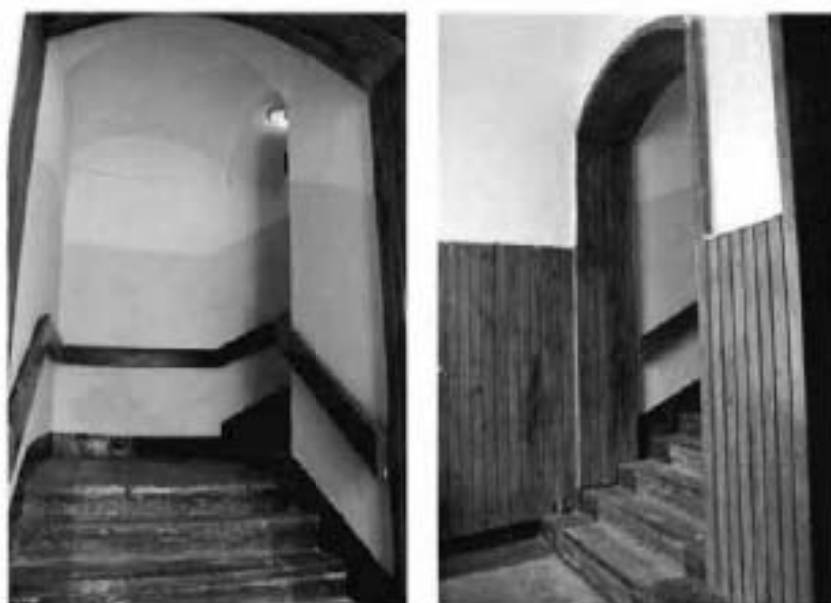
Фото №9, 10. Центральная лестница пом. 4-Н.
