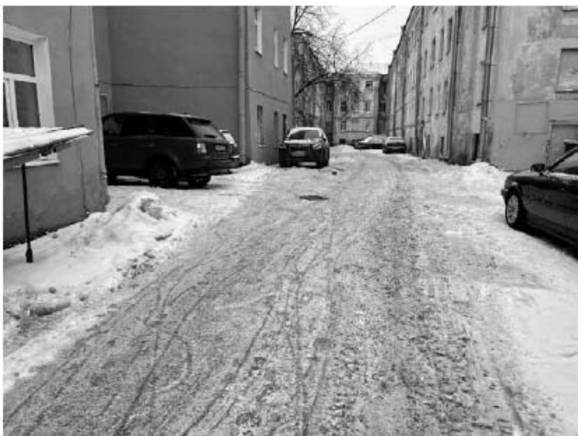
Фото 27. Участок производства работ.
