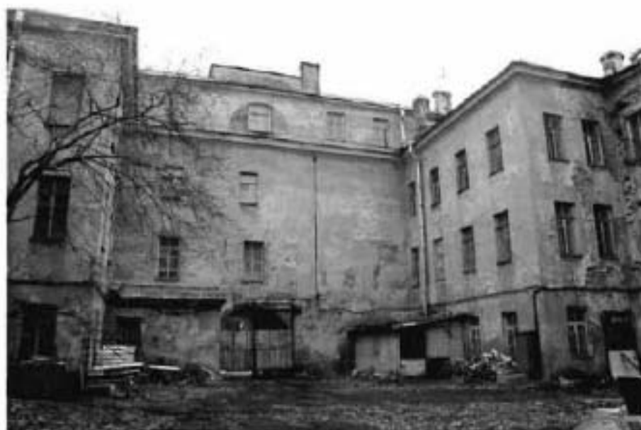
Фото №5. Вид на северный фасад со стороны внутреннего двора.
