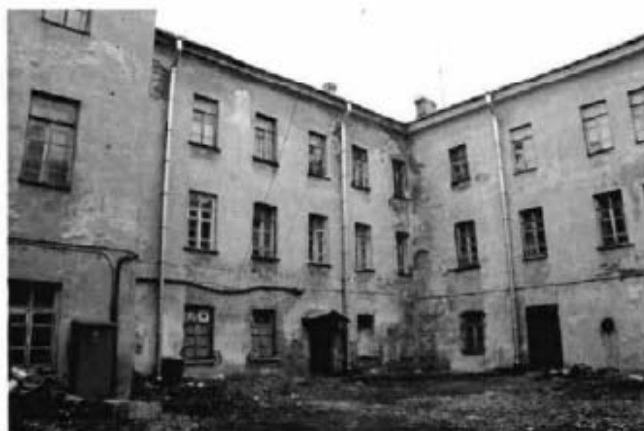
Фото №6. Вид на северный и западный фасады со стороны внутреннего двора.
