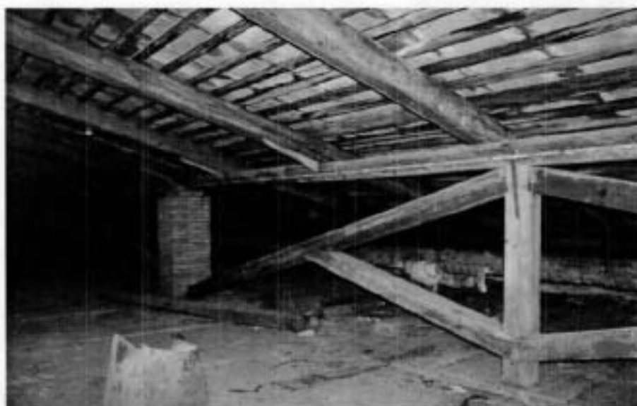
Фото №22. Чердак северного корпуса.
