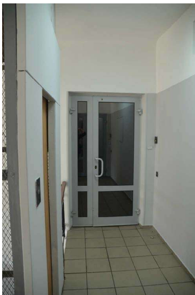
Фото 44. Выявленный объект культурного наследия «Дом П. М. Станового», расположенный по адресу Санкт-Петербург, 8-я Советская улица, д. 48, литера А. Вид площадки 6-го этажа. Съемка 26.04.2021. Егорова Т. Г.
