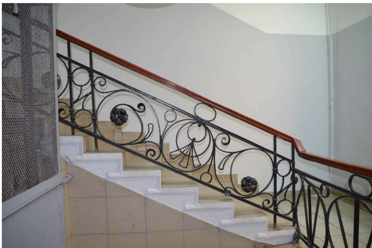
Фото 48. Выявленный объект культурного наследия «Дом П. М. Станового», расположенный по адресу Санкт-Петербург, 8-я Советская улица, д. 48, литера А. Вид ограждения лестницы (по Мытнинской ул.). Съемка 26.04.2021.Егорова Т. Г.
