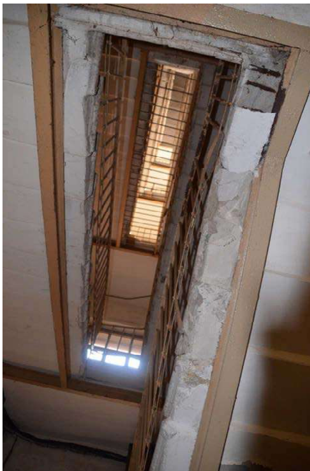
Фото 66. Выявленный объект культурного наследия «Дом П. М. Станового», расположенный по адресу Санкт-Петербург, 8-я Советская улица, д. 48, литера А. Общий вид черной лестницы. Съемка 26.04.2021.Егорова Т. Г.
