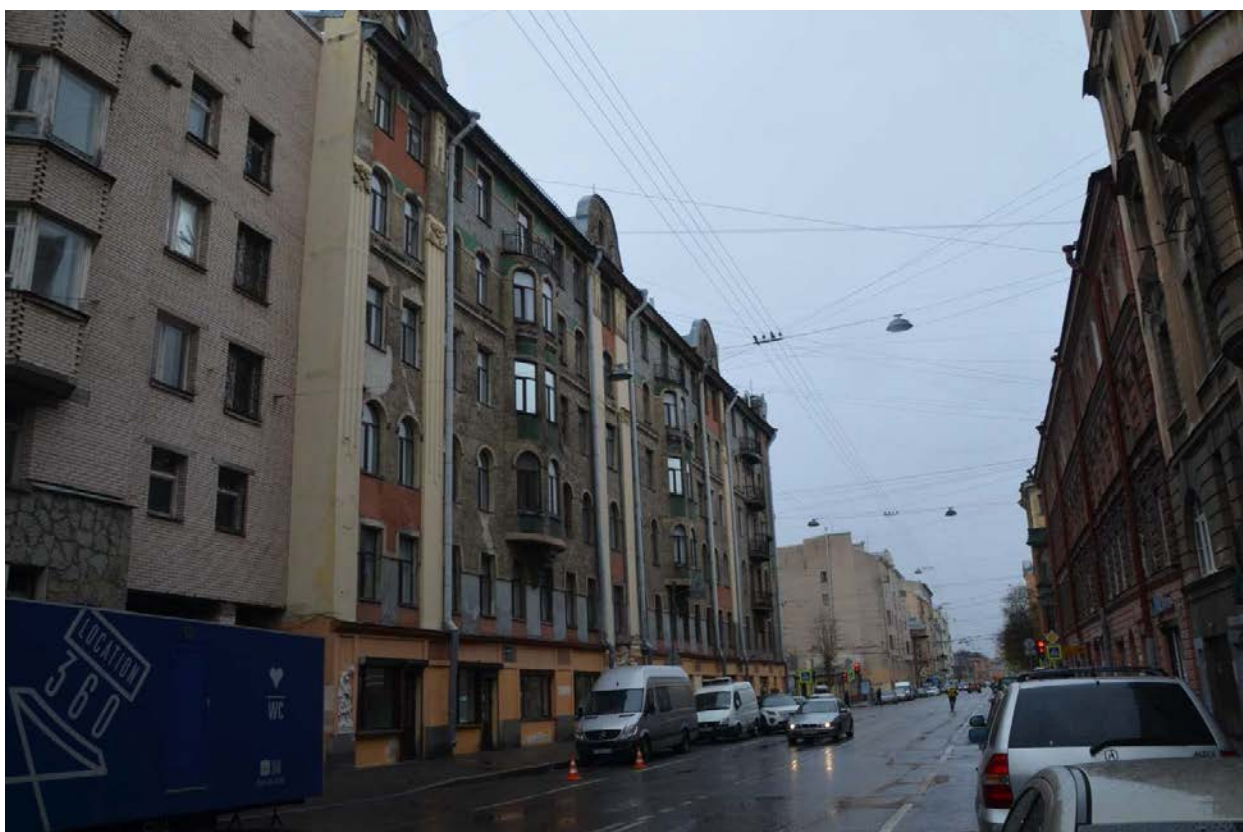
Фото 06. Выявленный объект культурного наследия «Дом П. М. Станового», расположенный по адресу Санкт-Петербург, 8-я Советская улица, д. 48, литера А. Общий вид западного фасада. Съемка 26.04.2021. Егорова Т. Г.
