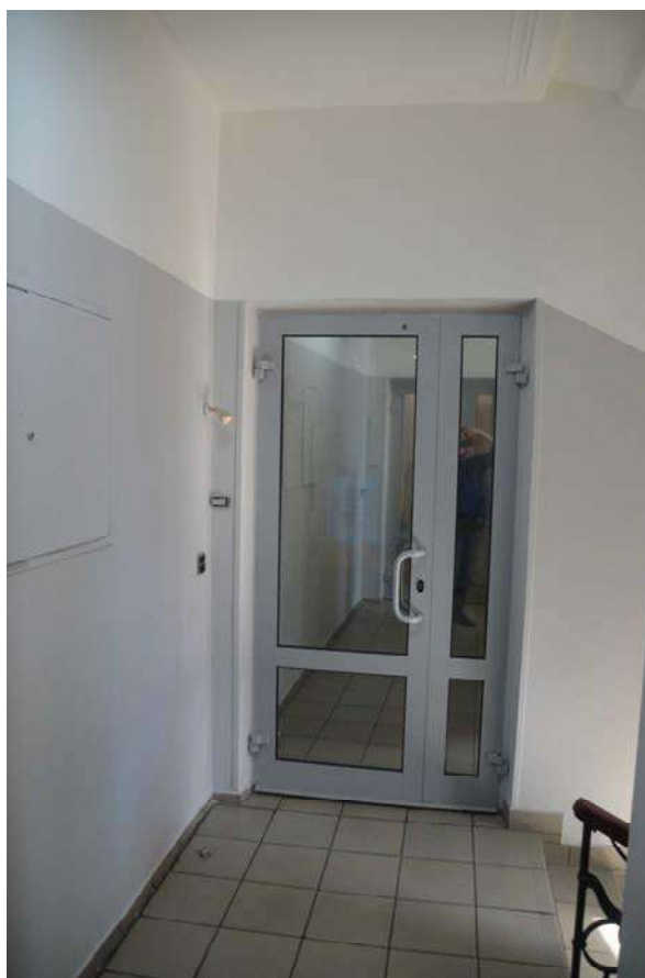
Фото 39. Выявленный объект культурного наследия «Дом П. М. Станового», расположенный по адресу Санкт-Петербург, 8-я Советская улица, д. 48, литера А. Вид площадки 5-го этажа. Съемка 26.04.2021. Егорова Т. Г.
