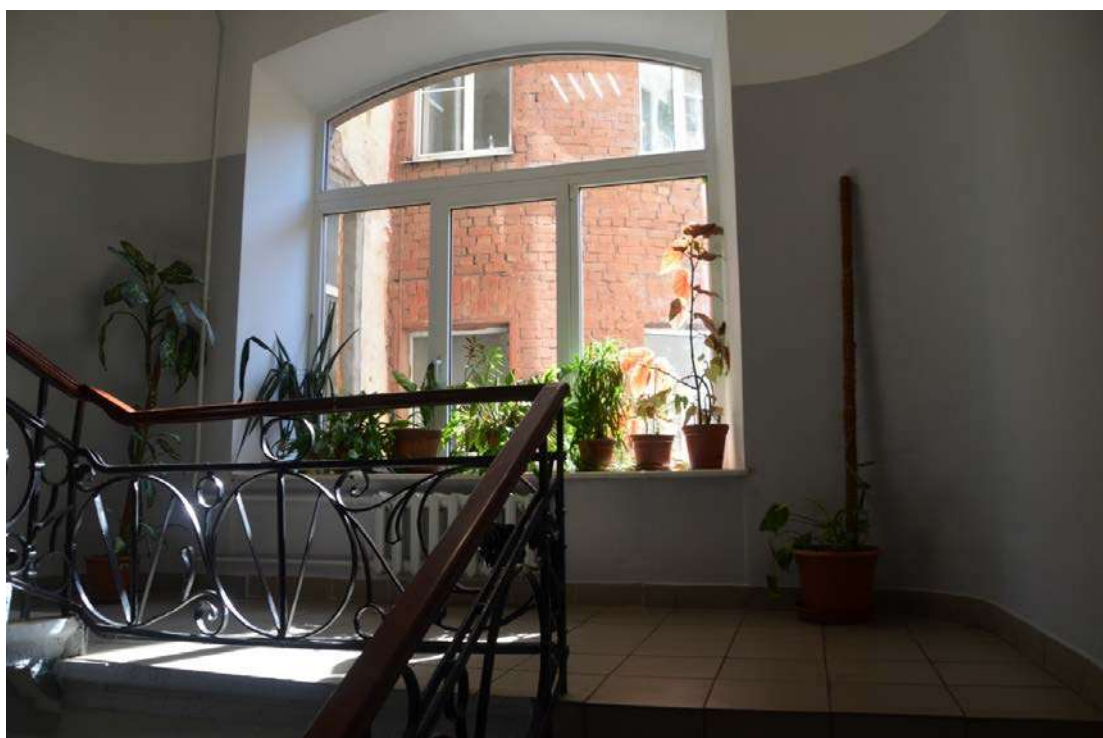
Фото 30. Выявленный объект культурного наследия «Дом П. М.. Станового», расположенный по адресу Санкт-Петербург, 8-я Советская улица, д. 48, литера А. Вид лестницы (по Мытнинской ул.). Съемка 26.04.2021. Егорова Т. Г.
