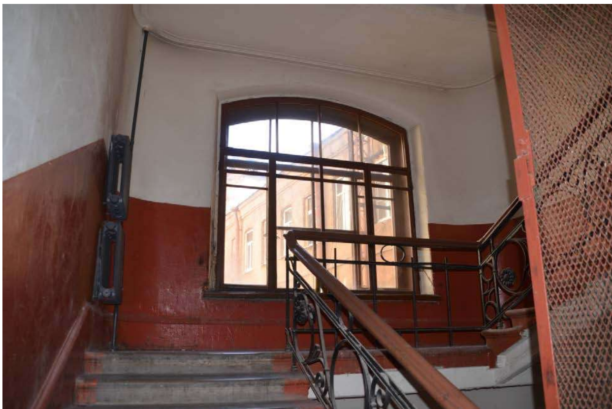
Фото 58. Выявленный объект культурного наследия «Дом П. М. Станового», расположенный по адресу Санкт-Петербург, 8-я Советская улица, д. 48, литера А. Вид лестницы. Съемка 26.04.2021.Егорова Т. Г.
