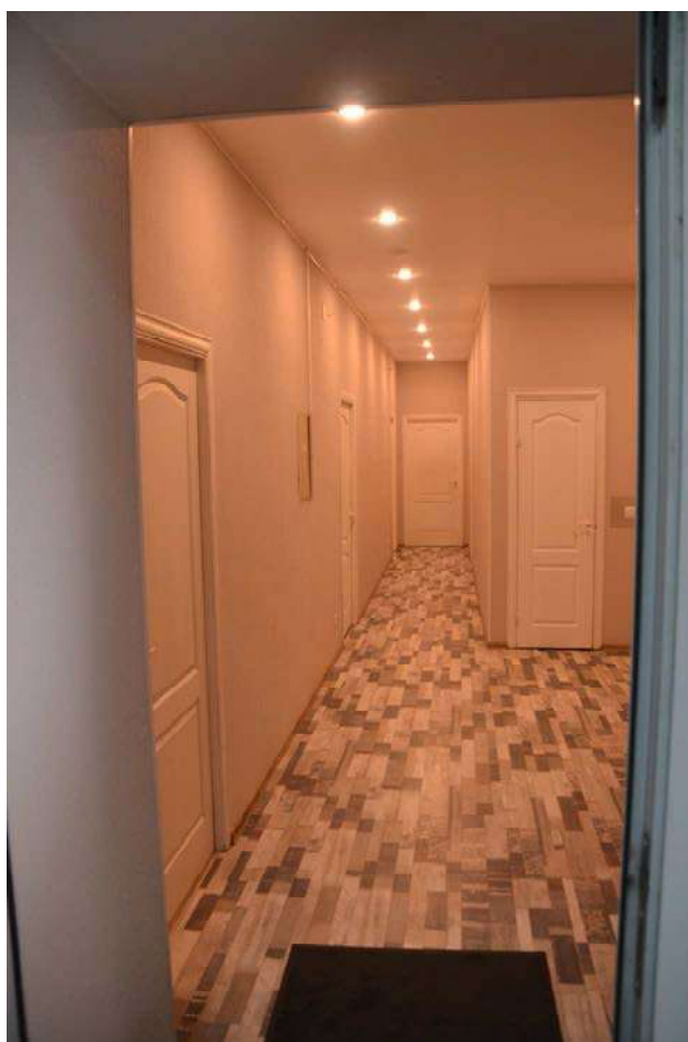
Фото 29. Выявленный объект культурного наследия «Дом П. М. Станового», расположенный по адресу Санкт-Петербург, 8-я Советская улица, д. 48, литера А. Вид коридора 3-го этажа. Съемка 26.04.2021. Егорова Т. Г.
