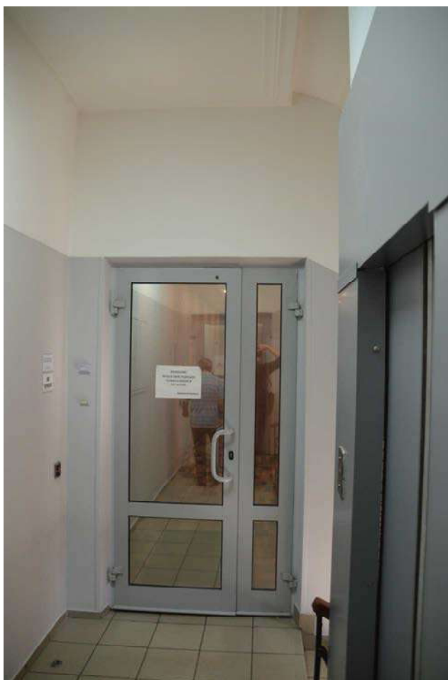
Фото 27. Выявленный объект культурного наследия «Дом П. М. Станового», расположенный по адресу Санкт-Петербург, 8-я Советская улица, д. 48, литера А. Вид площадки 3-го этажа. Съемка 26.04.2021. Егорова Т. Г.
