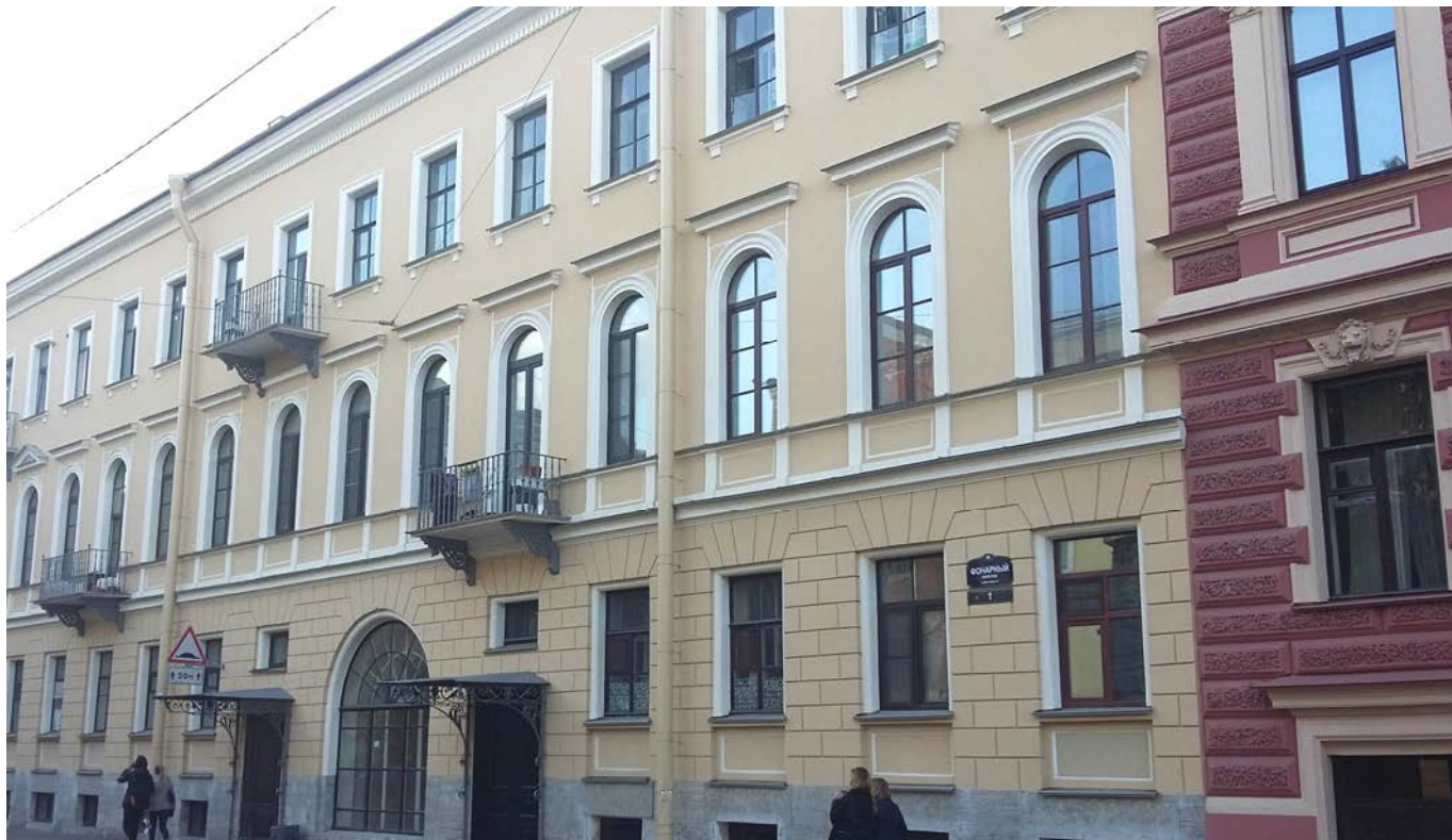
2. Доходные дома М.С. Воронина. Вид на лицевые фасады по Фонарному переулку.
