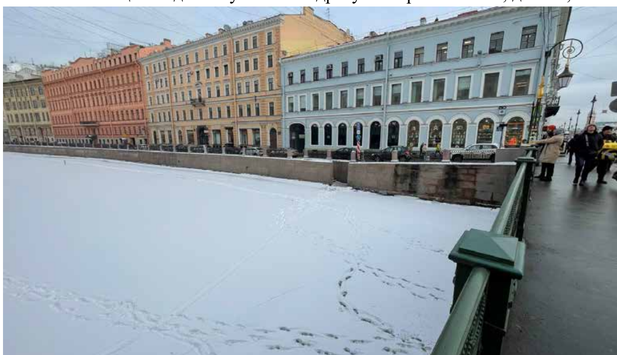
2. Общий вид на спуск 24 по адресу Наб. реки Мойки, дом 44;
