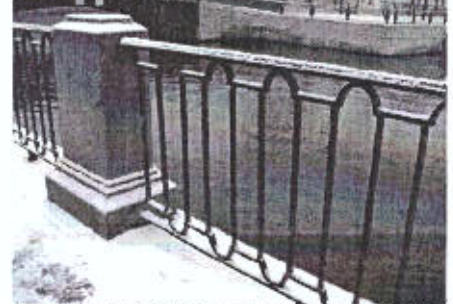
2. Отражение набережной на участке между Инженерным Первым и Михайловским (1-м Словским) мостами (правый берег)
