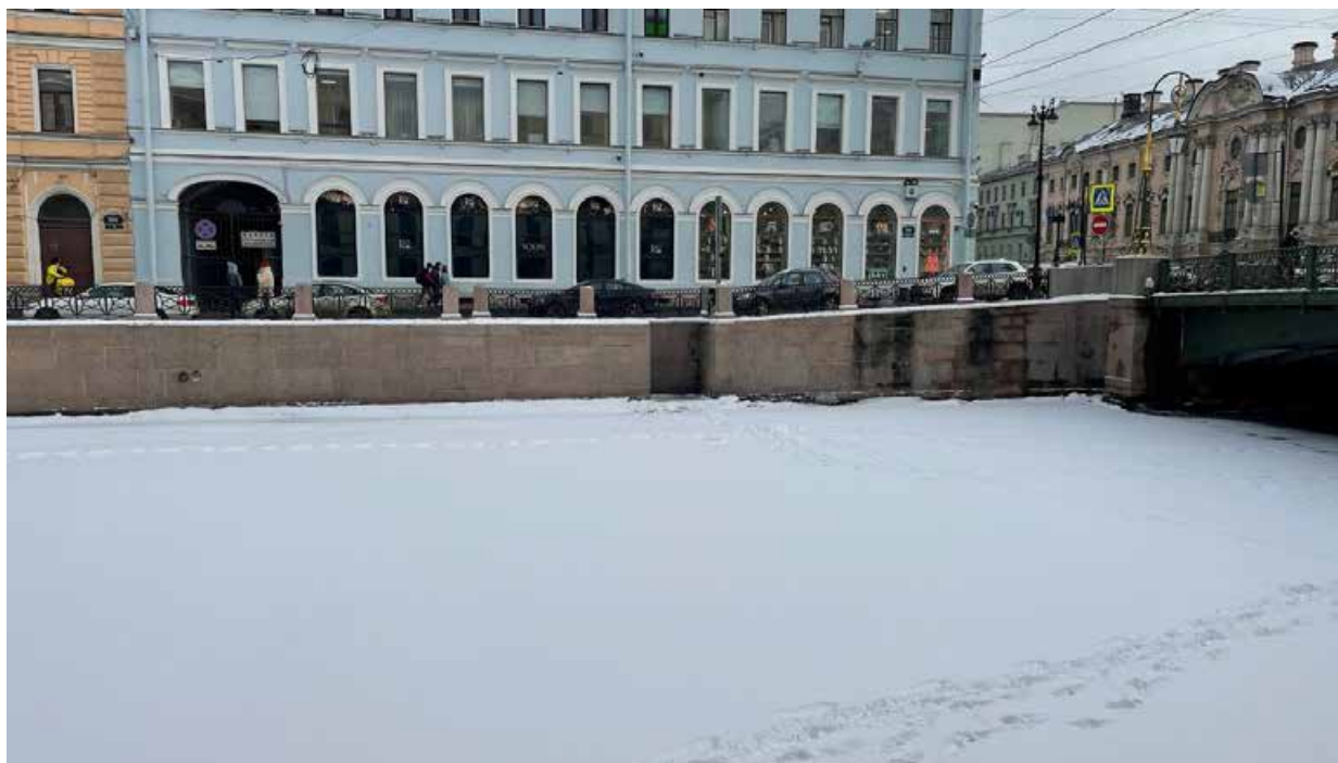
1. Общий вид на спуск 24 по адресу Наб. реки Мойки, дом 44;
