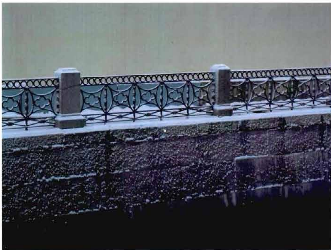
6. Ограждение набережной. Левобережная стенка
