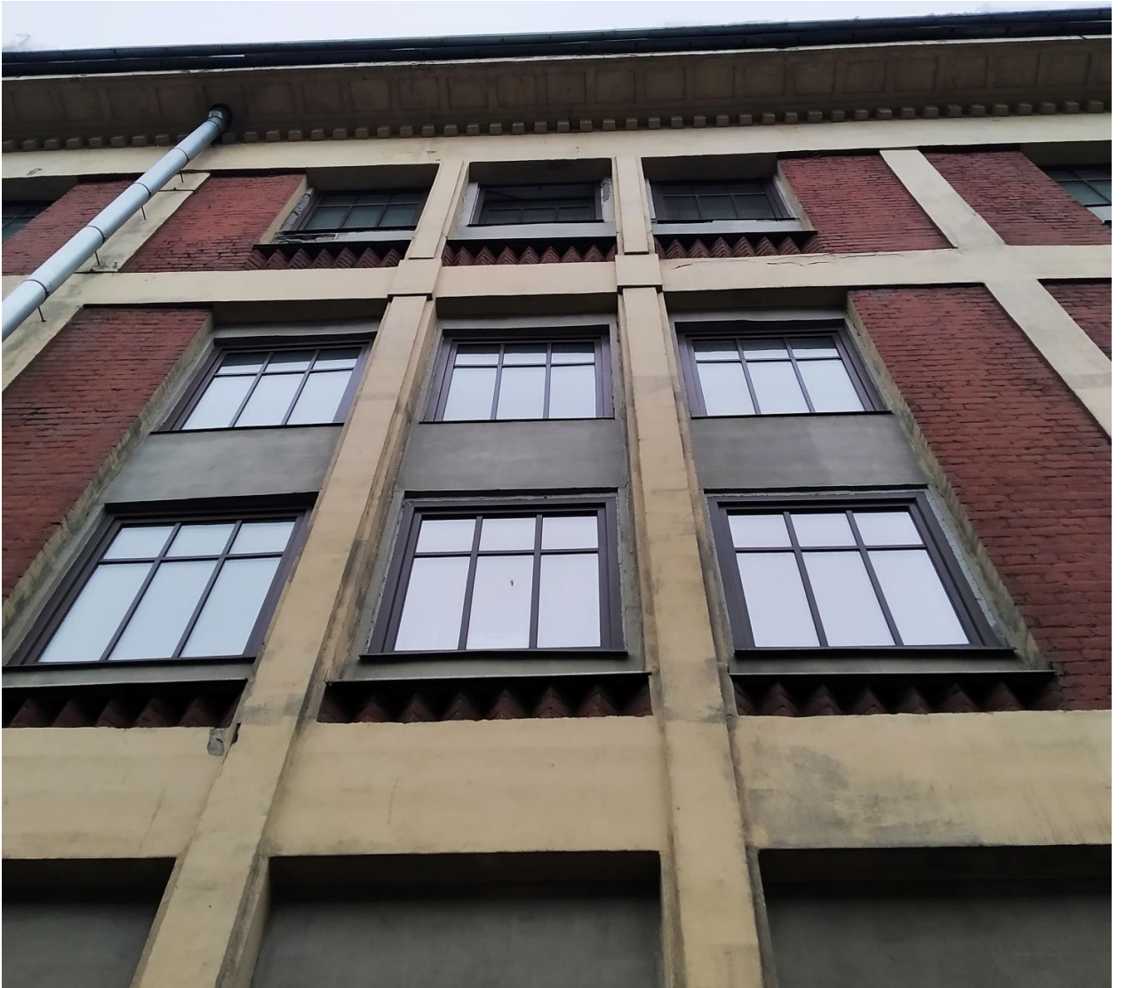
Фото 3. Фрагмент восточного фасада по Б. Сампсониевскому пр. Железобетонный каркас, заполнения межкаркасного пространства красным кирпичем и витражными проемами.
