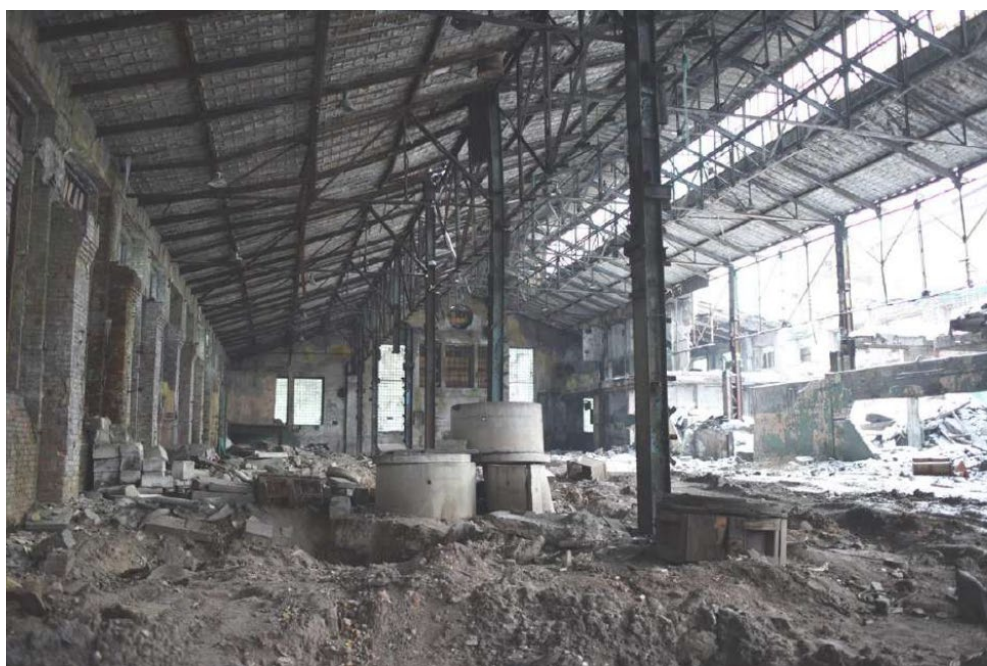
Фото 6. Интерьер. Северный пролет. Вид на восток.
