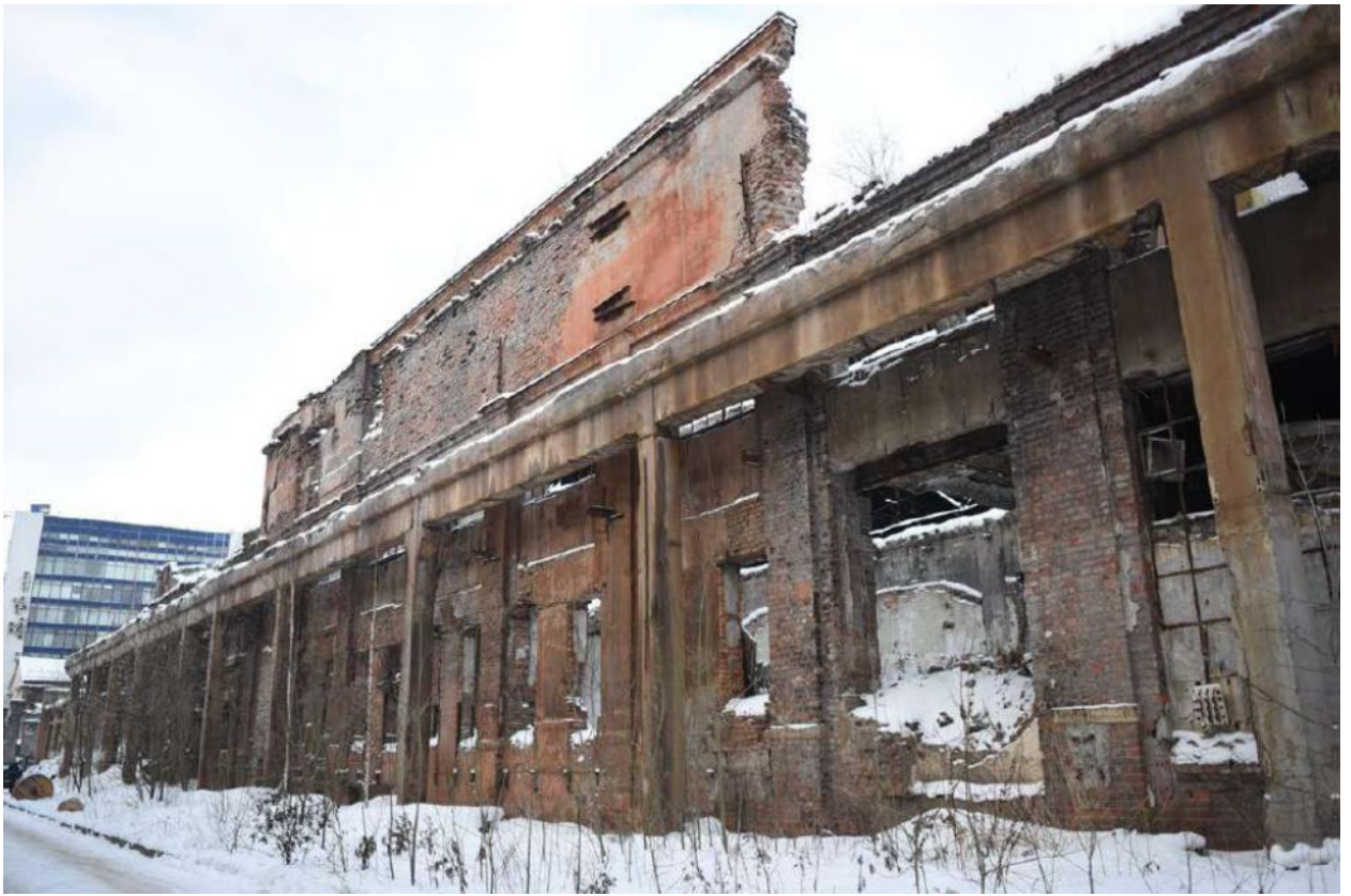
Фото 3. Фрагмент южного фасада со стороны внутривортовой территории.
