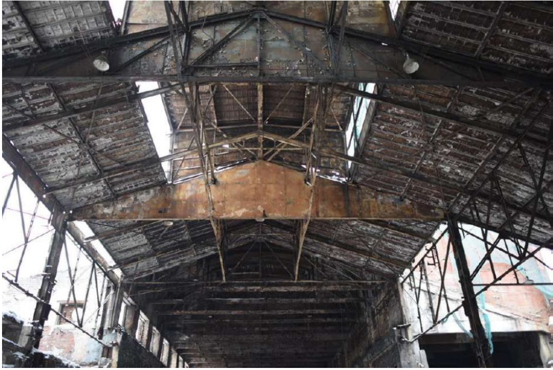
Фото 7. Интерьер. Конструкции светового фонаря.
