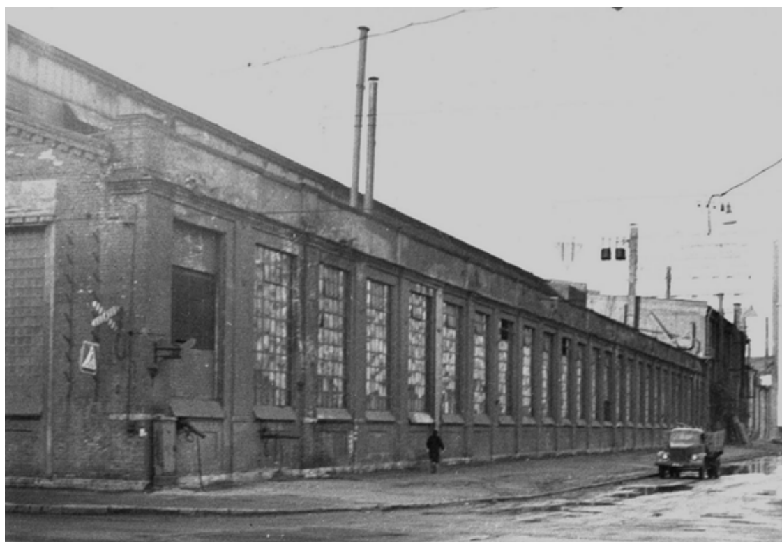
Илл. 39. Чугунолитейный цех. Фасад по улице Фокина. Фото 1970-х гг. Сектор хранения документированной информации КГИОП.
