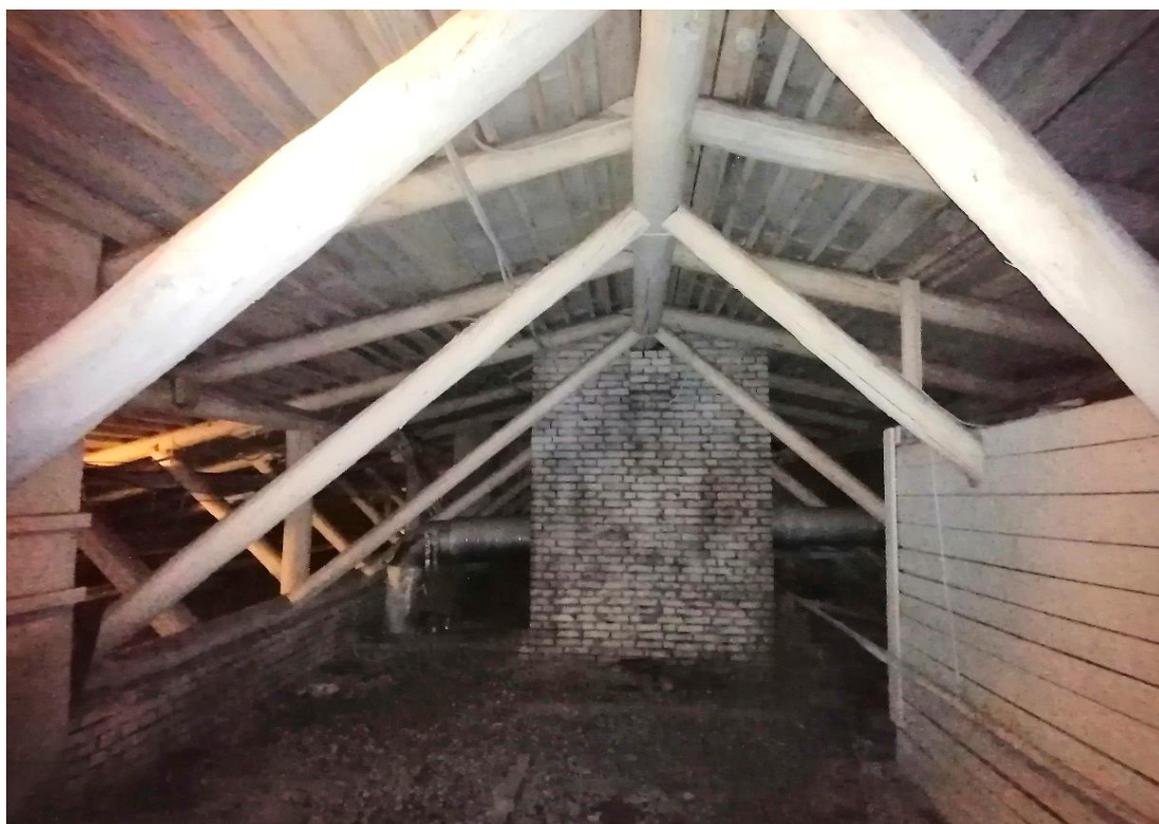
Фото 83. Здание Управления Метрополитена по адресу: Санкт-Петербург, Московский пр., д.28, лит. А. Фрагмент стропильной системы крыши в южной части здания. 20.01.2023г.
