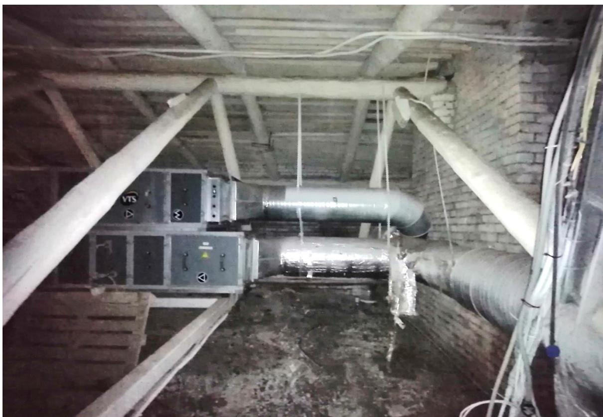
Фото 85. Здание Управления Метрополитена по адресу: Санкт-Петербург, Московский пр., д.28, лит. А. Вентиляционный блок на крыше в северной части здания. 20.01.2023г.
