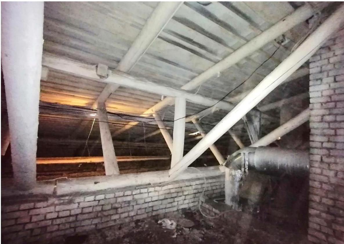
Фото 84. Здание Управления Метрополитена по адресу: Санкт-Петербург, Московский пр., д.28, лит. А. среднестенная кирпичная стенка с прогонами стропильной системы в средней части здания. 20.01.2023г.
