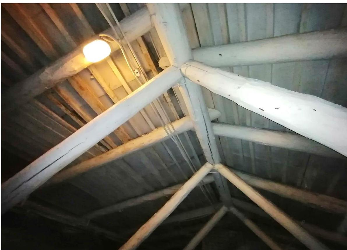
Фото 79. Здание Управления Метрополитена по адресу: Санкт-Петербург, Московский пр., д.28, лит. А. Состояние центрального прогона и стропильных ног крыши в южной части здания. 20.01.2023г.
