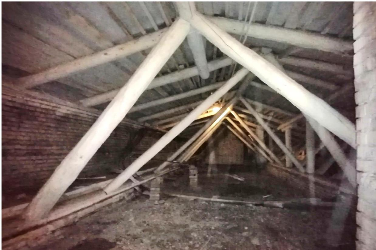
Фото 75. Здание Управления Метрополитена по адресу: Санкт-Петербург, Московский пр., д.28, лит. А. Стропильная система крыши в южной части здания. 20.01.2023г.
