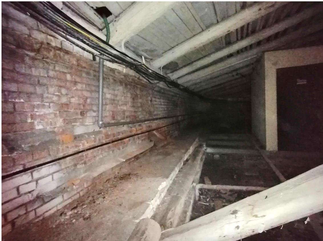
Фото 80. Здание Управления Метрополитена по адресу: Санкт-Петербург, Московский пр., д.28, лит. А. Кирпичная ограждающая конструкция с мауэрлатом в средней части здания. 20.01.2023г.
