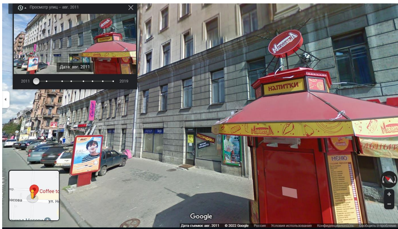
Фрагмент фасада по ул. Маяковского жилого дома по адресу: Санкт-Петербург. Басков пер. 13-15. Из панорамы Google Планета Земля. Август 2011г.
