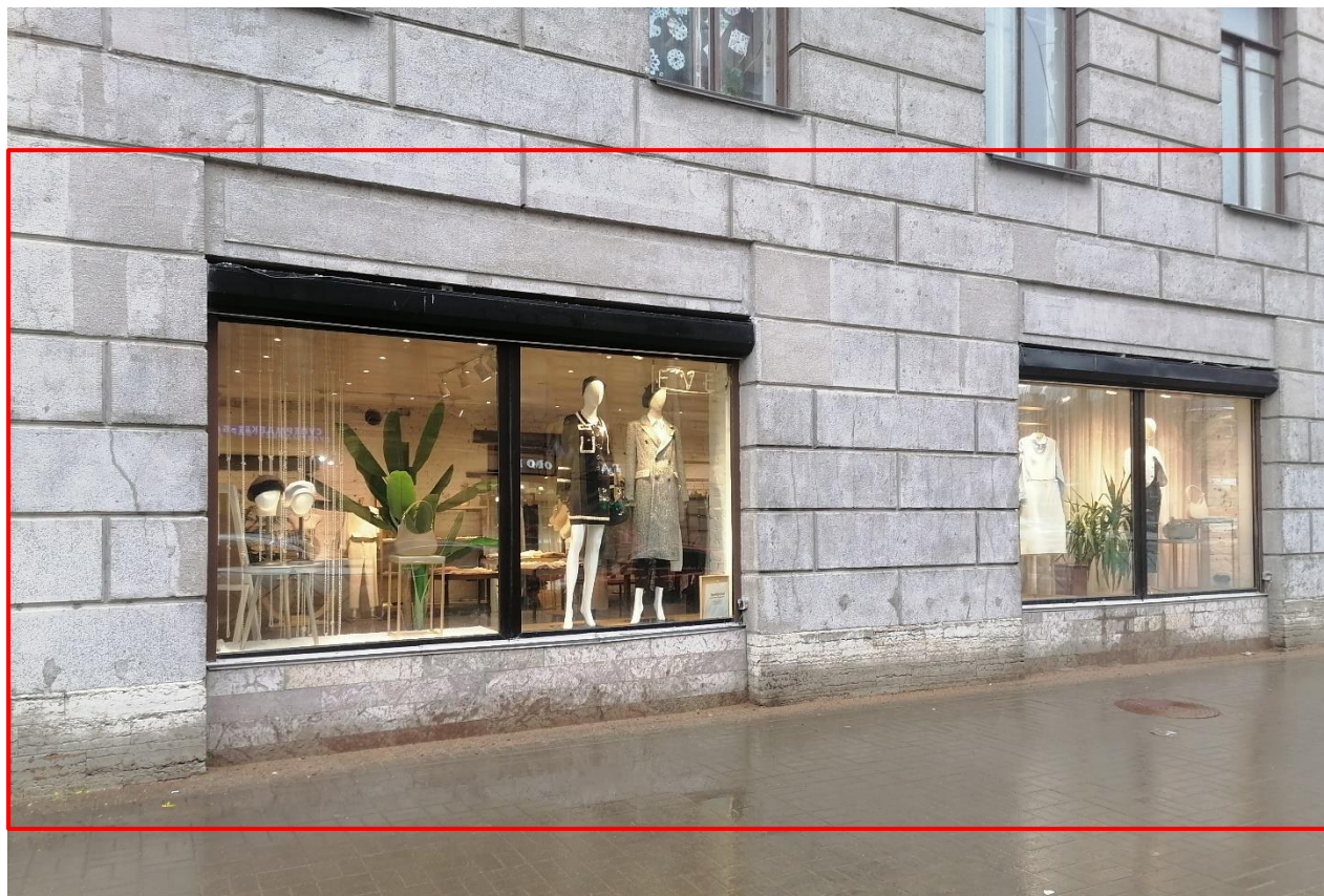
Фото 13. Фрагмент фасада здания по ул. Маяковского с указанием помещения 24-Н. 1-ый этаж, световые оси 12-13-14-15. Магазин “EVE”. 02.03.2022г.
