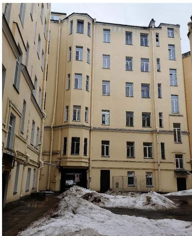
Фото 5. Дворовый фасад. Общий вид на север. 02.03.2022г.
