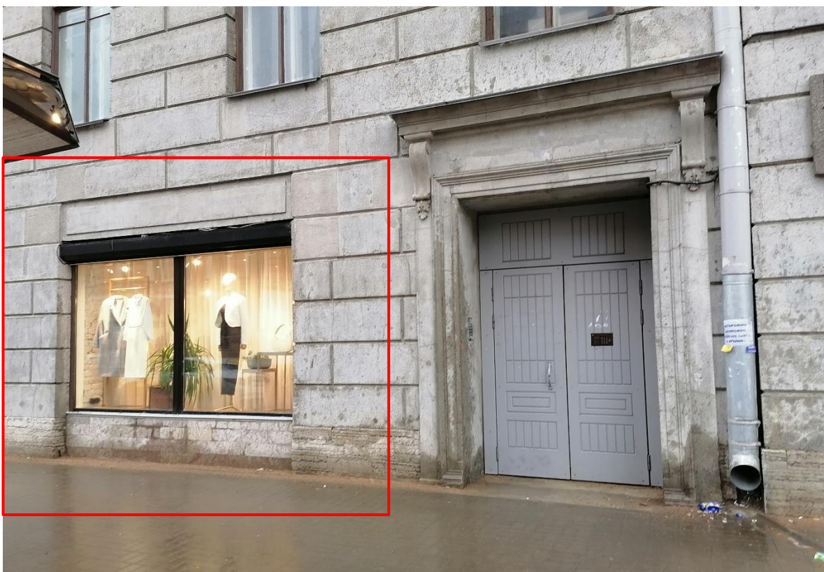
Фото 10. Фрагмент фасада здания по ул. Маяковского с указанием помещения 24-Н.. 1-ый этаж, световые оси 14-15-16. 02.03.2022г.
