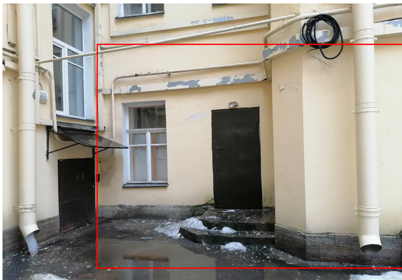
Фото 15. Фрагмент дворового фасада с указанием помещения 24-Н. Заложенный служебный вход. Магазин "EVE". 02.03.2022г.
