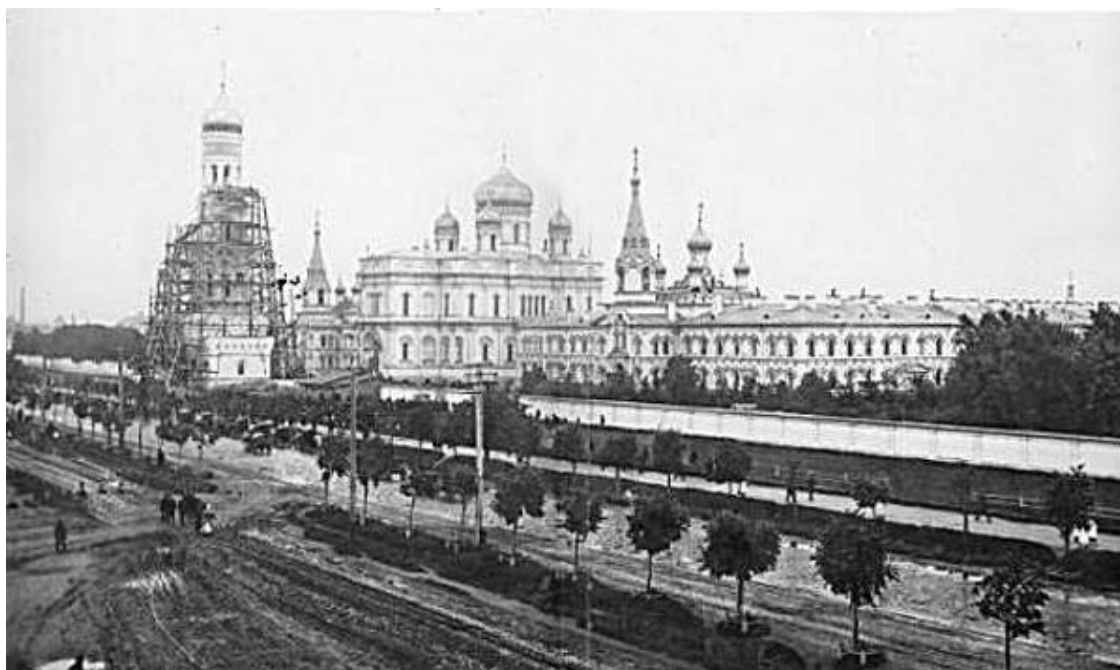
12. Воскресенский Новодевичий монастырь. Строительство колокольни. 1890-е гг. Фотография.
