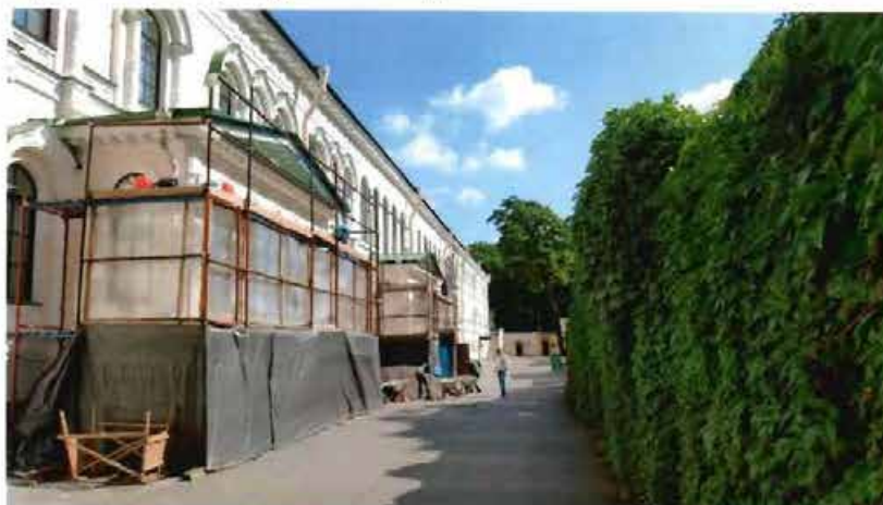
10. Торцевой фасад объекта культурного наследия, восточный дворовой фасад
