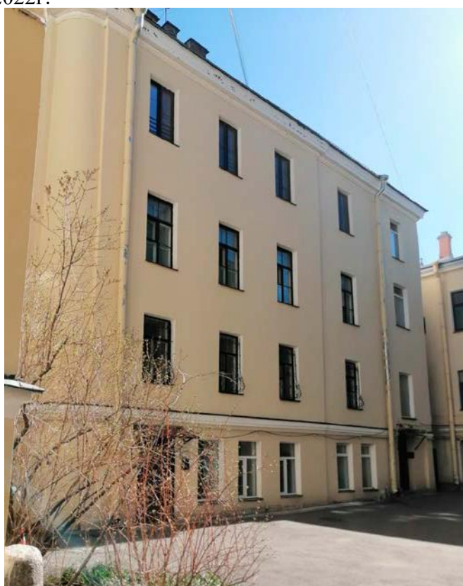
20. Выявленный объект культурного наследия «Дом С. Крамера (Г.А. Лепена)», по адресу: Санкт-Петербург, Большая Морская ул., 50; Мойки р. наб., 95. Дворовый восточный фасад. Дата съемки: 20.04.2022г.
