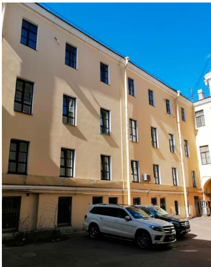
19. Выявленный объект культурного наследия «Дом С. Крамера (Г.А. Лепена)», по адресу: Санкт-Петербург, Большая Морская ул., 50; Мойки р. наб., 95. Дворовый западный фасад. Дата съемки: 20.04.2022г.
