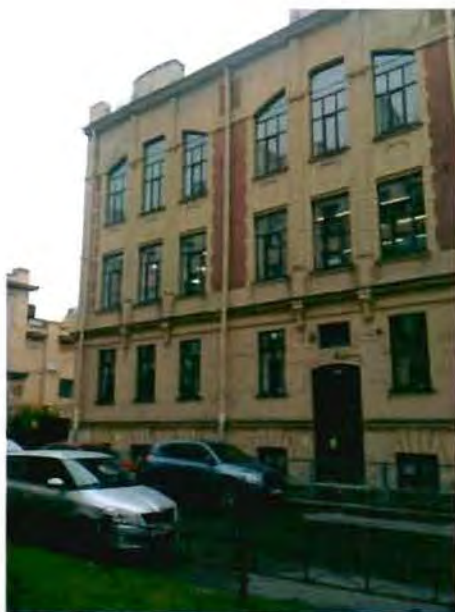
5. Фрагмент северного фасада.
