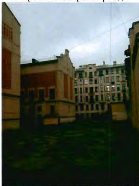
7. Фрагмент дворового (восточного) фасада.
