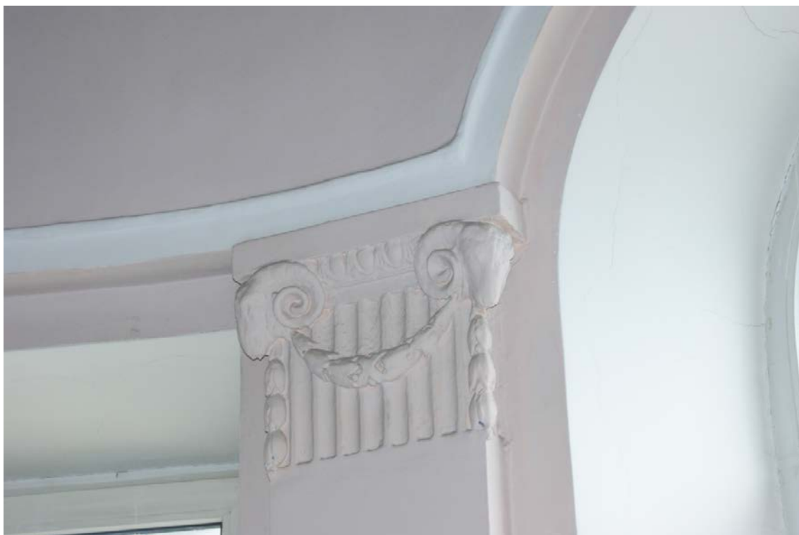
Фото 70. Лестница № 2. Площадка между 5-м и 6-м этажом. Оформление стен. Съемка 19.04.2021 г. Штиглиц М. С.
