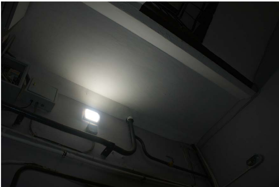
Фото 102. Лестница № 4. Площадка 1-го этажа. Съемка 19.04.2021 г. Штиглиц М. С.
