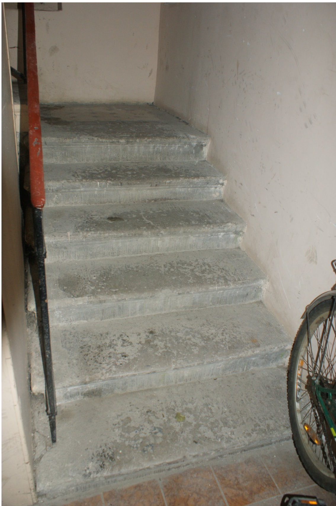
Фото 79. Лестница № 3. 1-й этаж. Лестничный марш. Съемка 19.04.2021 г. Штиглиц М. С.
