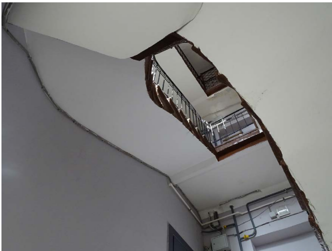
Фото 122. Лестница № 4. Лестница. Съемка 19.04.2021 г. Штиглиц М. С.
