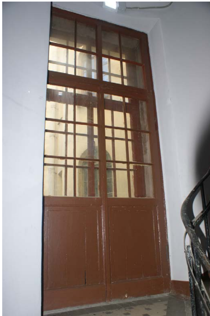
Фото 109. Лестница № 4. Площадка между 2-м и 3-м этажом. Съемка 19.04.2021 г. Штиглиц М. С.
