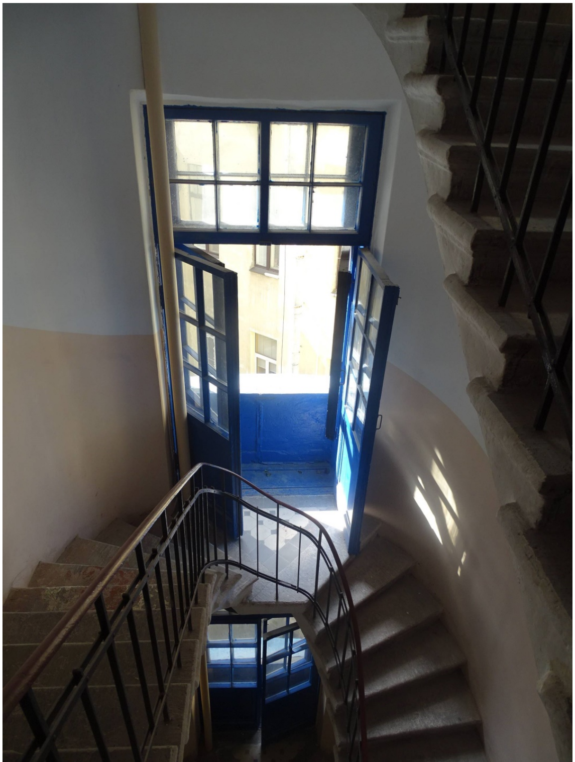
Фото 91. Лестница № 3. Площадка между 4-м и 5-м этажом. Съемка 19.04.2021 г. Штиглиц М. С.
