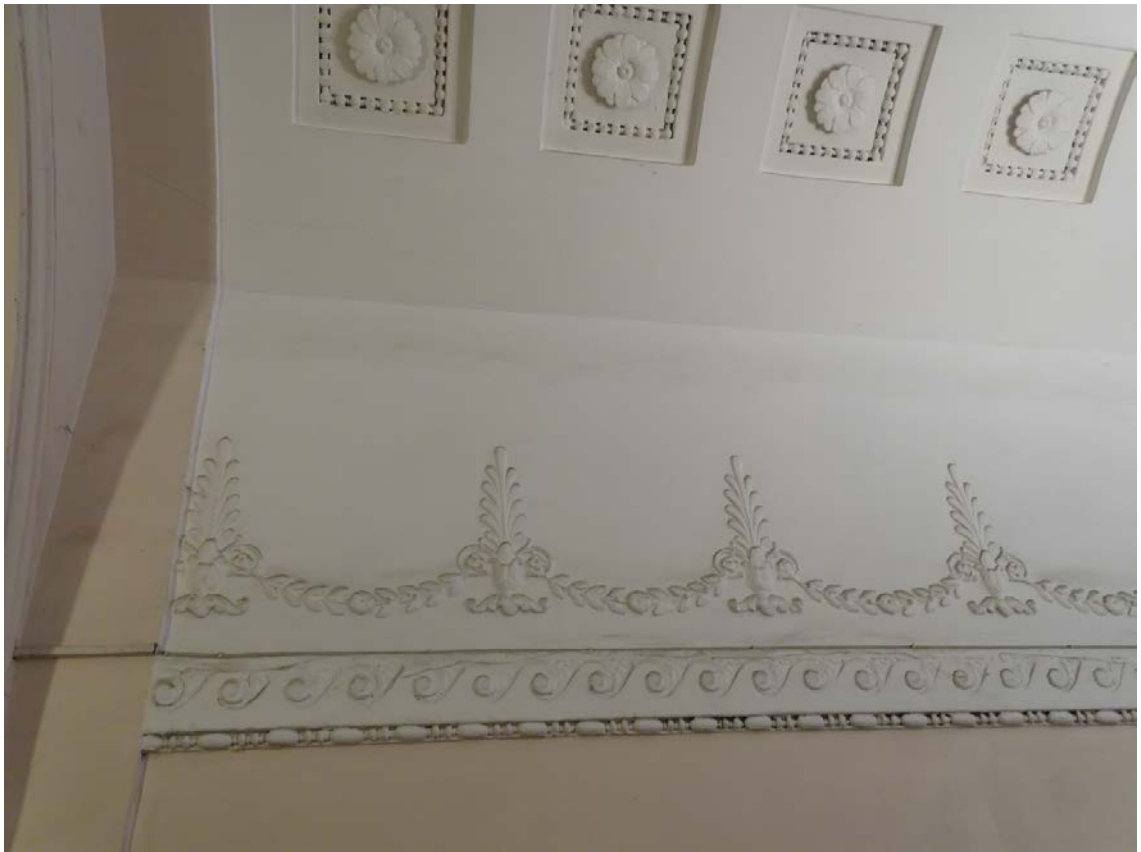
Фото 37. Лестница № 2. 1-й этаж. Вестибюль. Оформление потолка. Съемка 19.04.2021 г. Штиглиц М. С.
