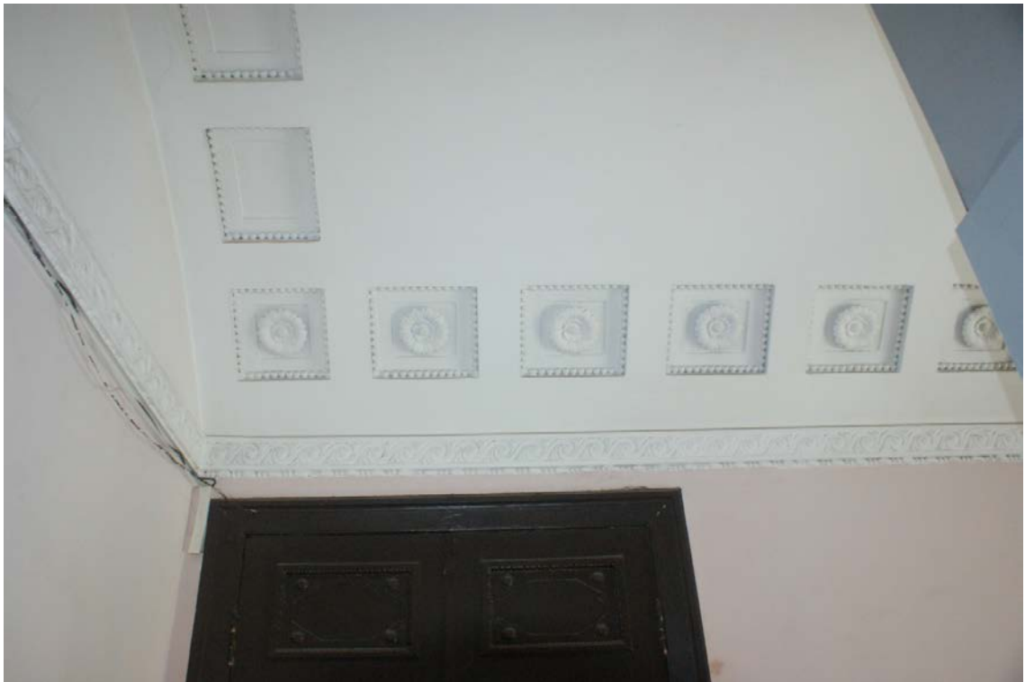
Фото 72. Лестница № 2. 6-й этаж. Оформление потолка. Съемка 19.04.2021 г. Штиглиц М. С.
