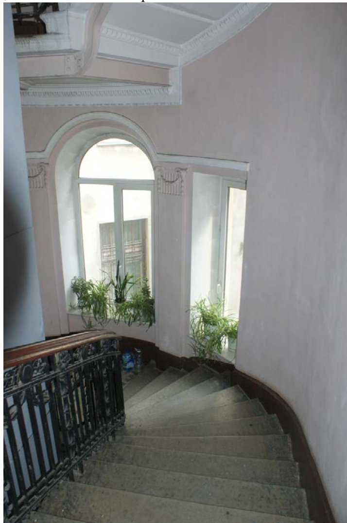
Фото 54. Лестница № 2. Площадка между 3-м и 4-м этажом. Съемка 19.04.2021 г. Штиглиц М. С.
