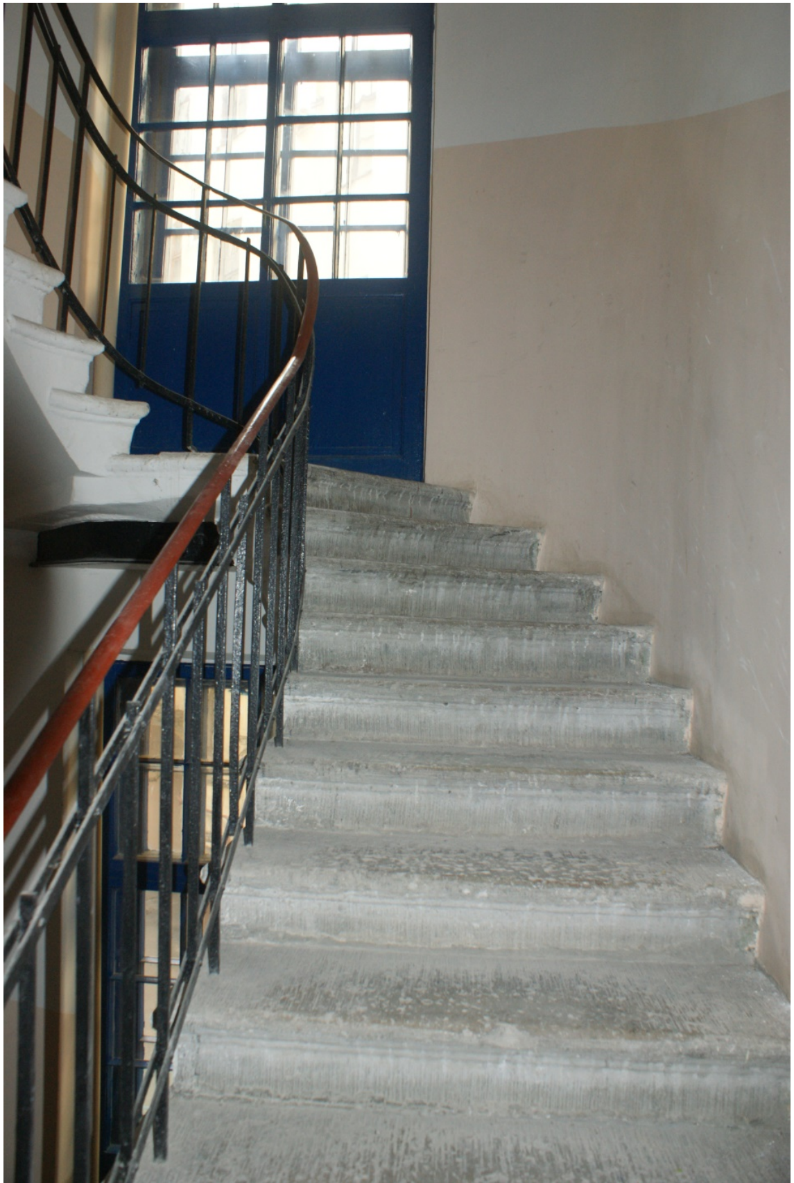
Фото 83. Лестница № 3. Площадка между 2-м и 3-м этажом. Съемка 19.04.2021 г. Штиглиц М. С.
