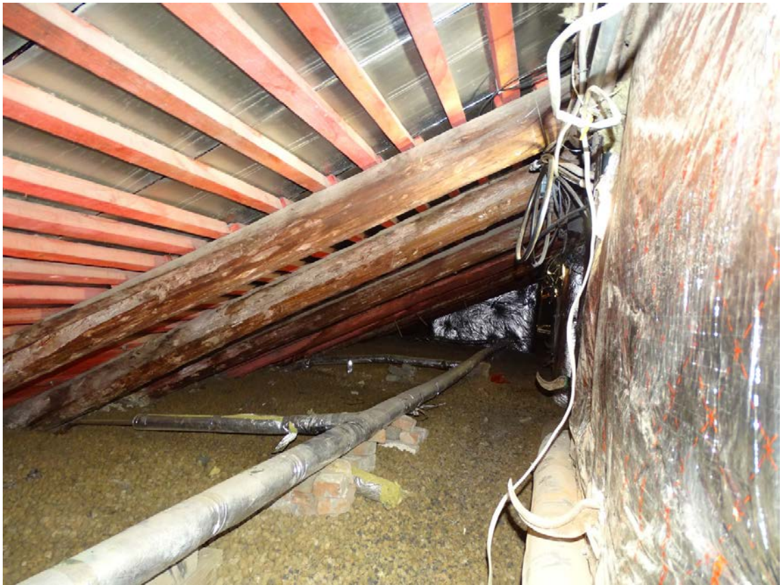
Фото 137. Лестница № 4. Чердачный этаж. Съемка 19.04.2021 г. Штиглиц М. С.
