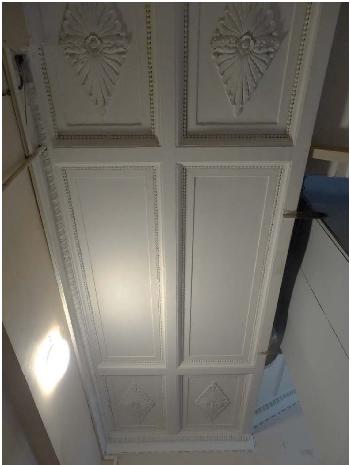
Фото 48. Лестница № 2. 2-й этаж. Оформление потолка. Съемка 19.04.2021 г. Штиглиц М. С.
