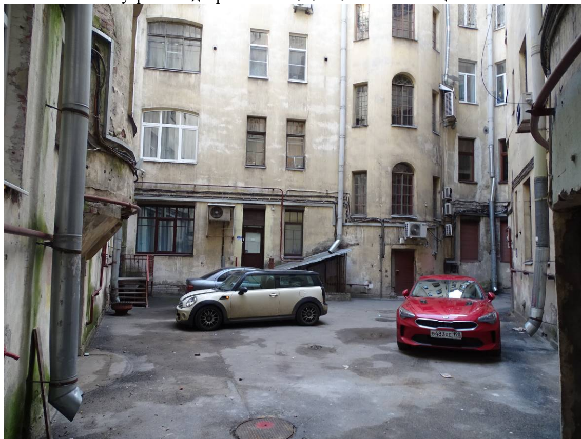
Фото 29. Здание по адресу: г. Санкт-Петербург, Большая Посадская, дом 1/10, литера А. Внутренний двор. Съемка 19.04.2021 г. Штиглиц М. С.
