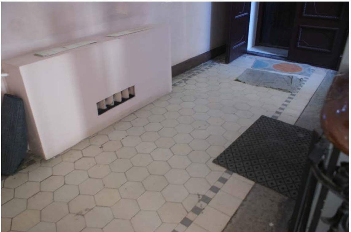
Фото 64. Лестница № 2. 5-й этаж. Покрытие пола. Съемка 19.04.2021 г. Штиглиц М. С.
