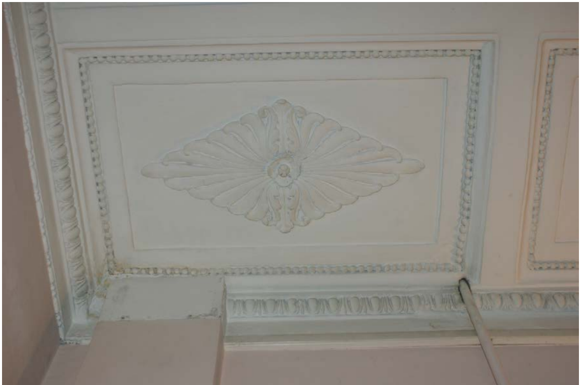
Фото 57. Лестница № 2. 4-й этаж. Оформление потолка. Съемка 19.04.2021 г. Штиглиц М. С.
