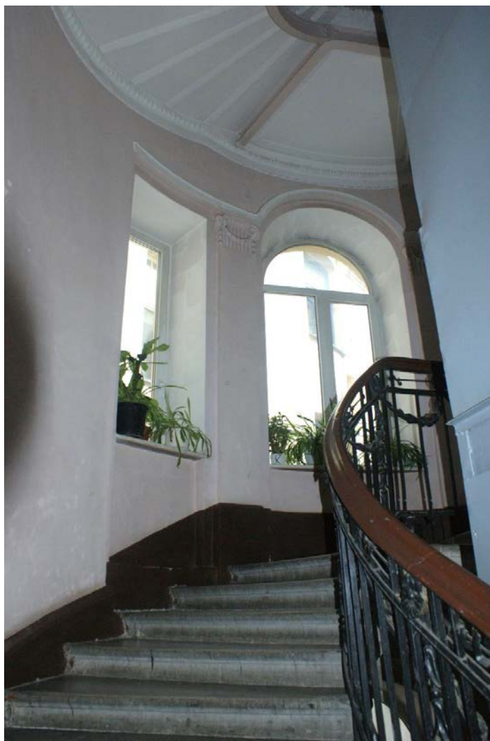
Фото 55. Лестница № 2. Площадка между 3-м и 4-м этажом. Съемка 19.04.2021 г. Штиглиц М. С.
