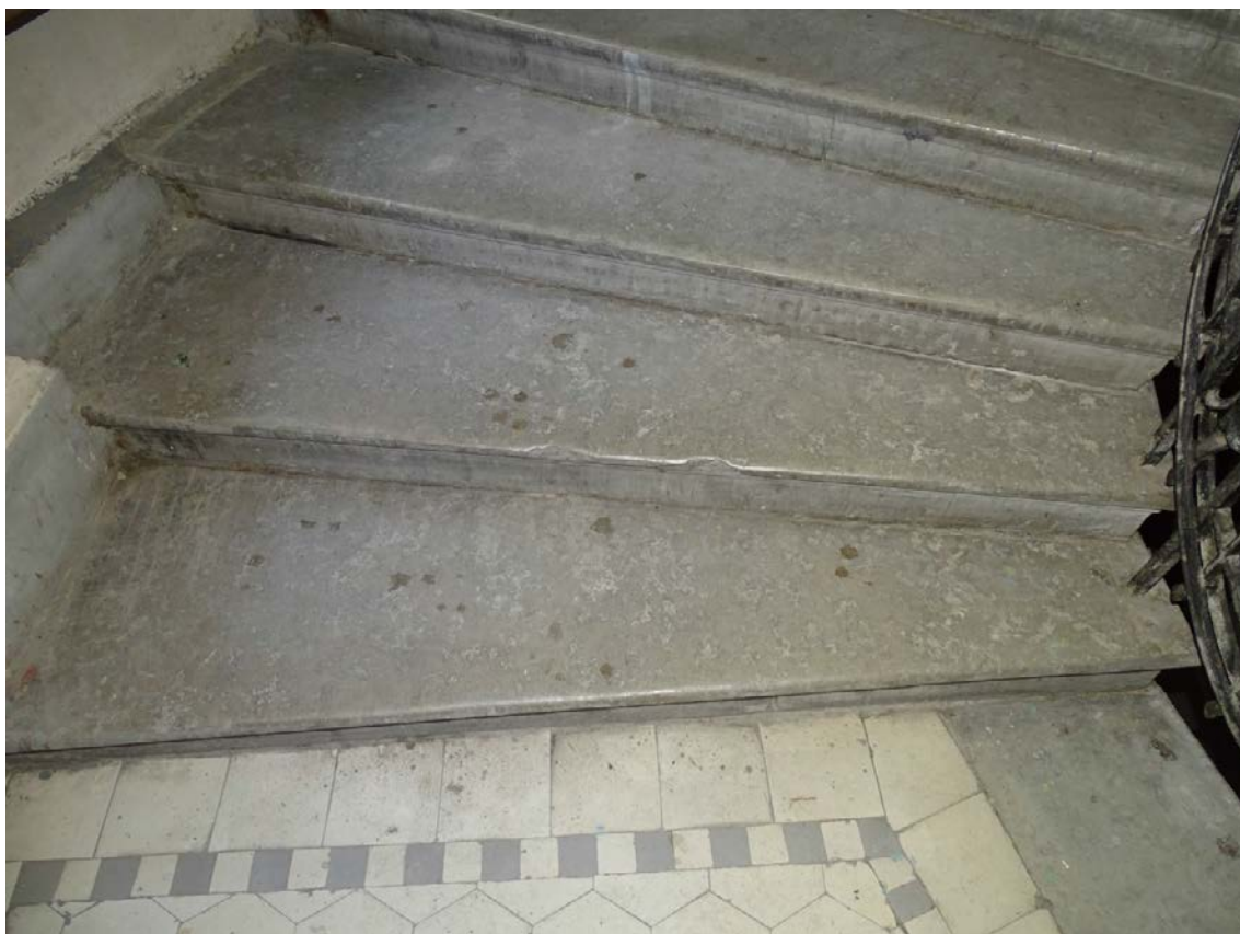
Фото 17. Лестница № 1. Лестничный марш на площадку между 2-м и 3-м этажом. Съемка 19.04.2021 г. Штиглиц М. С.
