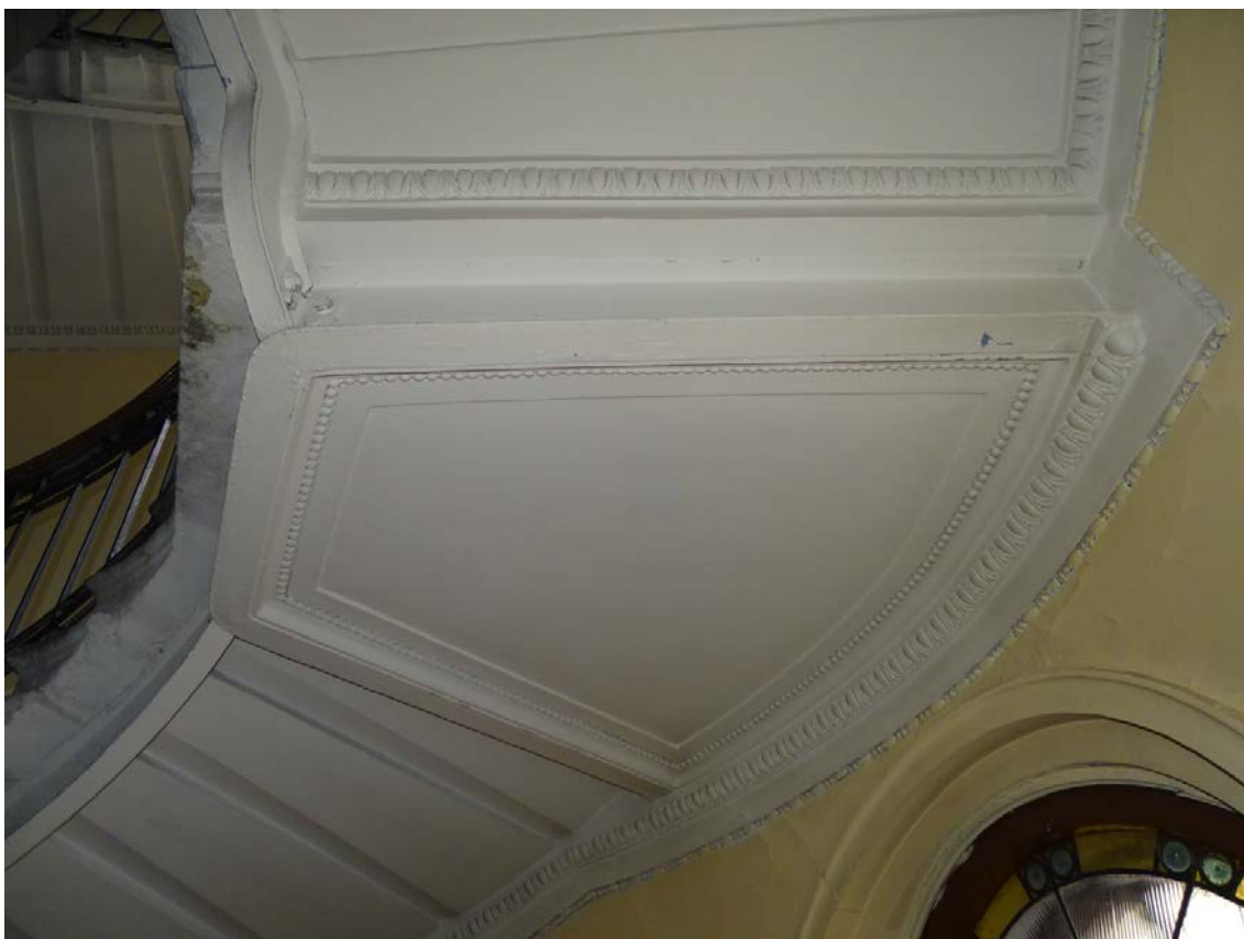
Фото 23. Лестница № 1. Площадка между 4-м и 5-м этажом. Штиглиц М. С.
