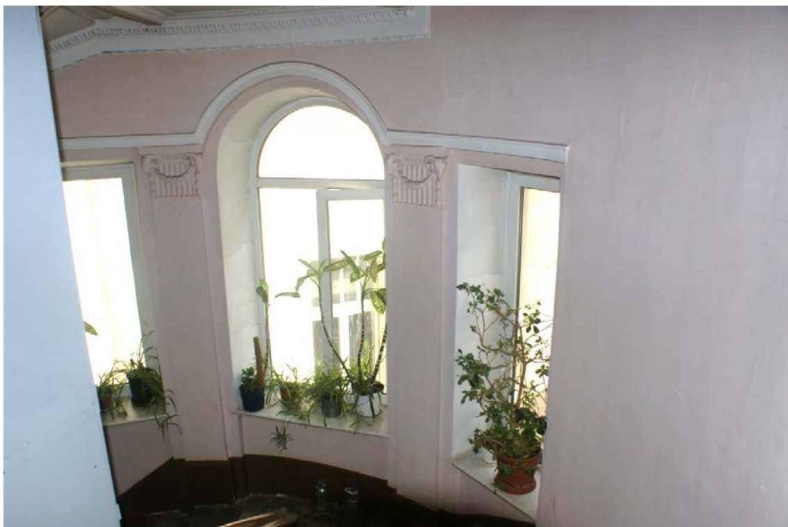
Фото 61. Лестница № 2. Площадка между 4-м и 5-м этажом. Съемка 19.04.2021 г. Штиглиц М. С.
