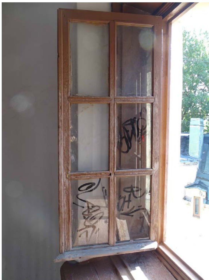
Фото 135. Лестница № 4. Площадка между 6-м и чердачным этажом. Съемка 19.04.2021 г. Штиглиц М. С.
