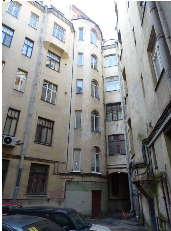
Фото 31. Здание по адресу: г. Санкт-Петербург, Большая Посадская, дом 1/10, литера А. Внутренний двор. Съемка 19.04.2021 г. Штиглиц М. С.
