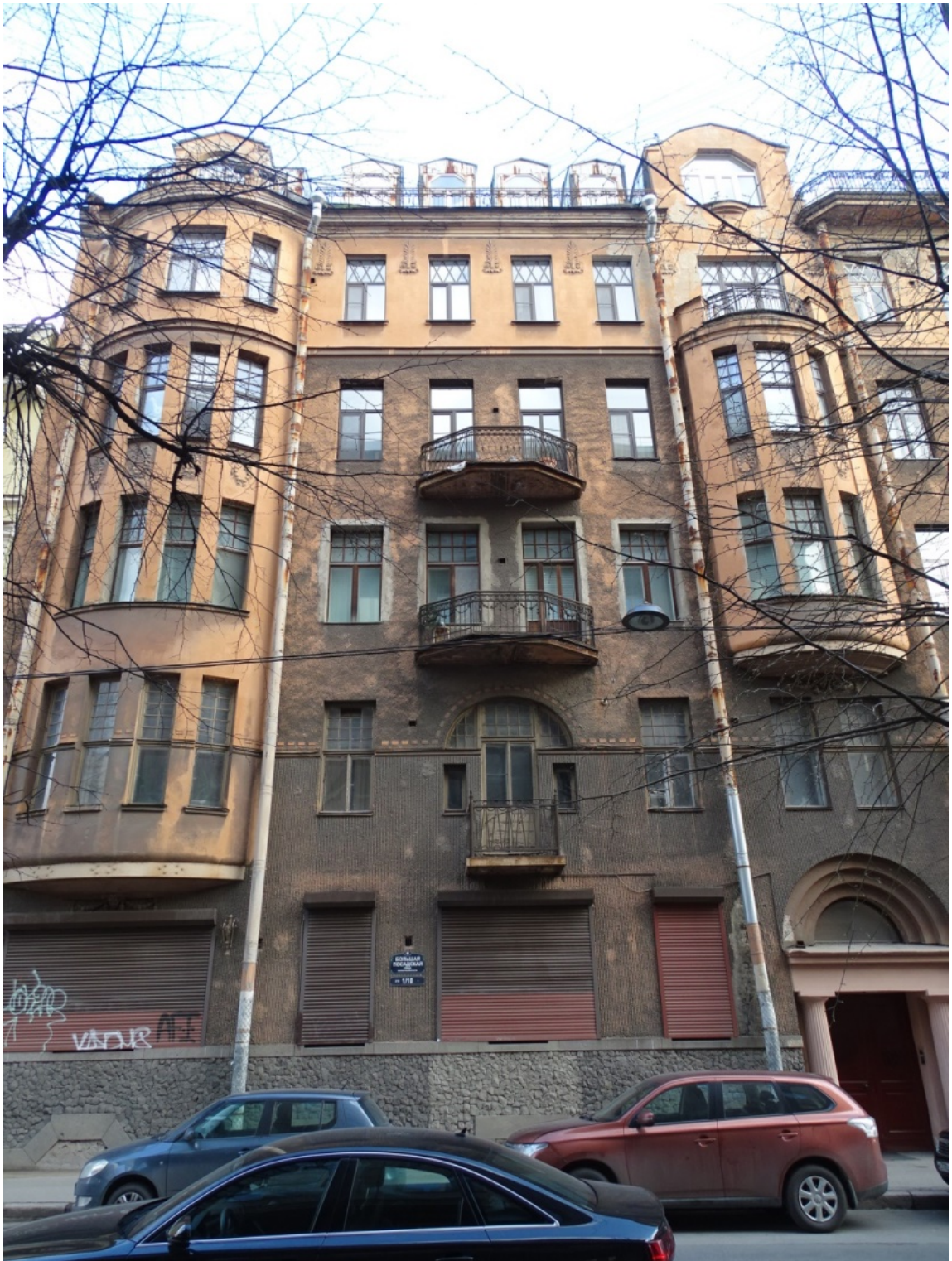
Фото 20. Здание по адресу: г. Санкт-Петербург, Большая Посадская, дом 1/10, литера А. Лицевой фасад по Большой Посадской ул. Съемка 19.04.2021 г. Штиглиц М. С.
