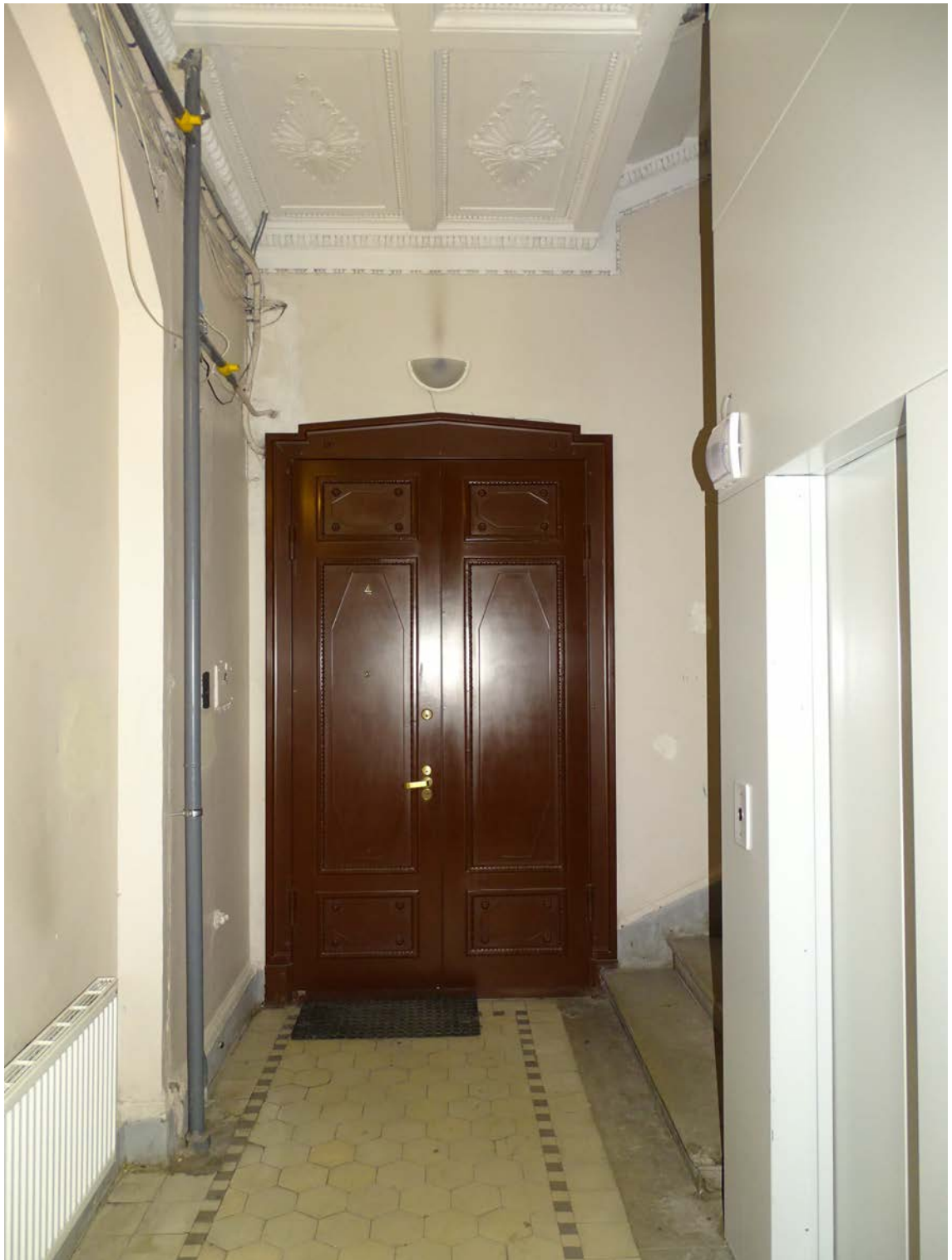
Фото 14. Лестница № 1. Площадка 2-го этажа. Съемка 19.04.2021 г. Штиглиц М. С.
