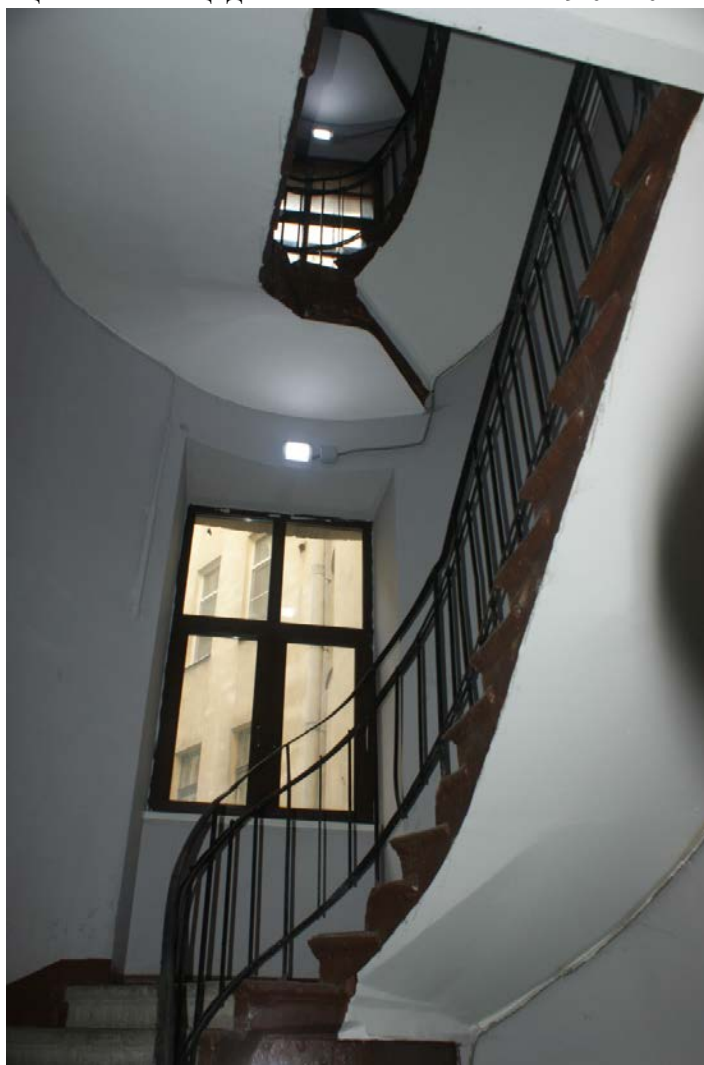
Фото 103. Лестница № 4. Площадка между 1-м и 2-м этажом. Съемка 19.04.2021 г. Штиглиц М. С.
