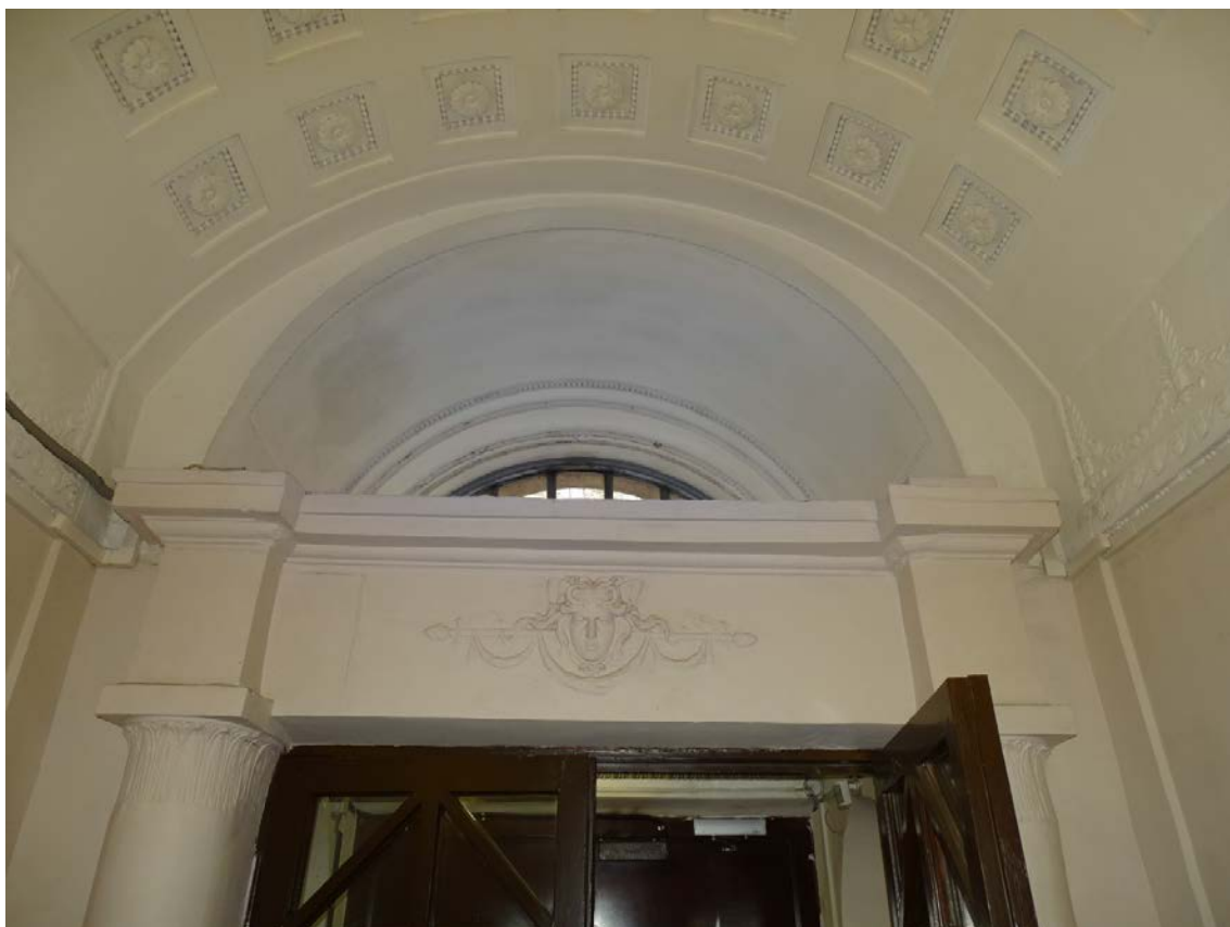
Фото 2. Лестница № 1. 1-й этаж. Вестибюль. Съёмка 19.04.2021 г. Штиглиц М. С.
