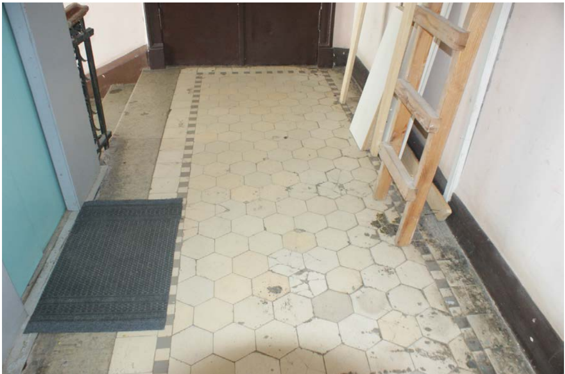
Фото 73. Лестница № 2. 6-й этаж. Покрытие пола. Съемка 19.04.2021 г. Штиглиц М. С.
