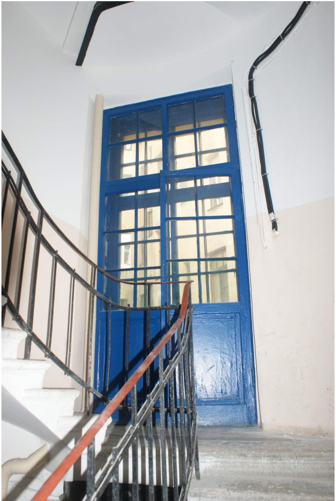
Фото 81. Лестница № 3. Площадка между 1-м и 2-м этажом. Съемка 19.04.2021 г. Штиглиц М. С.
