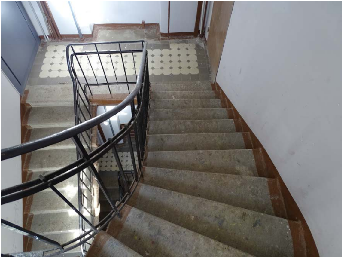
Фото 125. Лестница № 4. 5-й этаж. Съёмка 19.04.2021 г. Штиглиц М. С.
