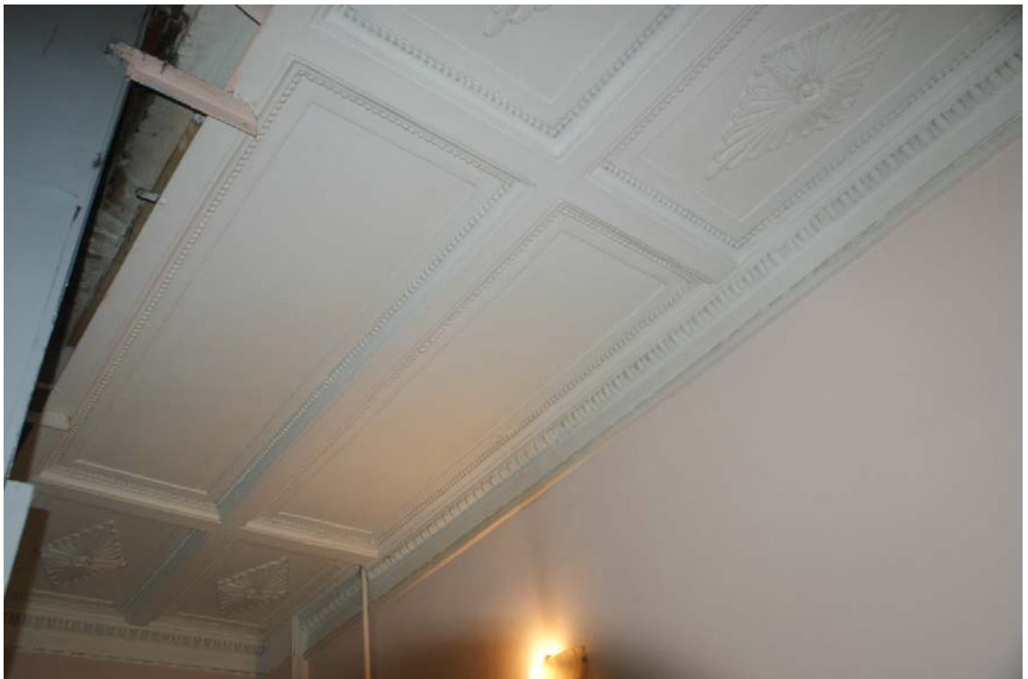
Фото 58. Лестница № 2. 4-й этаж. Оформление потолка. Съемка 19.04.2021 г. Штиглиц М. С.
