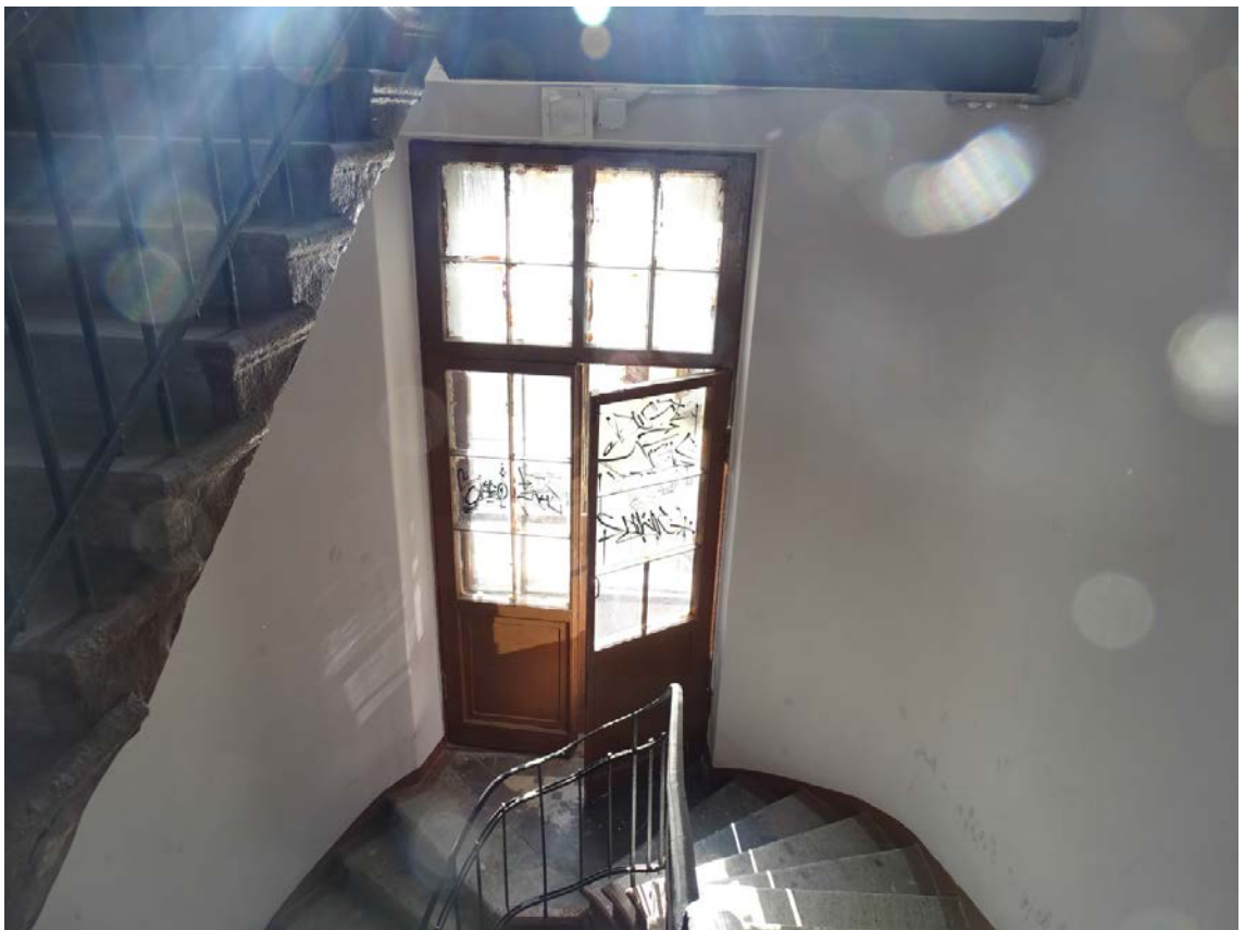
Фото 126. Лестница № 4. Площадка между 5-м и 6-м этажом. Съёмка 19.04.2021 г. Штиглиц М. С.
