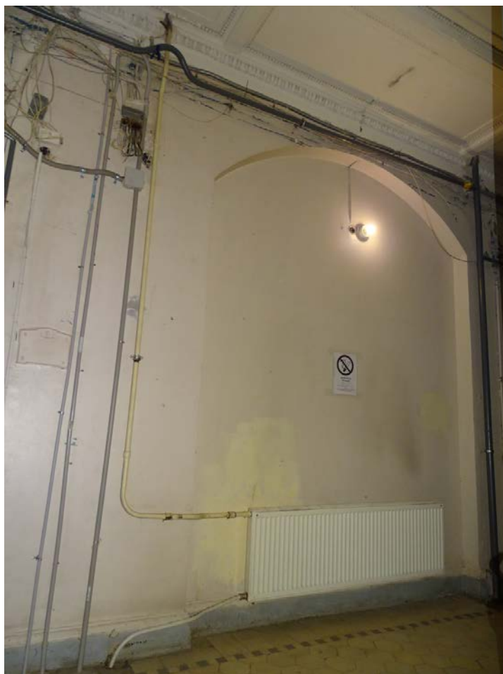
Фото 12. Лестница № 1. Площадка 2-го этажа. Съемка 19.04.2021 г. Штиглиц М. С.
