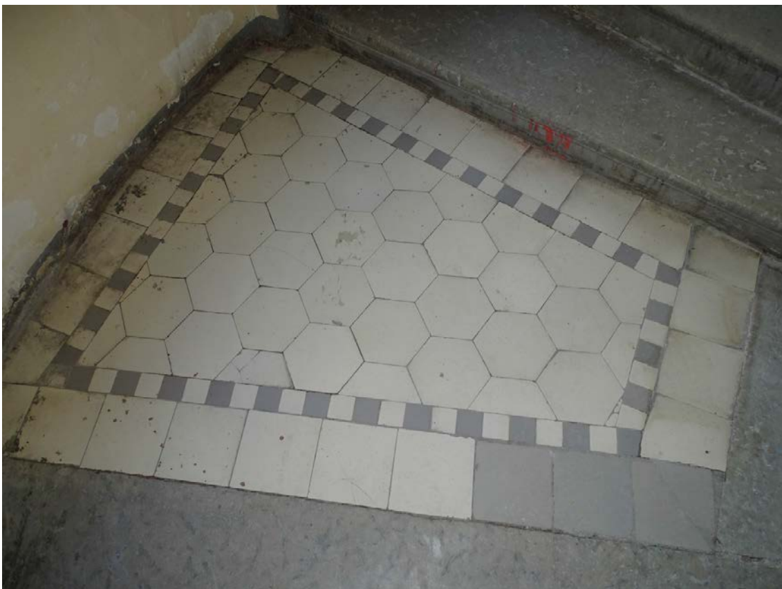
Фото 24. Лестница № 1. Площадка между 4-м и 5-м этажом. Съемка 19.04.2021 г. Штиглиц М. С.
