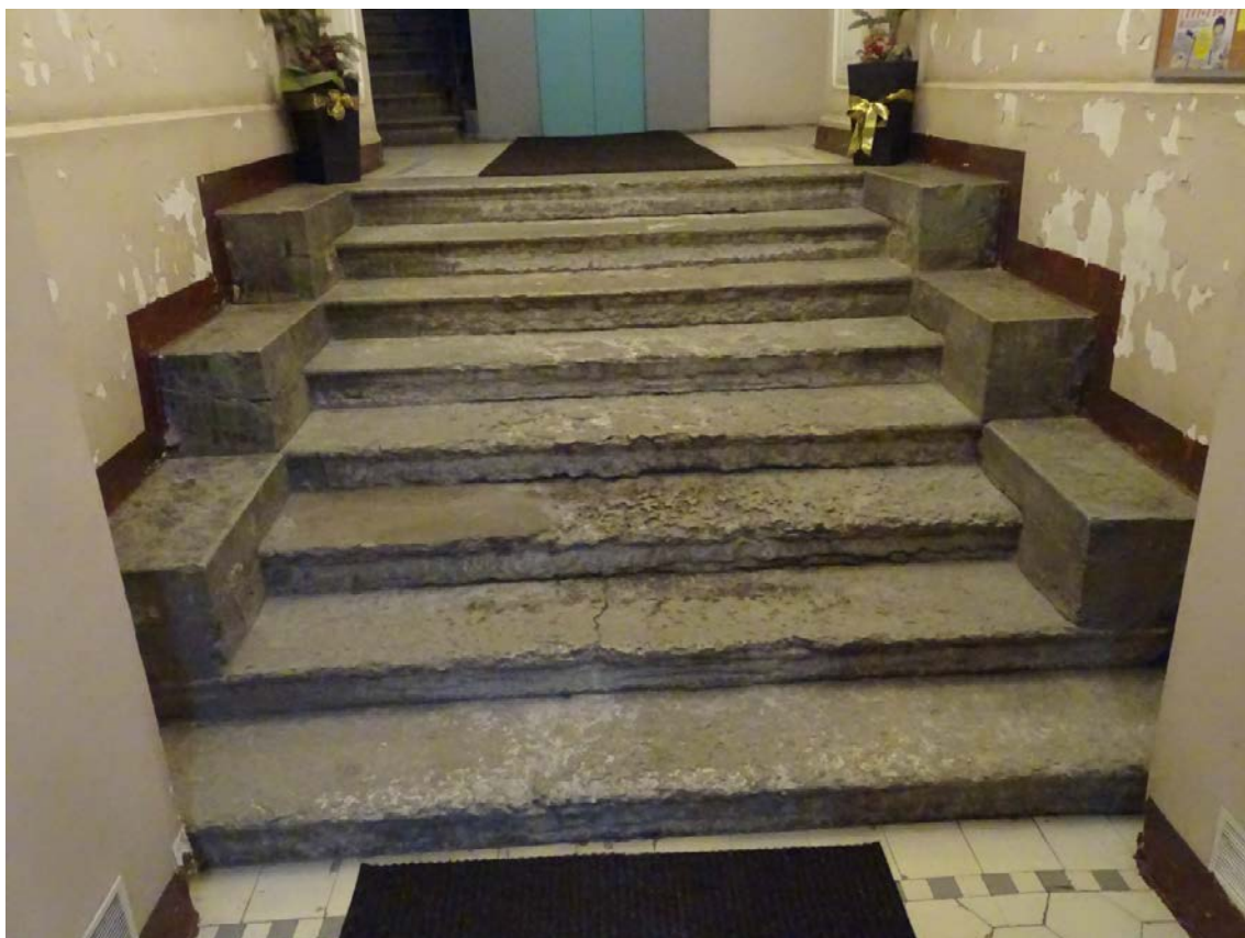
Фото 39. Лестница № 2. Вестибюль. Ступени. Съемка 19.04.2021 г. Штиглиц М. С.
