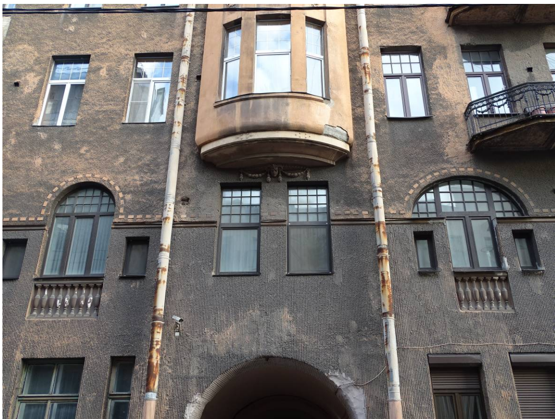
Фото 17. Здание по адресу: г. Санкт-Петербург, Большая Посадская, дом 1/10, литера А. Лицевой фасад по Большой Посадской ул. Фрагмент. Съемка 19.04.2021 г. Штиглиц М. С.
