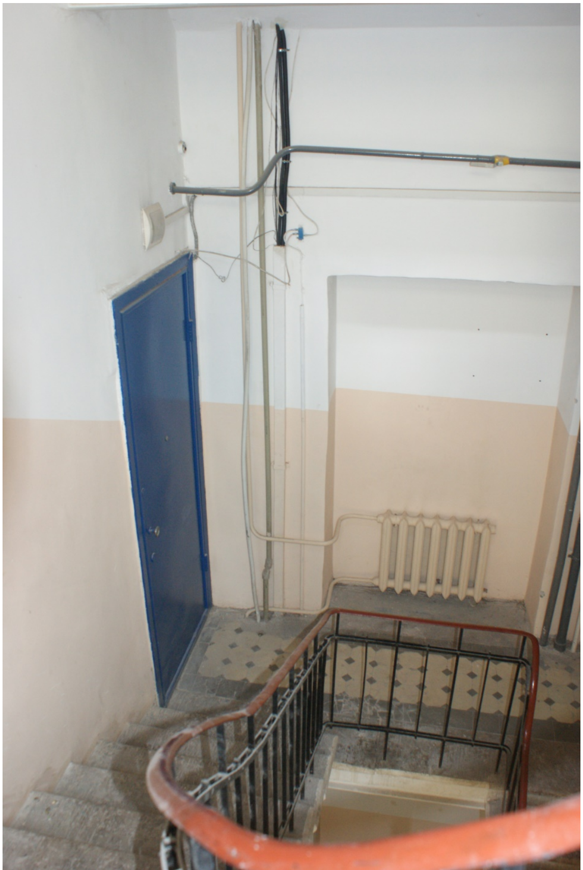
Фото 86. Лестница № 3. 3-й этаж. Съёмка 19.04.2021 г. Штиглиц М. С.
