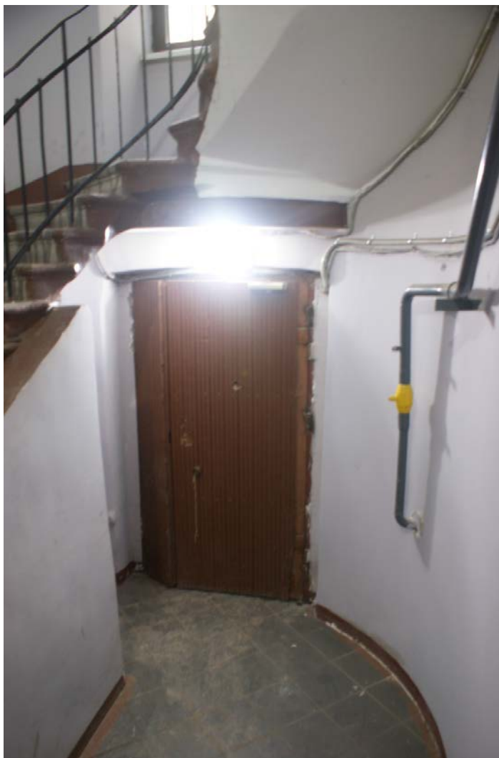
Фото 98. Лестница № 4. 1-й этаж. Вестибюль. Съёмка 19.04.2021 г. Штиглиц М. С.
