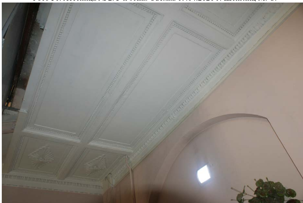
Фото 52. Лестница № 2. 3-й этаж. Оформление потолка. Съемка 19.04.2021 г. Штиглиц М. С.
