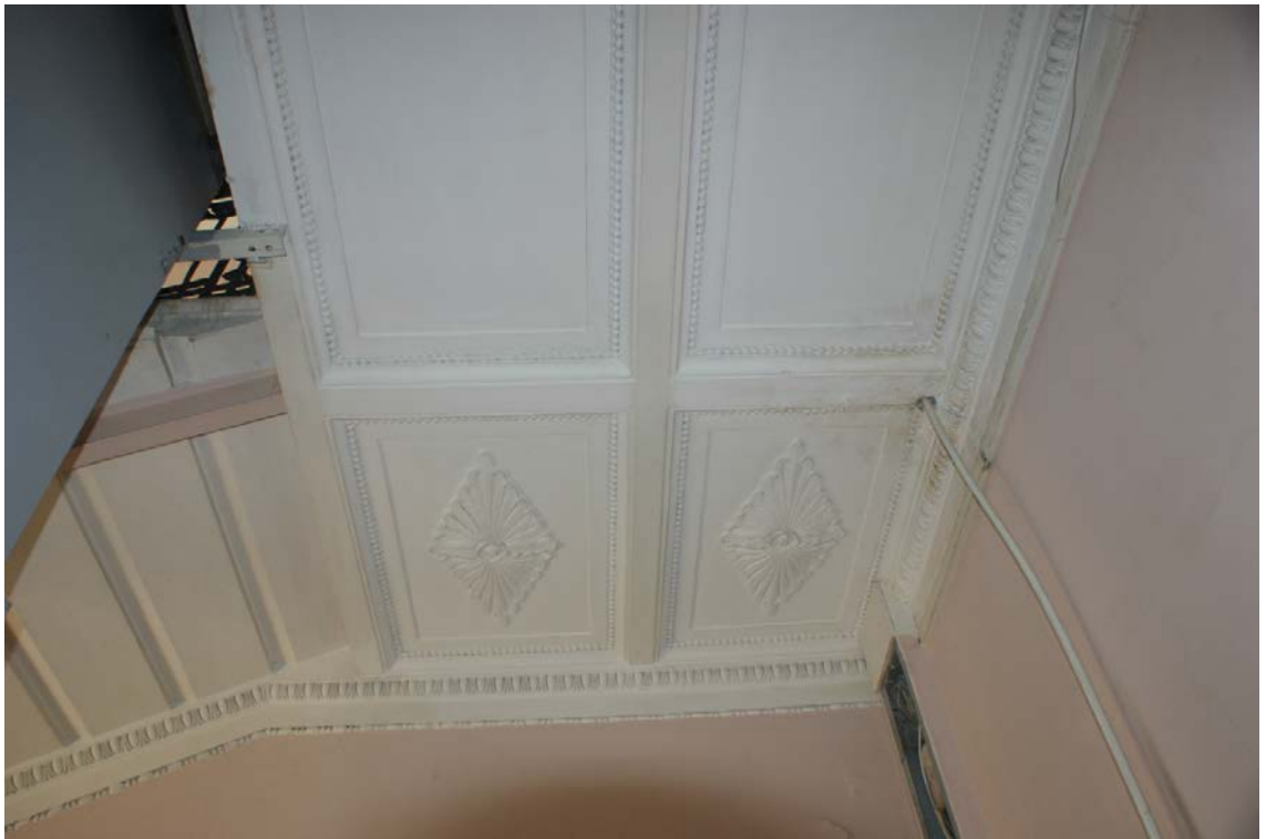
Фото 63. Лестница № 2. 5-й этаж. Оформление потолка. Съемка 19.04.2021 г. Штиглиц М. С.
