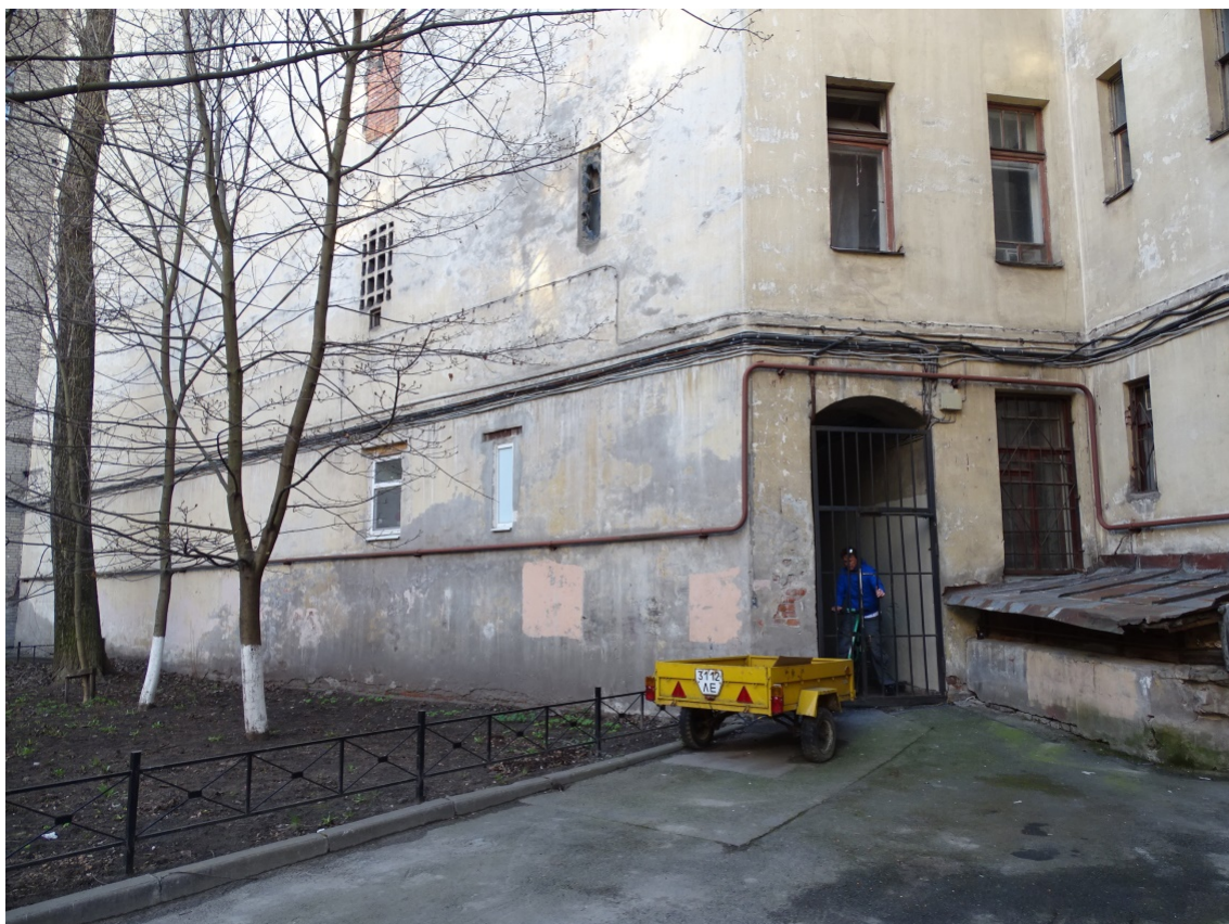
Фото 24. Здание по адресу: г. Санкт-Петербург, Большая Посадская, дом 1/10, литера А. Дворовой фасад. Съемка 19.04.2021 г. Штиглиц М. С.
