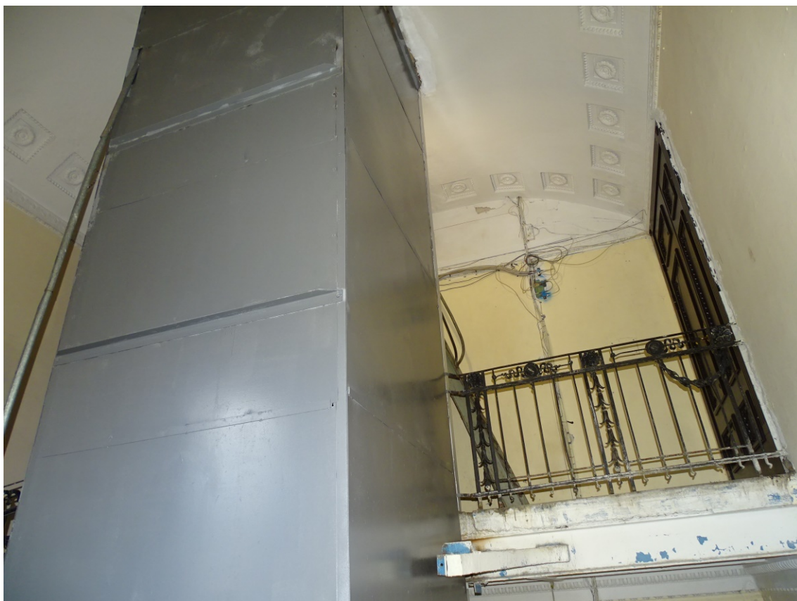
Фото 28. Лестница № 1. 6 этаж. Съемка 19.04.2021 г. Штиглиц М. С.
