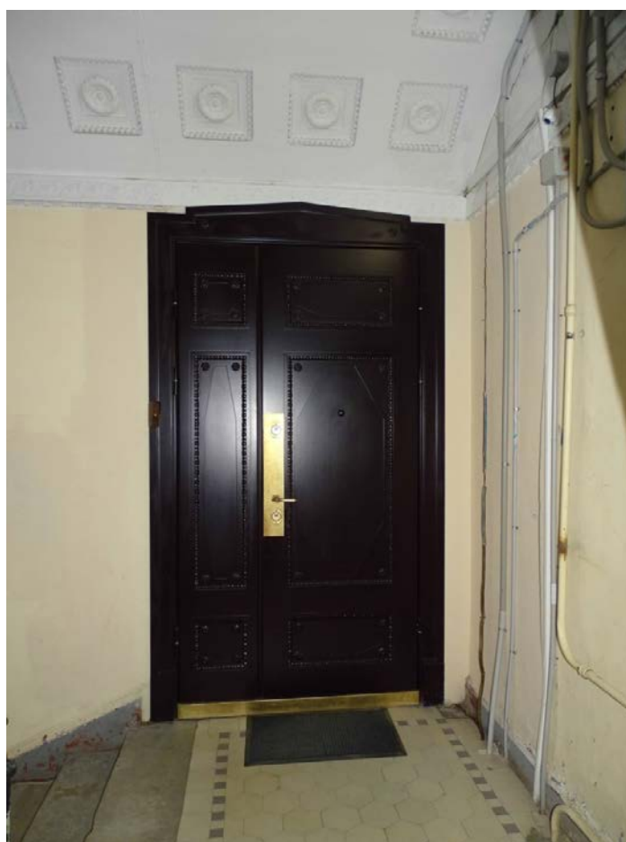
Фото 27. Лестница № 1. 6 этаж. Съемка 19.04.2021 г. Штиглиц М. С.
