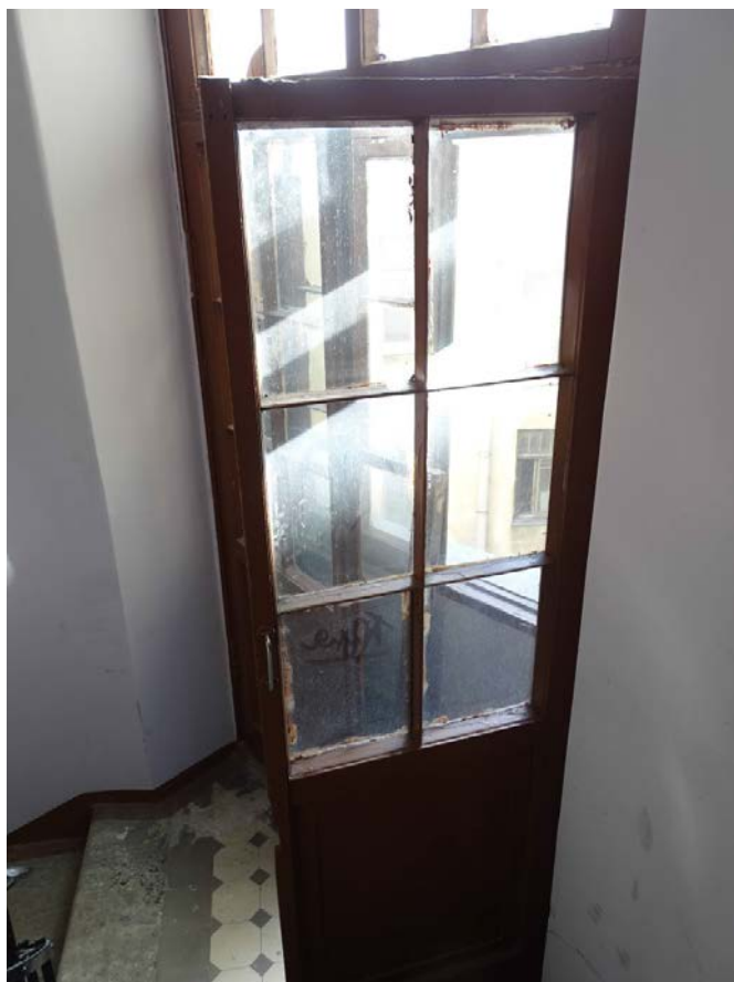
Фото 121. Лестница № 4. Площадка между 4-м и 5-м этажом. Съемка 19.04.2021 г. Штиглиц М. С.
