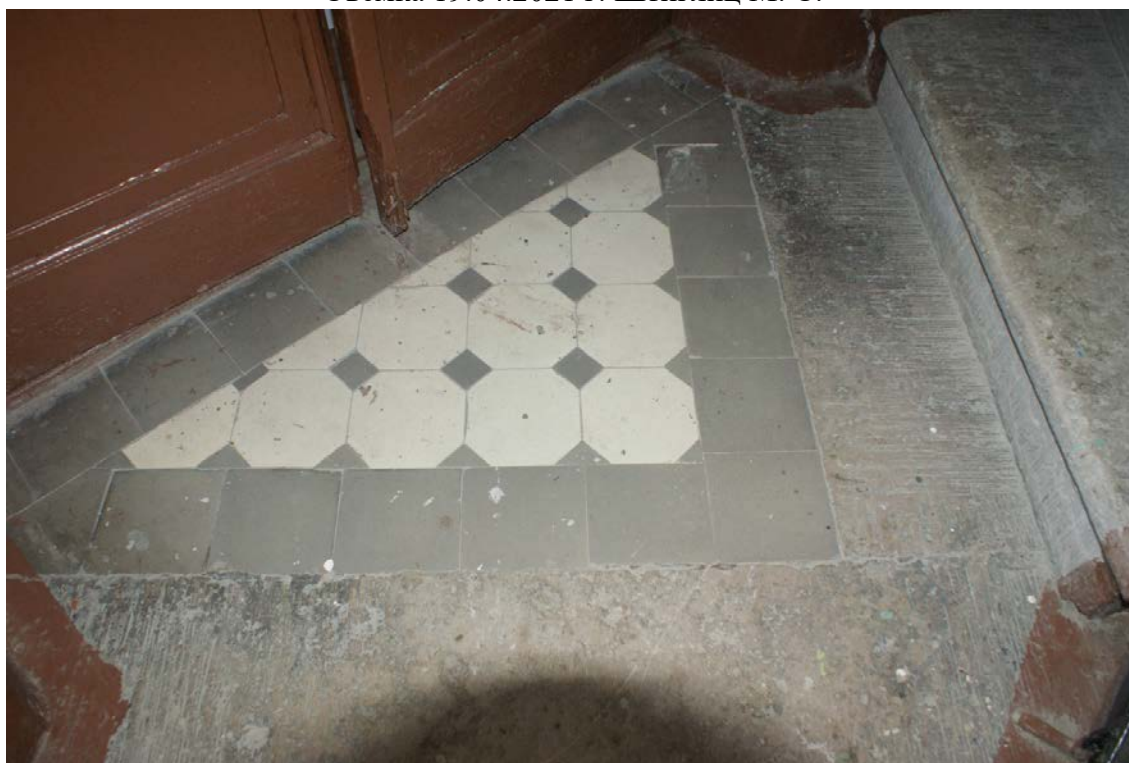
Фото 113. Лестница № 4. Площадка между 3-м и 4-м этажом. Съемка 19.04.2021 г. Штиглиц М. С.
