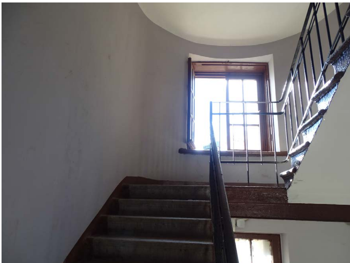
Фото 133. Лестница № 4. Площадка между 6-м и чердачным этажом. Съемка 19.04.2021 г. Штиглиц М. С.
