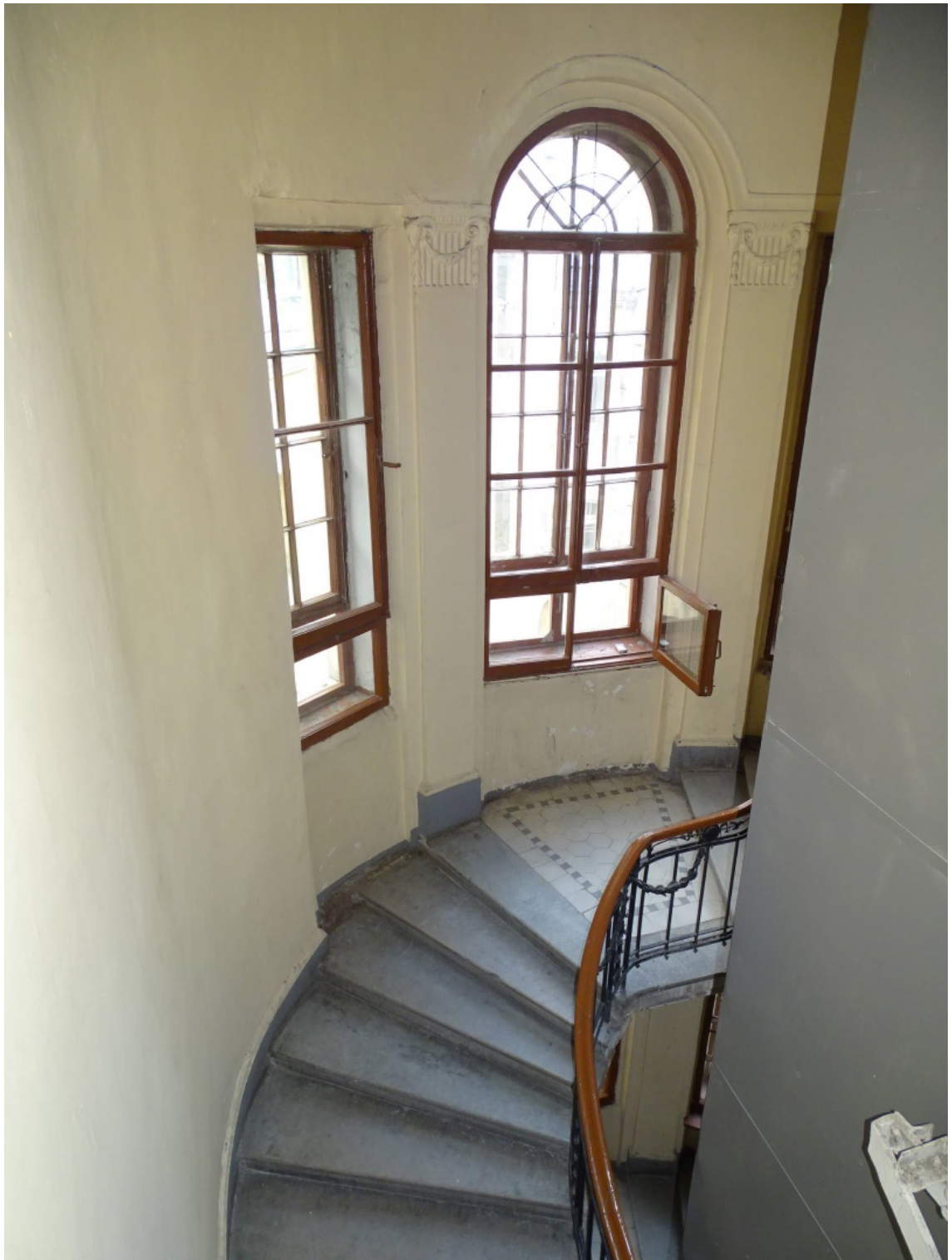
Фото 25. Лестница № 1. Площадка между 5-м и 6-м этажом. Съемка 19.04.2021 г. Штиглиц М. С.
