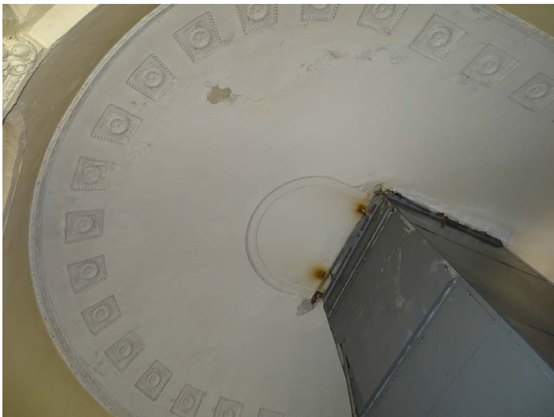
Фото 26. Лестница № 1. Площадка между 5-м и 6-м этажом. Оформление потолка. Съемка 19.04.2021 г. Штиглиц М. С.
