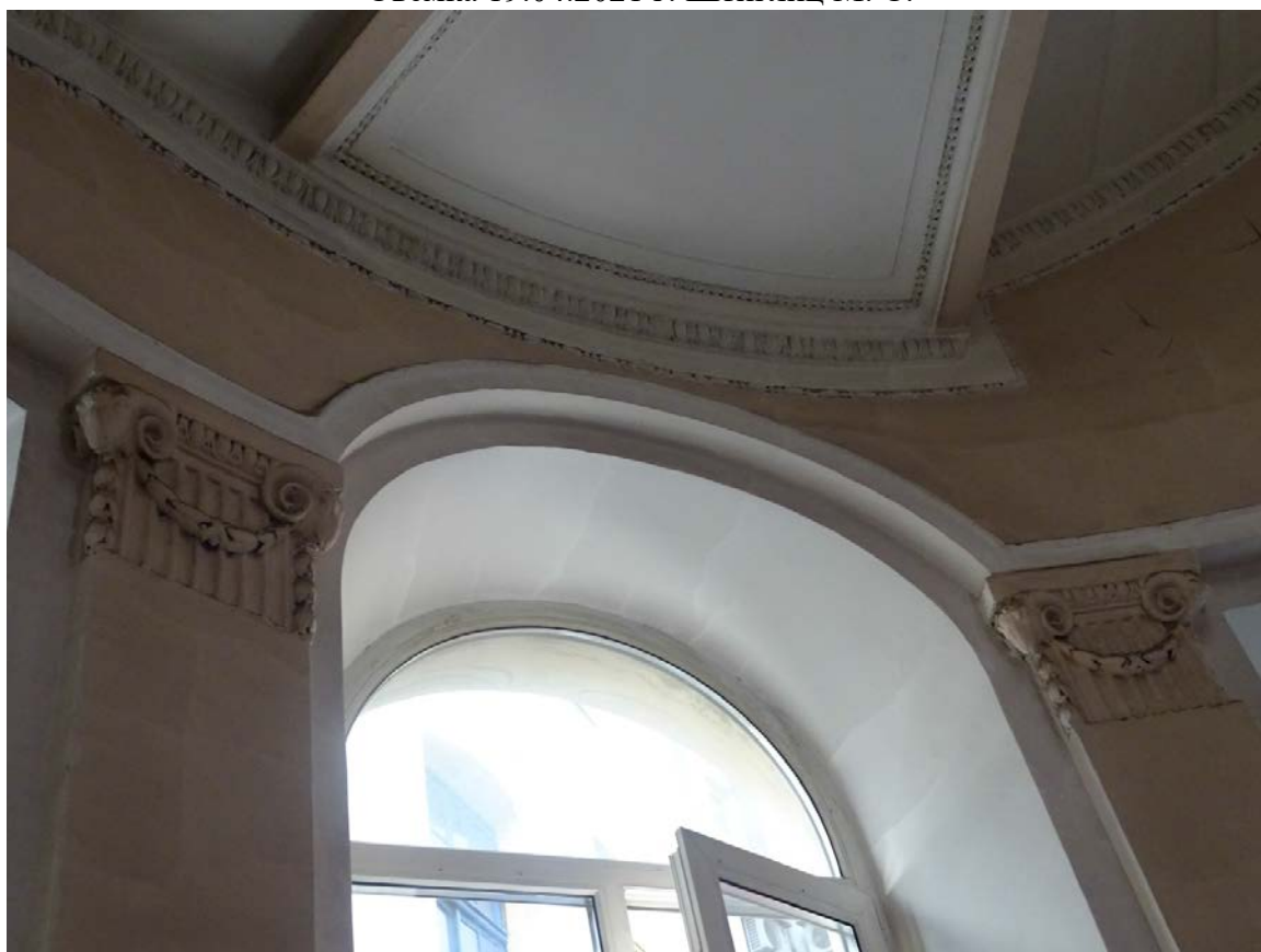
Фото 45. Лестница № 2. Площадка между 1-м и 2-м этажом. Съемка 19.04.2021 г. Штиглиц М. С.
