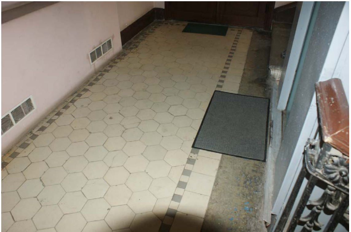
Фото 53. Лестница № 2. 3-й этаж. Покрытие пола. Съемка 19.04.2021 г. Штиглиц М. С.
