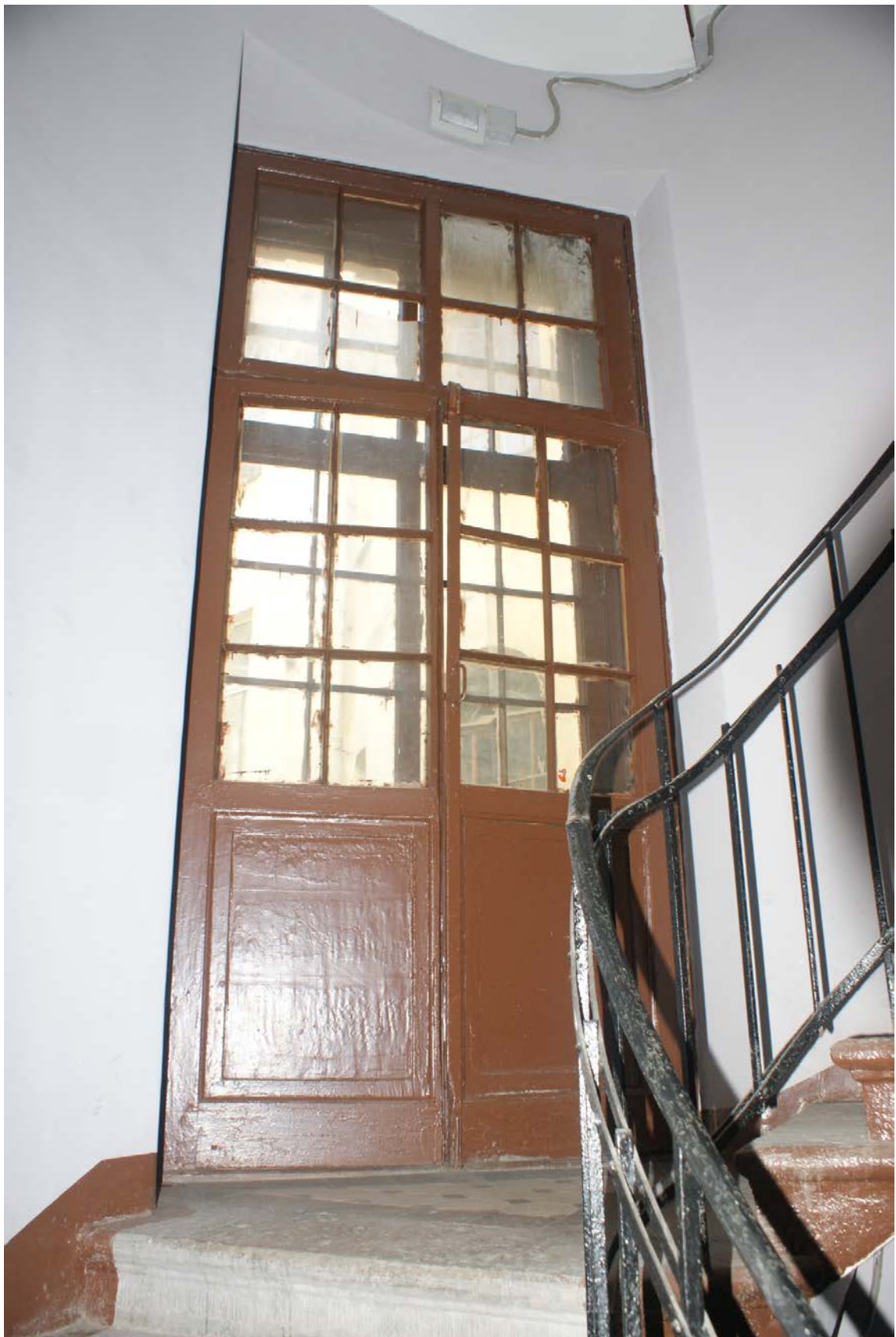
Фото 114. Лестница № 4. Площадка между 3-м и 4-м этажом. Съемка 19.04.2021 г. Штиглиц М. С.
