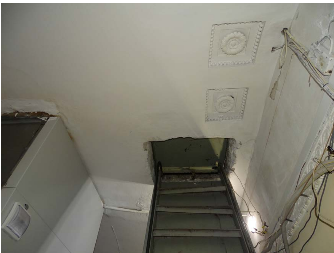
Фото 31. Лестница № 1. 6 этаж. Съемка 19.04.2021 г. Штиглиц М. С.
