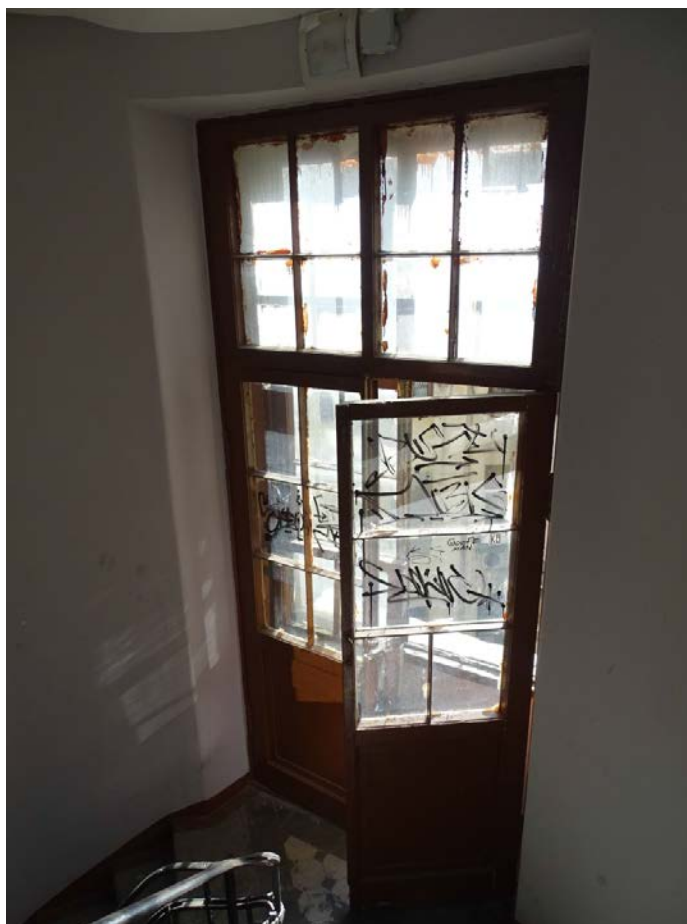
Фото 127. Лестница № 4. Площадка между 5-м и 6-м этажом. Съемка 19.04.2021 г. Штиглиц М. С.
