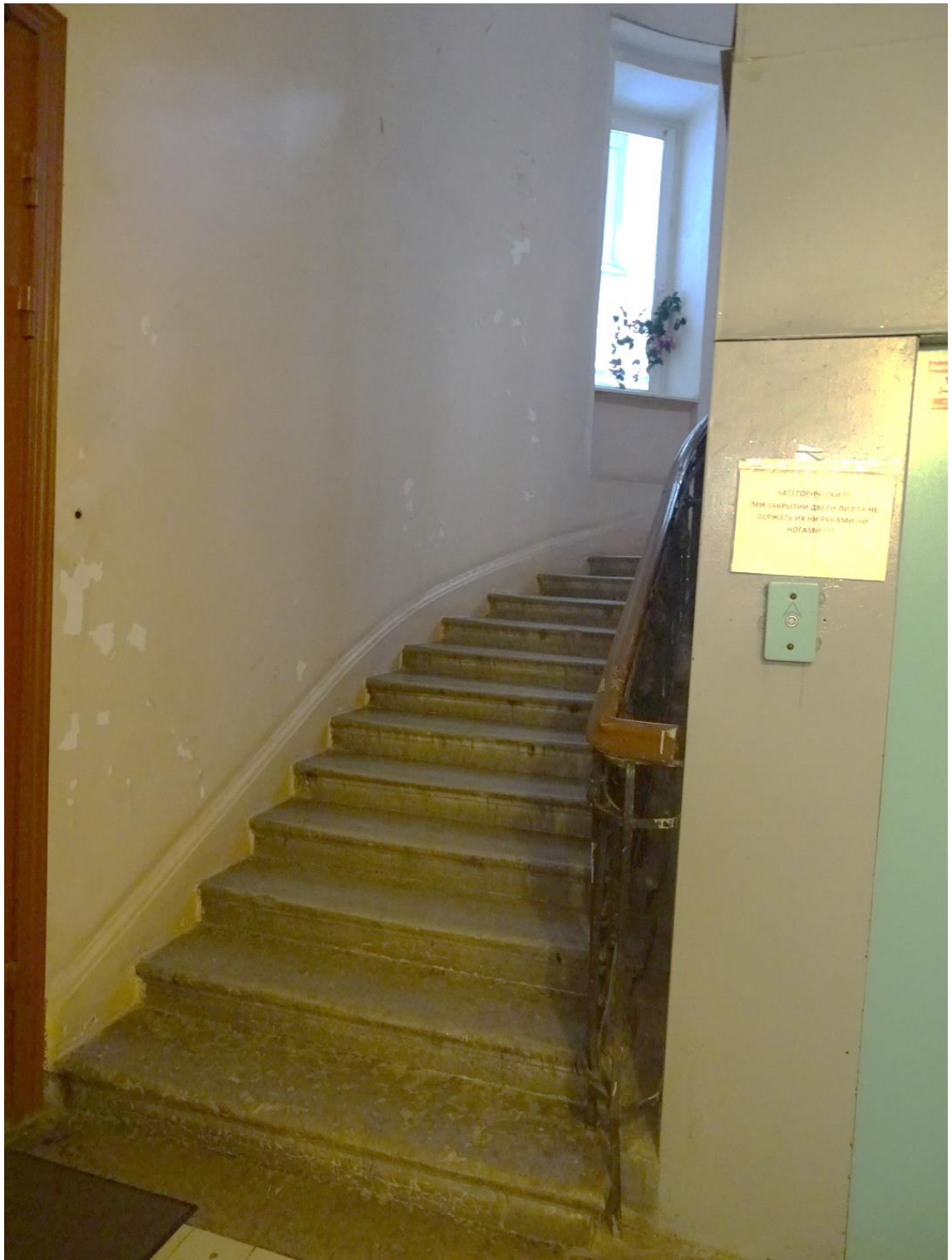
Фото 42. Лестница № 2. Вестибюль 1-го этажа. Съемка 19.04.2021 г. Штиглиц М. С.
