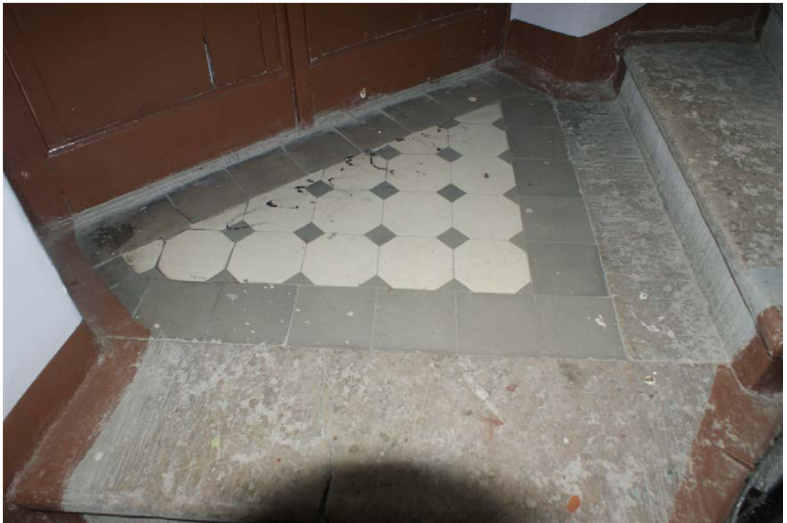
Фото 108. Лестница № 4. Площадка между 2-м и 3-м этажом. Съемка 19.04.2021 г. Штиглиц М. С.
