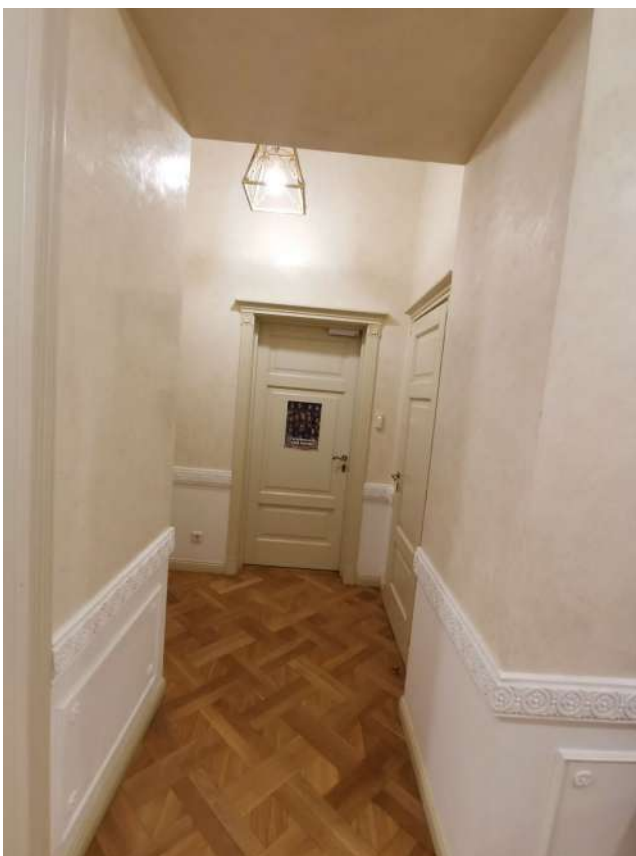
Фото 5. Вид на новые дверные заполнения проемов.
