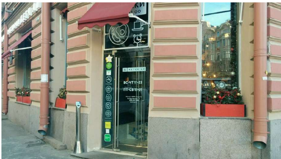
Фото № 4. Фрагмент лицевого фасада помещения 3-Н с дверью ДН-1
