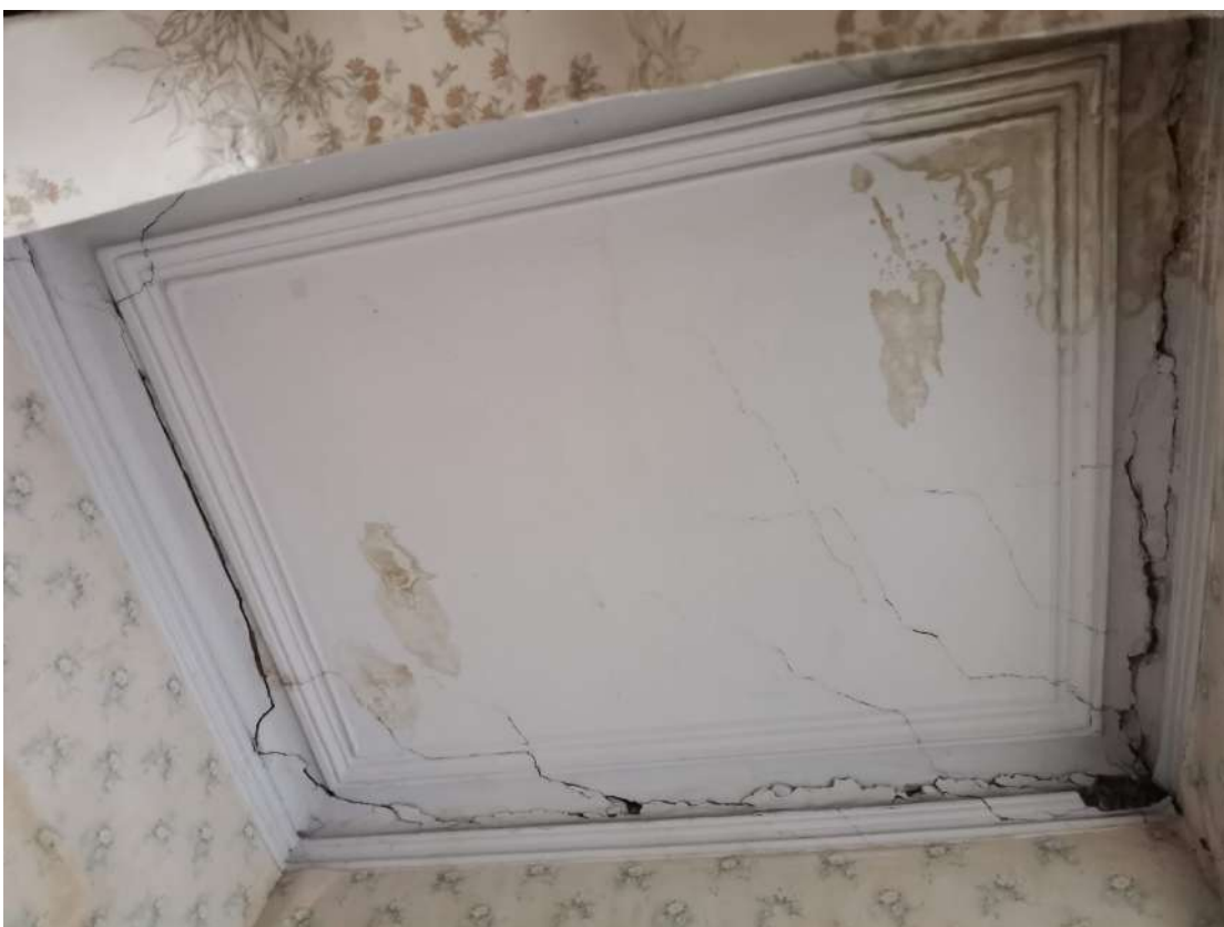
Фото №30. Фрагмент потолка помещения (пом.№12 согласно плану ПИБ)
