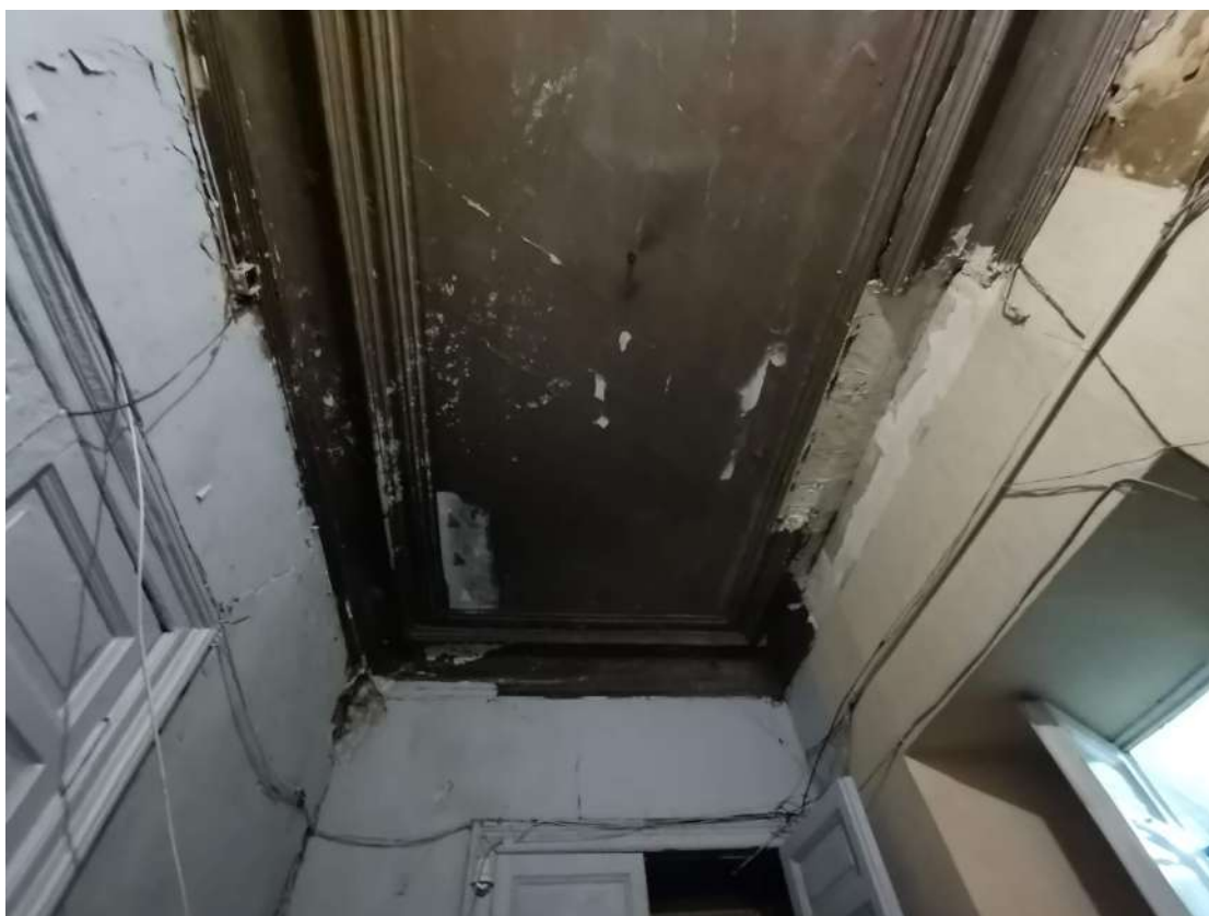
Фото №20. Фрагмент потолка помещения (пом.№1 согласно плану ПИБ)
