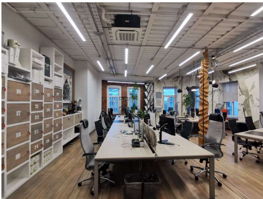
Фото 9. Общий вид офисного помещения, устройство новых перекрытий
