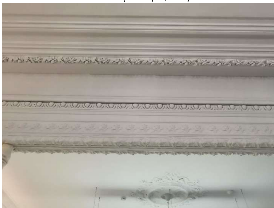
Фото 4. Сложный профилированный карниз
