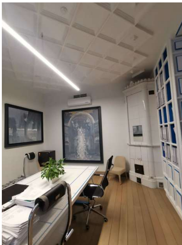
Фото 19. Вид на угловую печь гладкого белого изразца, с рельефным антаблементом в виде пальметт.
