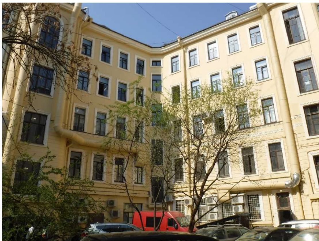
Фото № 7. Фрагмент дворового фасада помещения 3-Н с дверьми ДН-2 и ДН-3
