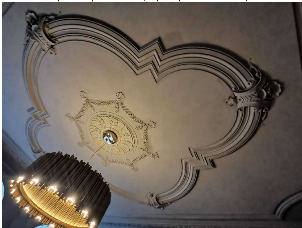
Фото 10. Лепное оформление потолка с профилированной падугой, и розеткой сложного рисунка.
