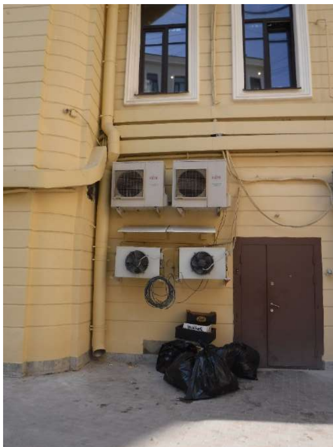
Фото № 12. Общий вид на дверь ДН-3 со стороны двора
