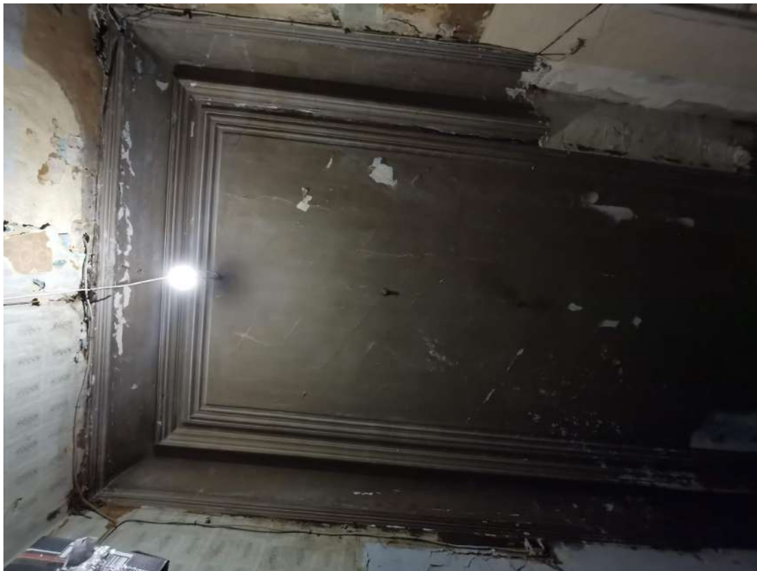
Фото №17. Фрагмент потолка помещения (пом.№1 согласно плану ПИБ)
