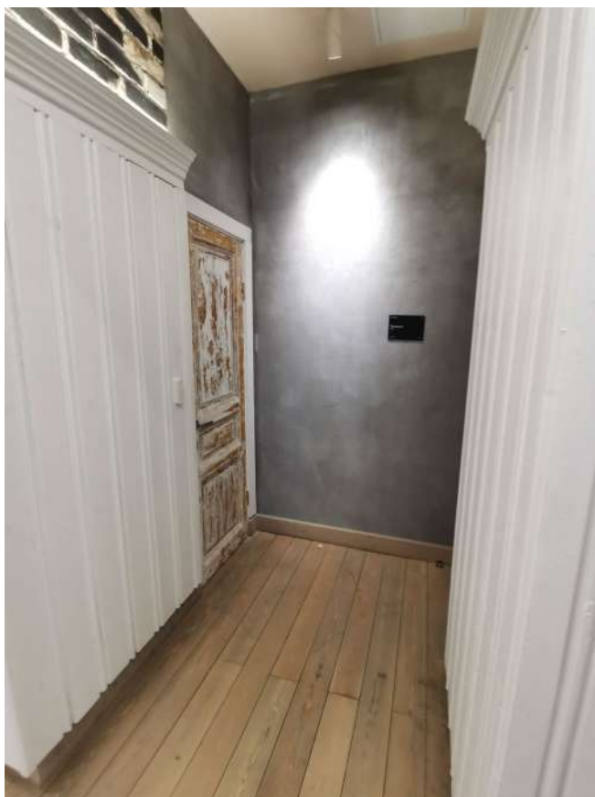
Фото 13. Заполнение дверного проема
