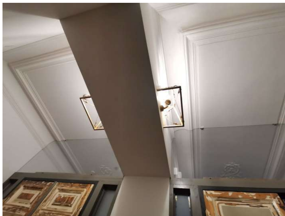
Фото 8. Лепное оформление с профилированной падугой, зеркалом потолка и розетками сложного рисунка под люстру.
