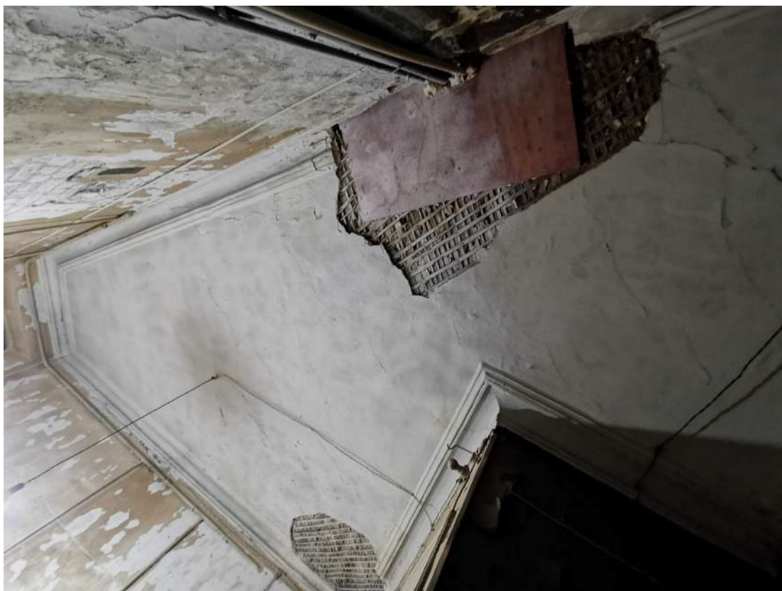
Фото №5. Фрагмент потолка помещения кухни (пом.№7 согласно плану ПИБ)
