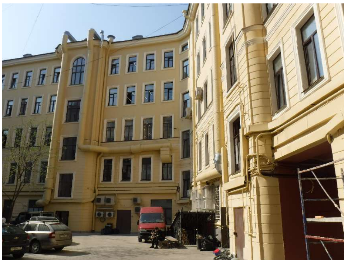
Фото № 6. Общий вид на дворовой фасад помещения 3-Н с дверьми ДН-2 и ДН-3
