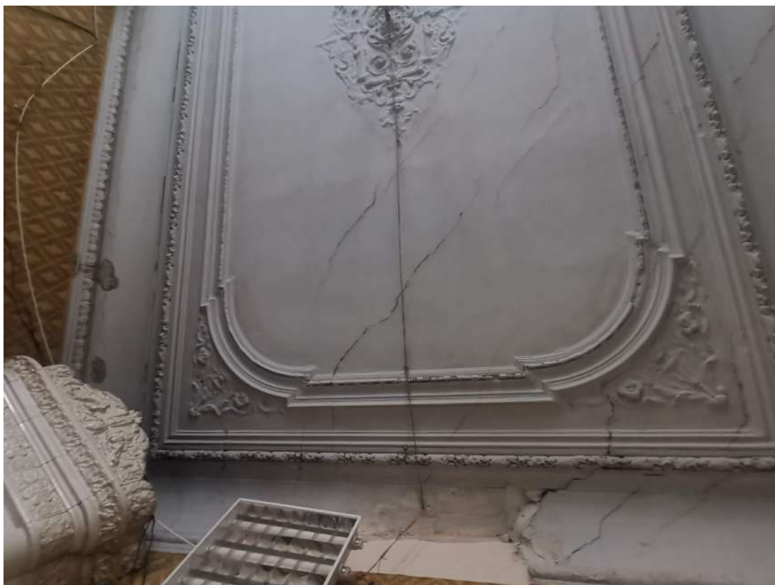
Фото №45. Фрагмент потолка помещения (пом.№4 согласно плану ПИБ)
