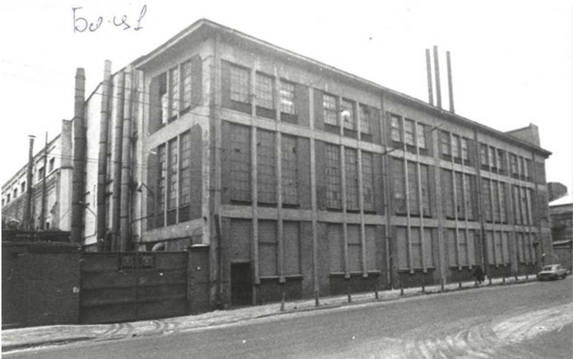
Илл. 45. Цех Завода «Русский дизель» 1930-х гг. постройки. Фасад по Большому Сампсониевскому проспекту. Фото 1970-х гг. Сектор хранения документированной информации КГИОП.
