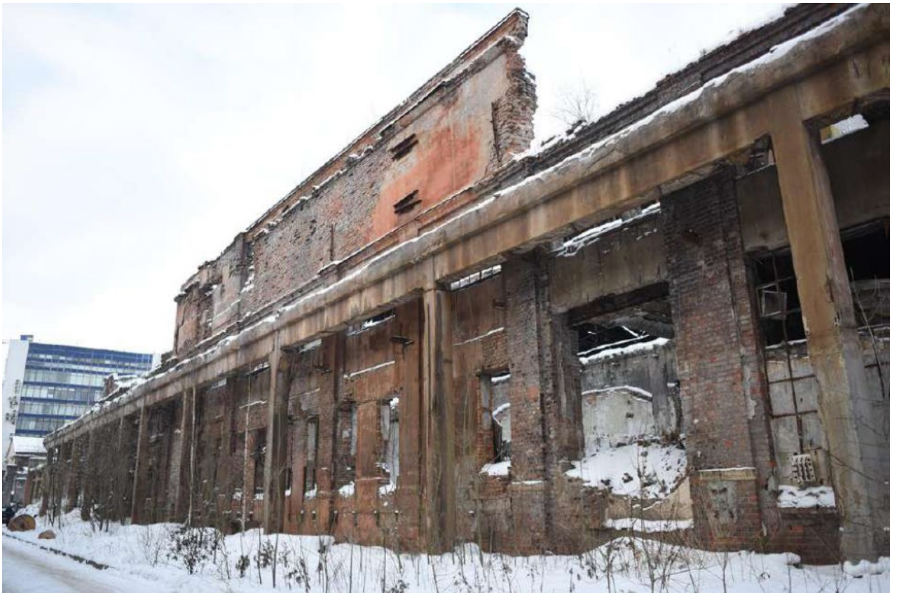
Фото 3. Фрагмент южного фасада со стороны внутриворовой территории.
