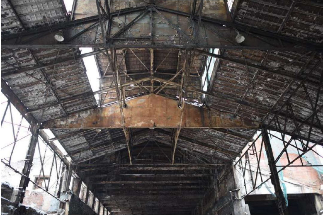
Фото 7. Интерьер. Конструкции светового фонаря.
