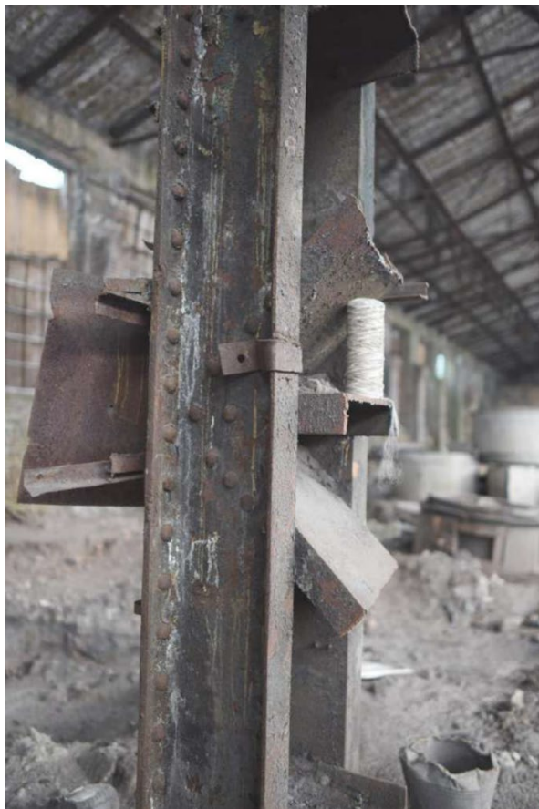
Фото 8. Интерьер. Фрагмент колонны.
