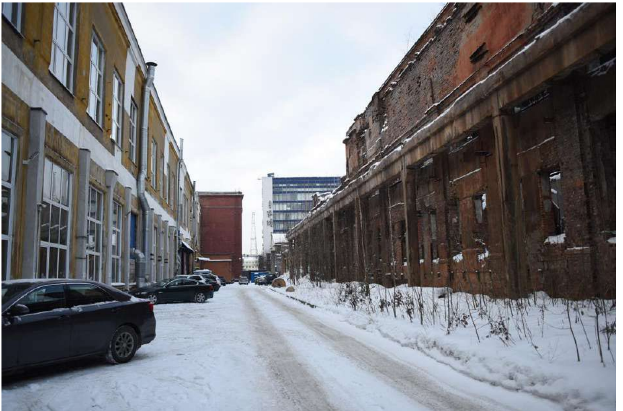
Фото 4. Внутриворговая территория завода.
