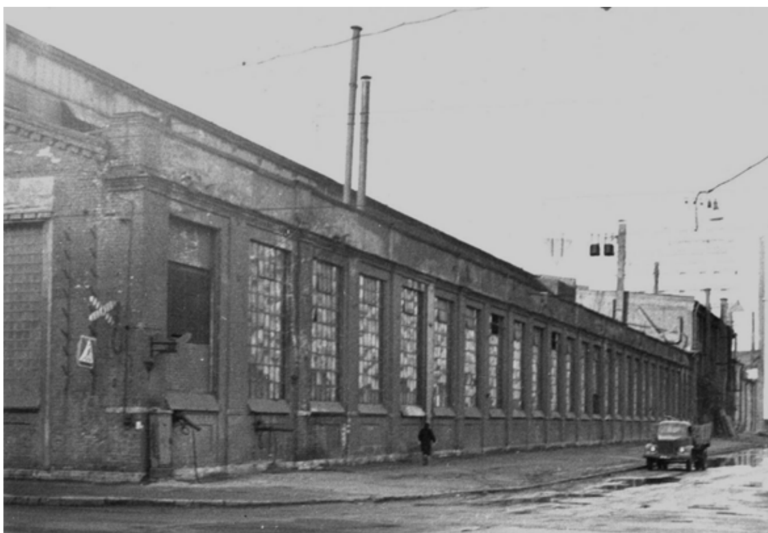
Илл. 39. Чугунолитейный цех. Фасад по улице Фокина. Фото 1970-х гг. Сектор хранения документированной информации КГИОП.
