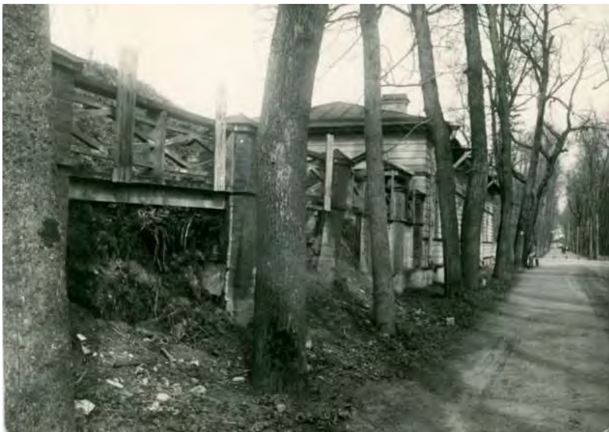
Илл. 42. Разрушенный забор владений Главвоенпорта с южной стороны. 1930-е гг. ГМЗ «Петергоф». ПДМП 11565-фд
