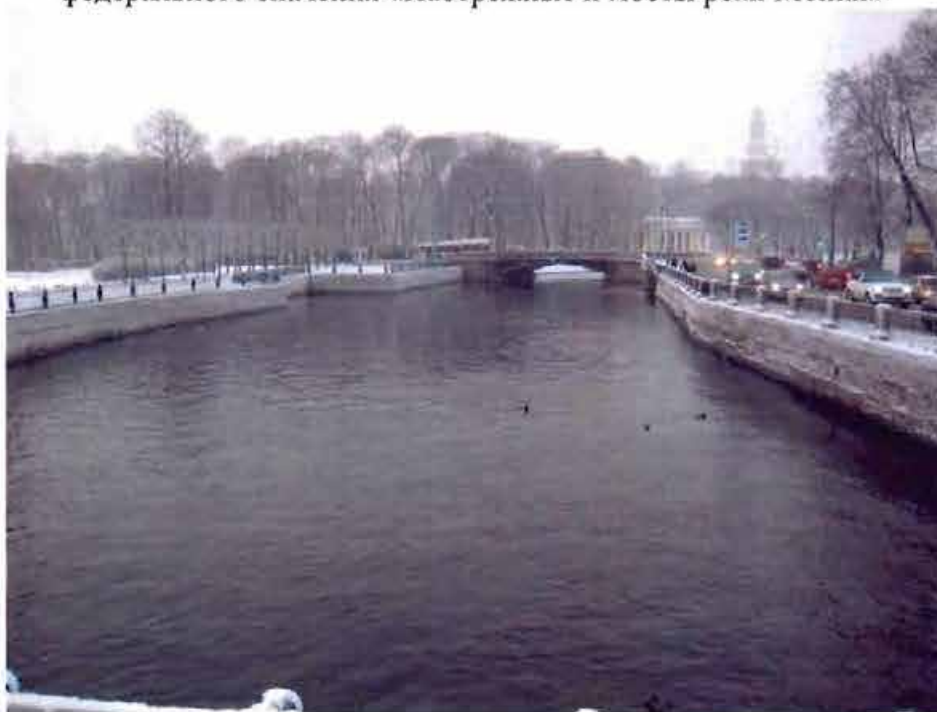
1. Набережные. Вид со стороны Инженерного Первого моста
