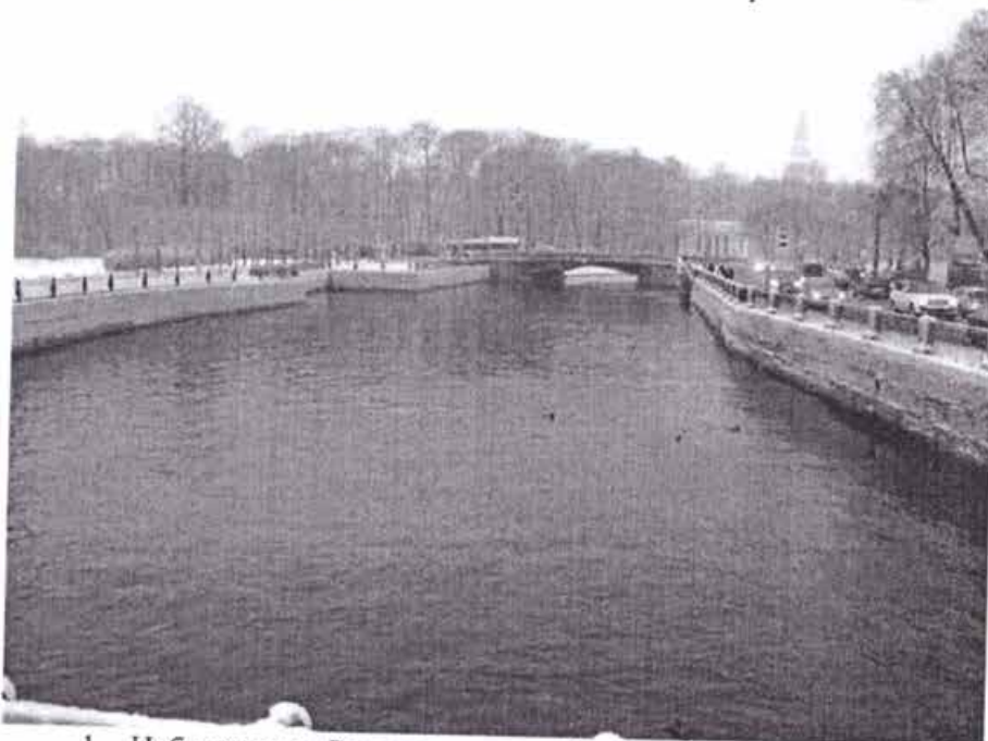
1. Набережные. Вид со стороны Инженерного Первого моста
