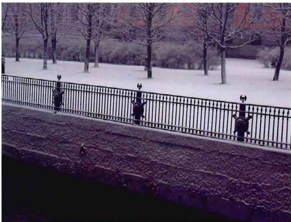
3. Ограждение набережной со стороны Михайловского (Инженерного) замка
