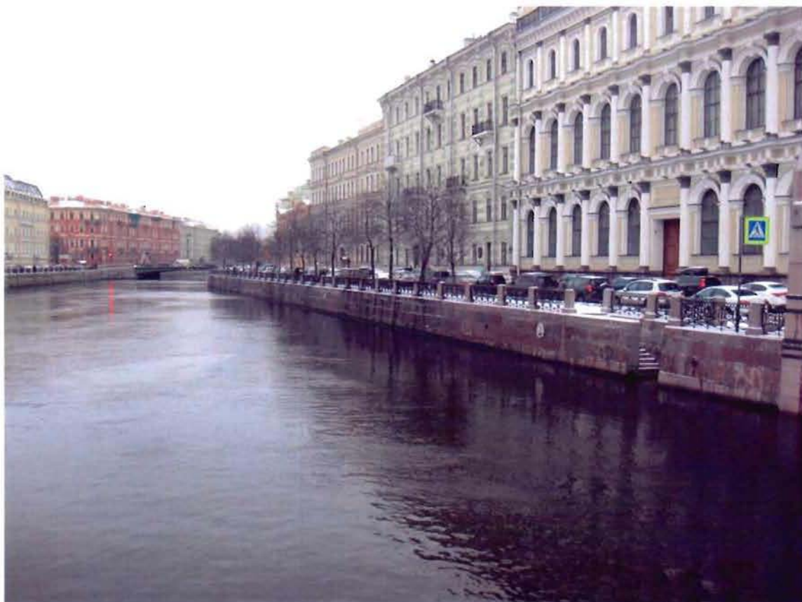
13. Вид на правобережную набережную с Синего моста
