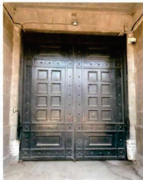
3. Ворота лицевого северо-западного фасада.
