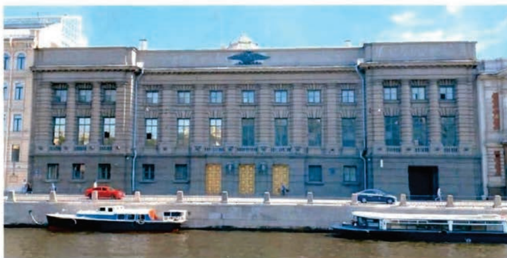
1. Лицевой северо-западный фасад.
