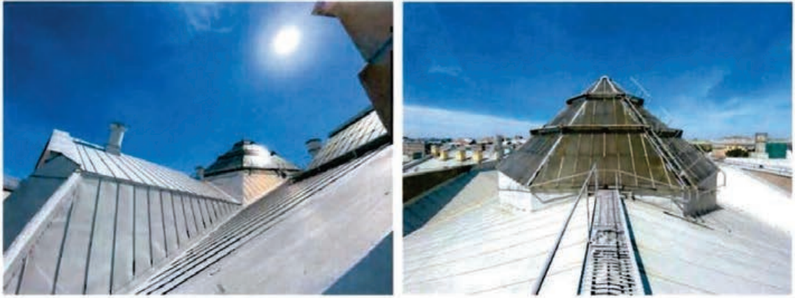
32-34. Конструкции световых фонарей.
