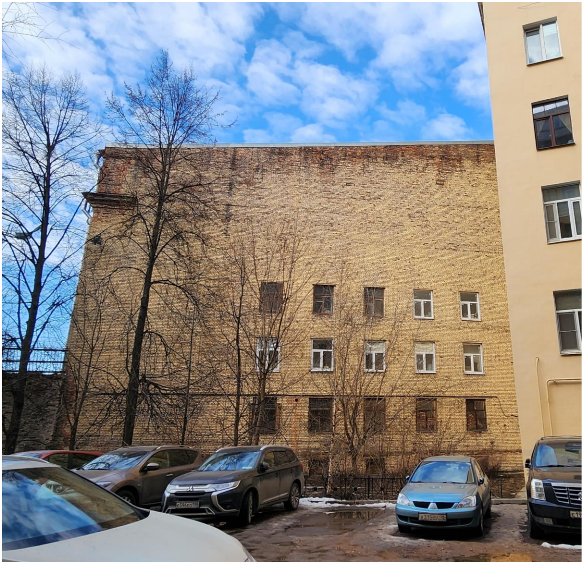
Фото 7. Литера А со стороны двора дома № 29 по Кронверкскому пр.
