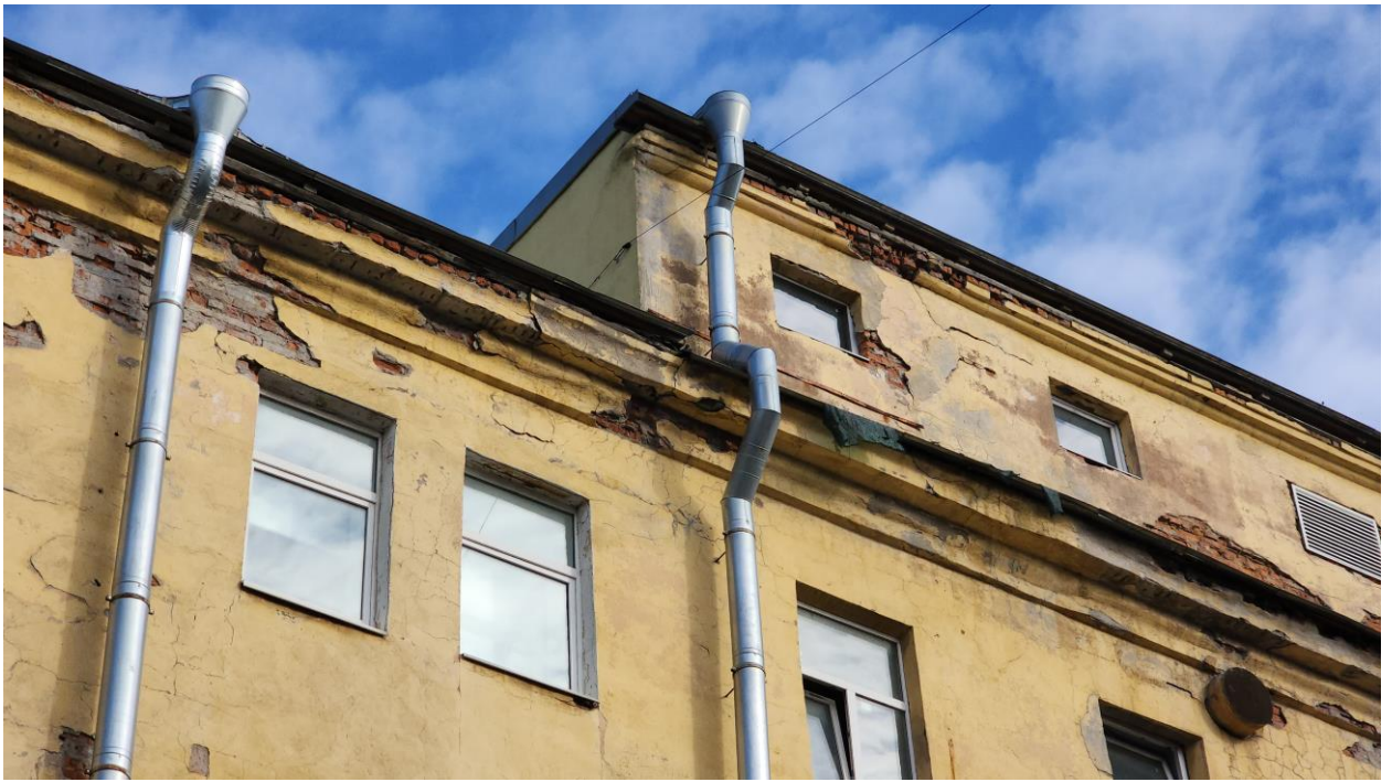
Фото 3. Литера А со стороны заднего двора. Венчающие карнизы.
