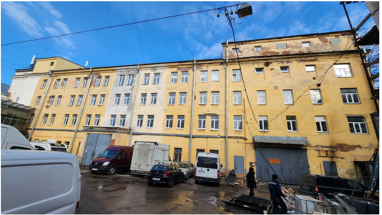
Фото 1. Литера А со стороны заднего двора.
