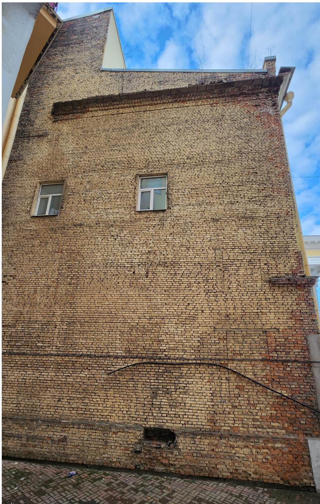
Фото 8. Литера А со стороны двора дома № 27 Б по Кронверкскому пр.
