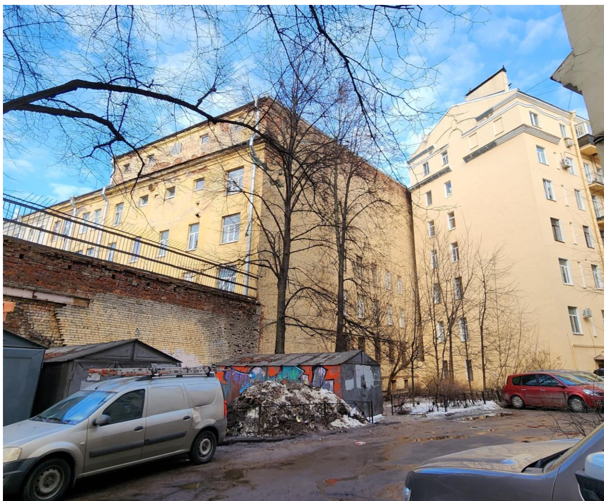
Фото 6. Литера А со стороны двора дома № 29 по Кронверкскому пр.
