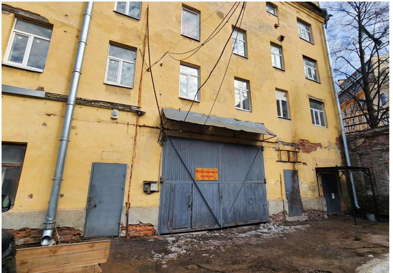
Фото 2. Литера А со стороны заднего двора. Ворота.
