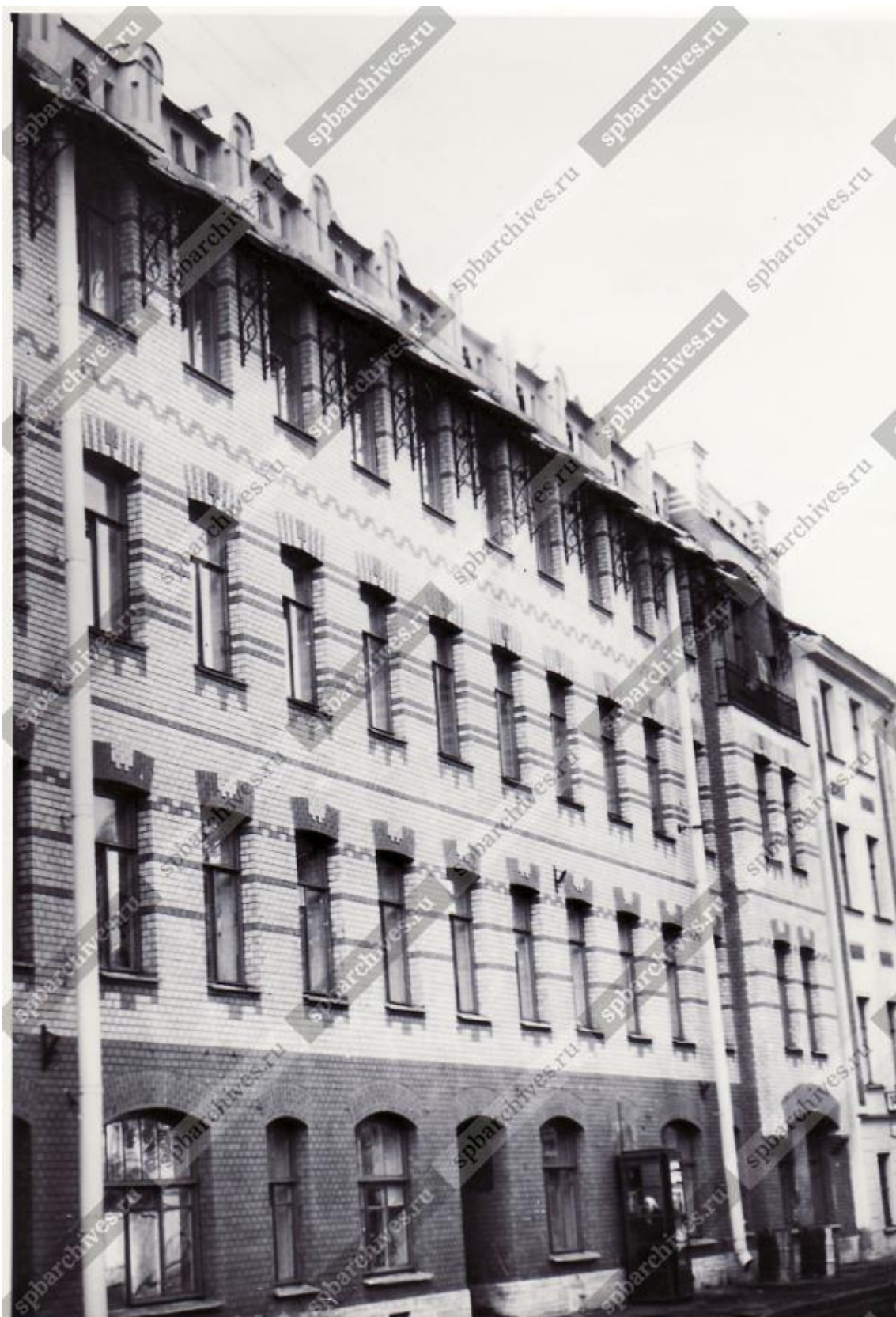
Илл. 24. Вид центрального фасада жилого дома № 12 по улице Блохина (архитектор А.К.Голосуев, 1905 год.) 12 сентября 1982 г. Овчинников Кирилл Владимирович. ЦГАКФФД СПб Ар 215739
