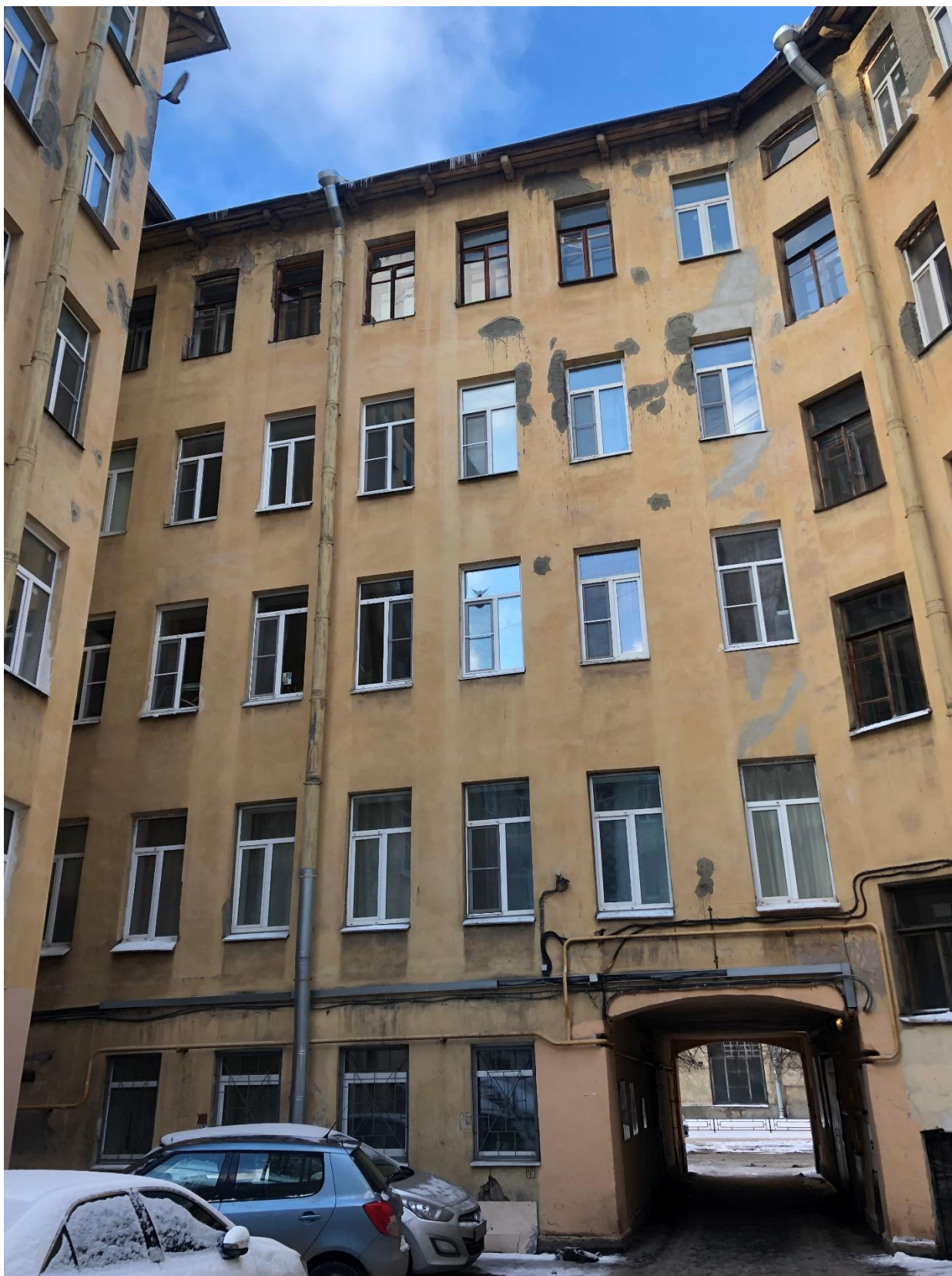
Фото 6. Вид на дворовый фасад исследуемого объекта.
