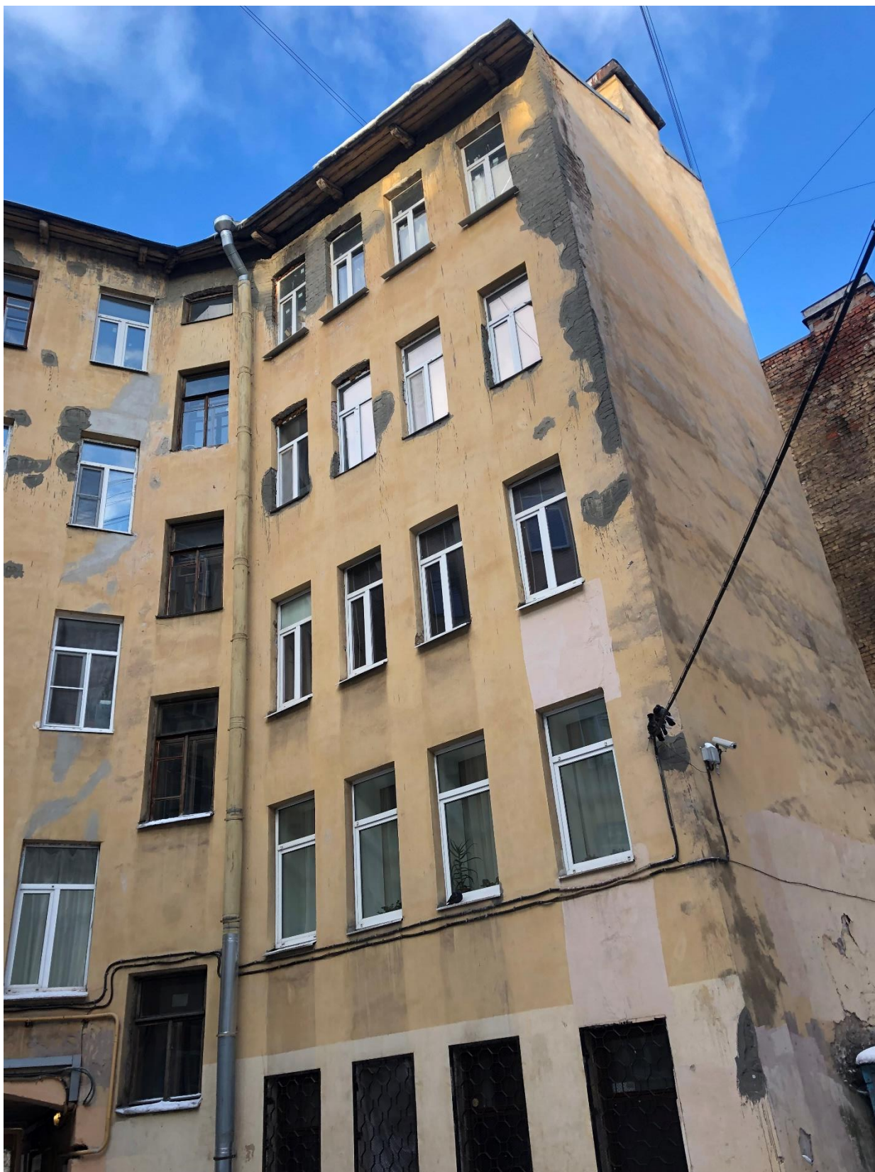
Фото 7. Вид на дворовый фасад исследуемого объекта.
