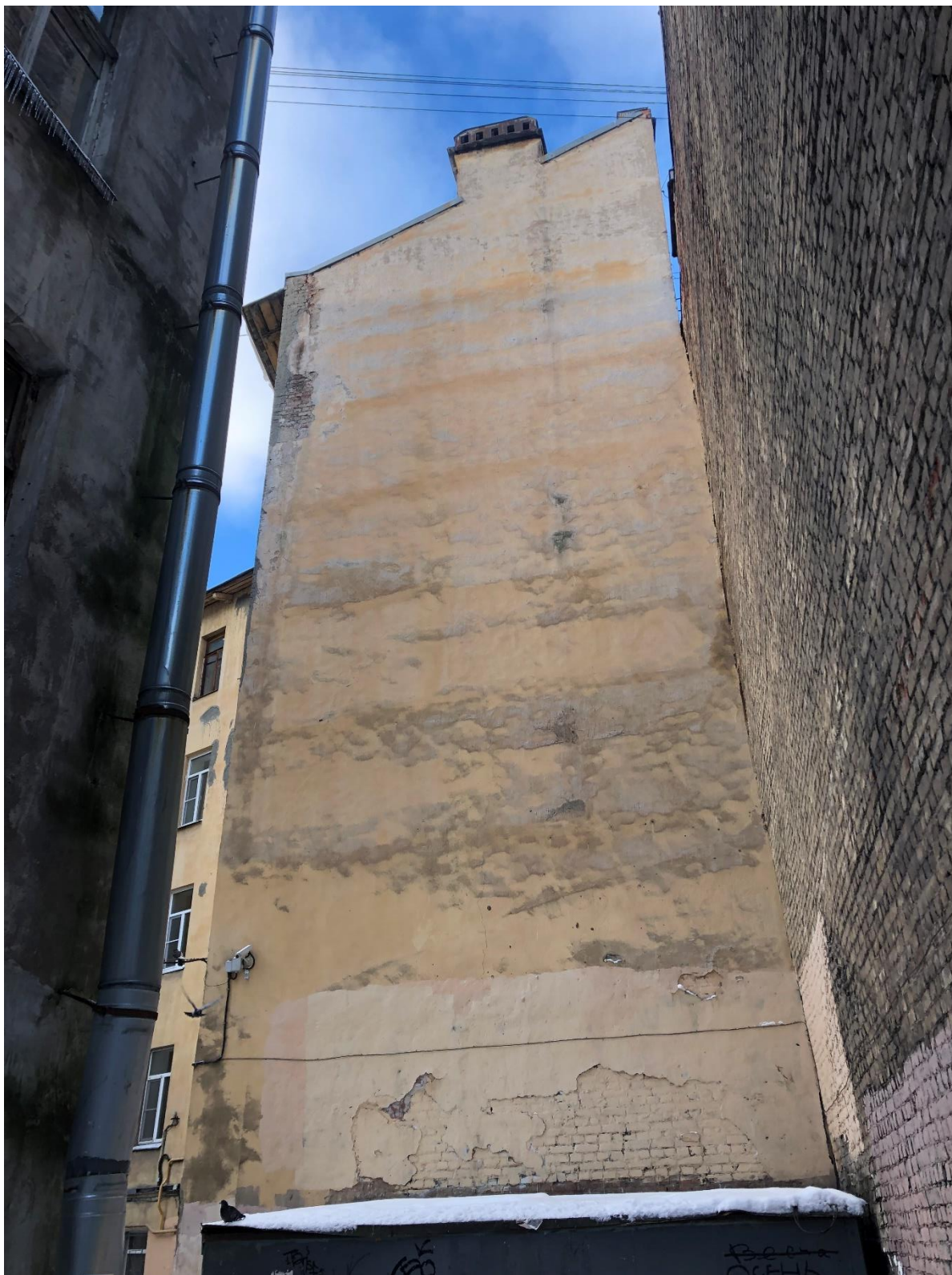
Фото 9. Вид на дворовый фасад исследуемого объекта.
