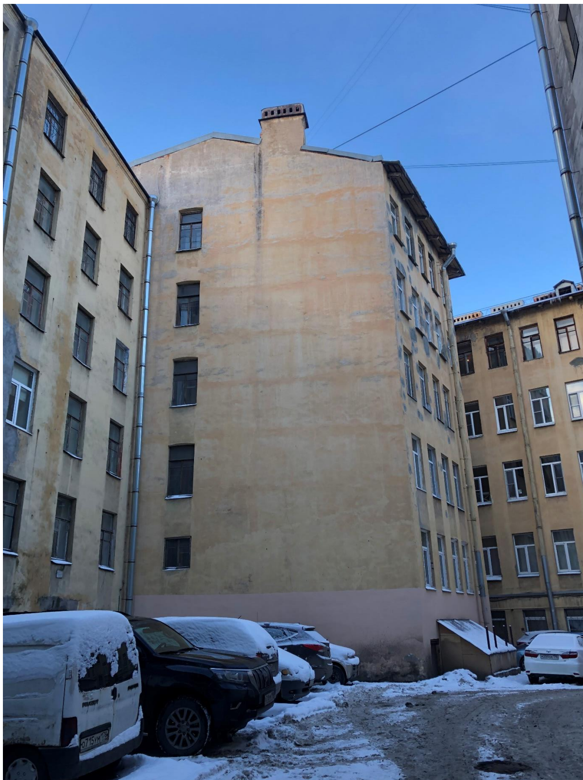
Фото 8. Вид на дворовый фасад исследуемого объекта.
