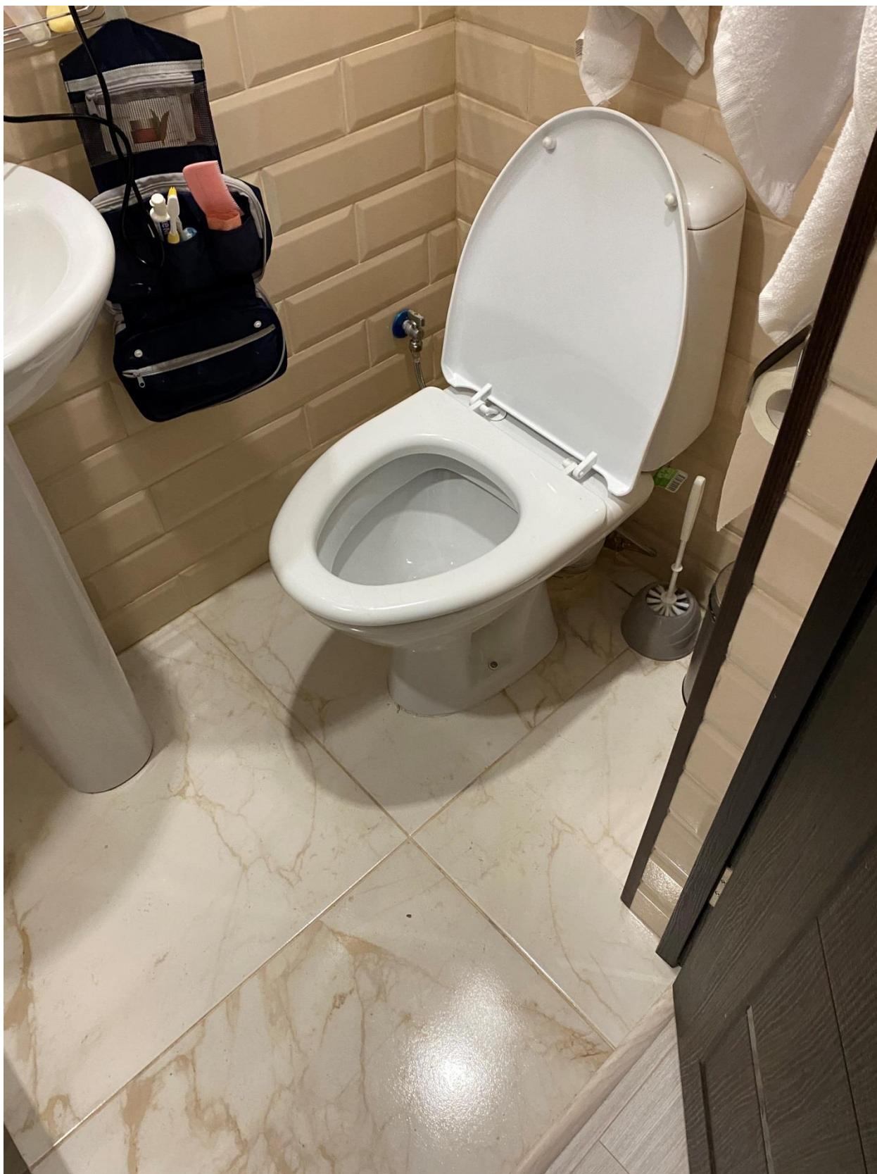
Фото 35. Вид на помещение квартиры № 10 объекта культурного наследия.
