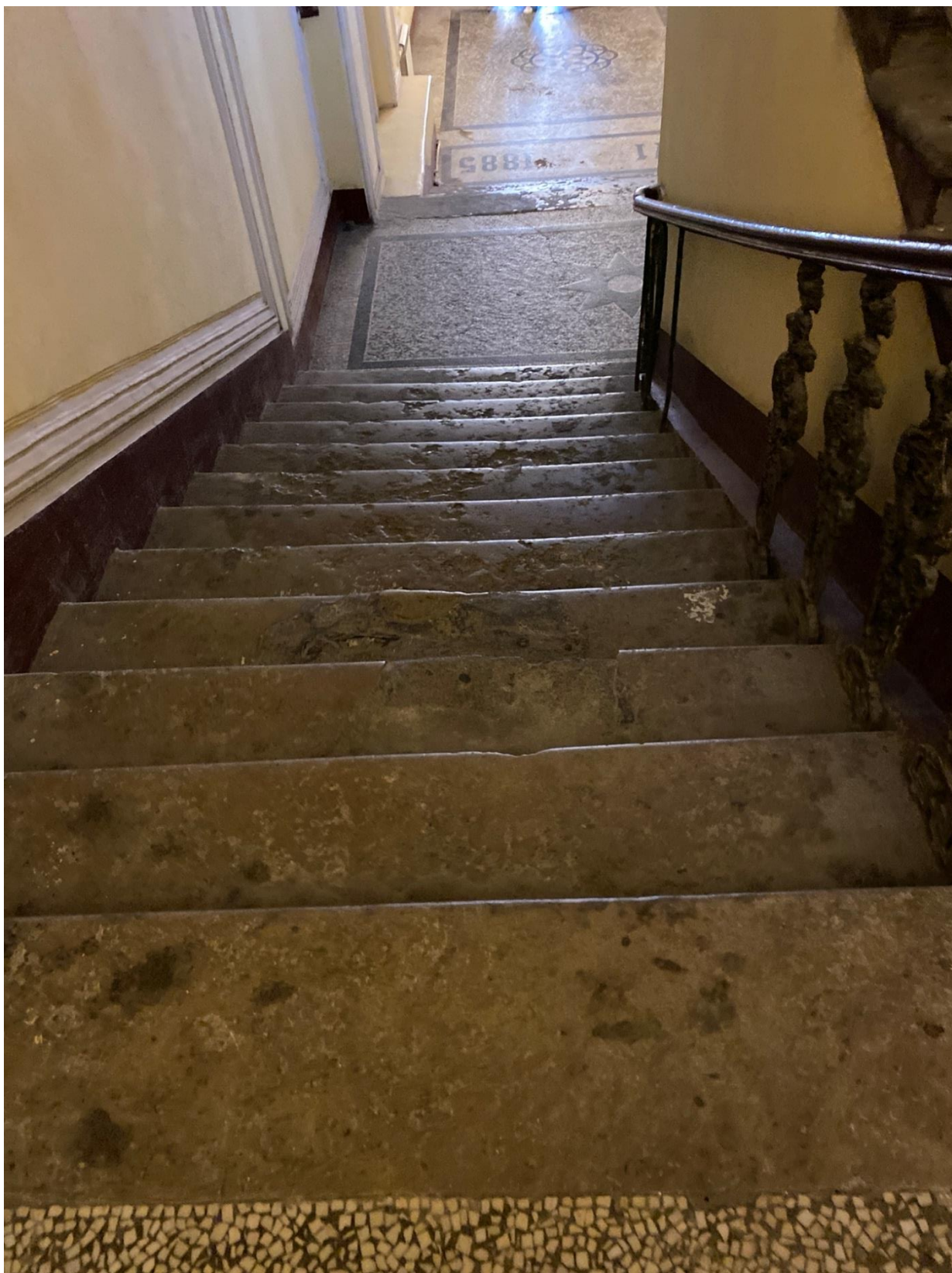
Фото 11. Вид на парадную лестницу объекта культурного наследия.
