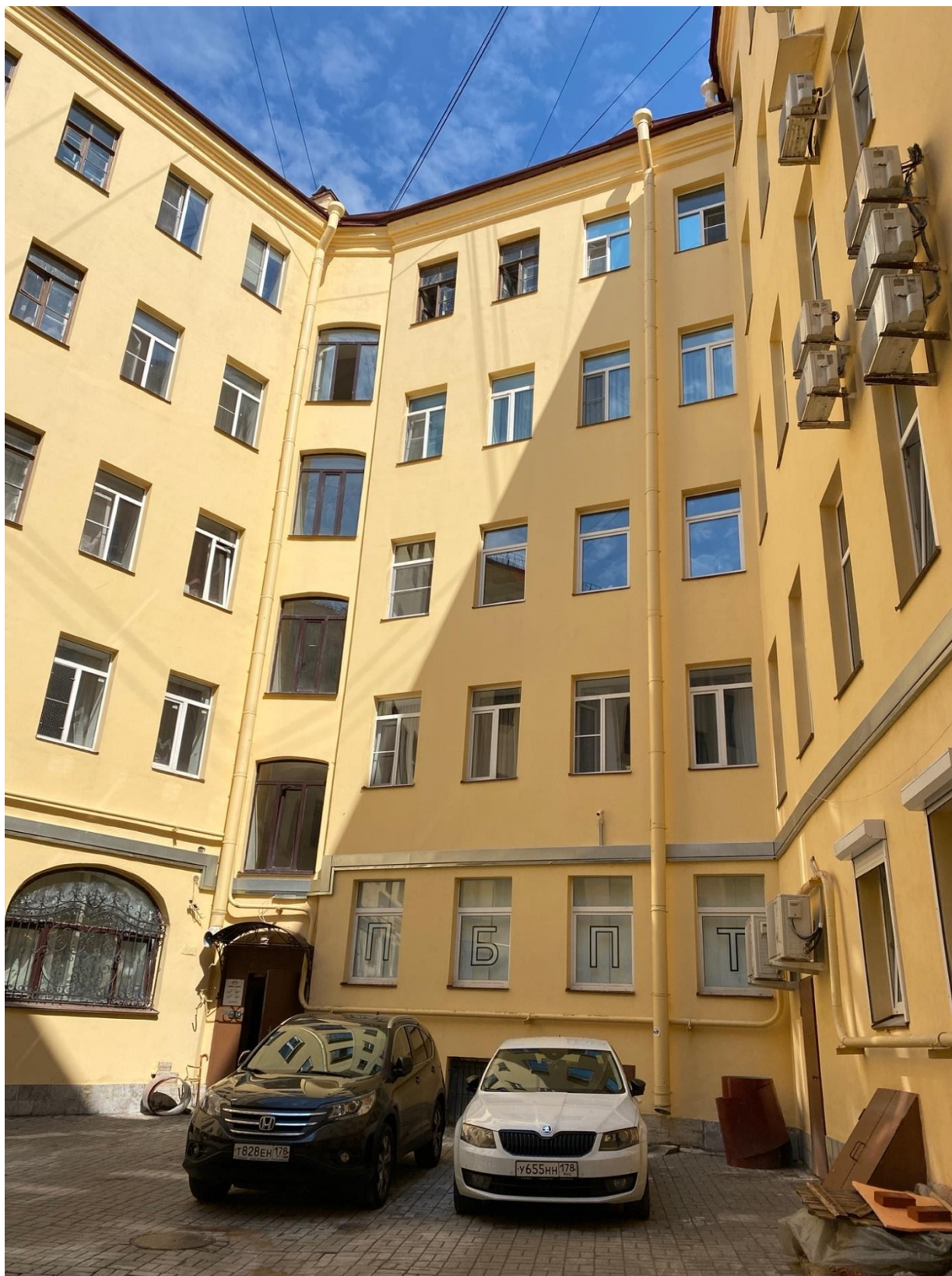
Фото 7. Вид на часть дворовых фасадов объекта культурного наследия.
