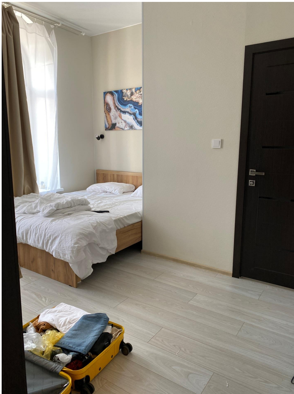
Фото 66. Вид на помещение квартиры № 10 объекта культурного наследия.
