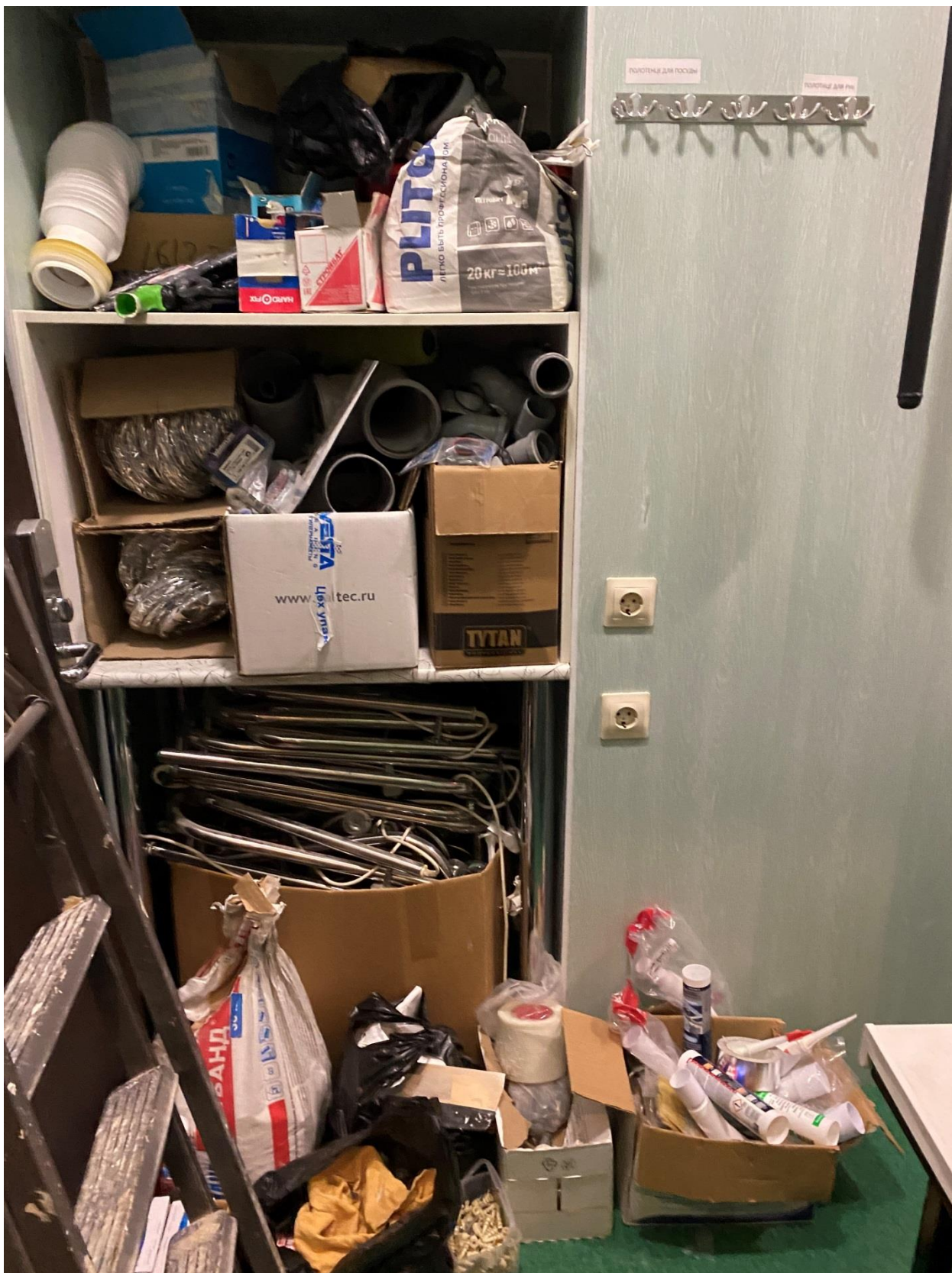
Фото 71. Вид на помещение квартиры № 10 объекта культурного наследия.
