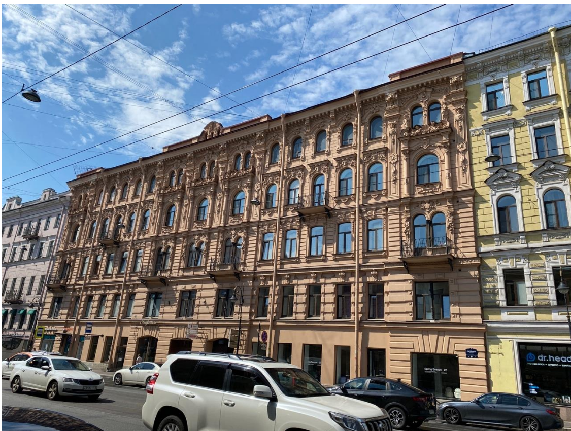
Фото 3. Общий вид лицевого фасада (по Литейному проспекту) объекта культурного наследия.
