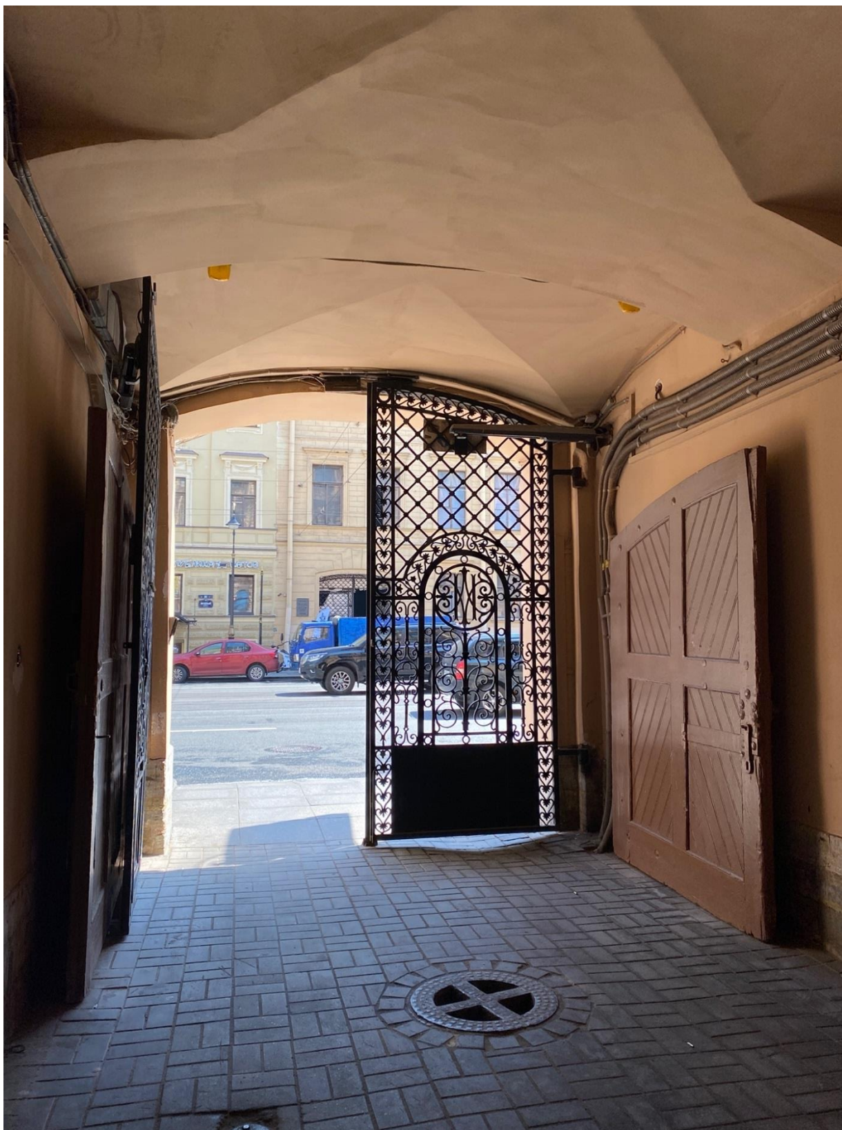
Фото 9. Вид на воротное заполнение из арки объекта культурного наследия.
