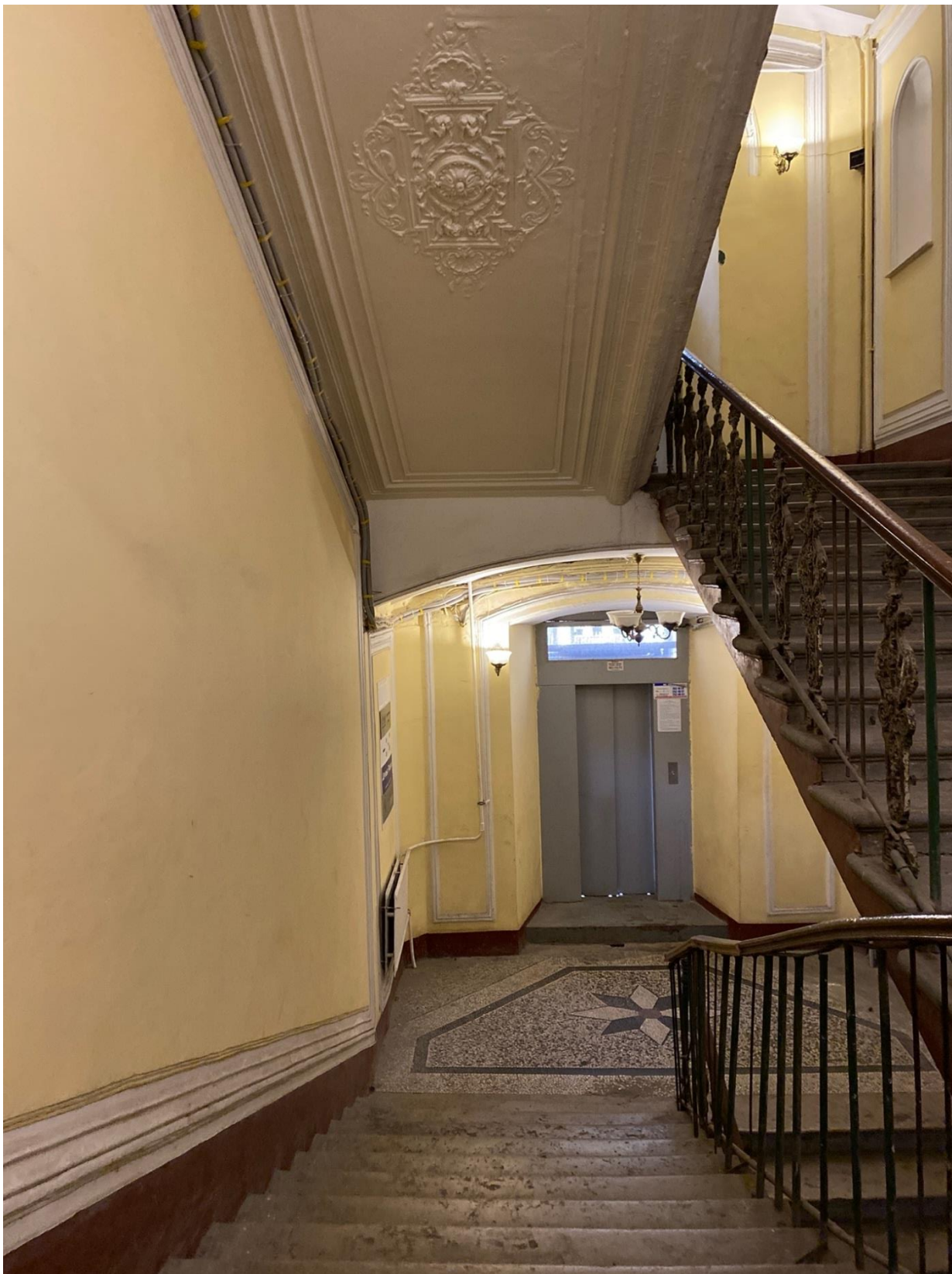
Фото 13. Вид на парадную лестницу объекта культурного наследия.
