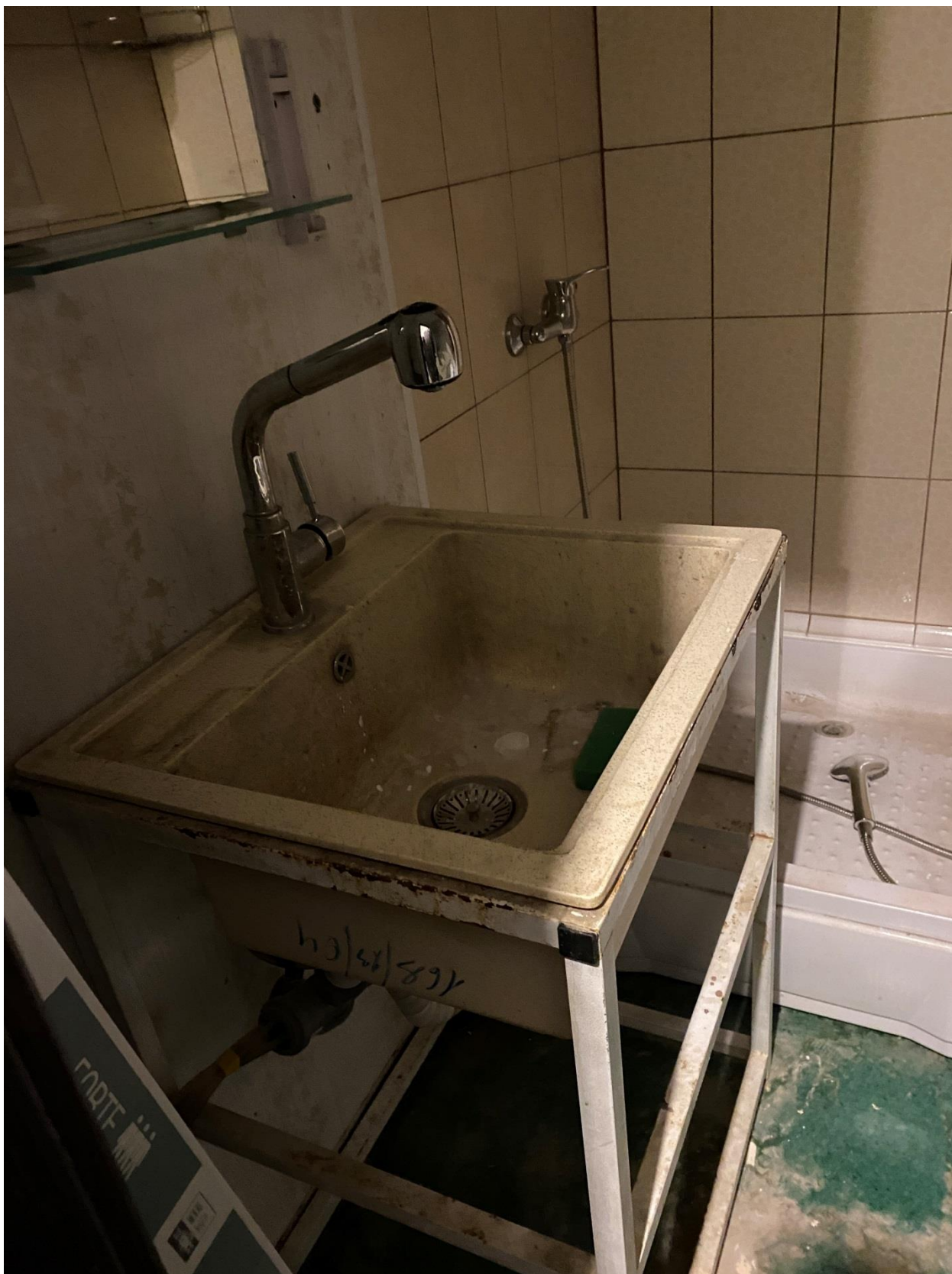
Фото 62. Вид на помещение квартиры № 10 объекта культурного наследия.
