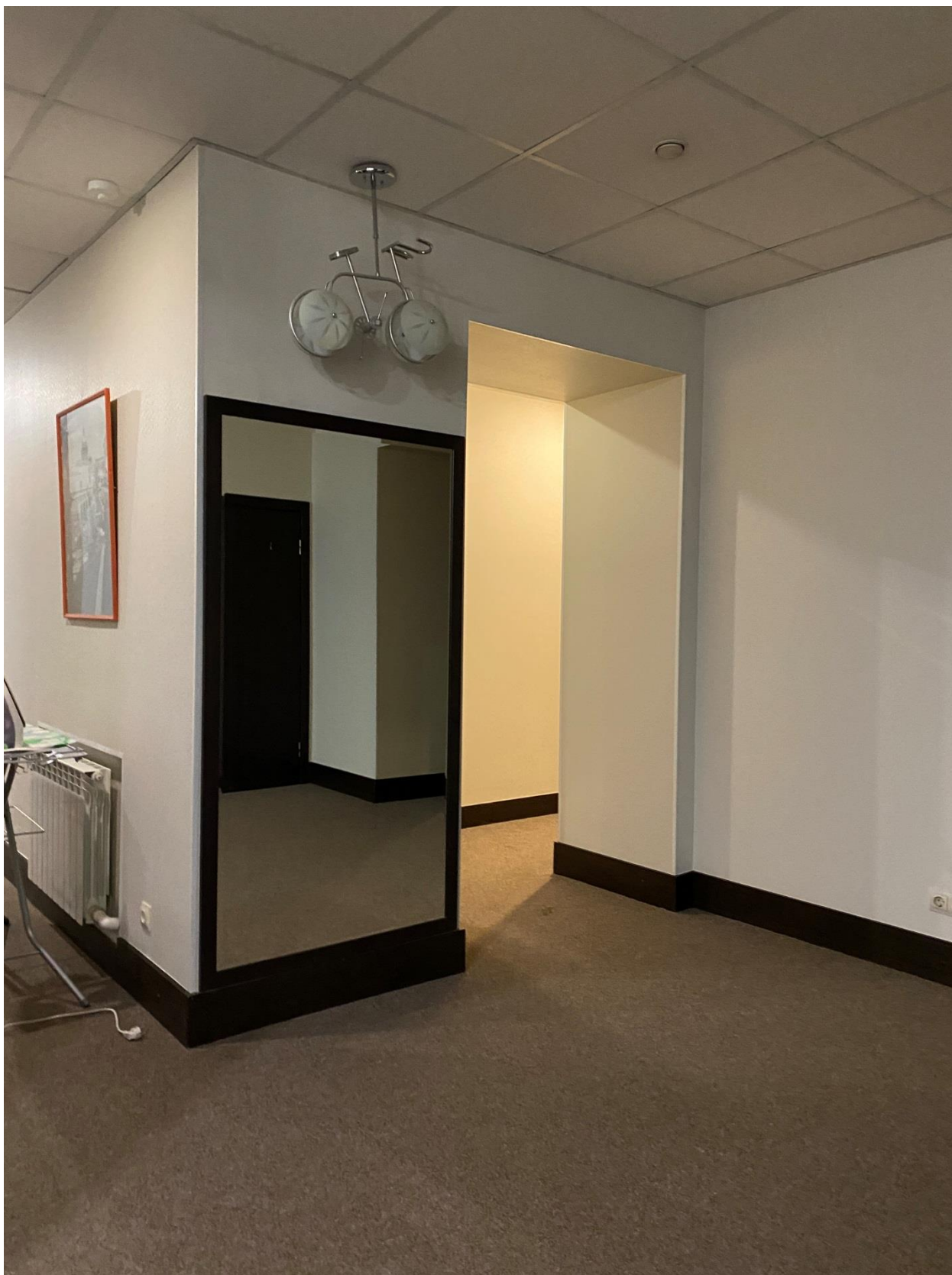
Фото 18. Вид на помещение квартиры № 10 объекта культурного наследия.
