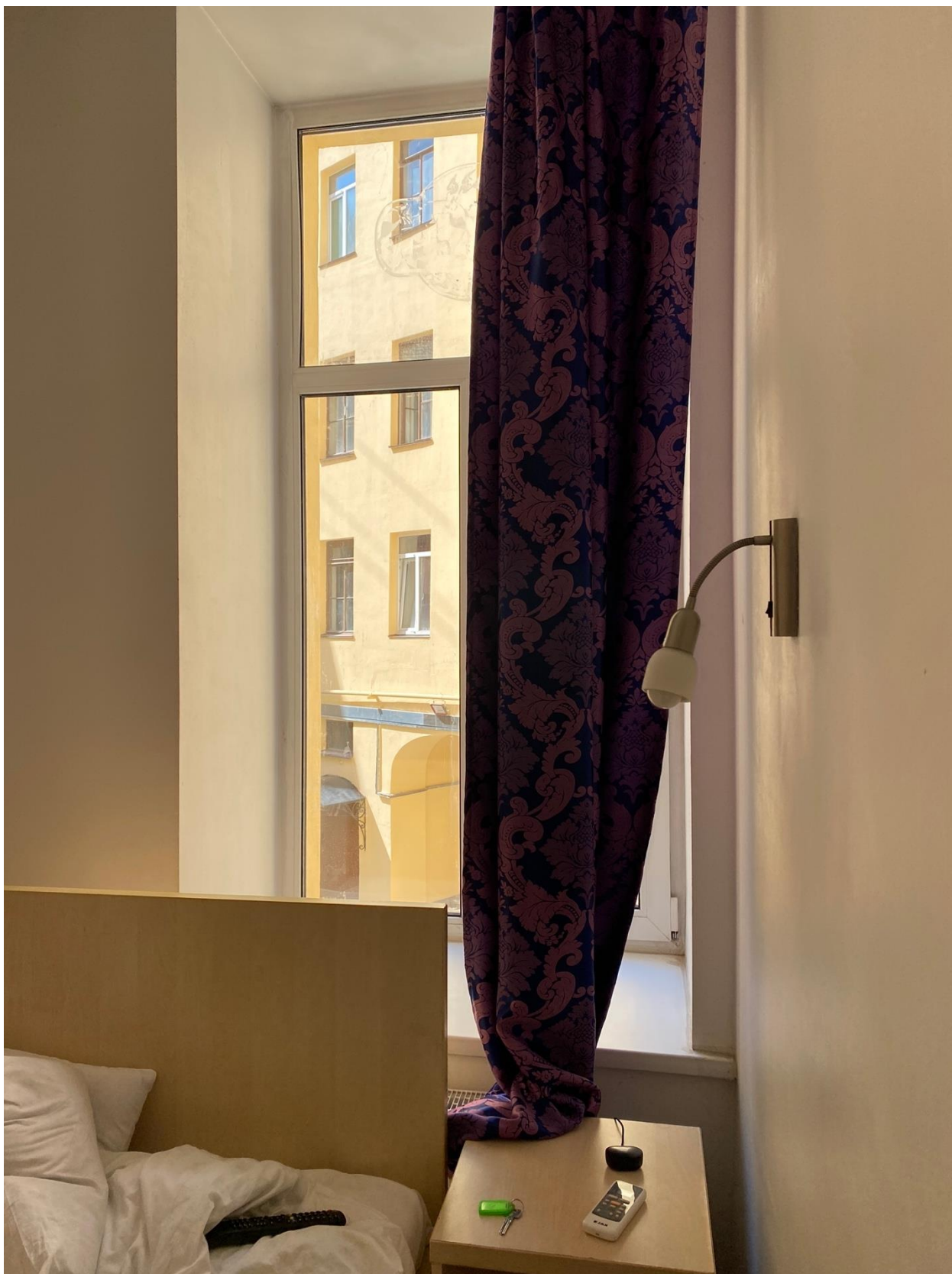
Фото 34. Вид на оконное заполнение в части квартиры № 8 объекта культурного наследия.
