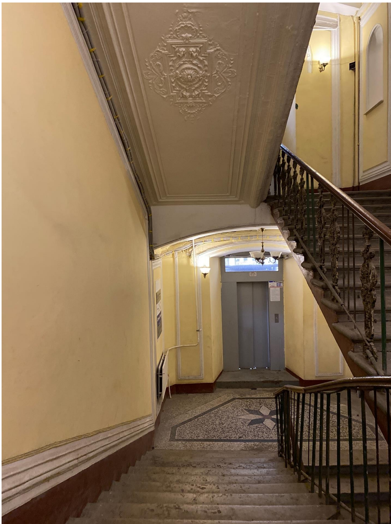
Фото 13. Вид на парадную лестницу объекта культурного наследия.
