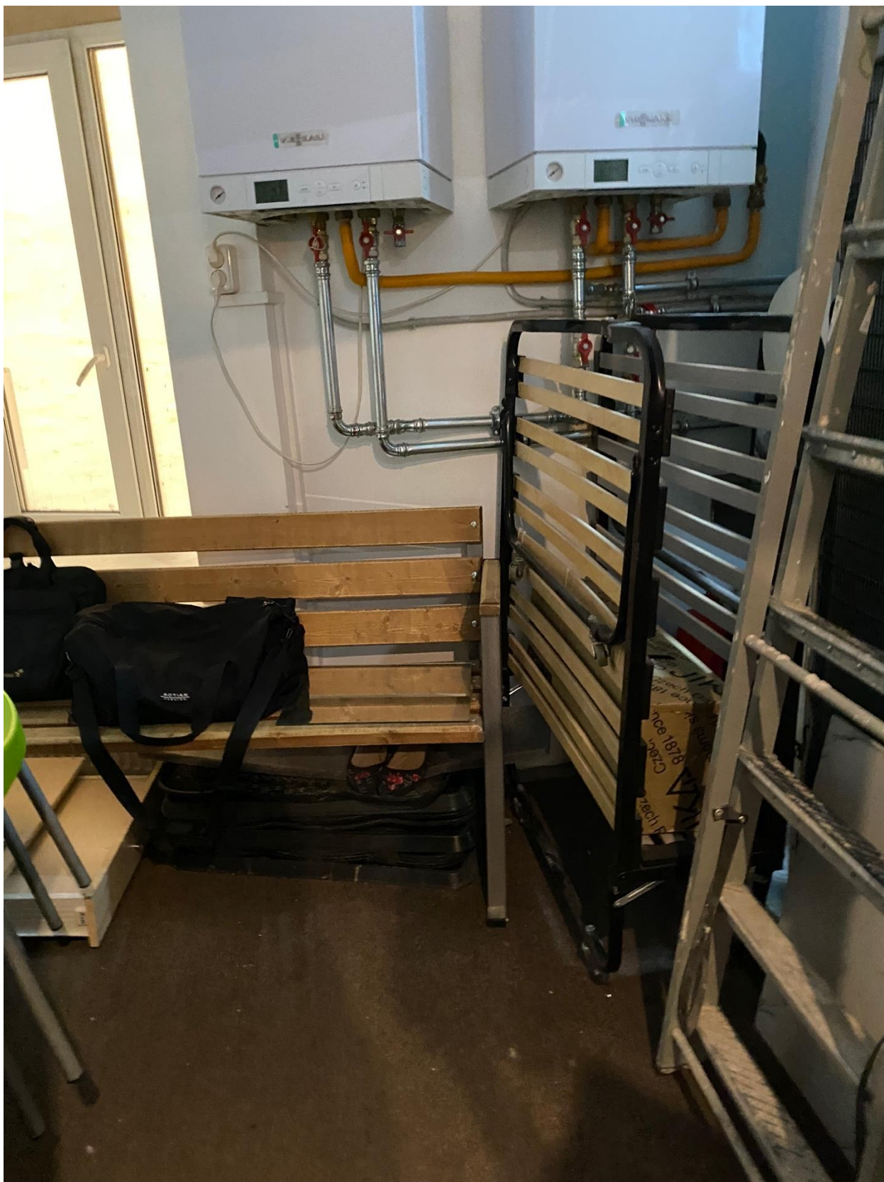
Фото 27. Вид на помещение квартиры № 8 объекта культурного наследия.
