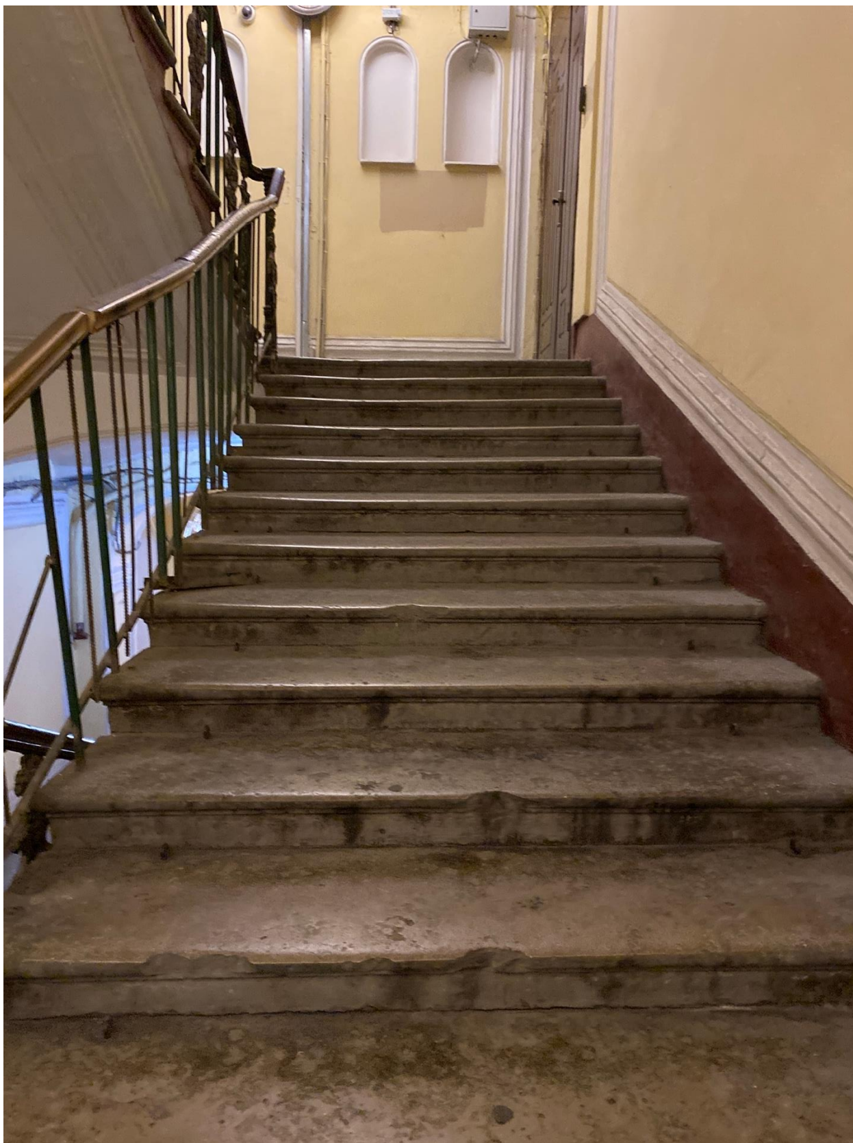
Фото 12. Вид на парадную лестницу объекта культурного наследия.
