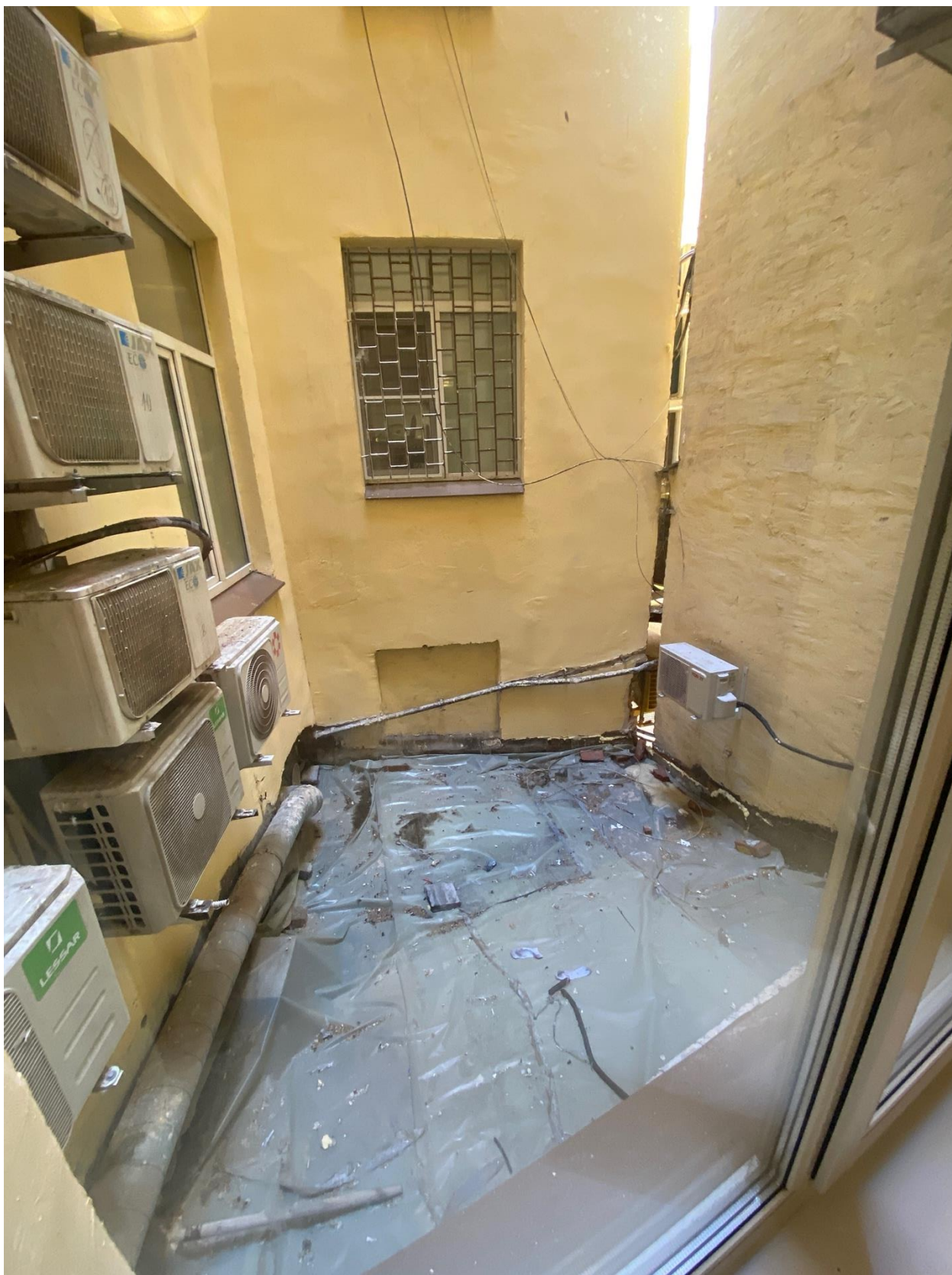
Фото 69. Вид из помещения квартиры № 8 объекта культурного наследия.
