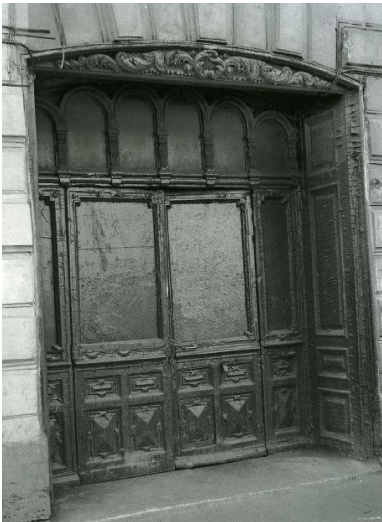
34. Утраченная дверь главного входа. Автор: С.А.Шмидт. [Электронный ресурс]. URL: https://p3.citywalls.ru/photo_83-85931.jpg?mt=1303152597
