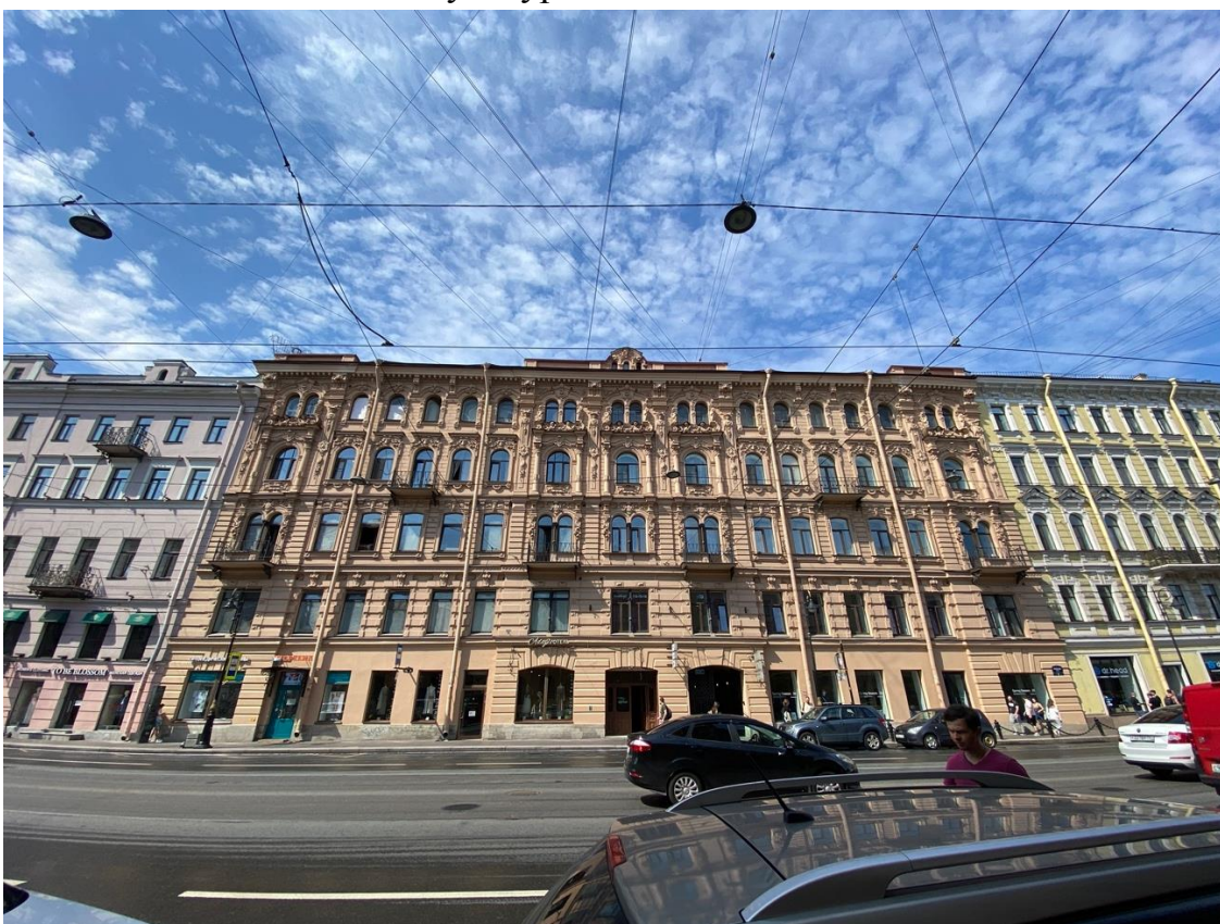
Фото 2. Общий вид лицевого фасада (по Литейному проспекту) объекта культурного наследия.
