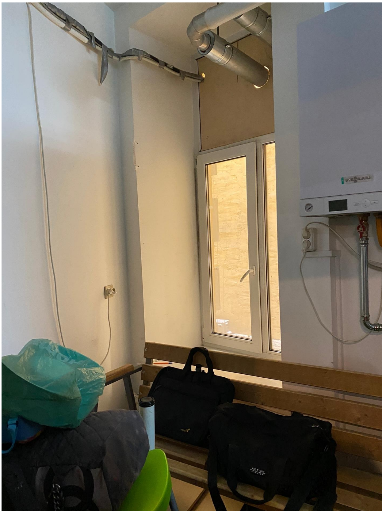
Фото 28. Вид на помещение квартиры № 8 объекта культурного наследия.
