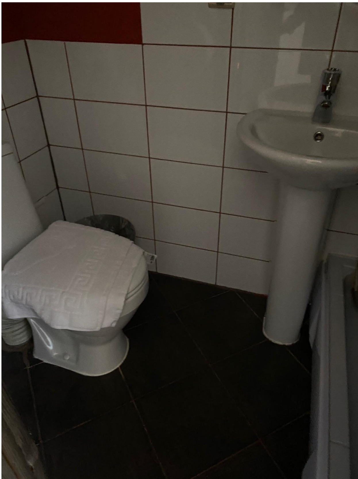
Фото 57. Вид на помещение квартиры № 8 объекта культурного наследия.
