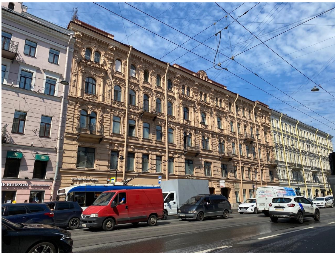
Фото 1. Общий вид лицевого фасада (по Литейному проспекту) объекта культурного наследия.
