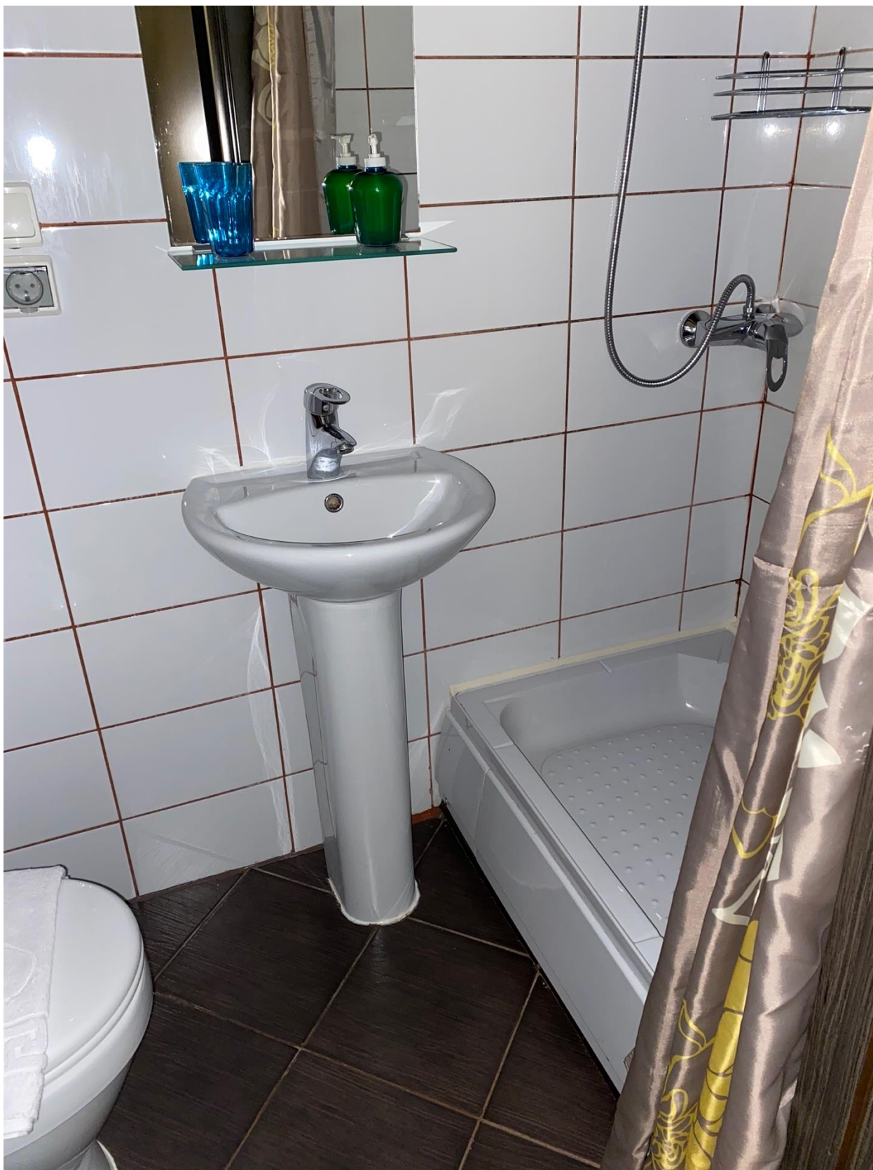
Фото 33. Вид на помещение квартиры № 8 объекта культурного наследия.
