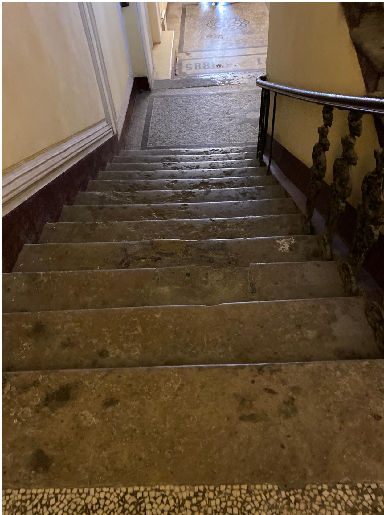
Фото 11. Вид на парадную лестницу объекта культурного наследия.
