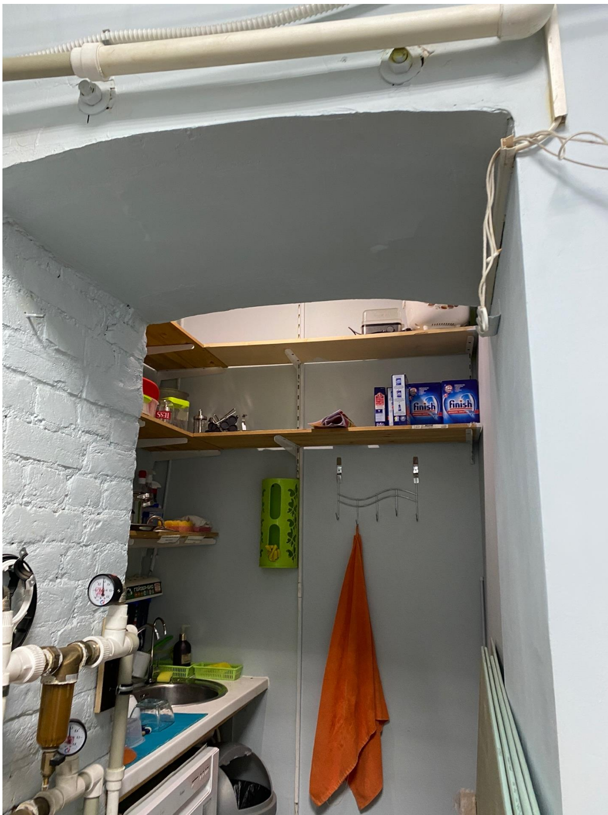
Фото 24. Вид на помещение квартиры № 8 объекта культурного наследия.
