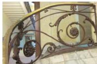
парадная лестница Л-1 – конфигурация, местоположение, габариты, тип (двухмаршевая), конструкция (по косярам), материал ступеней (известняк); лестничное ограждение – материал (черный металл), рисунок (вертикальные стойки с перехватами); поручни – материал (дерево), профиль;
