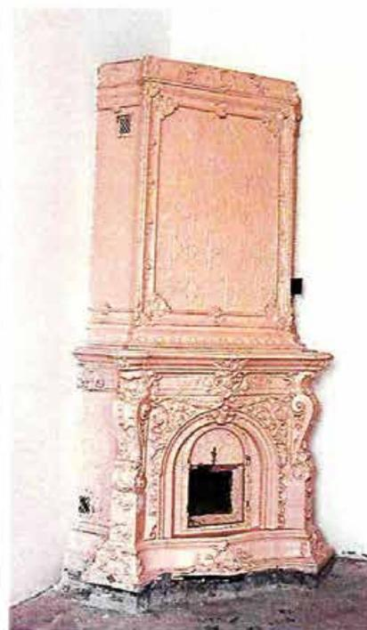
Сохранность: Многослойно окрашена. Топочное отверстие деформировано, дверцы утрачены. Поверхностные загрязнения, мелкие сколы и трещины.
