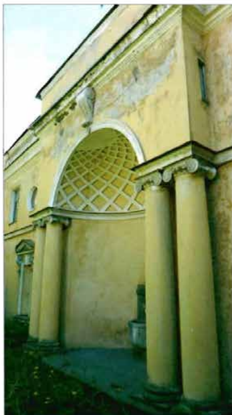
4. «Садовый флигель». Северный фасад. Фрагмент.
