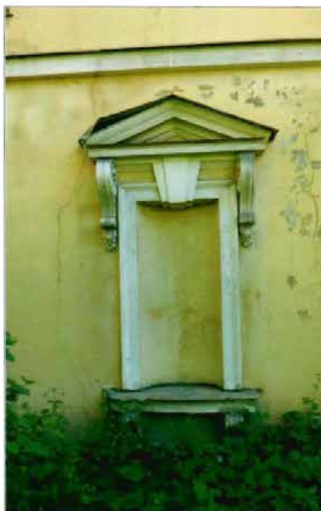
6. «Садовый флигель». Северный фасад. Фрагмент.
