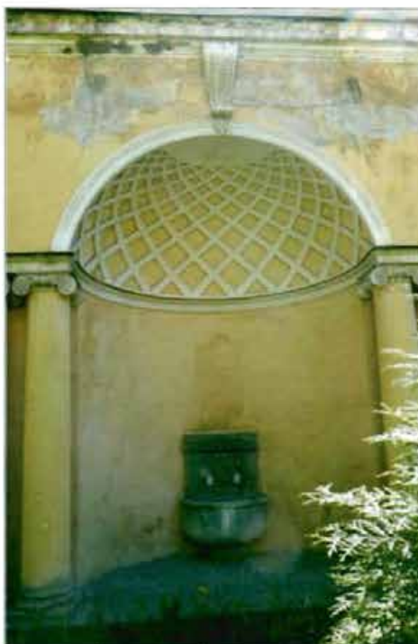
5. «Садовый флигель». Северный фасад. Фрагмент.
