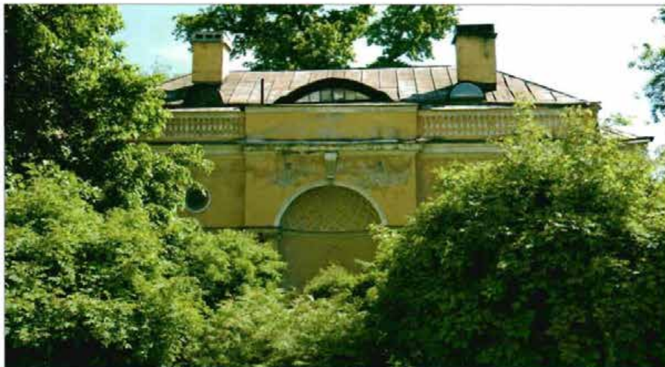
3. «Садовый флигель». Общий вид с севера.
