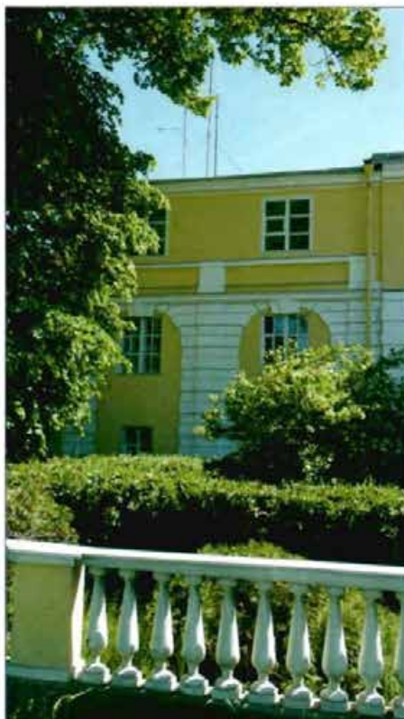
7. «Лицевой флигель» (Песочная наб., 24/2, литера И). Северный фасад.
