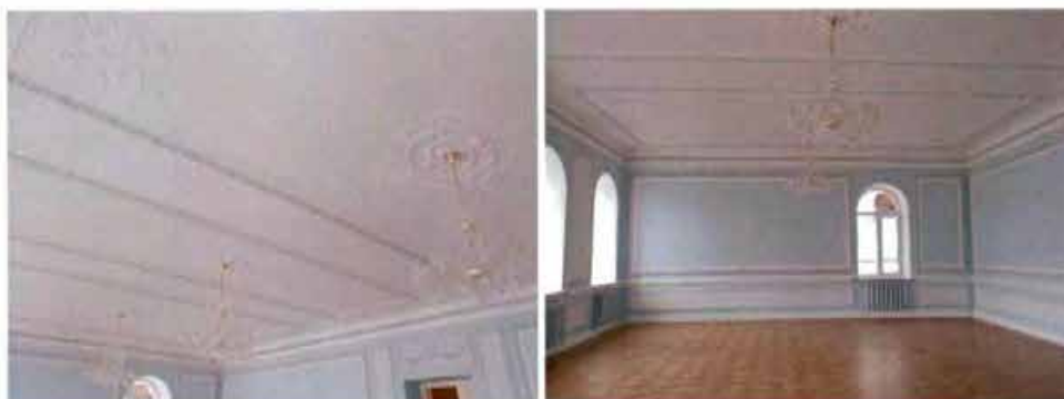
26, 27. Помещения 2-го этажа
