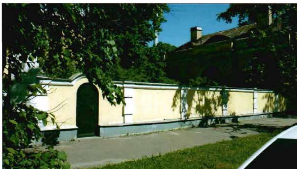
12. «Сад с каменной оградой». Каменная ограда. Вид с северо-запада.
