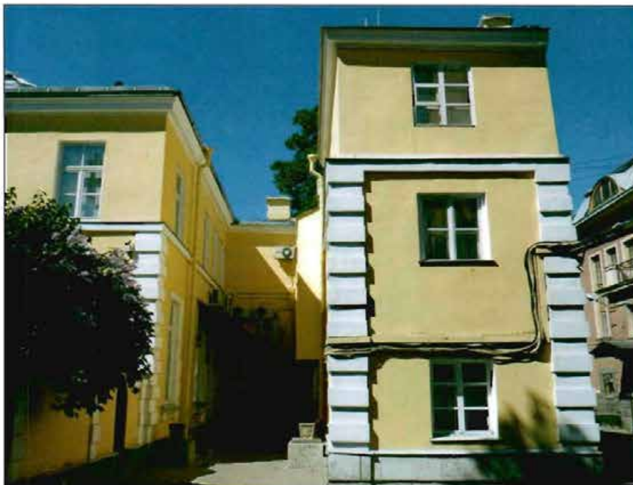
9. «Лицевой флигель». Общий вид с юга.
