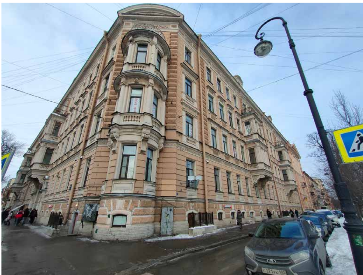
7. Здание по адресу: г. Санкт-Петербург, 4-я линия В.О., д. 5, Лит. А. Вид лицевых фасадов здания со стороны Большого проспекта В.О.
