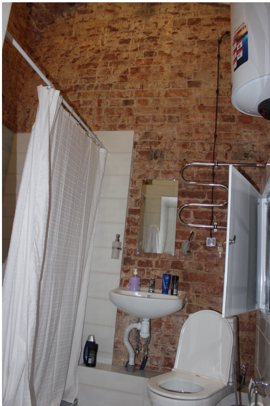
25. Здание по адресу: Санкт-Петербург, 4-я линия ВО, д. 5, Лит. А. Санузел квартиры №10
