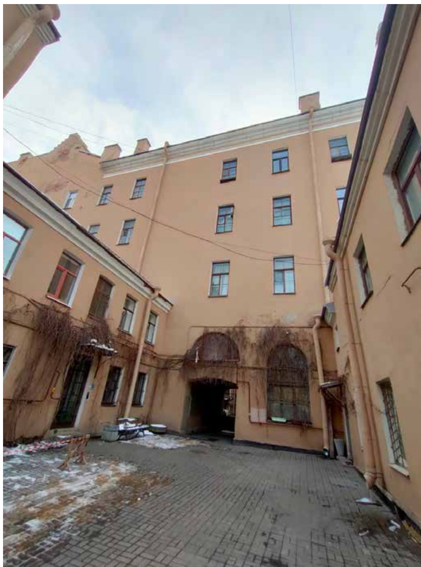
14. Здание по адресу: г. Санкт-Петербург, 4-я линия В.О., д. 5, Лит. А. Вид дворового фасада с арочным проемом, ведущим в северный двор здания.
