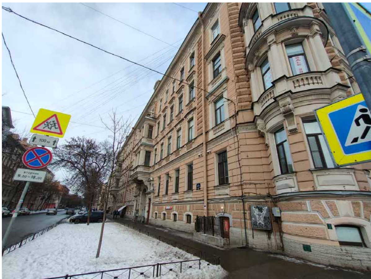
5. Здание по адресу: г. Санкт-Петербург, 4-я линия В.О., д. 5, Лит. А. Вид лицевого фасада здания со стороны 4-й линии В.О.
