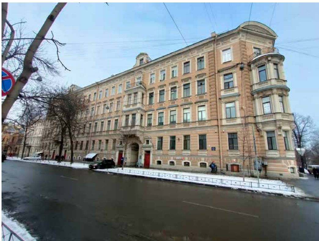
6. Здание по адресу: г. Санкт-Петербург, 4-я линия В.О., д. 5, Лит. А. Вид лицевого фасада здания со стороны 4-й линии В.О.
