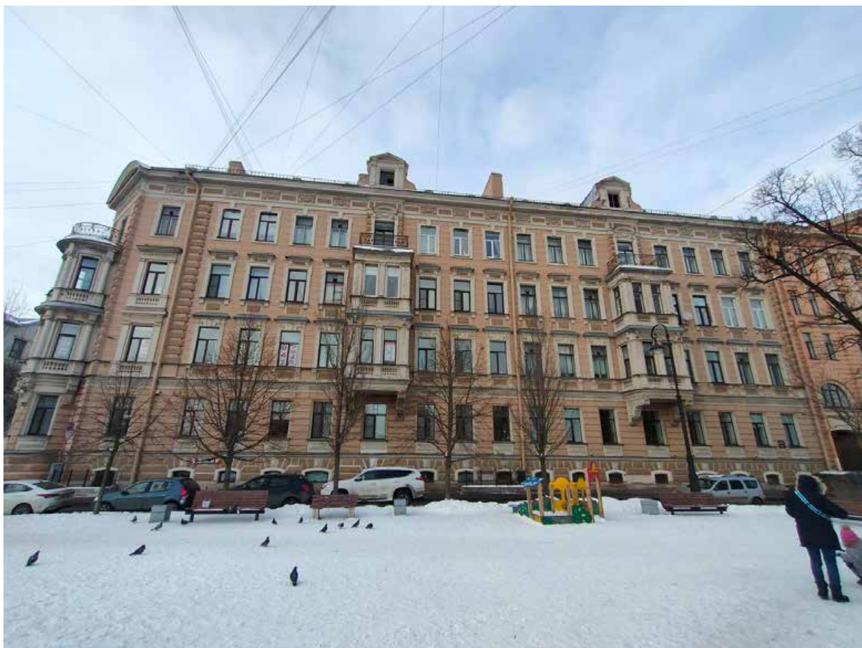
9. Здание по адресу: г. Санкт-Петербург, 4-я линия В.О., д. 5, Лит. А. Вид лицевого фасада здания со стороны Большого проспекта В.О.
