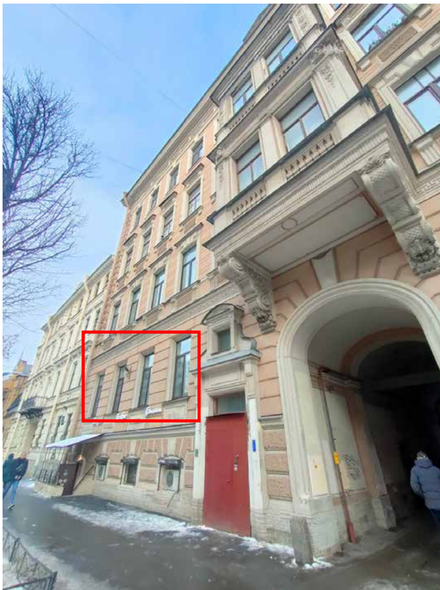
2. Здание по адресу: г. Санкт-Петербург, 4-я линия В.О., д. 5, Лит. А. Вид лицевого фасада здания со стороны 4-й линии В.О.
