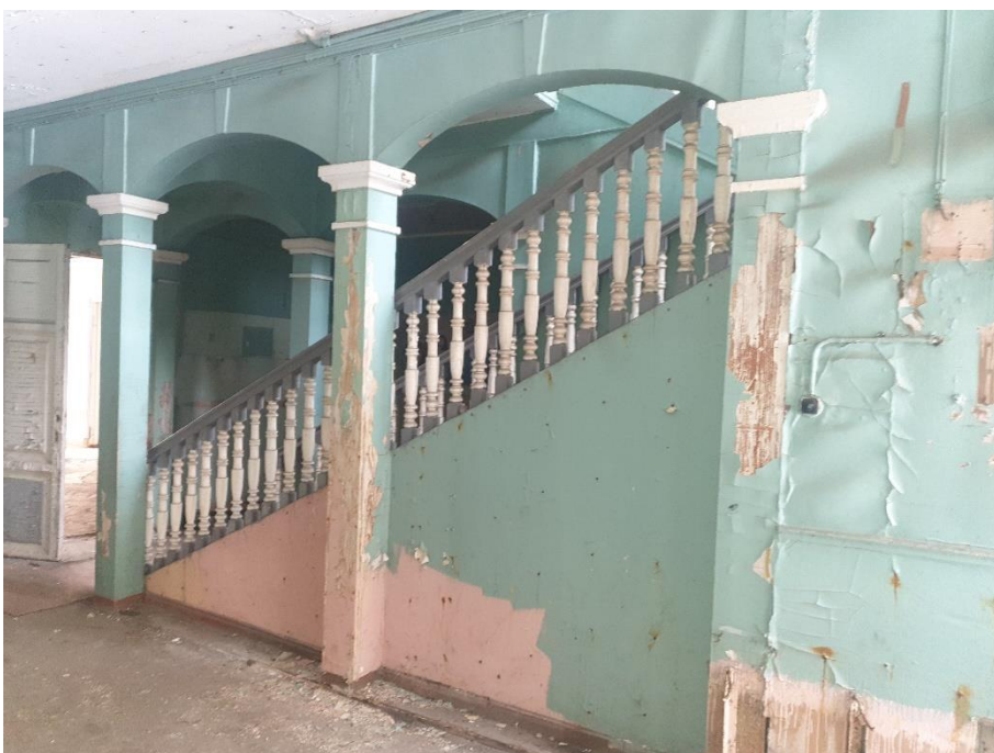
17. «Финская усадьба Заеца», Санкт-Петербург, город Зеленогорск, Приморское шоссе, дом 597, литера К. Помещение первого этажа. Общий вид. Фото 27.02.2023г.
