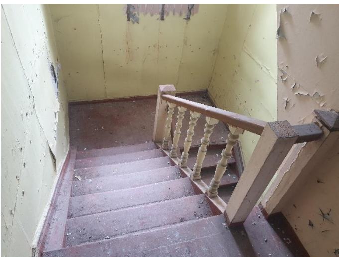
26. «Финская усадьба Заеца», Санкт-Петербург, город Зеленогорск, Приморское шоссе, дом 597, литера К. Помещение второго этажа. Общий вид. Фото 27.02.2023г.
