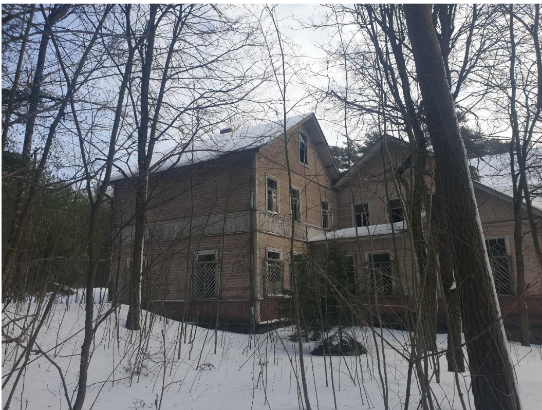
6. «Финская усадьба Заеца», Санкт-Петербург, город Зеленогорск, Приморское шоссе, дом 597, литера К. Западный фасад. Общий вид. Фото 27.02.2023г.
