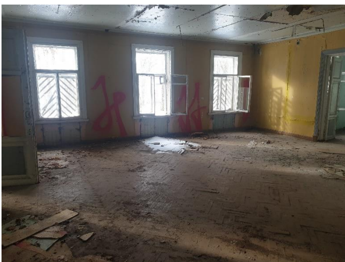
20. «Финская усадьба Заеца», Санкт-Петербург, город Зеленогорск, Приморское шоссе, дом 597, литера К. Помещение первого этажа. Общий вид. Фото 27.02.2023г.
