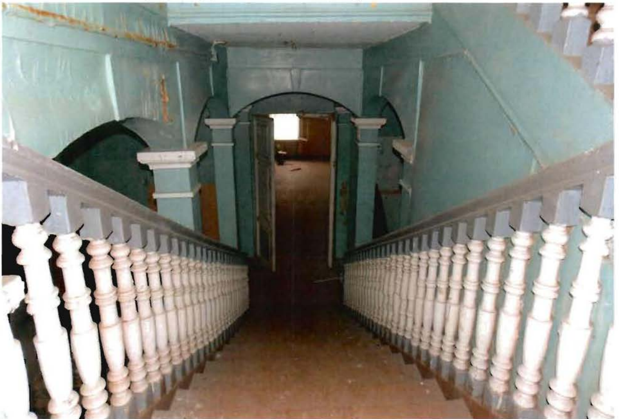
3. Главная парадная деревянная лестница. Фрагмент.
