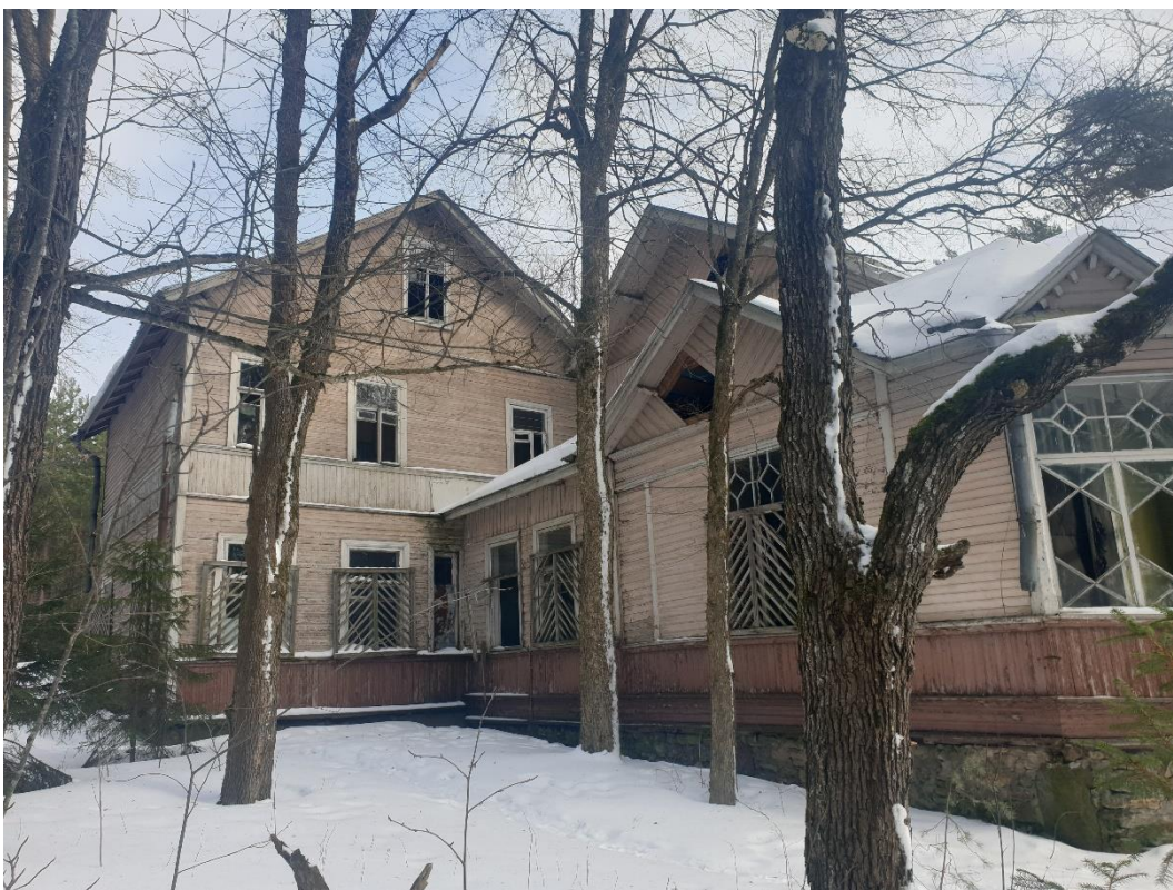
5. «Финская усадьба Заеца», Санкт-Петербург, город Зеленогорск, Приморское шоссе, дом 597, литера К. Западный фасад. Общий вид. Фото 27.02.2023г.
