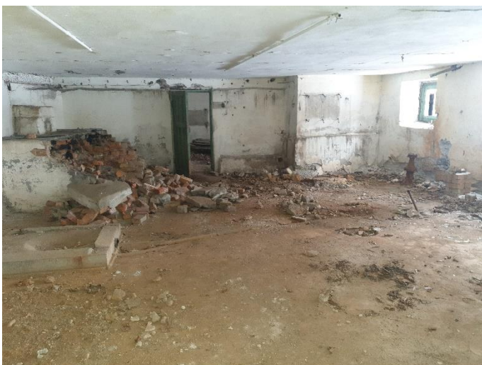
11. «Финская усадьба Заеца», Санкт-Петербург, город Зеленогорск, Приморское шоссе, дом 597, литера К. Подвал. Общий вид. Фото 27.02.2023г.
