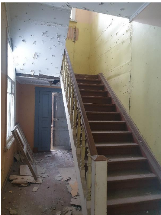
16. «Финская усадьба Заеца», Санкт-Петербург, город Зеленогорск, Приморское шоссе, дом 597, литера К. Помещение первого этажа. Общий вид. Фото 27.02.2023г.
