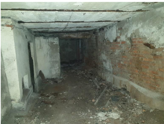
14. «Финская усадьба Заеца», Санкт-Петербург, город Зеленогорск, Приморское шоссе, дом 597, литера К. Подвал. Общий вид. Фото 27.02.2023г.
