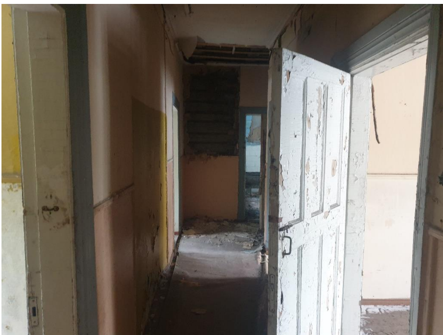
29. «Финская усадьба Заеца», Санкт-Петербург, город Зеленогорск, Приморское шоссе, дом 597, литера К. Помещение второго этажа. Общий вид. Фото 27.02.2023г.
