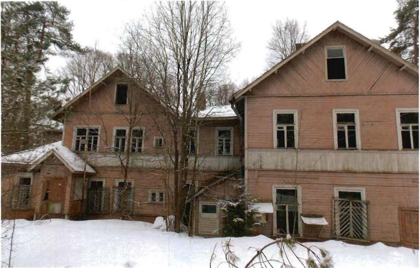
2. Северный фасад здания.
