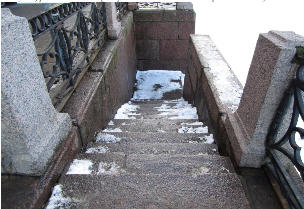
Фото 2. Вид на спуск № 14 (со стороны Синего моста) объекта культурного наследия федерального значения «Набережные со спусками»
