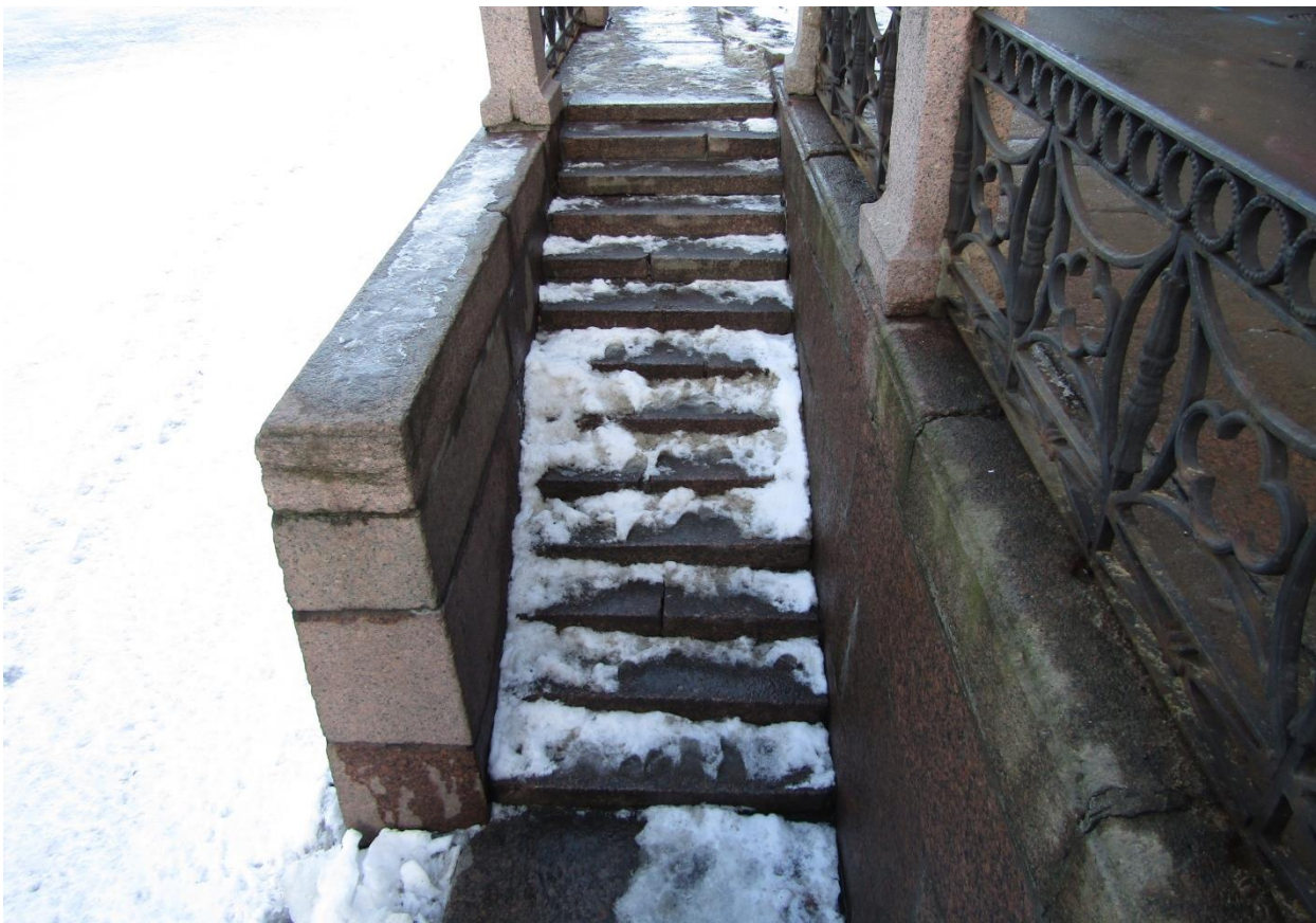
Фото 7. Вид на спуск № 14 (с четной стороны набережной реки Мойки) объекта культурного наследия федерального значения «Набережные со спусками»
