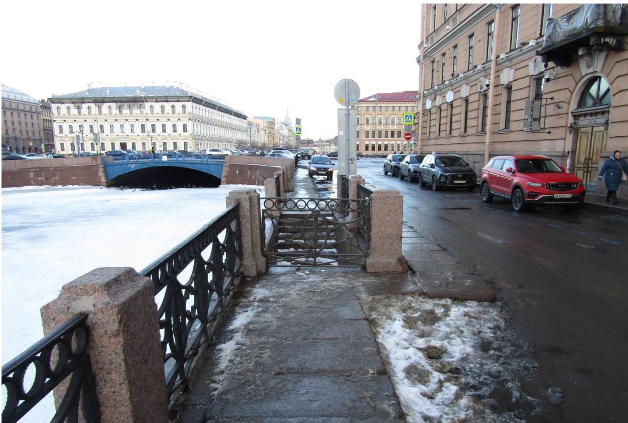
Фото 8. Вид на спуск № 14 (с четной стороны набережной реки Мойки) объекта культурного наследия федерального значения «Набережные со спусками»
