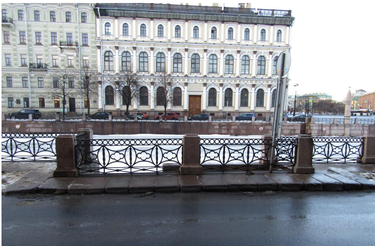
Фото 9. Вид на спуск № 14 (с четной стороны набережной реки Мойки) объекта культурного наследия федерального значения «Набережные со спусками»
