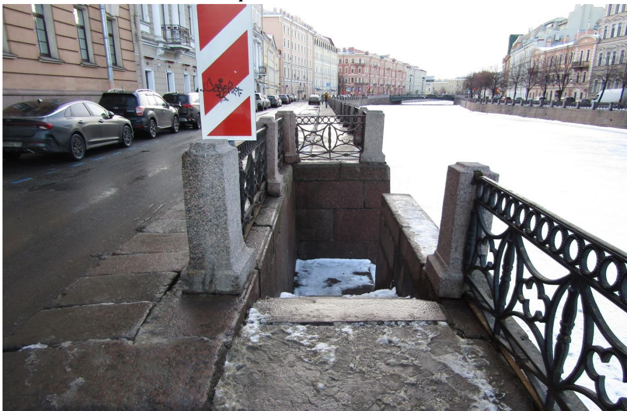
Фото 1. Вид на спуск № 14 (с четной стороны набережной реки Мойки) объекта культурного наследия федерального значения «Набережные со спусками»
