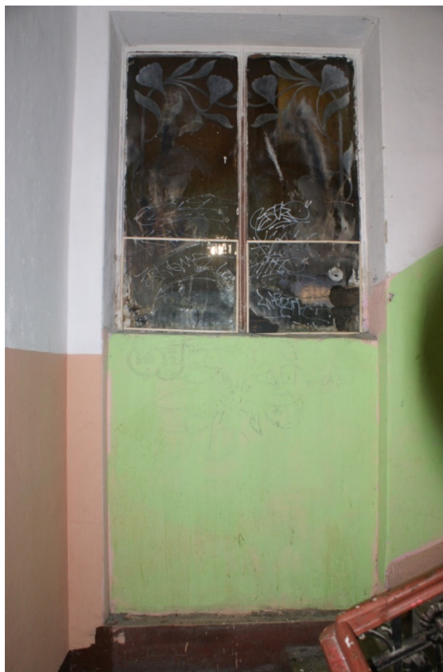
Фото 15. Лестница № 1. Площадка между 2-м и 3-м этажом. Оконное заполнение. Съемка 19.04.2021 г. Кириков Б. М.
