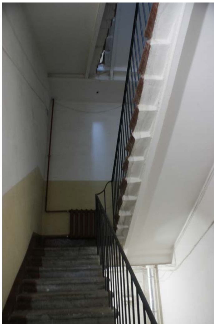
Фото 46. Лестница № 2. Площадка между 3-м и 4-м этажом. Съемка 19.04.2021 г. Кириков Б. М.
