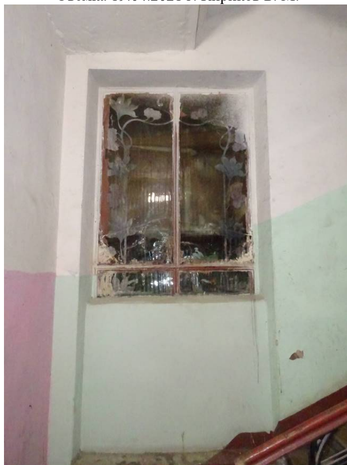
Фото 18. Лестница № 1. Площадка между 3-м и 4-м этажом. Оконное заполнение. Съемка 19.04.2021 г. Кириков Б. М.
