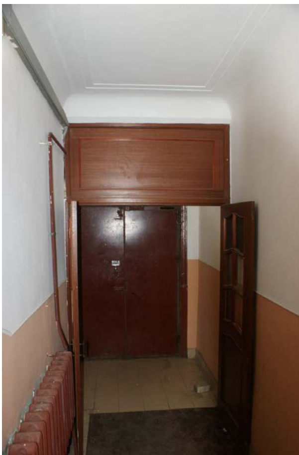
Фото 3. Лестница № 1. 1-й этаж. Вестибюль. Съемка 19.04.2021 г. Кириков Б. М.
