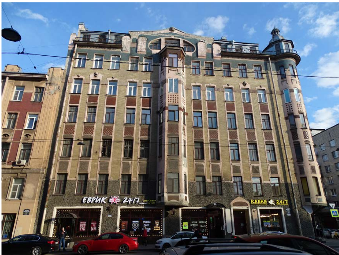
Фото 5. Здание по адресу: г. Санкт-Петербург, Средний пр. В. О., д. 56, литера А. Лицевой фасад по 14-й линии. Съемка 19.04.2021 г. Кириков Б. М.
