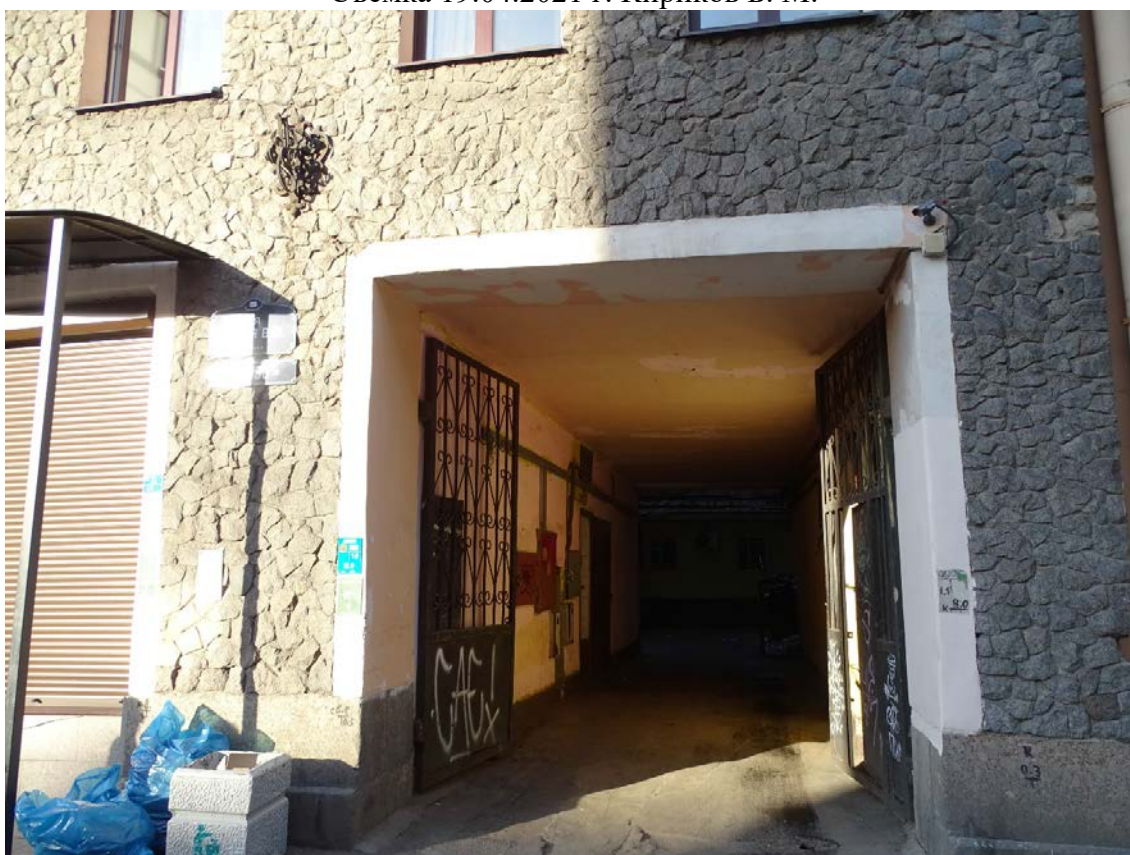
Фото 26. Здание по адресу: г. Санкт-Петербург, Средний пр. В. О., д. 56, литера А. Фрагмент лицевого фасада по Среднему пр. Воротный проезд. Съемка 19.04.2021 г. Кириков Б. М.
