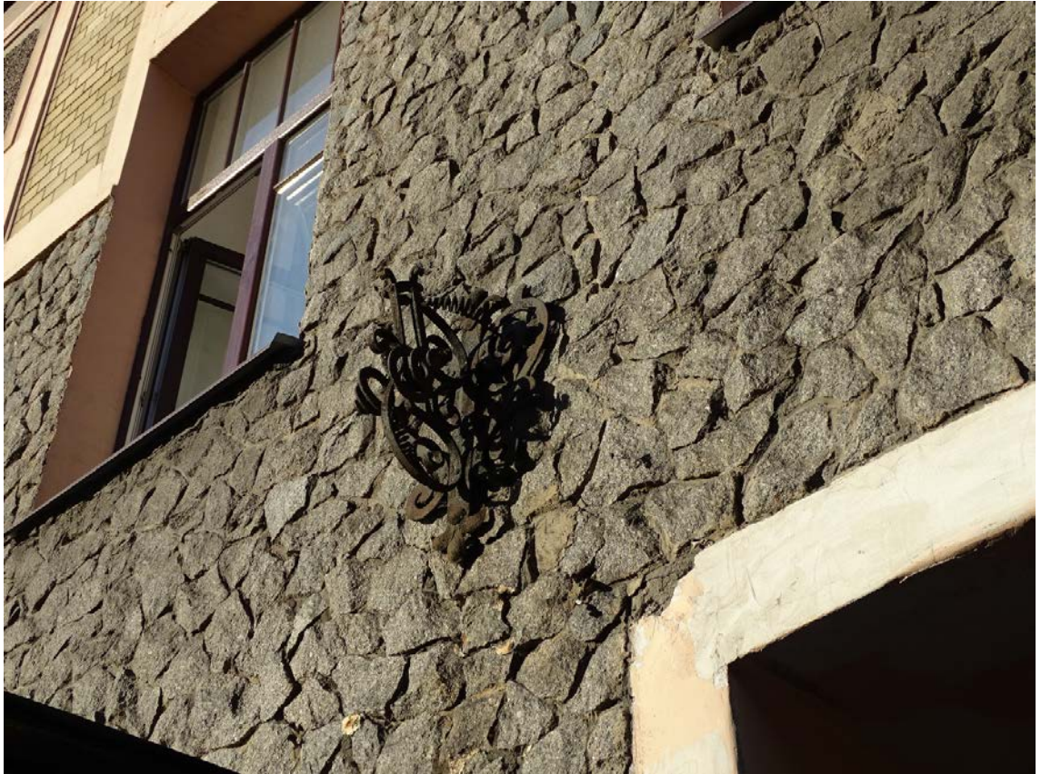
Фото 27. Здание по адресу: г. Санкт-Петербург, Средний пр. В. О., д. 56, литера А. Фрагмент лицевого фасада по Среднему пр. Флагодержатель. Съемка 19.04.2021 г. Кириков Б. М.
