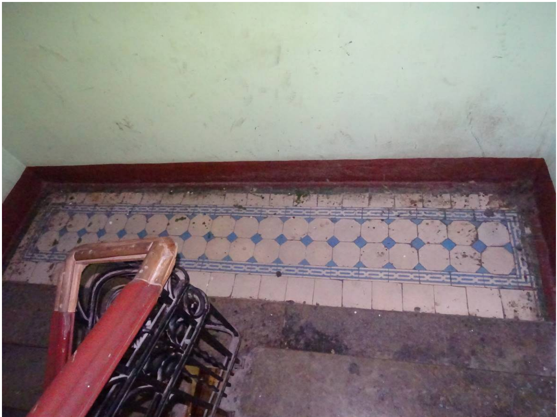
Фото 29. Лестница № 1. Площадка между 6-м и 7-м этажом. Оформление пола. Съемка 19.04.2021 г. Кириков Б. М.
