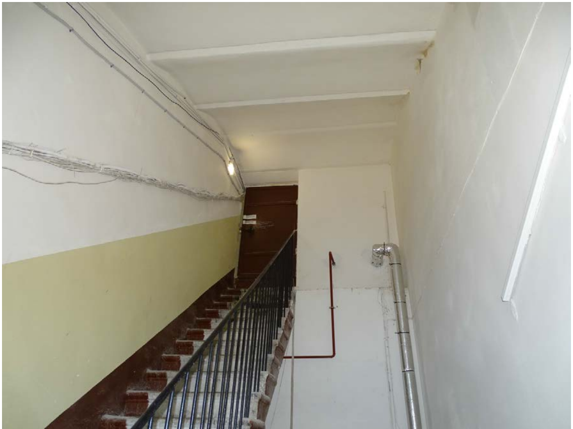
Фото 68. Лестница № 2. 7 этаж. Съёмка 19.04.2021 г. Кириков Б. М.
