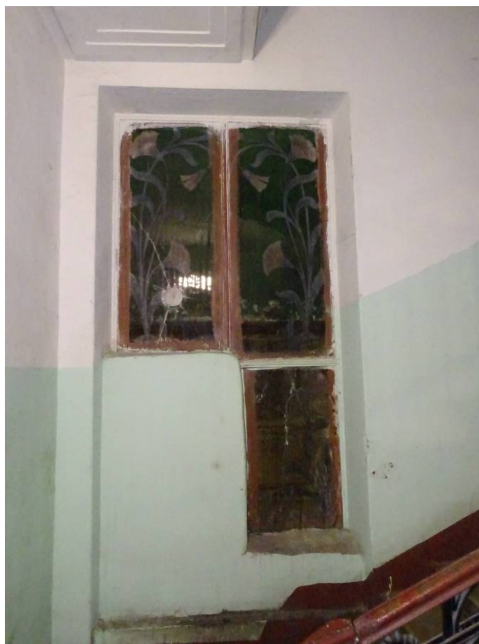
Фото 22. Лестница № 1. Площадка между 4-м и 5-м этажом. Оконное заполнение. Съемка 19.04.2021 г. Кириков Б. М.
