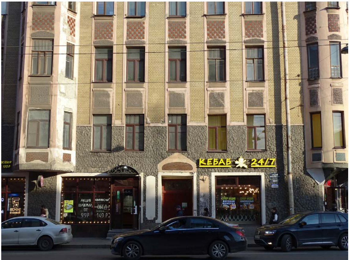
Фото 12. Здание по адресу: г. Санкт-Петербург, Средний пр. В. О., д. 56, литера А. Фрагмент лицевого фасада по 14-й линии. Съемка 19.04.2021 г. Кириков Б. М.
