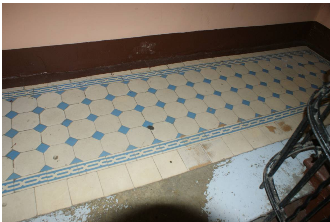
Фото 10. Лестница № 1. Площадка между 1-м и 2-м этажом. Оформление пола. Съемка 19.04.2021 г. Кириков Б. М.
