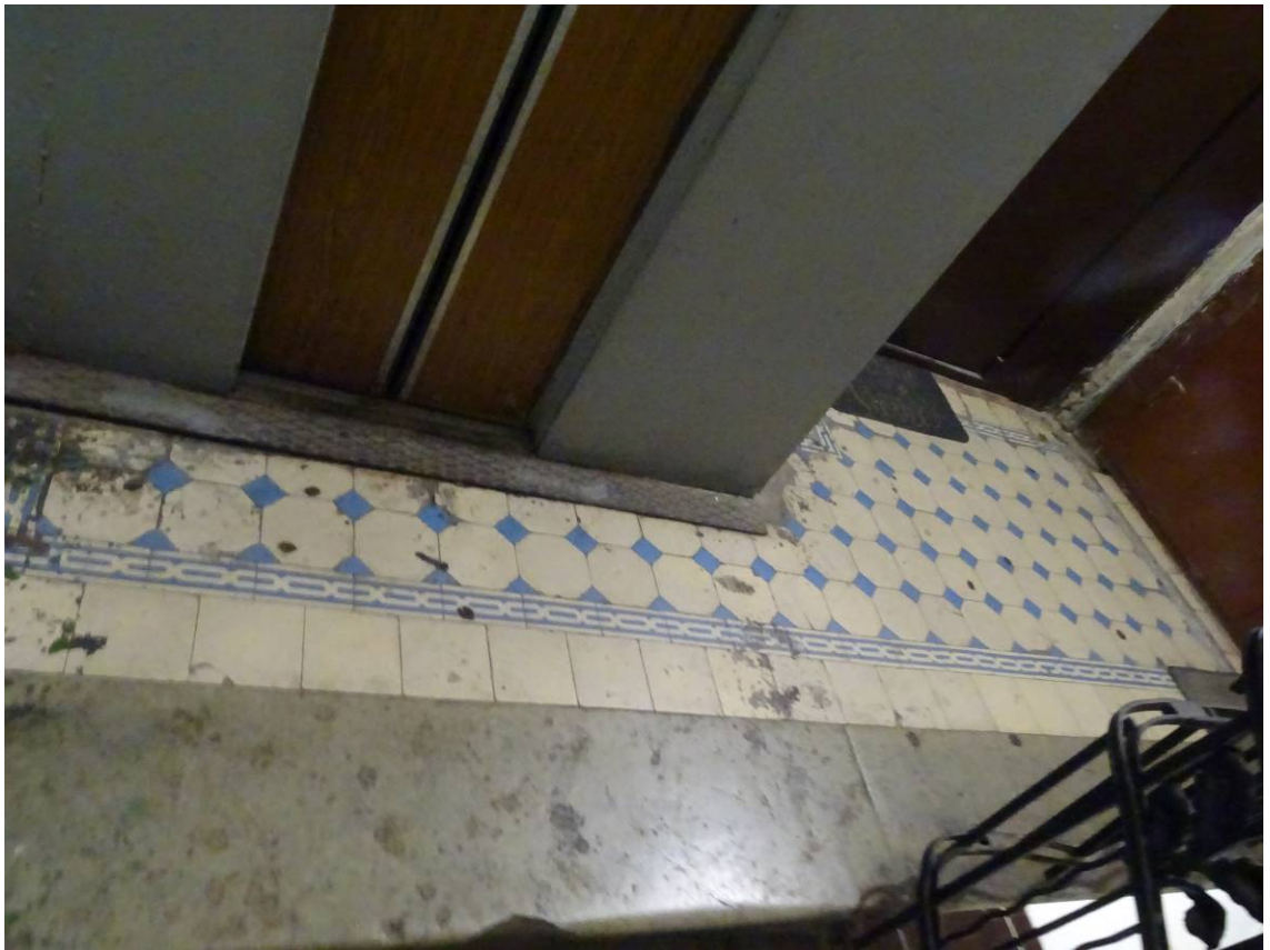
Фото 33. Лестница № 1. 7-й этаж. Оформление пола. Съёмка 19.04.2021 г. Кириков Б. М.
