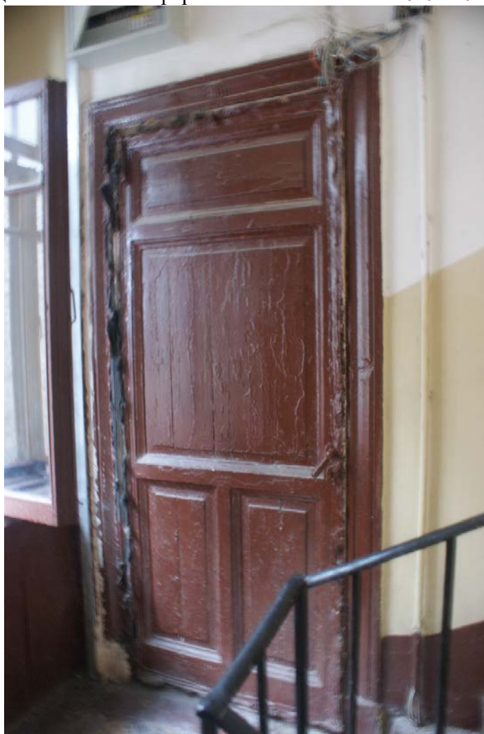
Фото 51. Лестница № 2. 4 этаж. Дверное заполнение. Съемка 19.04.2021 г. Кириков Б. М.
