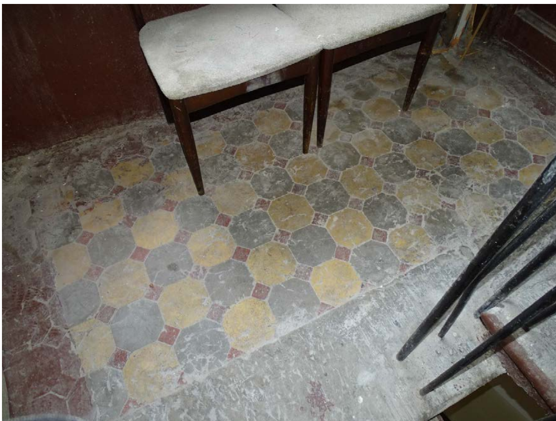
Фото 54. Лестница № 2. 5 этаж. Оформление пола. Съёмка 19.04.2021 г. Кириков Б. М.
