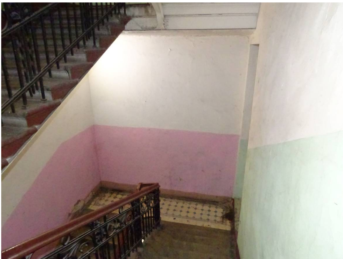
Фото 17. Лестница № 1. Площадка между 3-м и 4-м этажом. Съемка 19.04.2021 г. Кириков Б. М.
