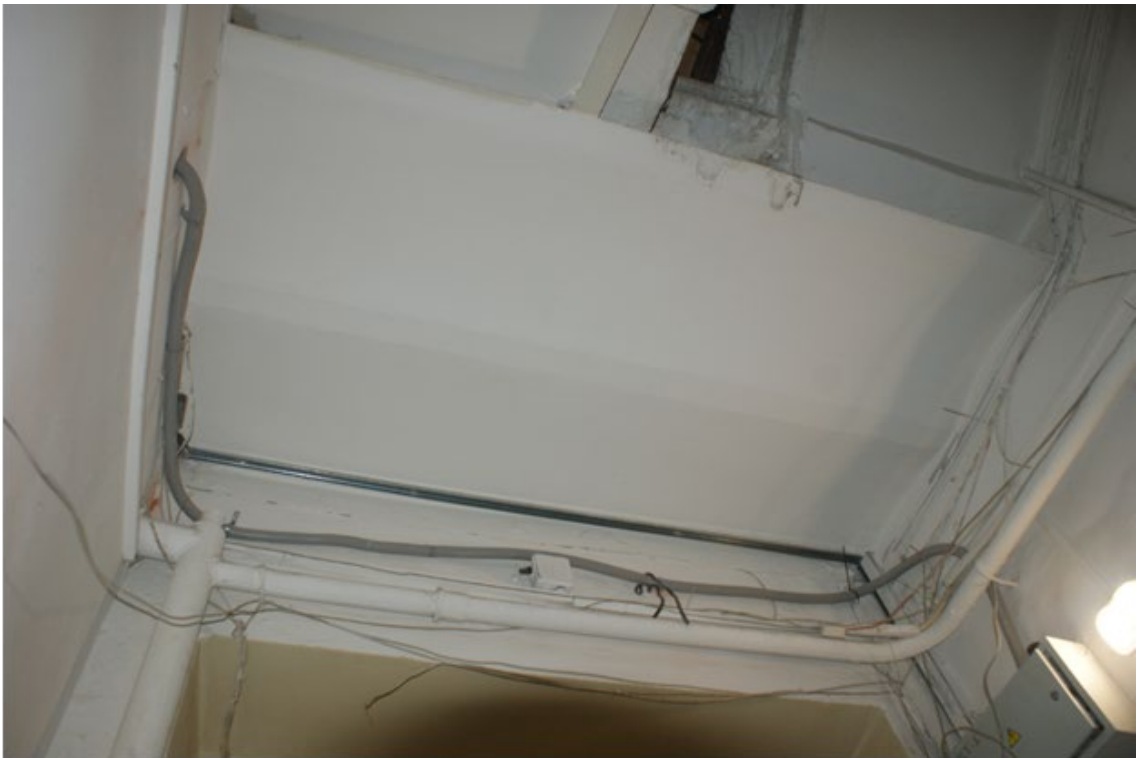
Фото 40. Лестница № 2. 2 этаж. Оформление потолка. Съемка 19.04.2021 г. Кириков Б. М.
