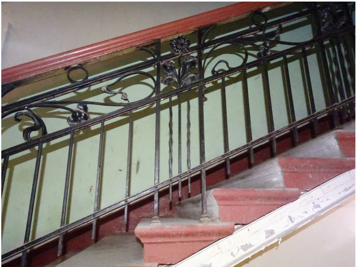
Фото 24. Лестница № 1. Площадка между 5-м и 6-м этажом. Лестничное ограждение. Съёмка 19.04.2021 г. Кириков Б. М.
