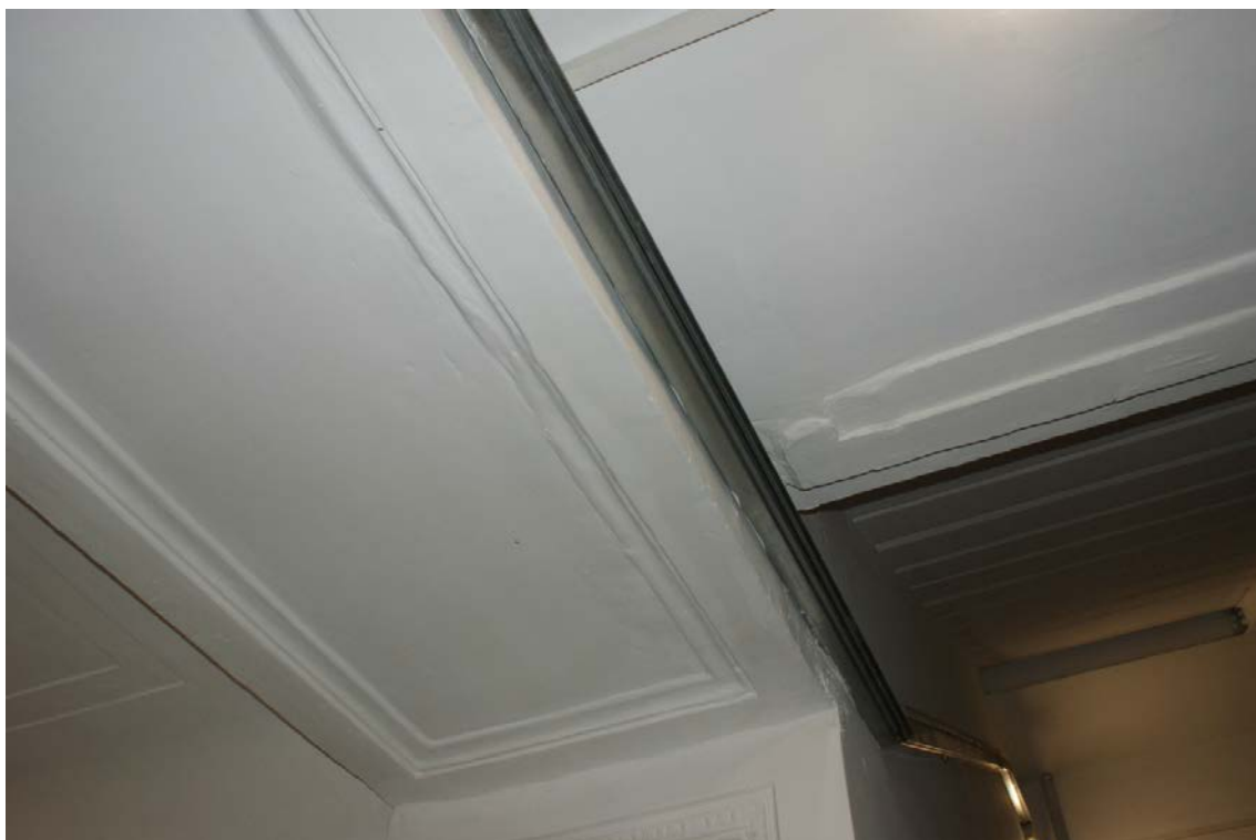
Фото 5. Лестница № 1. 1-й этаж. Вестибюль. Оформление потолка. Съемка 19.04.2021 г. Кириков Б. М.
