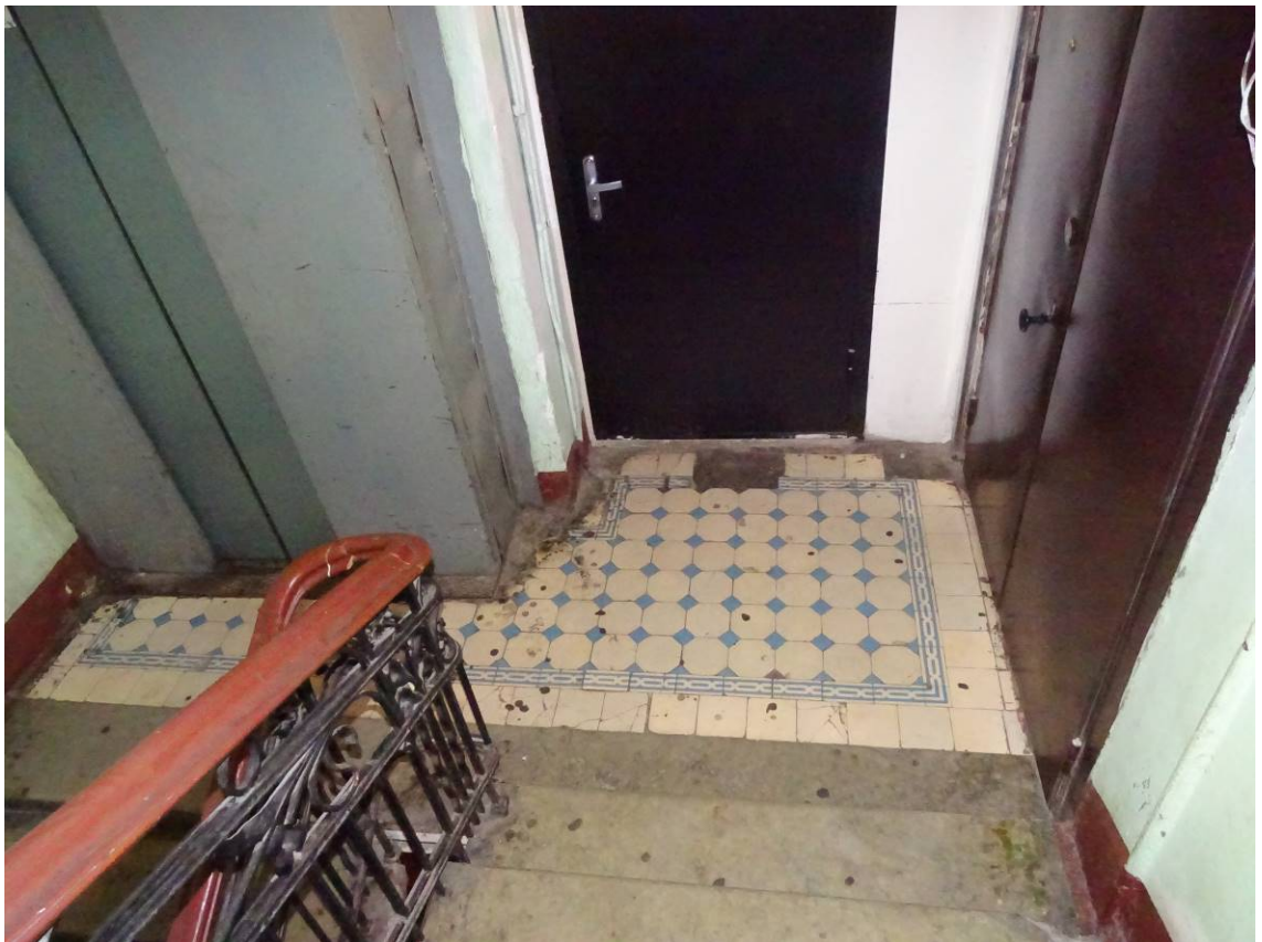
Фото 28. Лестница № 1. 6 этаж. Оформление пола. Съемка 19.04.2021 г. Кириков Б. М.
