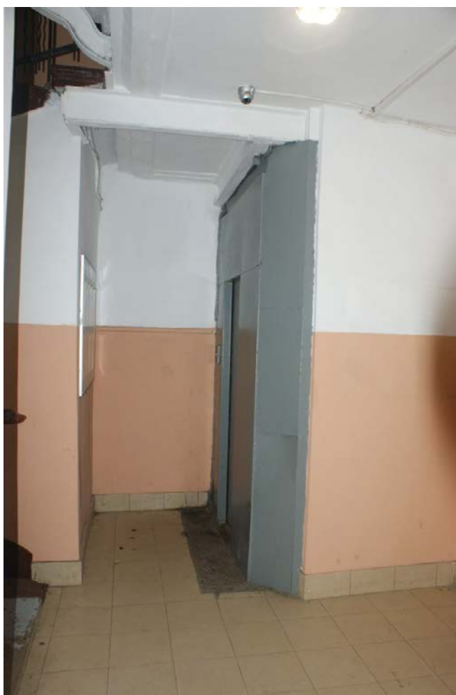
Фото 6. Лестница № 1. 1-й этаж. Съемка 19.04.2021 г. Кириков Б. М.
