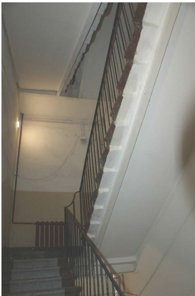
Фото 42. Лестница № 2. Площадка между 2-м и 3-м этажом. Съемка 19.04.2021 г. Кириков Б. М.
