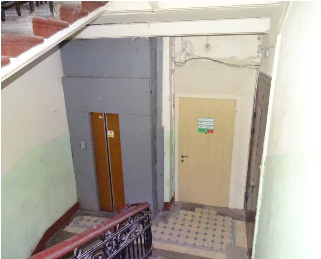
Фото 23. Лестница № 1. 5-й этаж. Съёмка 19.04.2021 г. Кириков Б. М.
