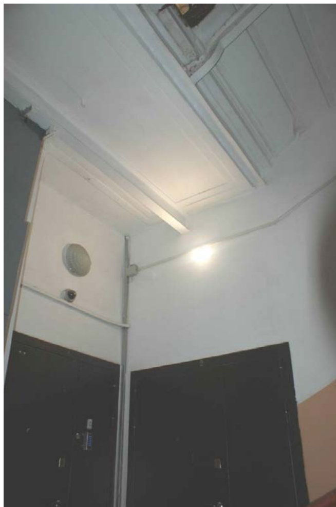
Фото 12. Лестница № 1. Площадка 2-го этажа. Съемка 19.04.2021 г. Кириков Б. М.
