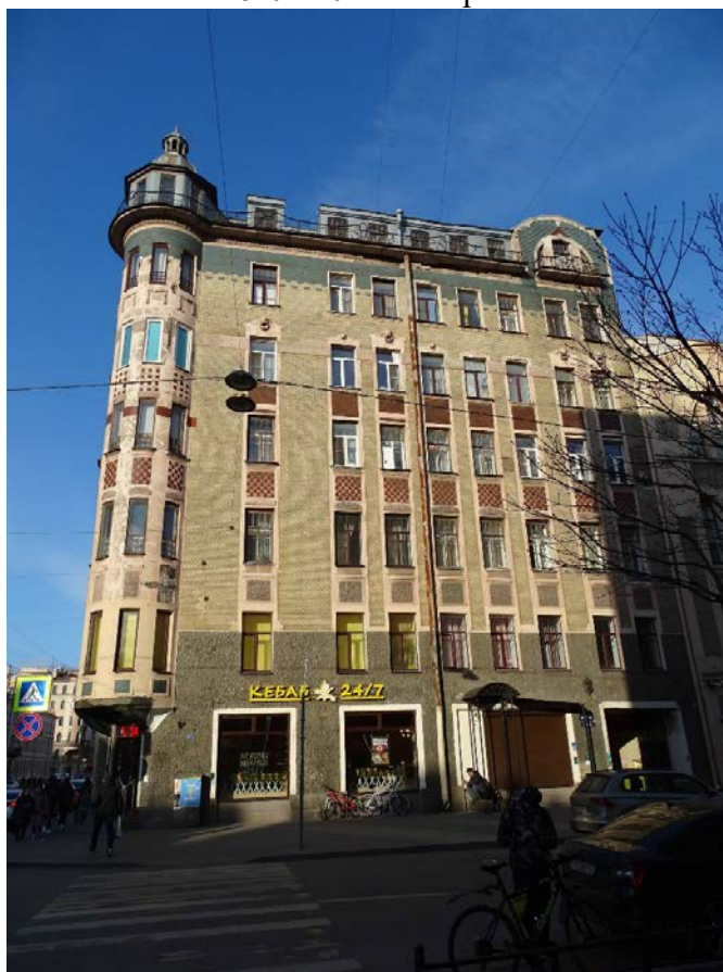
Фото 18. Здание по адресу: г. Санкт-Петербург, Средний пр. В. О., д. 56, литера А. Лицевой фасад по Среднему пр. Съемка 19.04.2021 г. Кириков Б. М.
