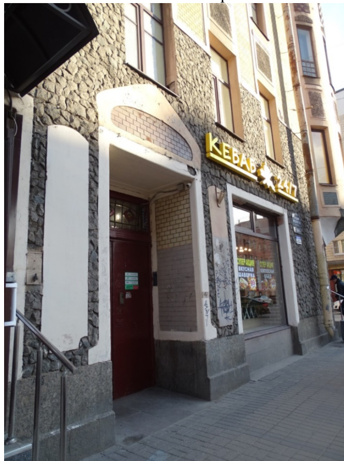
Фото 14. Здание по адресу: г. Санкт-Петербург, Средний пр. В. О., д. 56, литера А. Фрагмент лицевого фасада по 14-й линии. Съемка 19.04.2021 г. Кириков Б. М.
