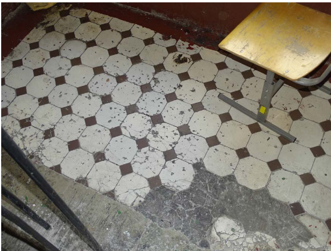
Фото 62. Лестница № 2. 6 этаж. Оформление пола. Съемка 19.04.2021 г. Кириков Б. М.
