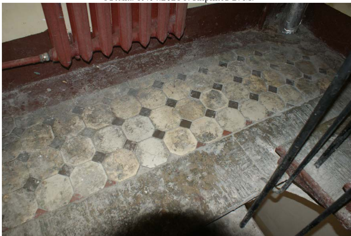
Фото 47. Лестница № 2. Площадка между 3-м и 4-м этажом. Оформление пола. Съемка 19.04.2021 г. Кириков Б. М.
