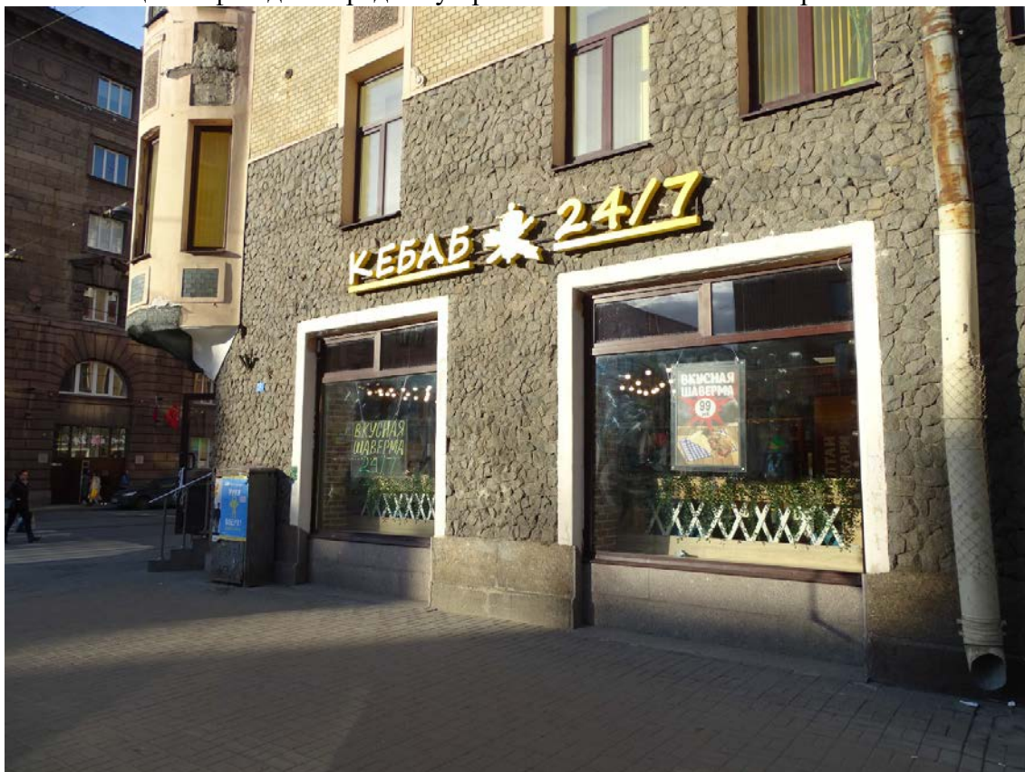
Фото 20. Здание по адресу: г. Санкт-Петербург, Средний пр. В. О., д. 56, литера А. Фрагмент лицевого фасада по Среднему пр. Съемка 19.04.2021 г. Кириков Б. М.
