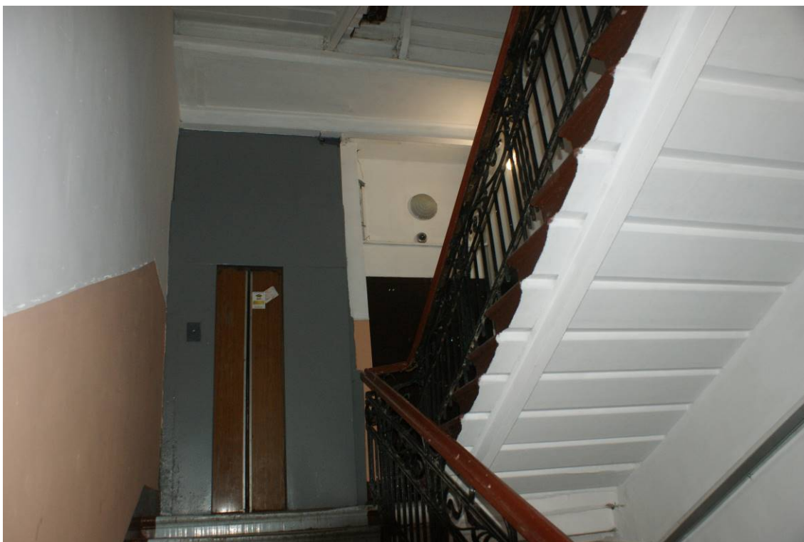
Фото 11. Лестница № 1. Площадка 2-го этажа. Съемка 19.04.2021 г. Кириков Б. М.
