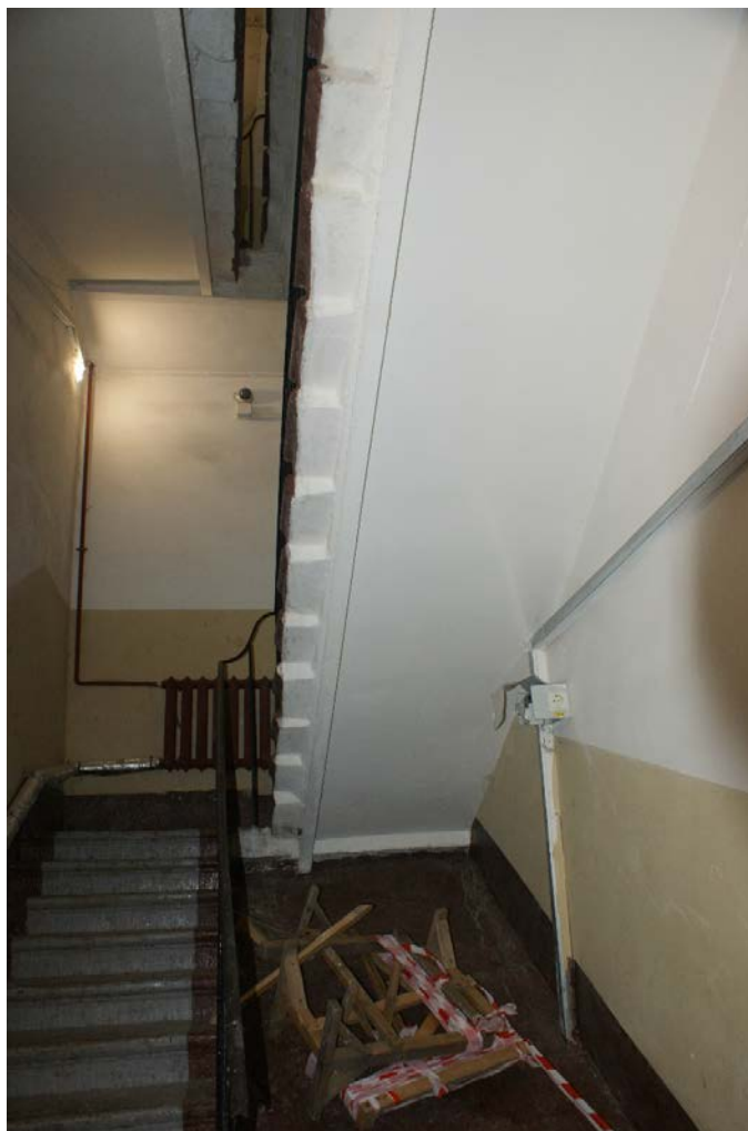
Фото 34. Лестница № 2. 1-й этаж. Вестибюль. Съемка 19.04.2021 г. Кириков Б. М.
