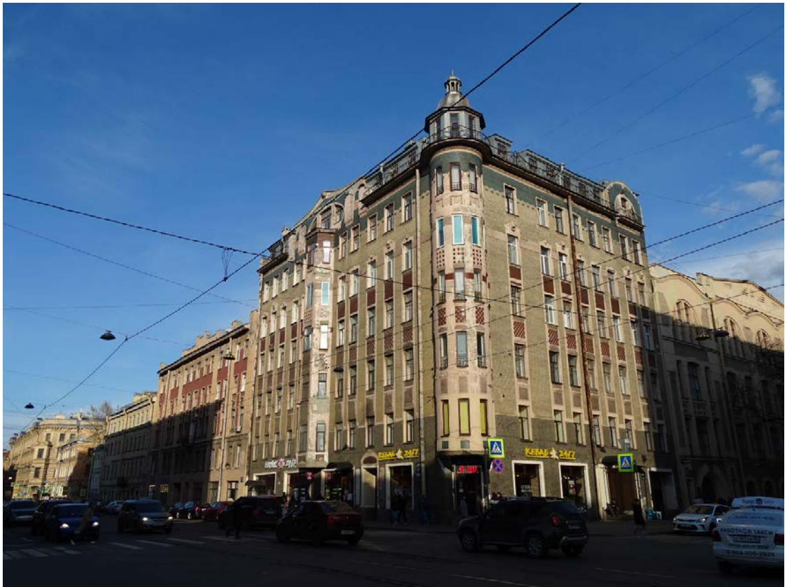
Фото 1. Здание по адресу: г. Санкт-Петербург, Средний пр. В. О., д. 56, литера А. Вид с пересечения 14-й линии и Среднего пр. Съемка 19.04.2021 г. Кириков Б. М.
