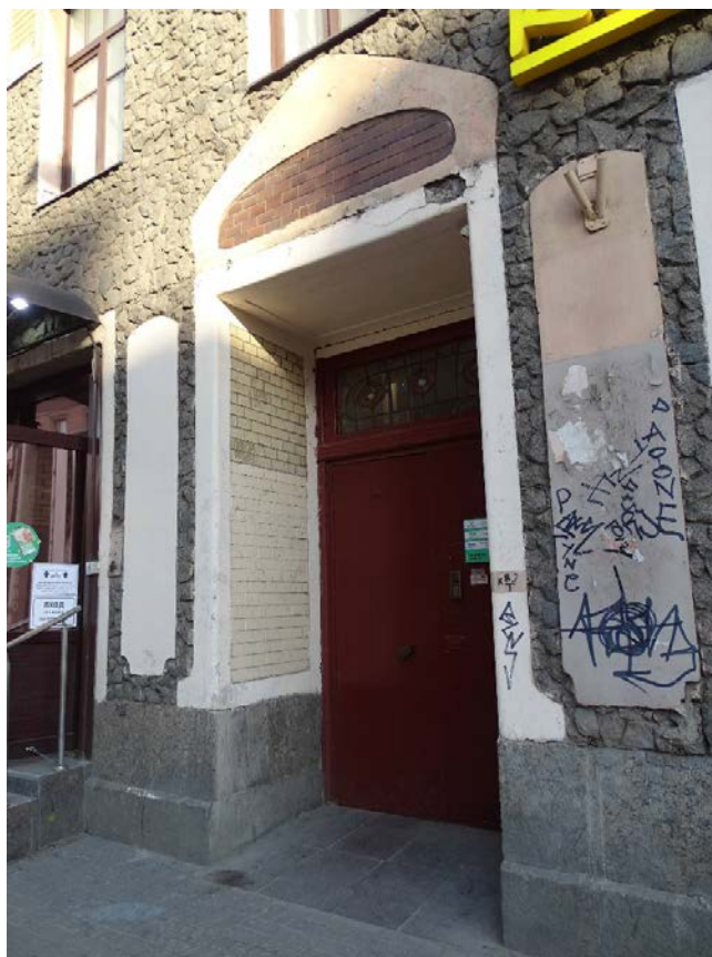
Фото 15. Здание по адресу: г. Санкт-Петербург, Средний пр. В. О., д. 56, литера А. Фрагмент лицевого фасада по 14-й линии. Оформление входного портала. Съемка 19.04.2021 г. Кириков Б. М.
