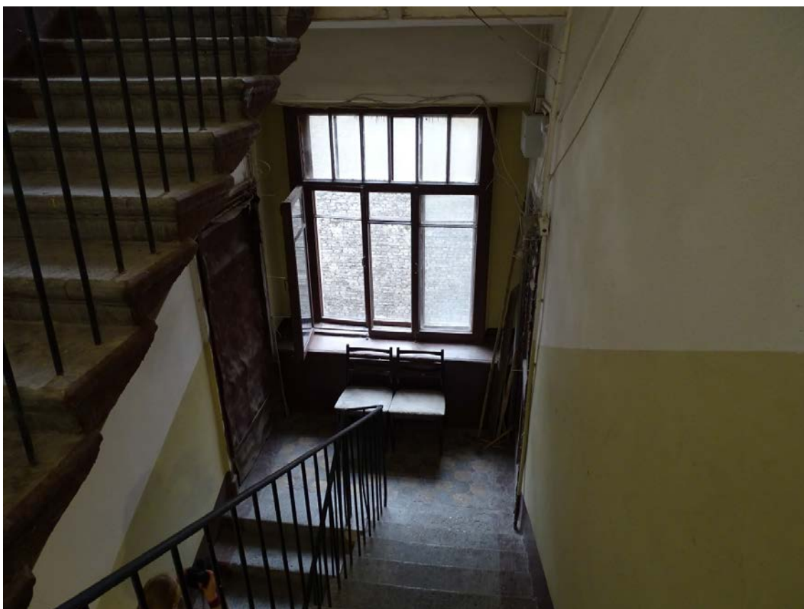
Фото 55. Лестница № 2. 5 этаж. Съёмка 19.04.2021 г. Кириков Б. М.
