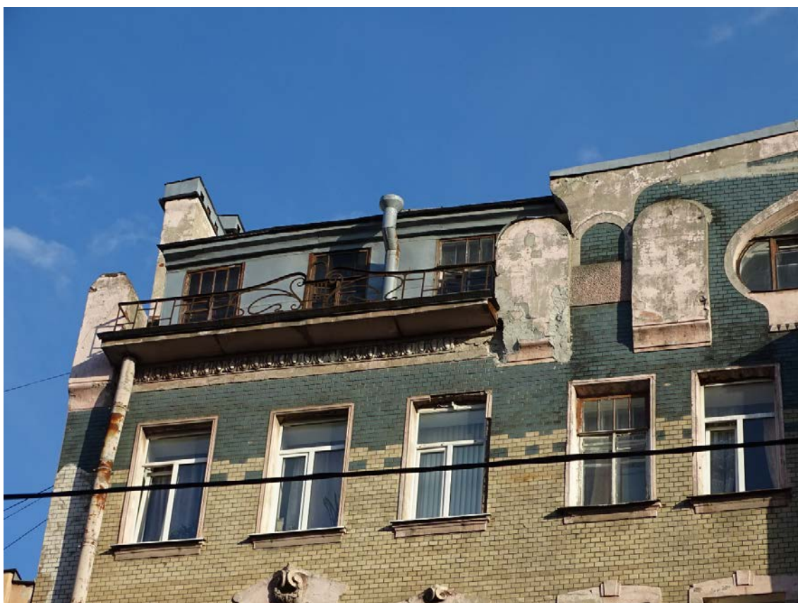
Фото 8. Здание по адресу: г. Санкт-Петербург, Средний пр. В. О., д. 56, литера А. Фрагмент лицевого фасад по 14-й линии. Съемка 19.04.2021 г. Кириков Б. М.
