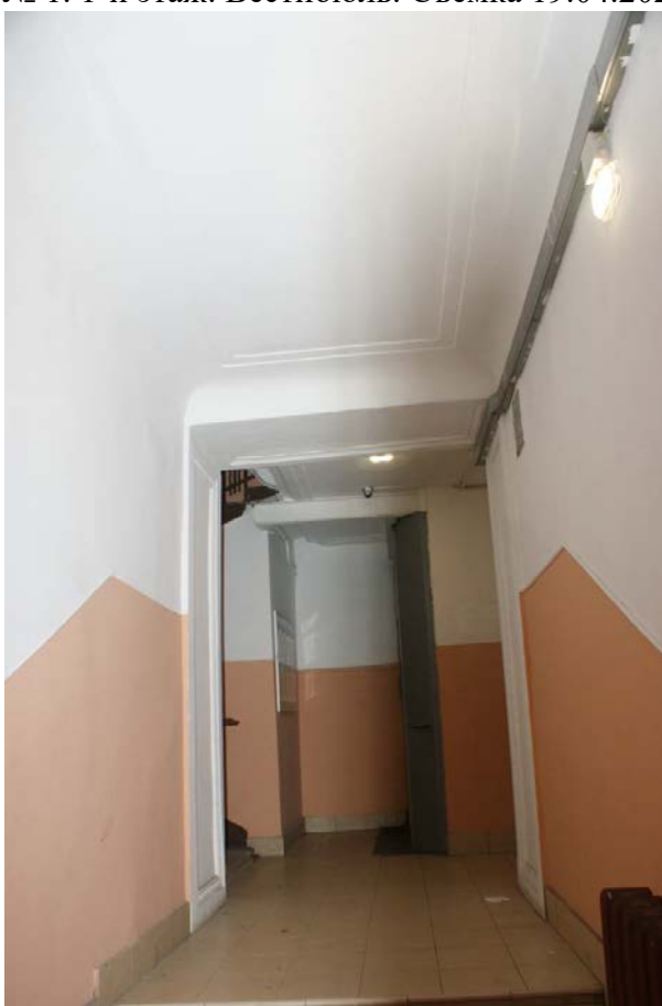
Фото 4. Лестница № 1. 1-й этаж. Вестибюль. Съемка 19.04.2021 г. Кириков Б. М.
