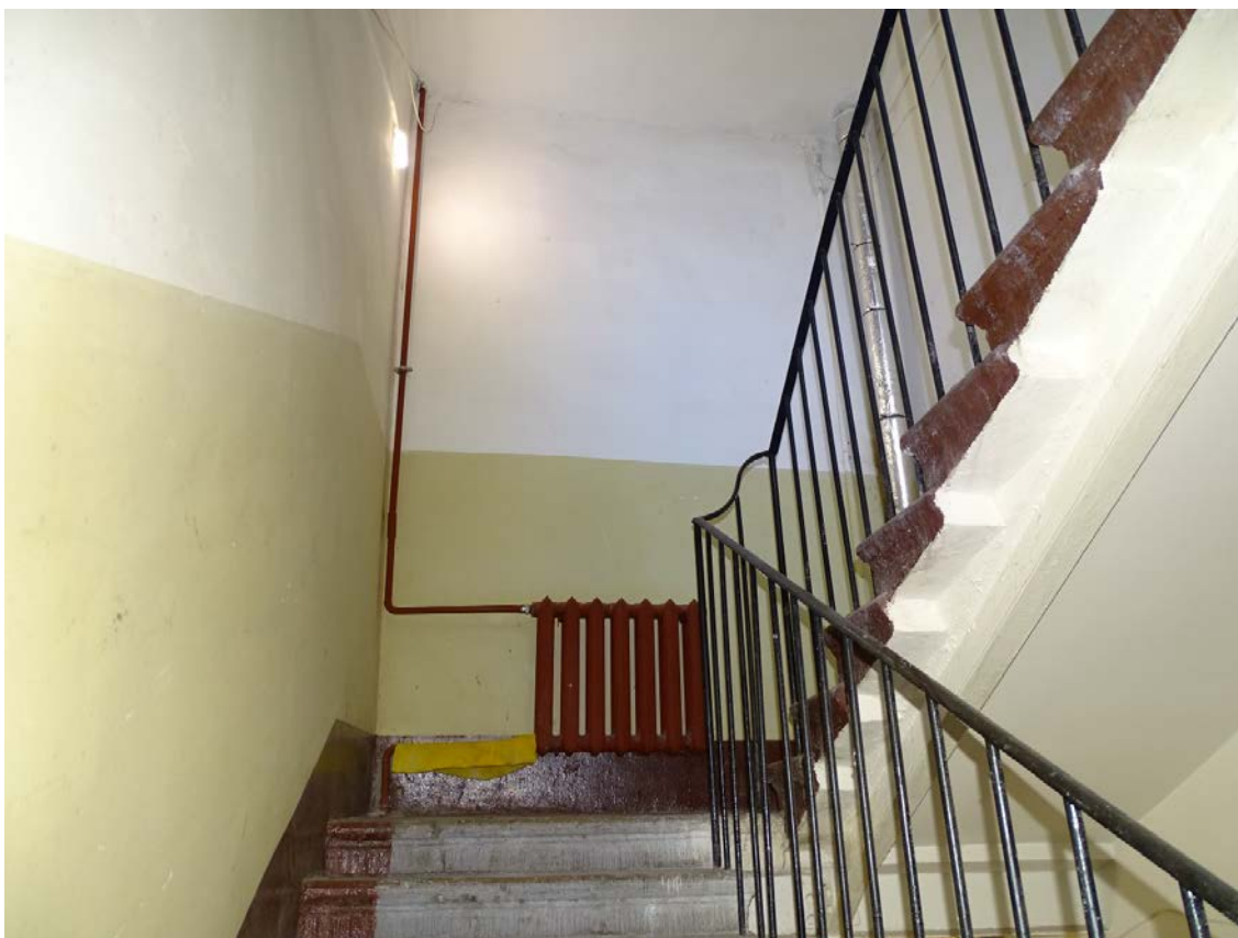
Фото 56. Лестница № 2. Площадка между 5-м и 6-м этажом. Съемка 19.04.2021 г. Кириков Б. М.
