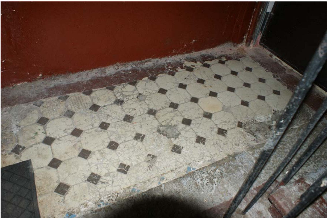
Фото 41. Лестница № 2. 2 этаж. Оформление пола. Съемка 19.04.2021 г. Кириков Б. М.
