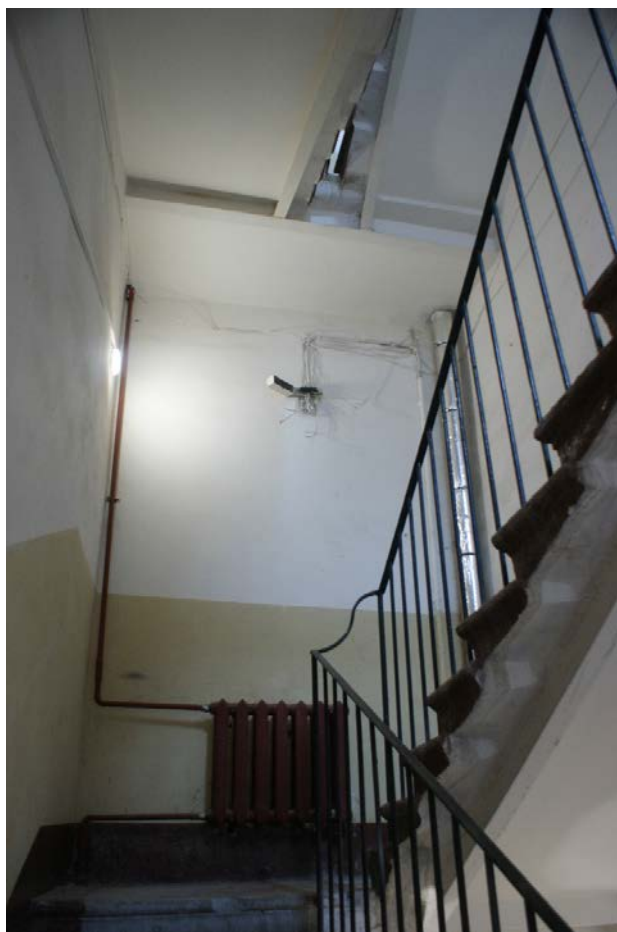
Фото 52. Лестница № 2. Площадка между 4-м и 5-м этажом. Съемка 19.04.2021 г. Кириков Б. М.
