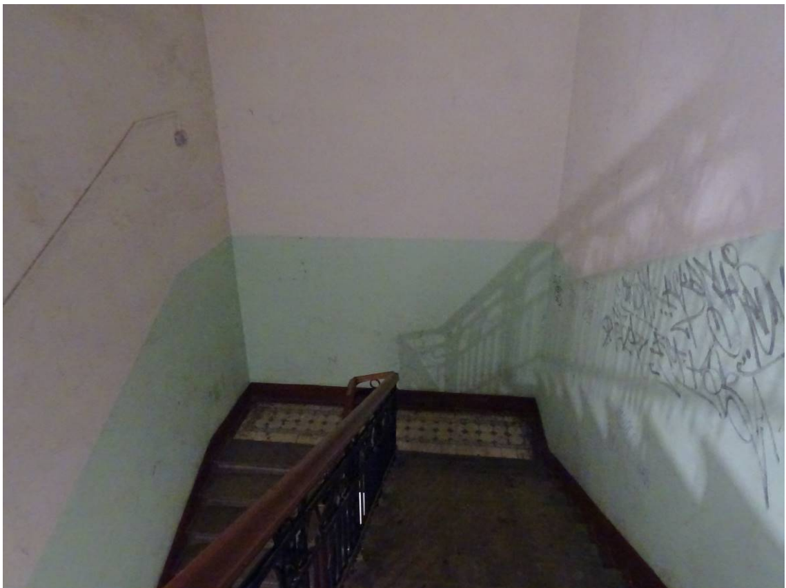
Фото 30. Лестница № 1. Площадка между 6-м и 7-м этажом. Съемка 19.04.2021 г. Кириков Б. М.
