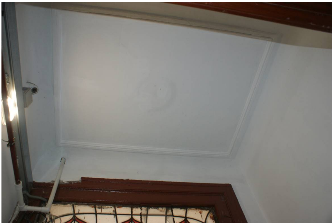
Фото 2. Лестница № 1. 1-й этаж. Вестибюль. Оформление потолка. Съемка 19.04.2021 г. Кириков Б. М.
