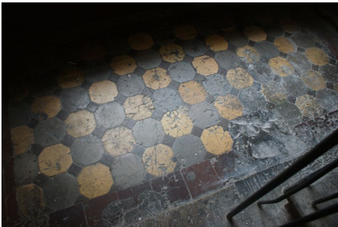
Фото 50. Лестница № 2. 4 этаж. Оформление пола. Съемка 19.04.2021 г. Кириков Б. М.
