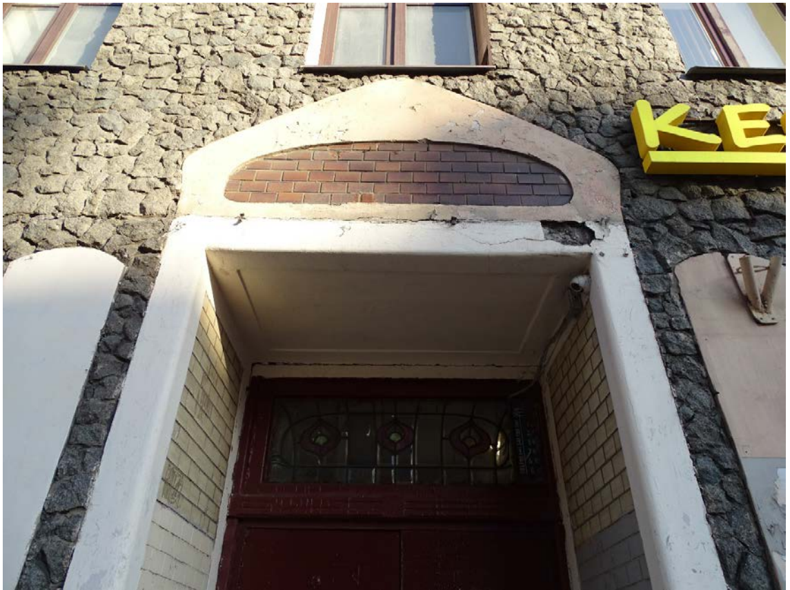
Фото 13. Здание по адресу: г. Санкт-Петербург, Средний пр. В. О., д. 56, литера А. Фрагмент лицевого фасада по 14-й линии. Оформление входного портала. Съемка 19.04.2021 г. Кириков Б. М.
