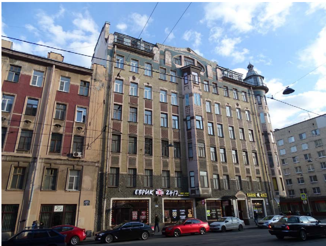
Фото 4. Здание по адресу: г. Санкт-Петербург, Средний пр. В. О., д. 56, литера А. Лицевой фасад по 14-й линии. Съемка 19.04.2021 г. Кириков Б. М.
