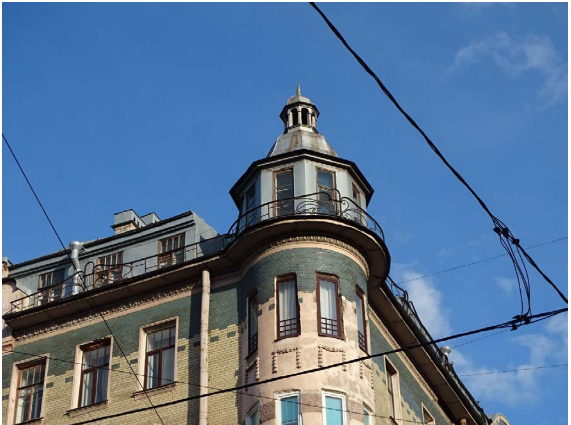
Фото 10. Здание по адресу: г. Санкт-Петербург, Средний пр. В. О., д. 56, литера А. Фрагмент лицевого фасада по 14-й линии. Башенка с куполом. Съемка 19.04.2021 г. Кириков Б. М.
