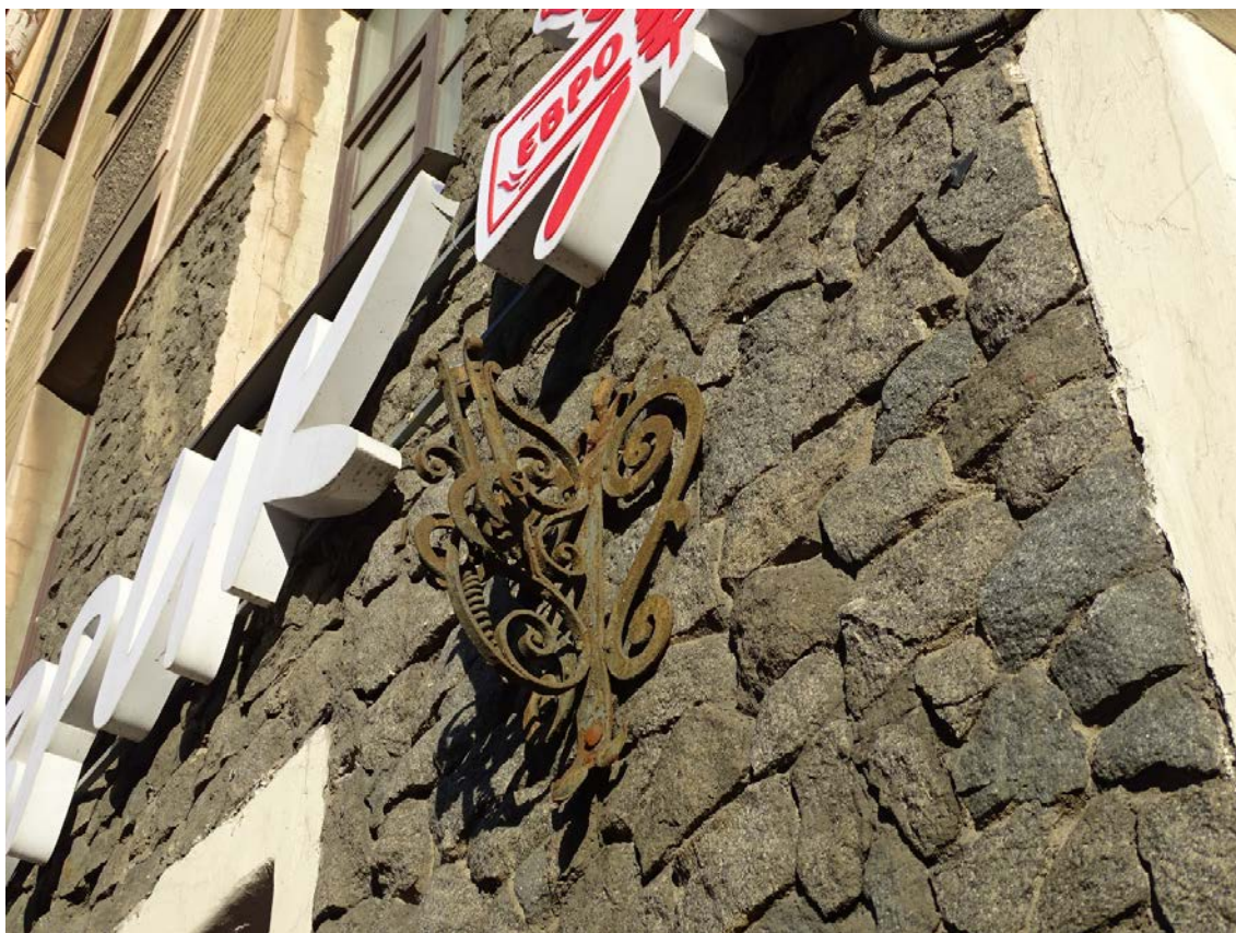
Фото 17. Здание по адресу: г. Санкт-Петербург, Средний пр. В. О., д. 56, литера А. Фрагмент лицевого фасада по 14-й линии. Флагодержатель. Съемка 19.04.2021 г. Кириков Б. М.
