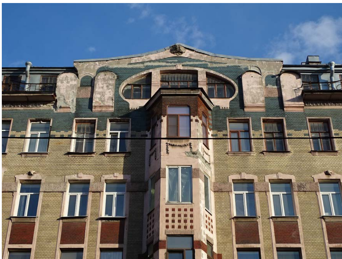
Фото 6. Здание по адресу: г. Санкт-Петербург, Средний пр. В. О., д. 56, литера А. Фрагмент лицевого фасад по 14-й линии. Съемка 19.04.2021 г. Кириков Б. М.
