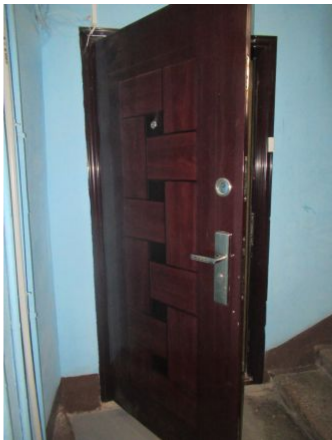
Фото №6. Входная дверь в квартиру №125.
