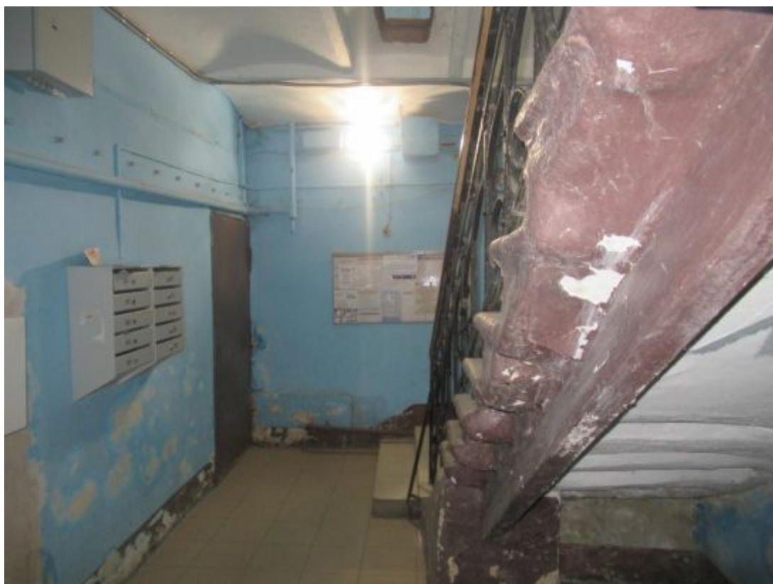
Фото № 4. Лестничная клетка.
