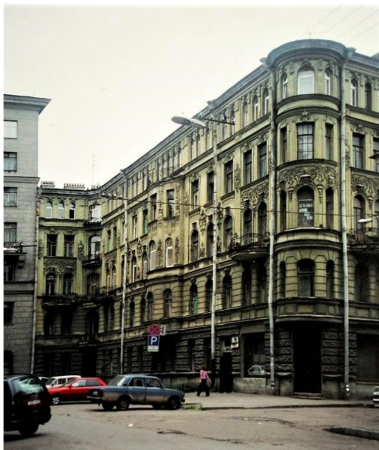
Илл. 32. Юго-восточный фасад дома. 1990-е гг.
