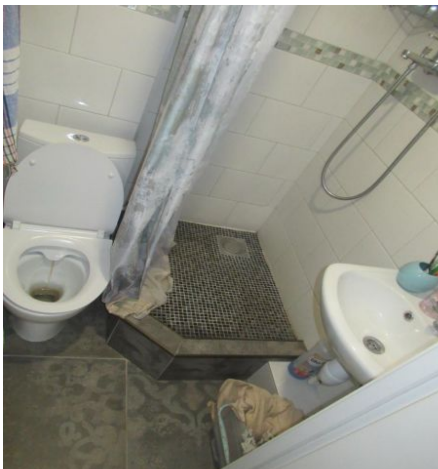
Фото №14. Санитарный узел.
