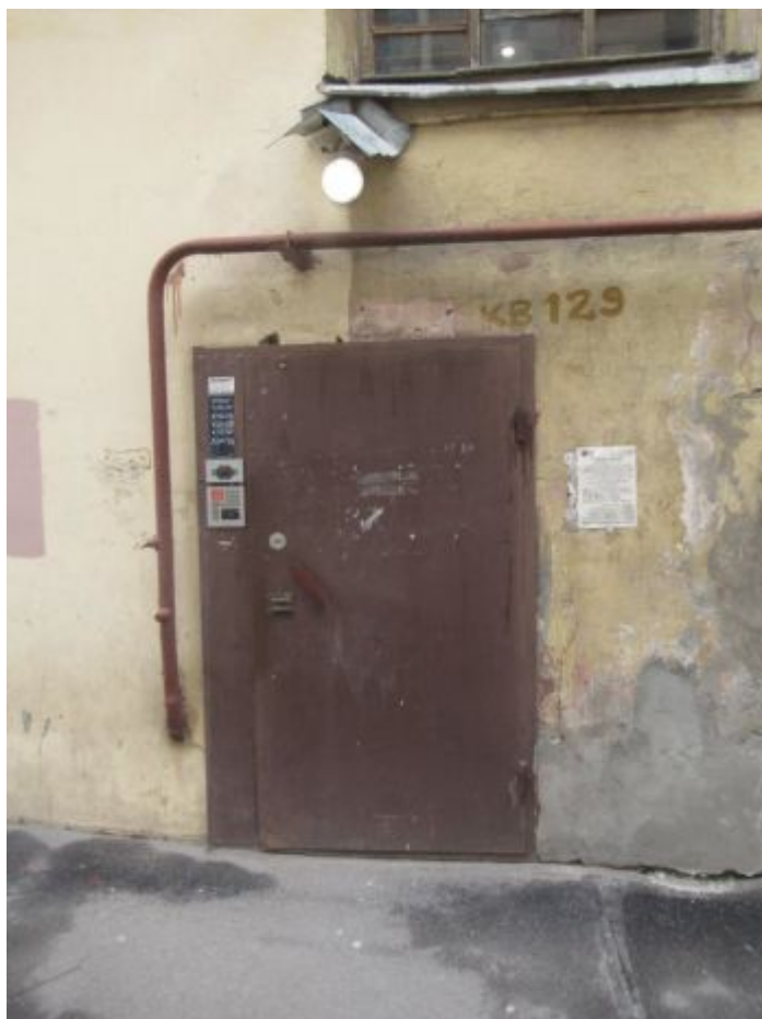
Фото №3. Входная дверь на лестничную клетку.
