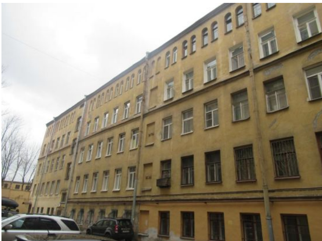
Фото №1. Дворовой фасад жилого дома.
