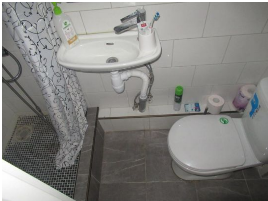
Фото №15. Санитарный узел.
