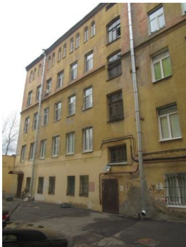
Фото №2. Дворовой фасад жилого дома.
