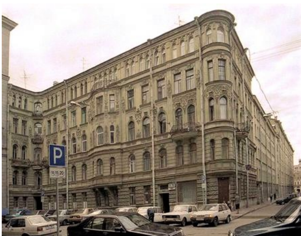
Илл. 33. Общий вид юго-восточной части дома. 1990-е гг.
