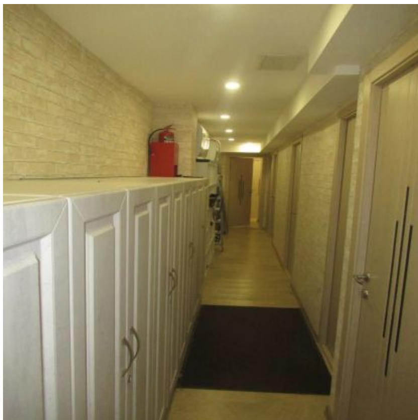
Фото №7. Коридор квартиры №121.
