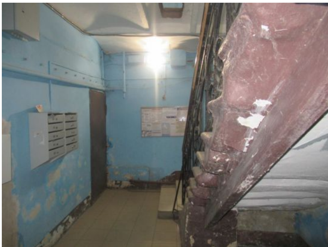
Фото № 4. Лестничная клетка.
