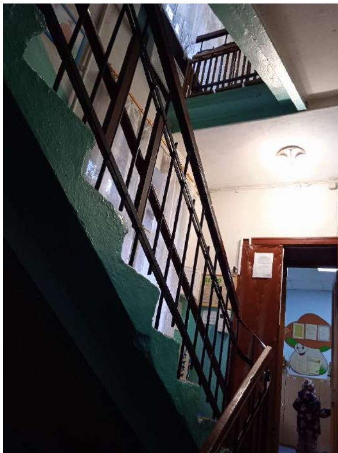
Фото 8 Лестничная клетка 1/К. Общий вид на площадки первого и второго этажей
