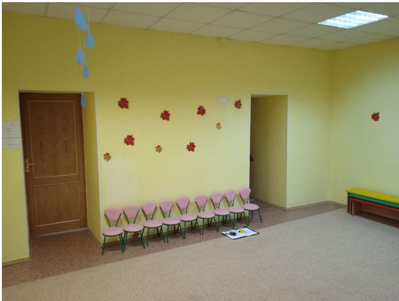
Фото 60. Помещение 3 Проемы в капитальной стене.
