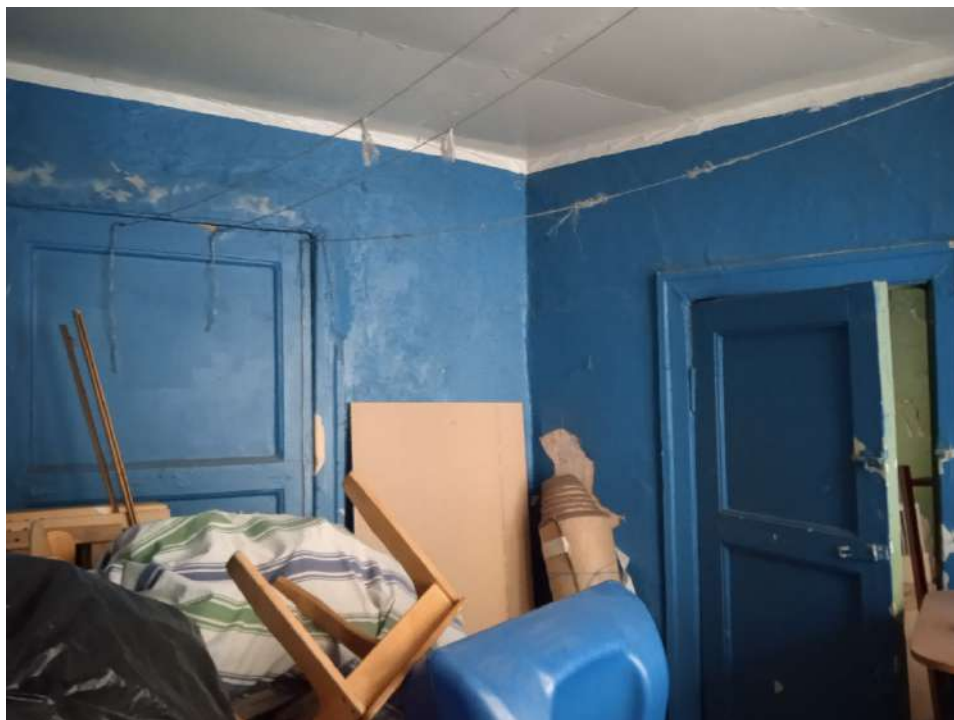
Фото 53 Помещение 21 Слева дверной проем на эвакуационную лестницу
