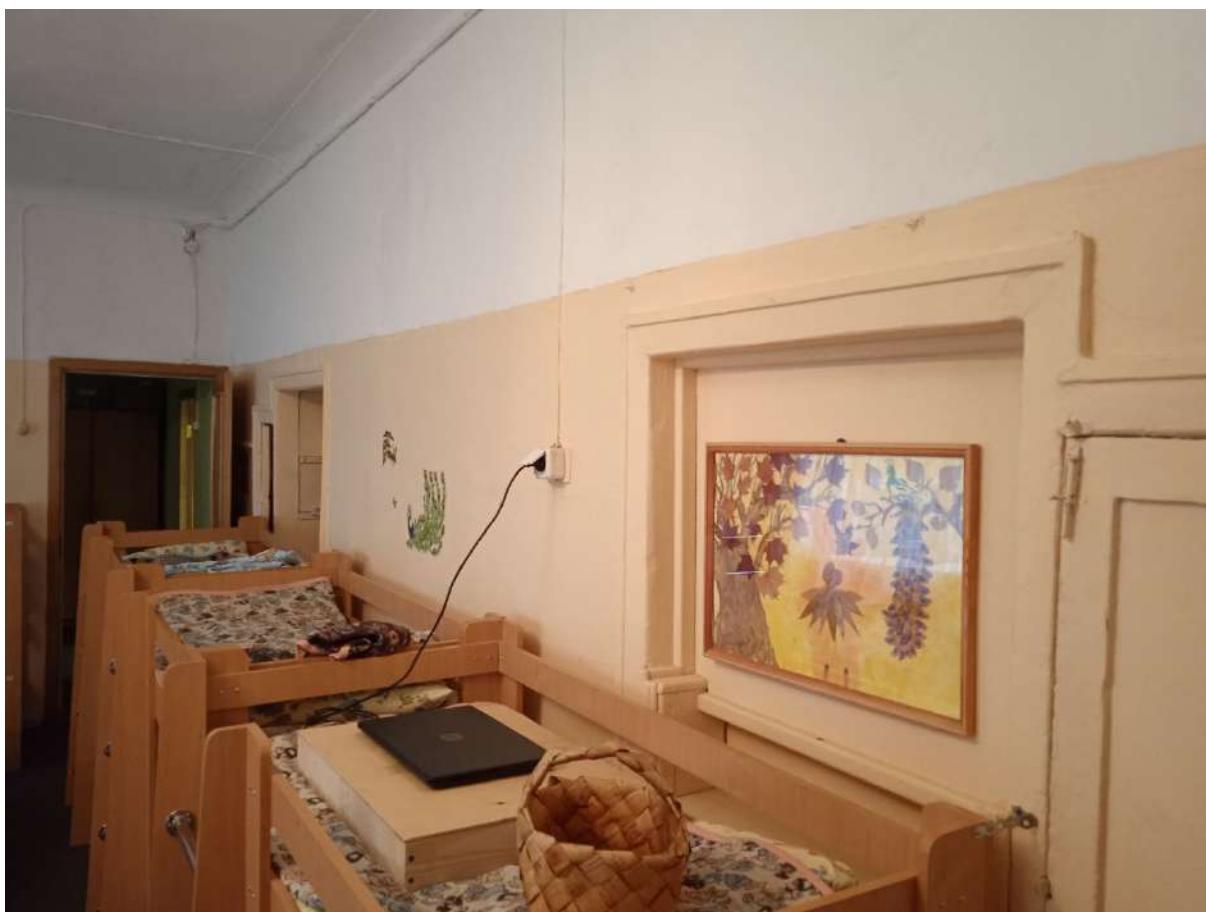
Фото 19. Помещение 5. Ниши в капитальной стене.
