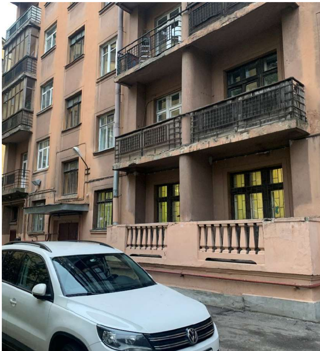
Фото 5. Общий вид здания. Дворовый фасад.
