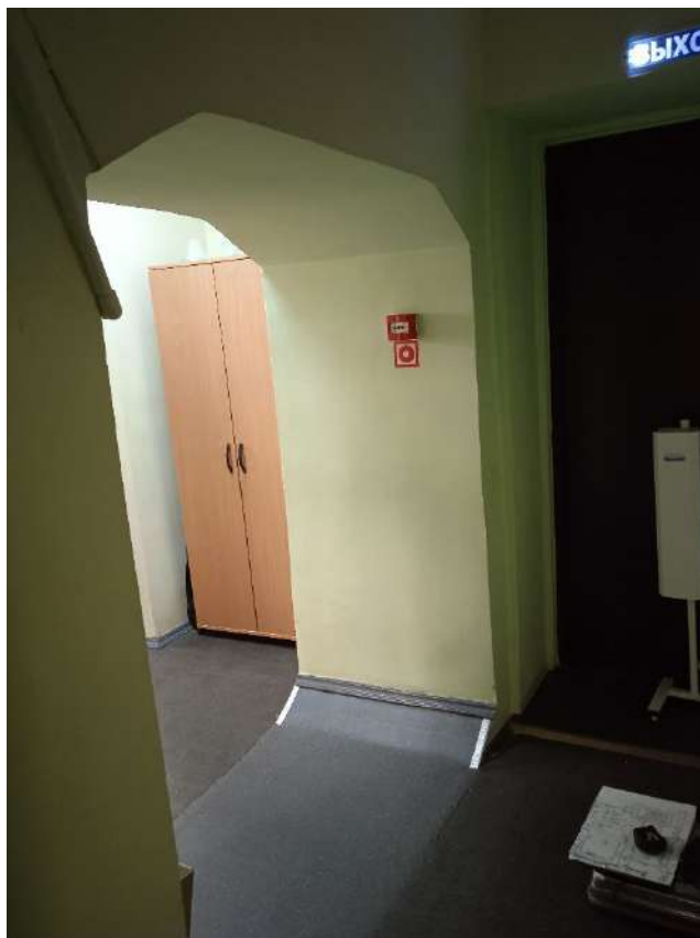
Фото 34 Помещение 11. Проем в капитальной стене
