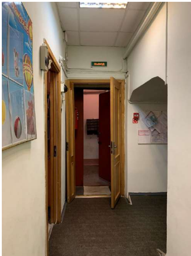
Фото 32 Помещение 11. Выход на лестничную клетку 6/К
