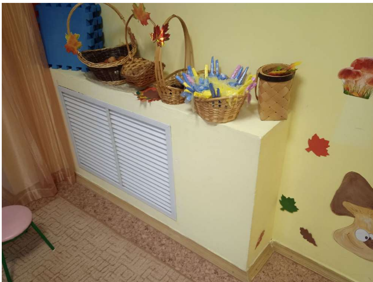
Фото 61. Помещение 3 Защитный короб радиаторов отопления.
