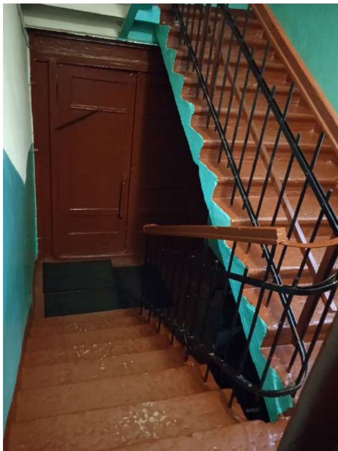
Фото 6 Лестничная клетка 1ЛК. Вид на площадку входа в здание.
