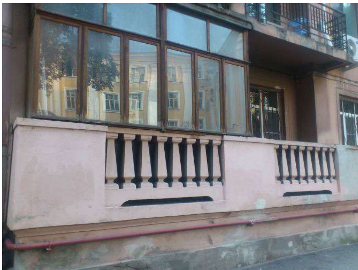
23. Фрагмент дворового фасада в уровне 1-го этажа. Фото 2016 г. https://www.citywalls.ru/house12649.html
