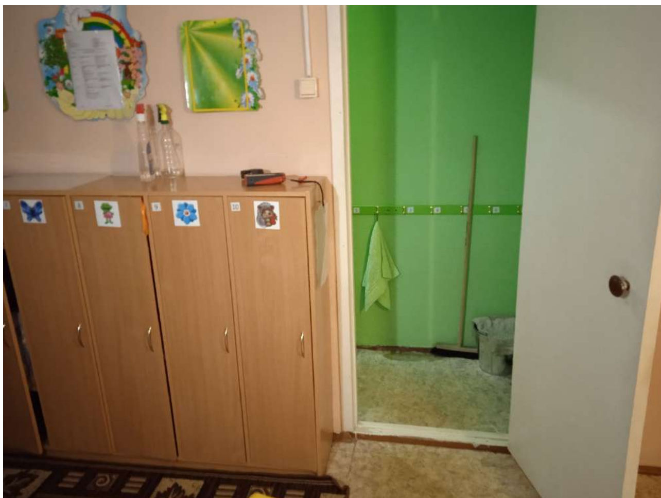
Фото 73. Помещение 10. Вход в санузел
