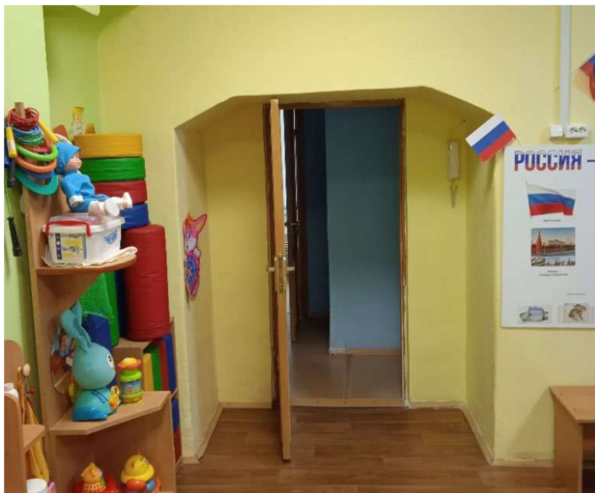
Фото 46. Помещение 18 Игровая. Проем в капитальной стене.
