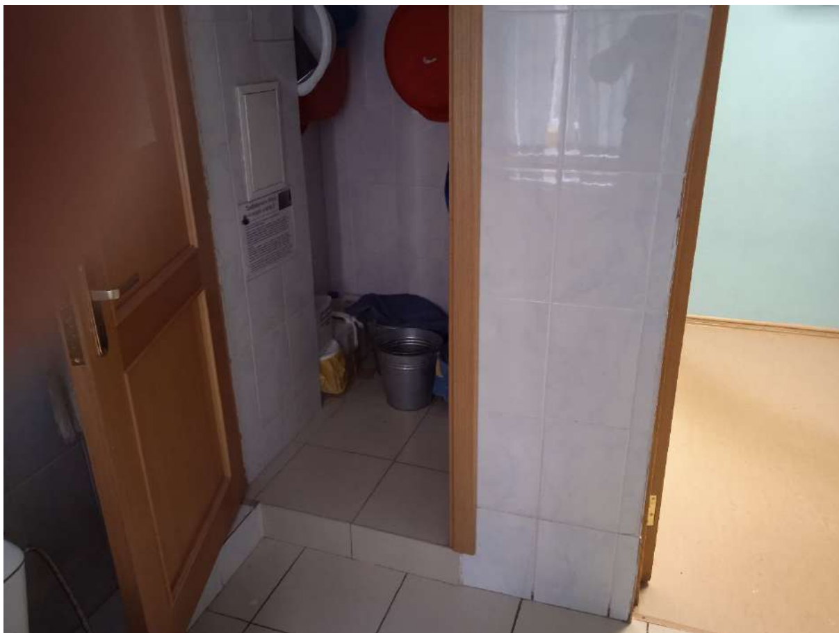
Фото 15. Помещение 4 и 4.1 (кладовая)
