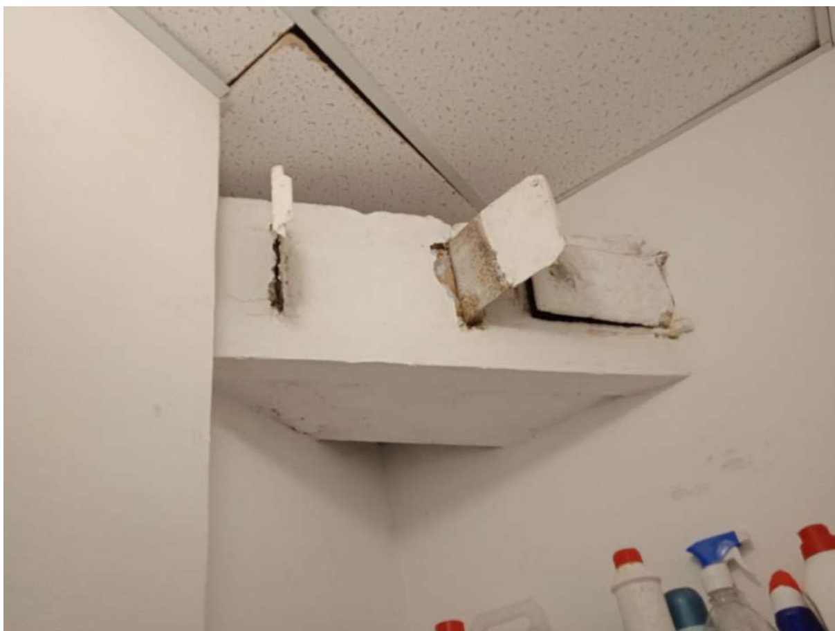
Фото 16. Помещение 4. Кладовая, вентиляционный короб
