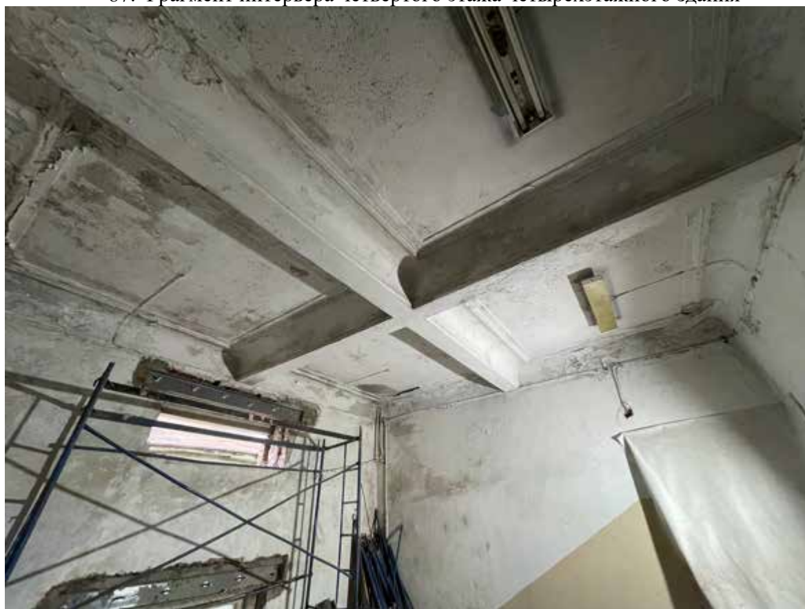
88. Фрагмент интерьера четвертого этажа четырехэтажного здания
