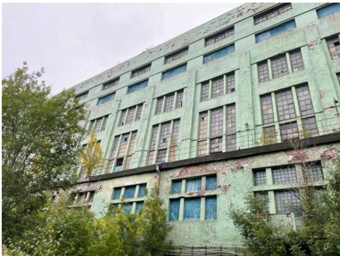
19. Фрагмент южного фасада
