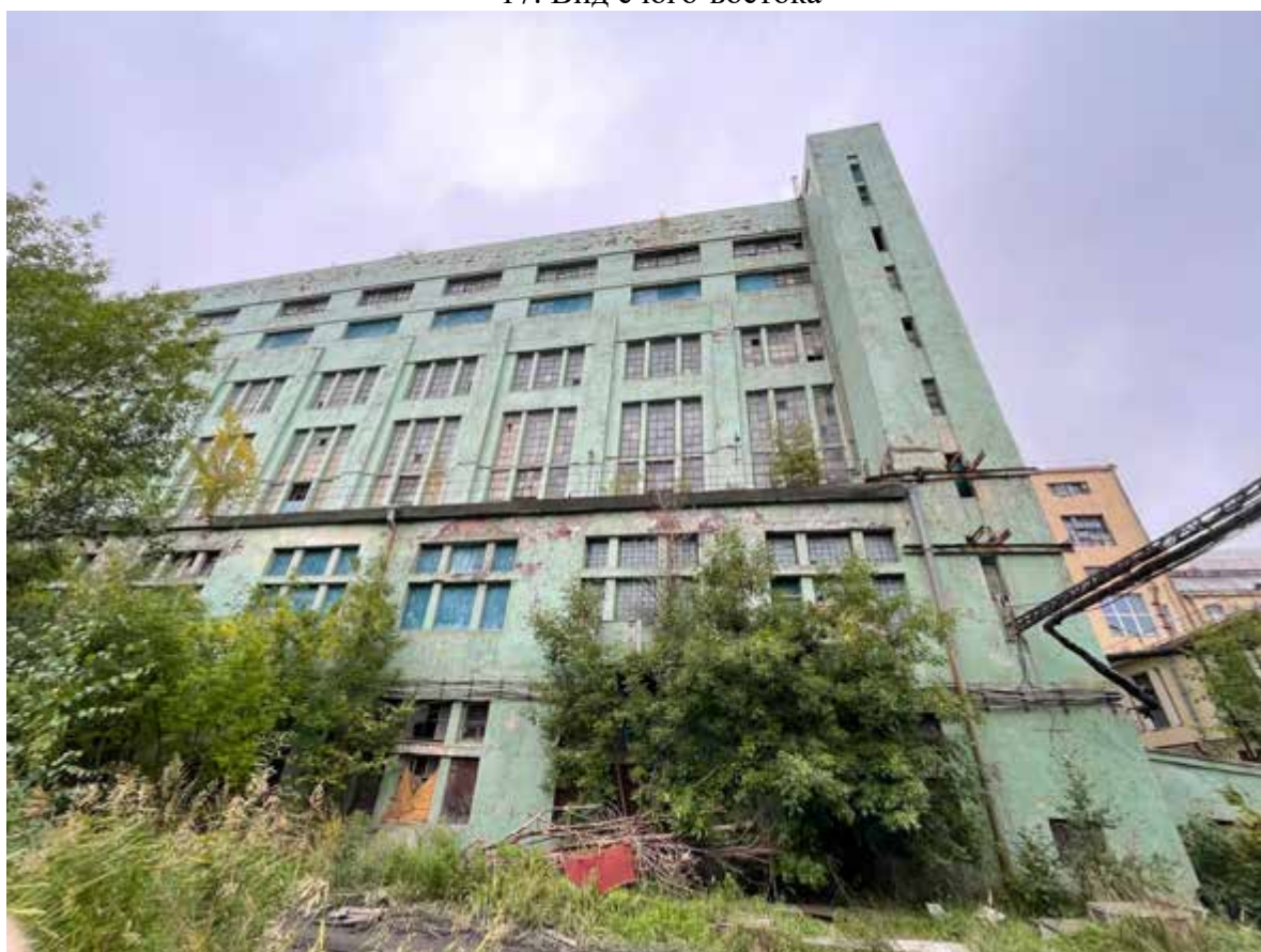
18. Фрагмент южного фасада
