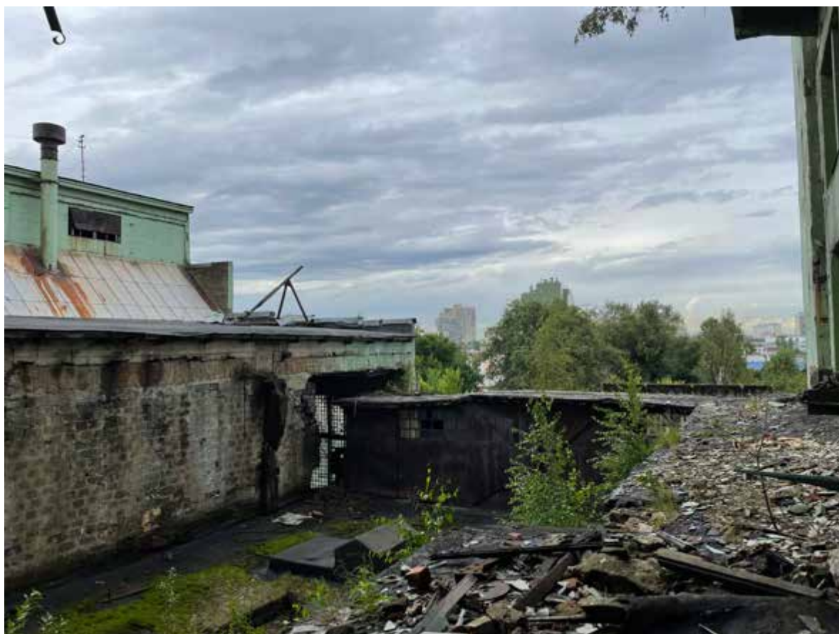
45. Вид на крышу
