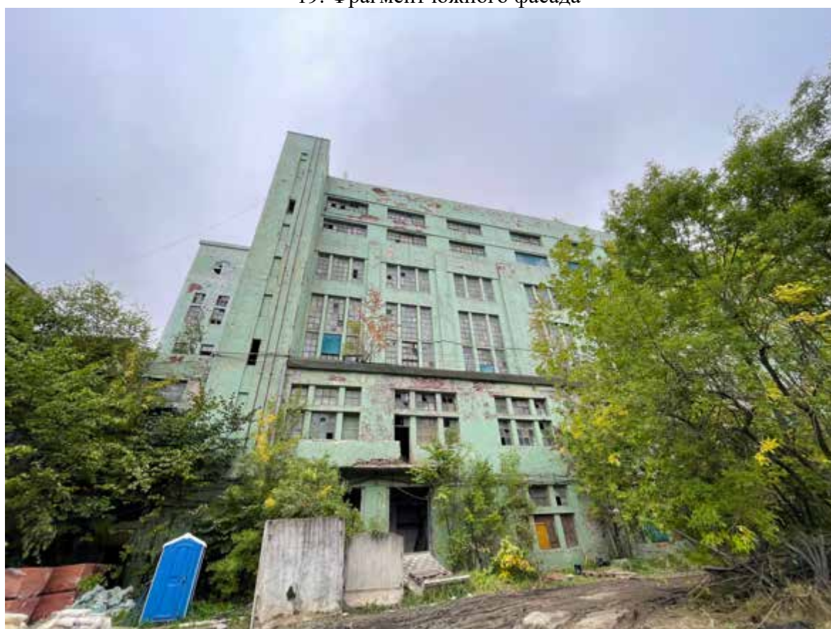
20. Фрагмент южного фасада
