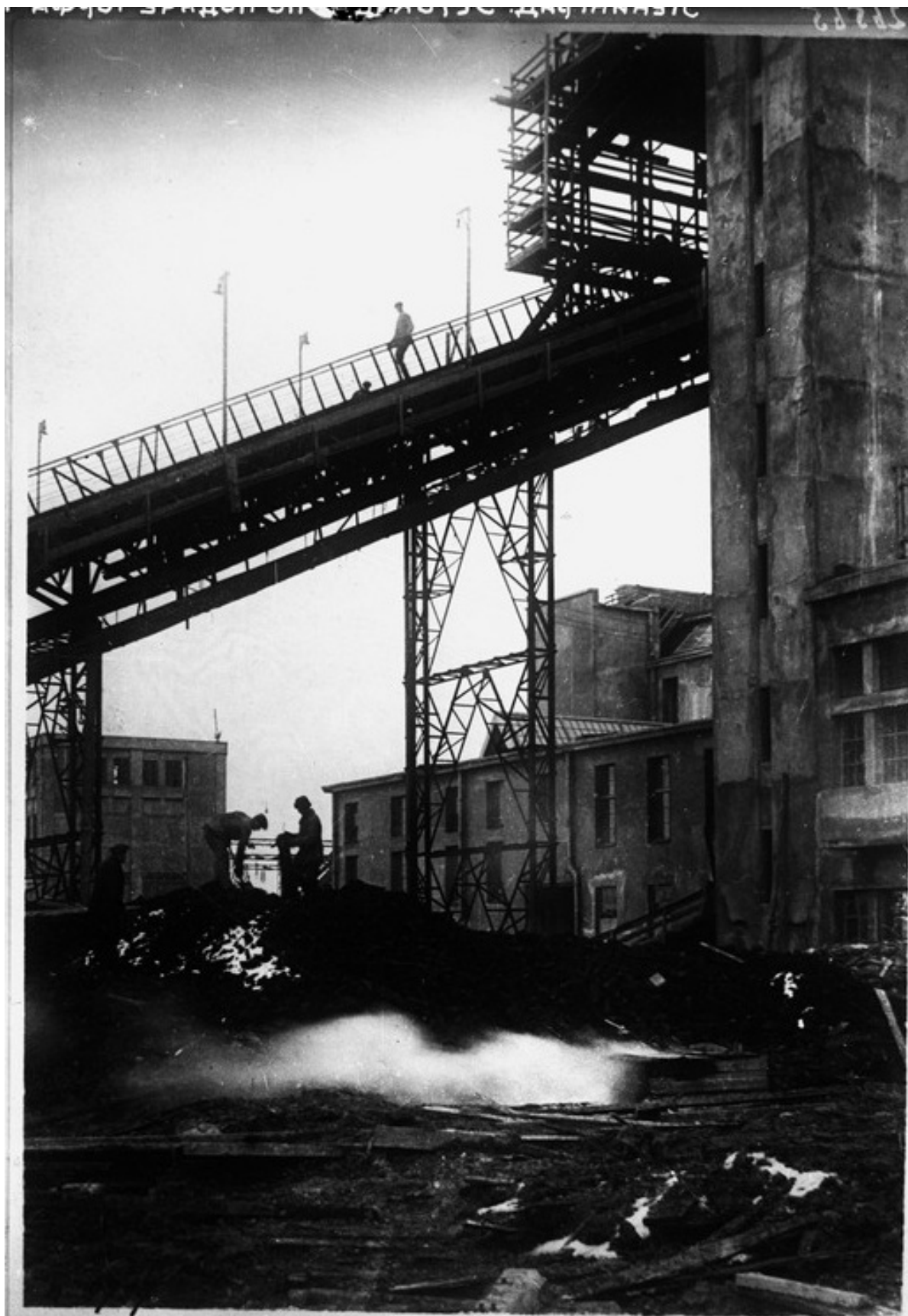
64. "Красный Октябрь". Эстакада по подаче торфа. 1930 г. Федеральное государственное бюджетное учреждение культуры "Государственный центральный музей современной истории России" КП 6161(16)
