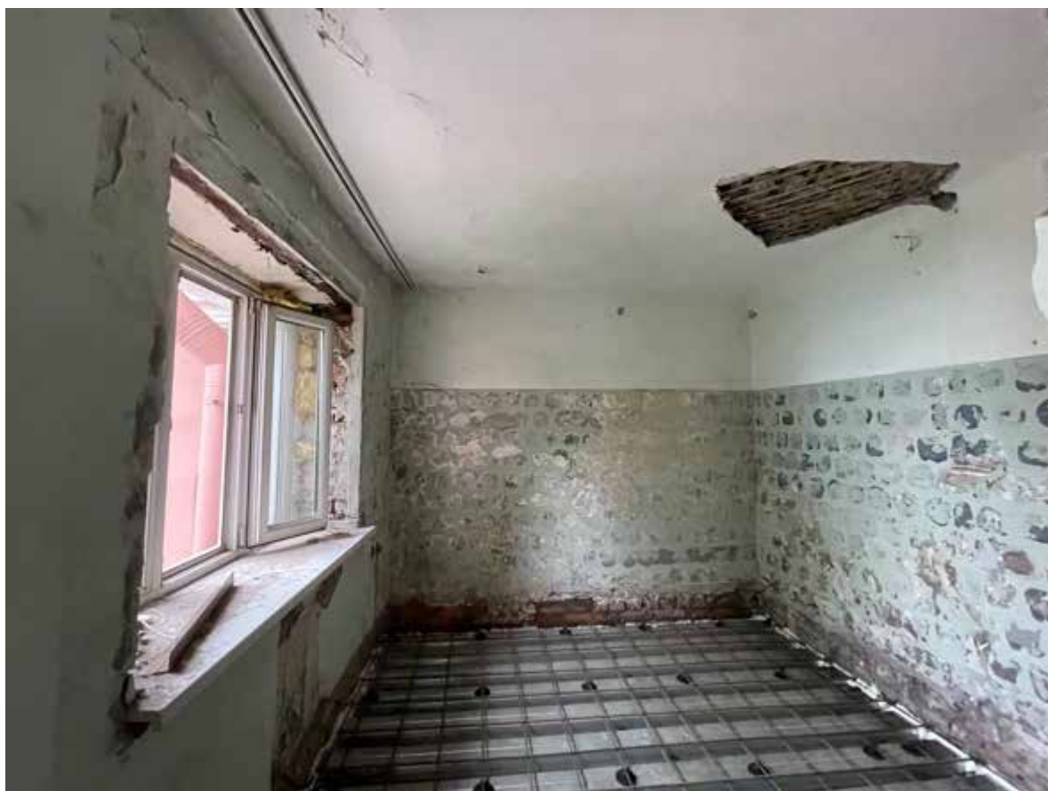
83. Фрагмент интерьера четвертого этажа четырехэтажного здания
