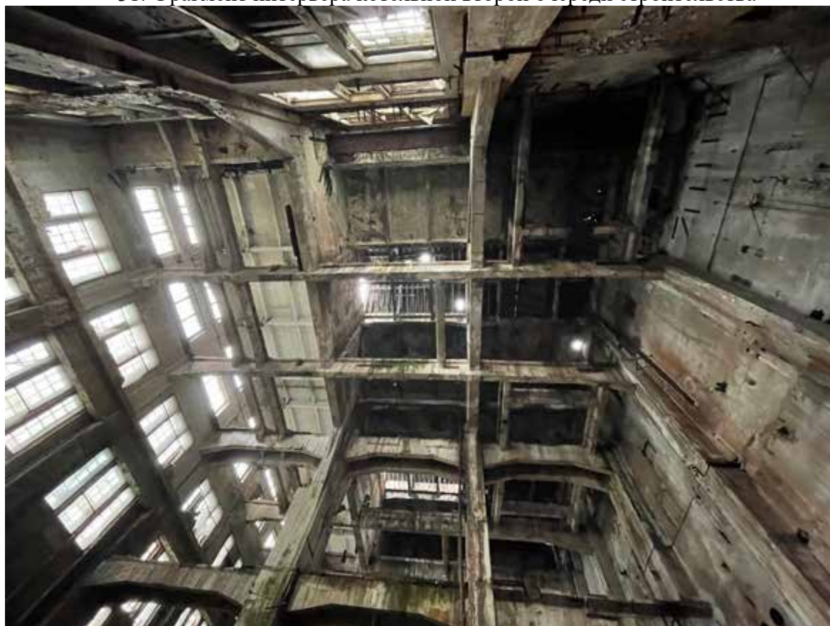
32. Вид на перекрытие котельной второй очереди строительства
