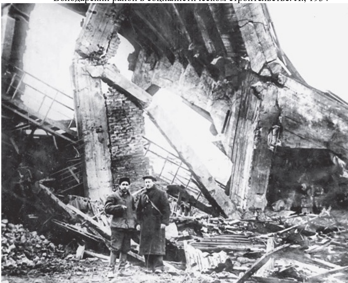
70. ГЭС-5 «Красный Октябрь» после бомбежки. 1941 – 1942 гг. "Опережая время: фотолетопись энергетики Северо-Запада" / Под ред. Н. И. Быстровой. — СПб.: Издательский дом «МедиаЛайн», 2015.
