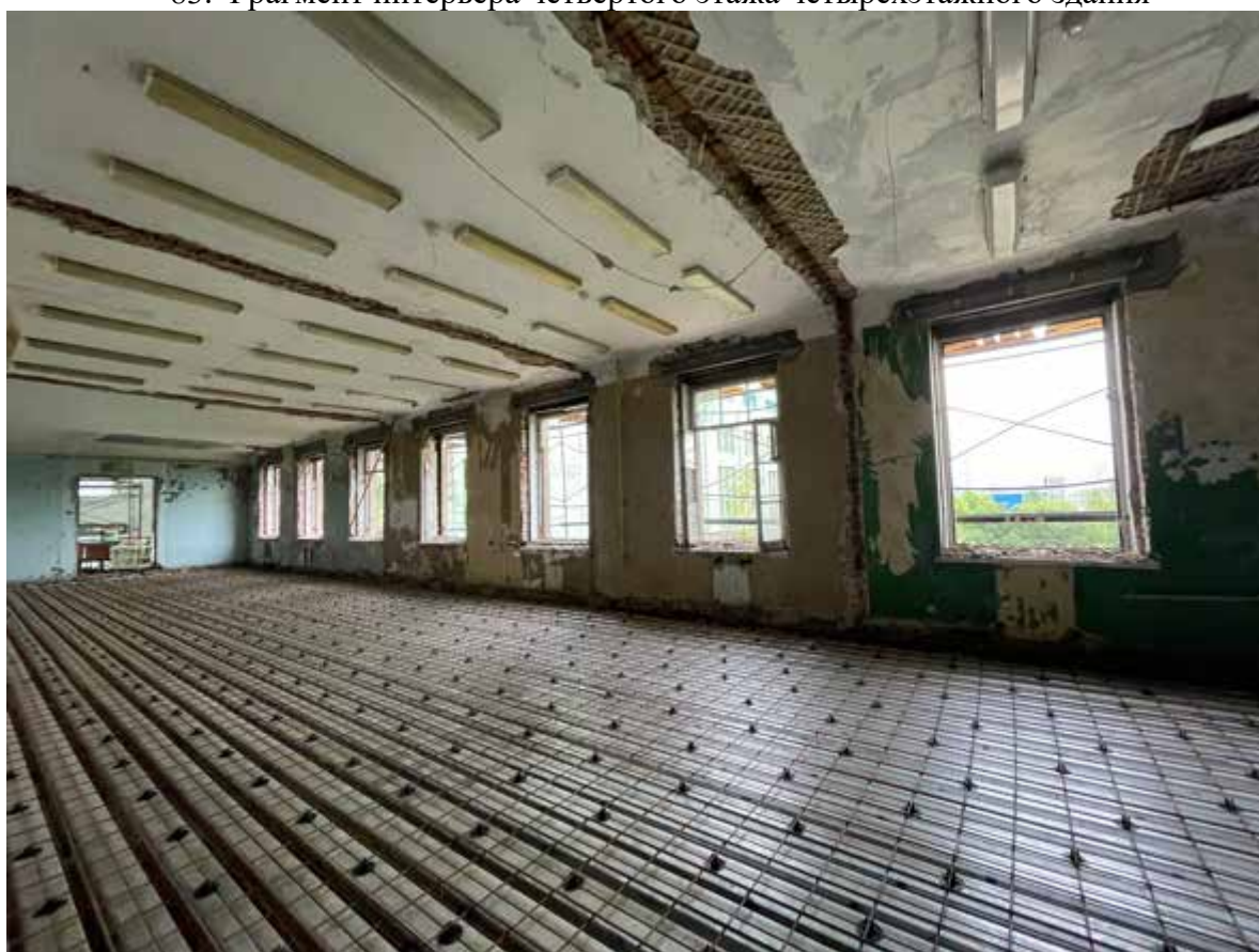
84. Фрагмент интерьера четвертого этажа четырехэтажного здания
