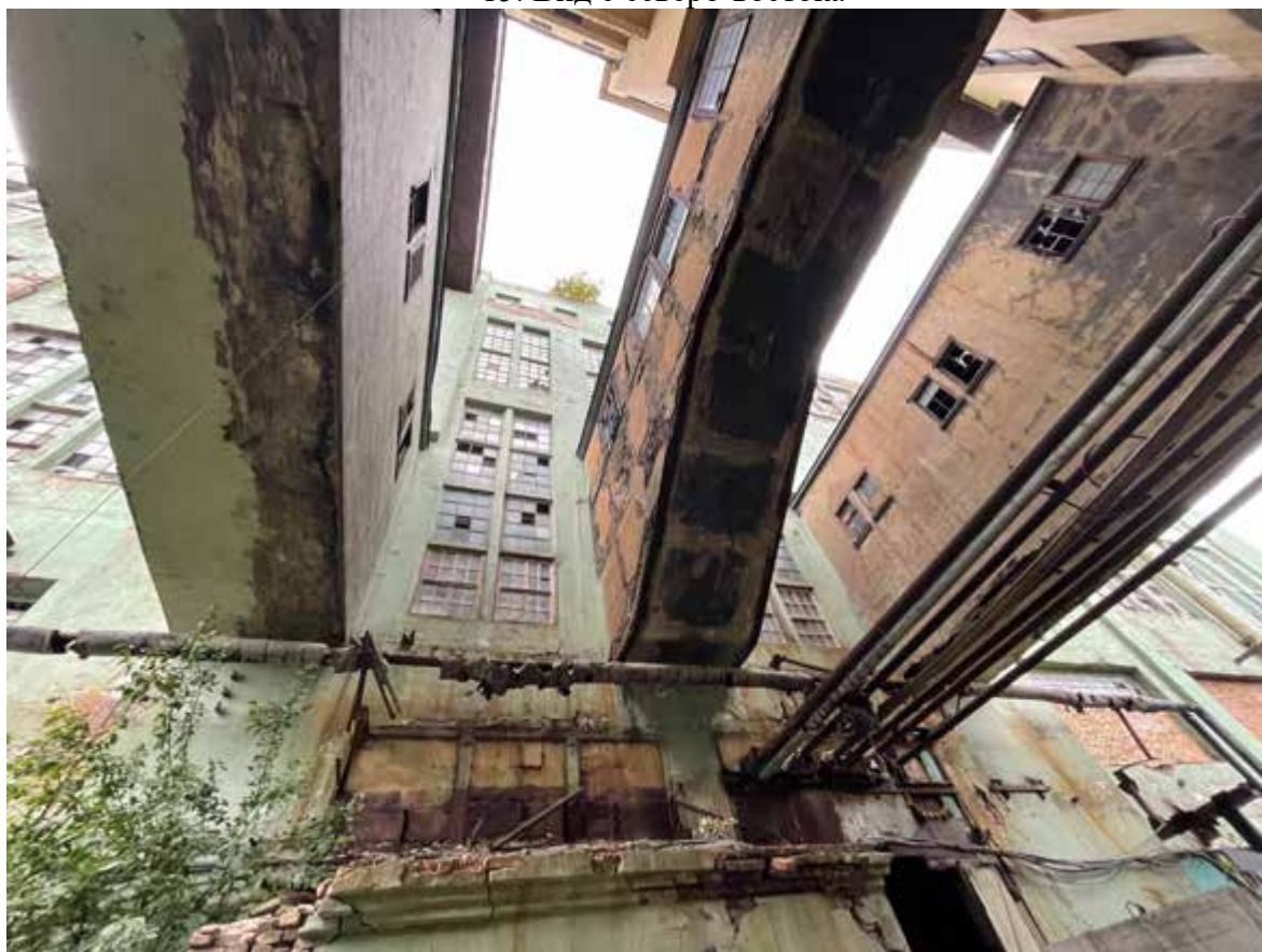
16. Фрагмент восточного фасада
