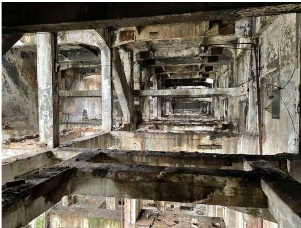
49. Вид на перекрытия котельной второй очереди строительства
