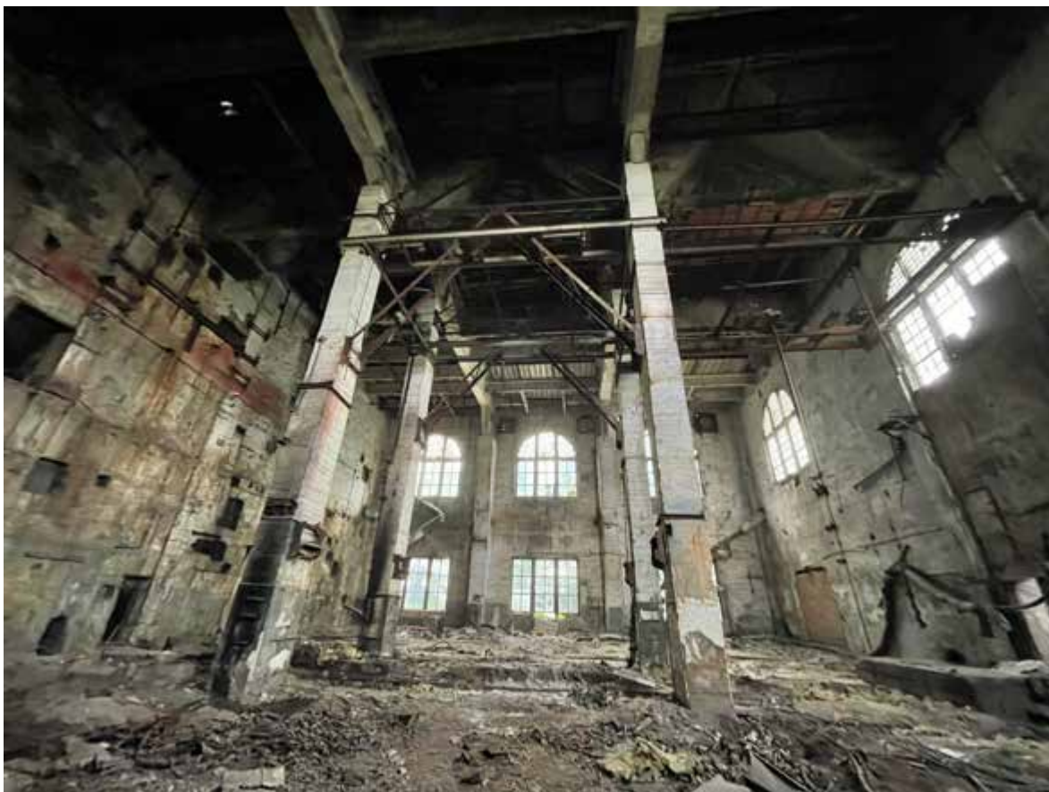
41. Фрагмент интерьера котельной первой очереди строительства
