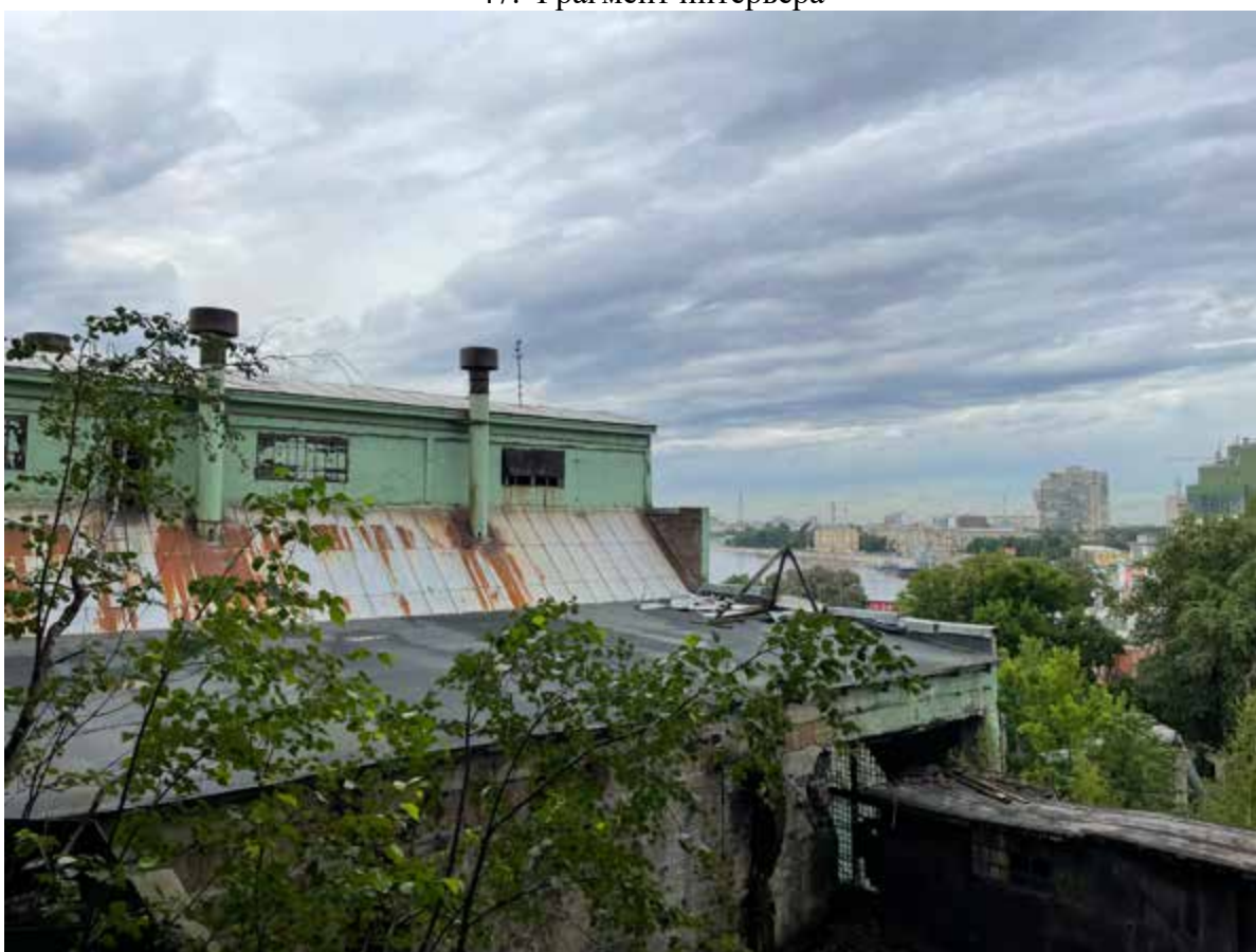
48. Вид на крышу котельной первой очереди строительства
