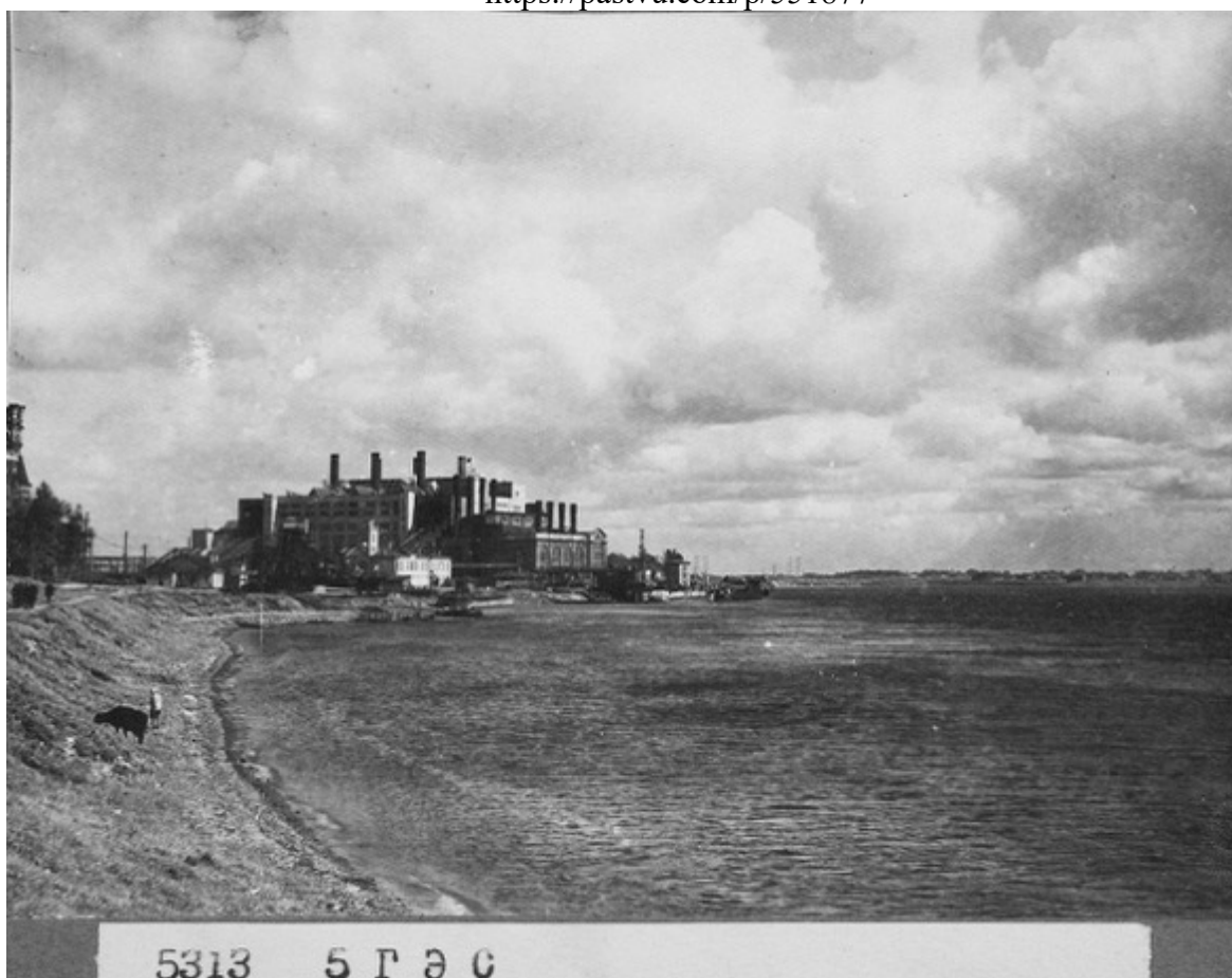
68. 5-я ГЭС. 1931-1933 гг. [Электронный ресурс] URL: https://www.citywalls.ru/photo575087.html
