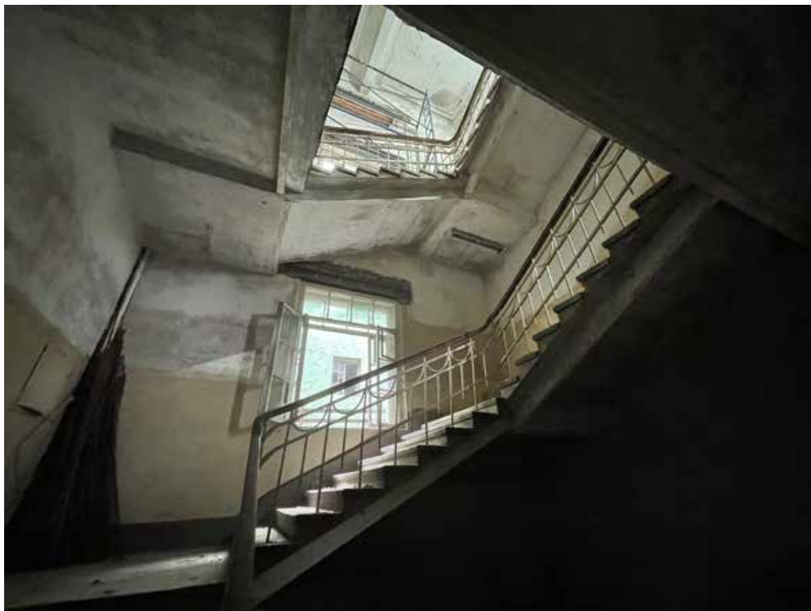
73. Фрагмент интерьера лестницы четырехэтажного здания
