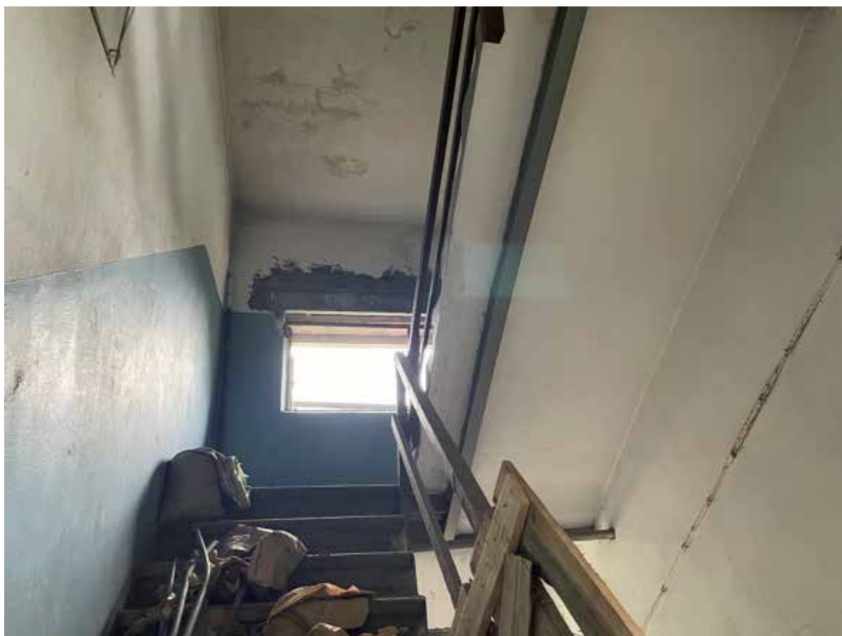
81. Фрагмент интерьера четвертого этажа четырехэтажного здания
