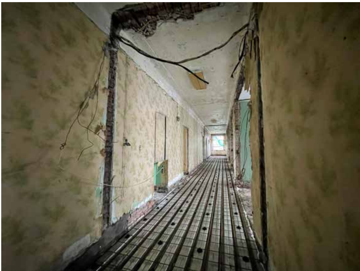
87. Фрагмент интерьера четвертого этажа четырехэтажного здания
