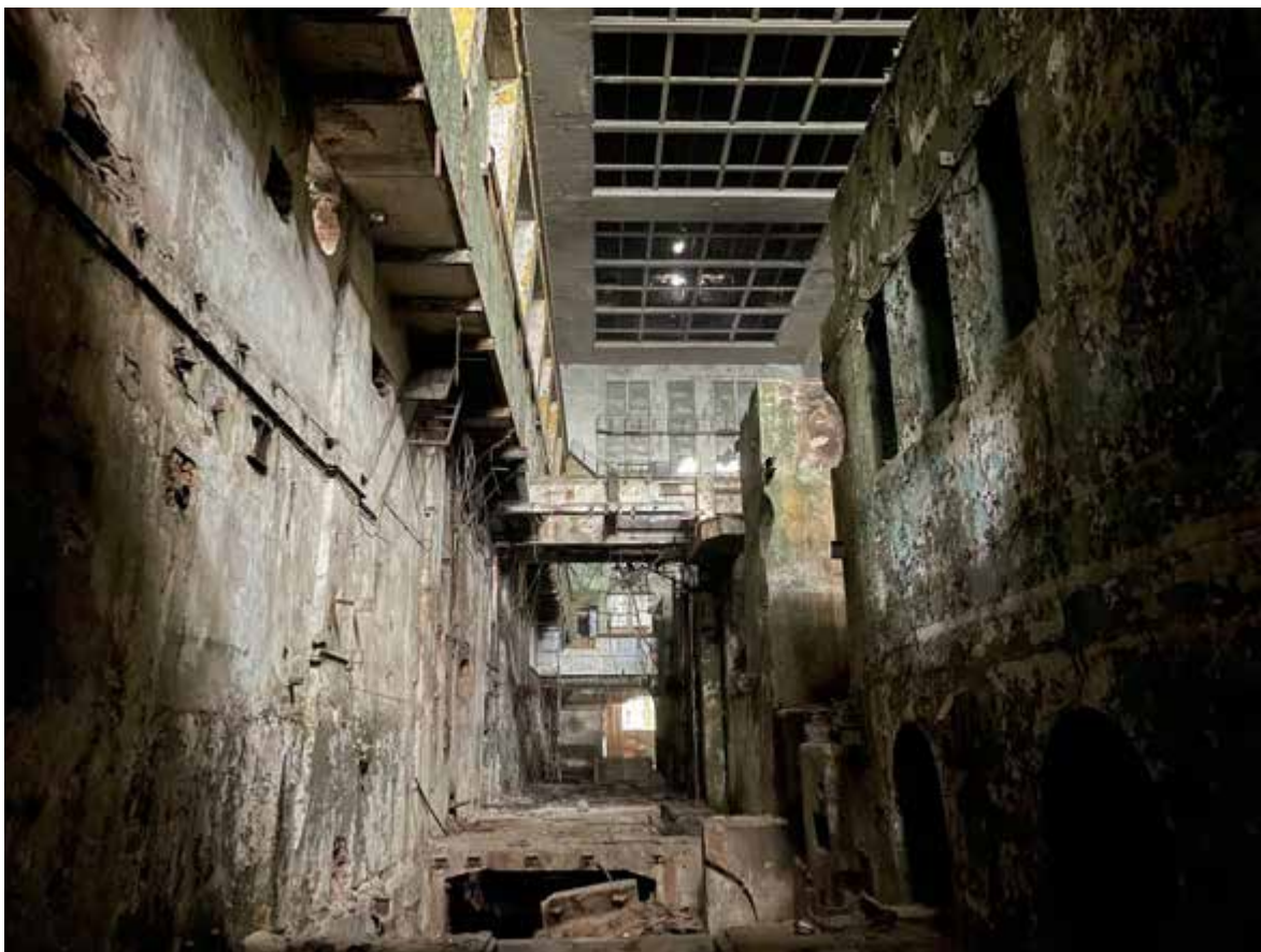
29. Фрагмент интерьера машинного зала в уровне фундамента
