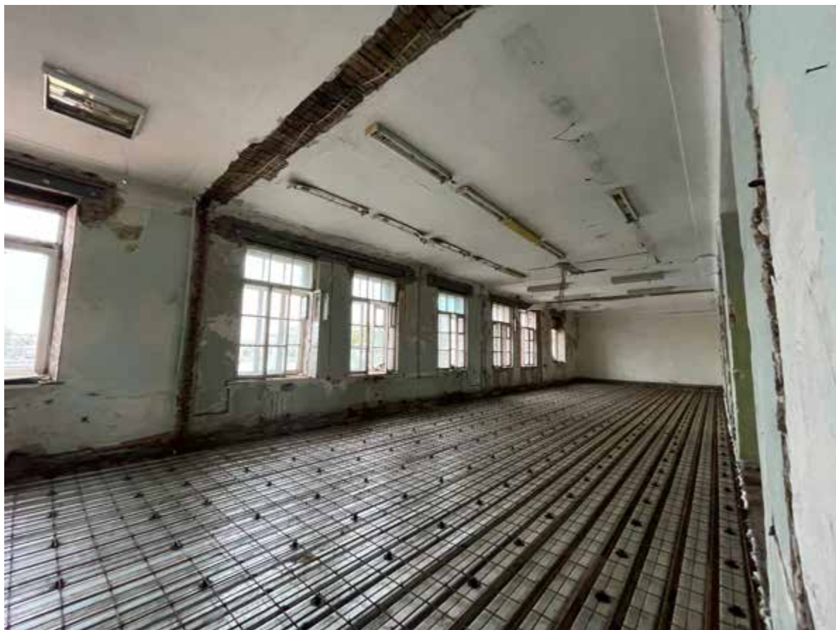
85. Фрагмент интерьера четвертого этажа четырехэтажного здания
