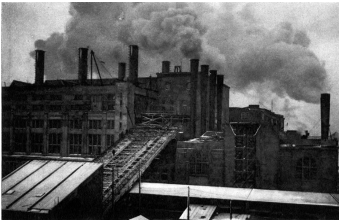
58. 5-я электрическая станция «Красный Октябрь» («Там, где рождается электричество»). 1929 – 1930 гг. «Советское фото», № 3 за 1930 г.
