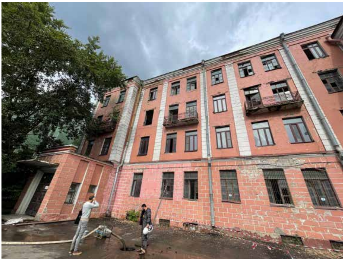
3. Вид на примыкающее здание
