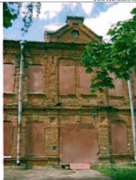
Фото 117. Восточный фасад. Фрагмент центральной части фасада.
