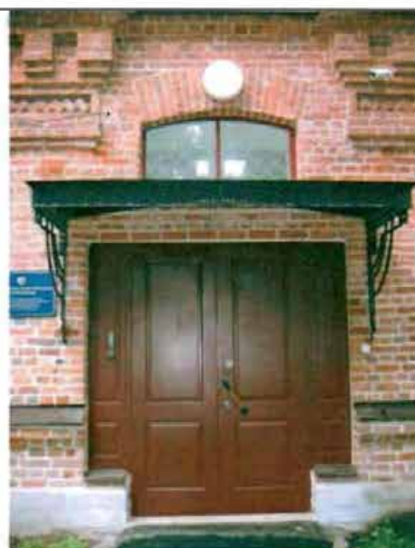
Фото 41. Дверной проем восточного фасада. Общий вид.
