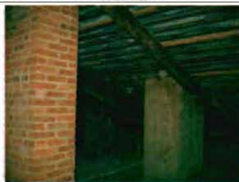
Фото 152. Конструкции крыши. Фрагмент.
