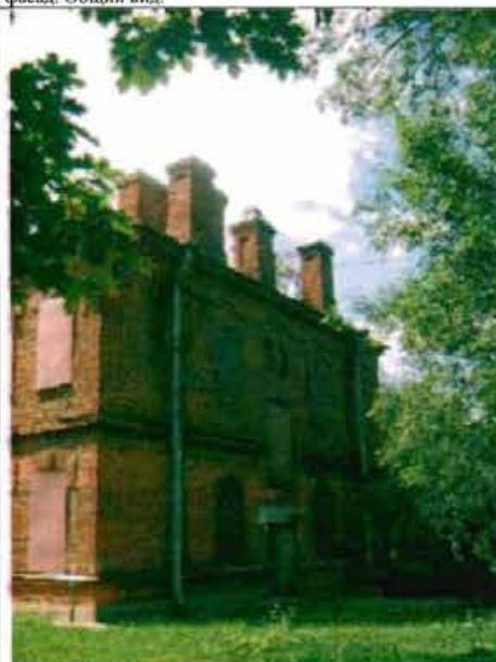
Фото 118. Северный фасад. Общий вид.
