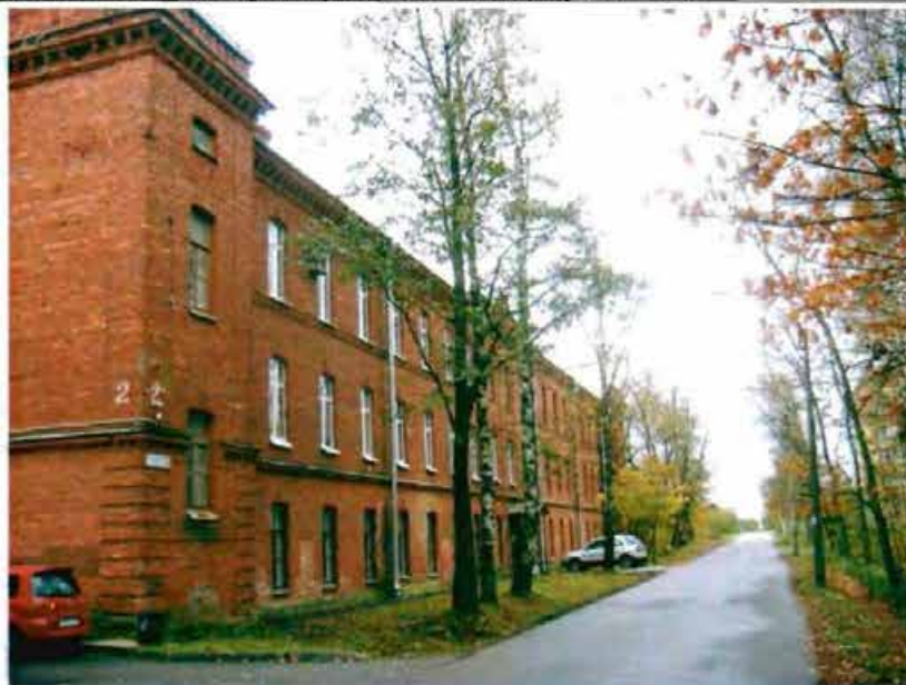
Фото 13. Западный фасад. Общий вид.
