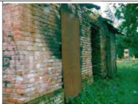
Фото 95. Северный фасад. Общий вид.
