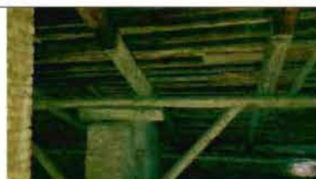
Фото 38. Конструкции крыши. Фрагмент.
