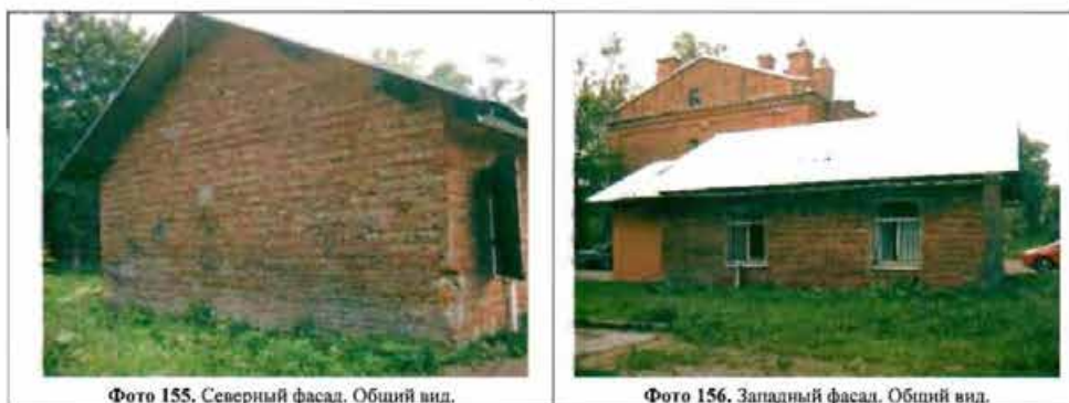
Фото 155. Северный фасад. Общий вид.
