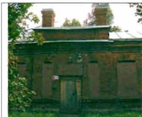
Фото 99. Западный фасад. Центральная часть. Общий вид.
