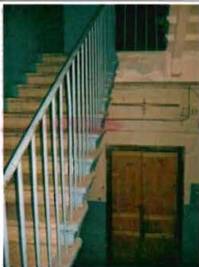
Фото 143. Лестница № 1 в северной части здания. Общий вид.
