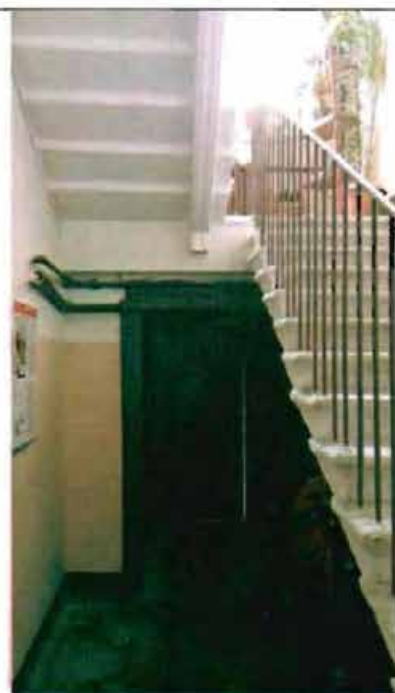
Фото 131. Лестница № 2 в северной части здания. Общий вид.
