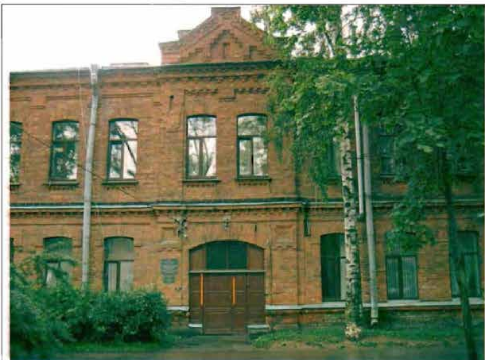
Фото 164. Восточный фасад. Фрагмент центральной части фасада.
