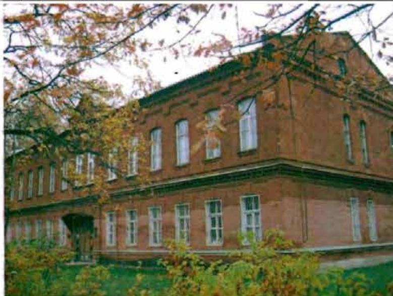
Фото 89. Западный, южный фасады. Общий вид.
