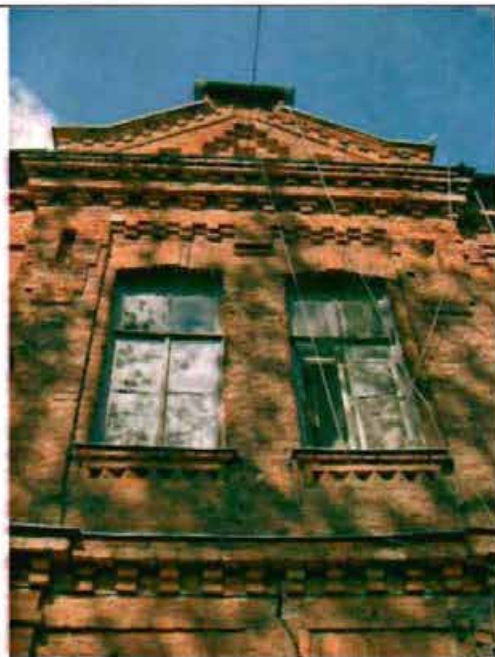
Фото 177. Восточный фасад. Центральная часть. Фрагмент.
