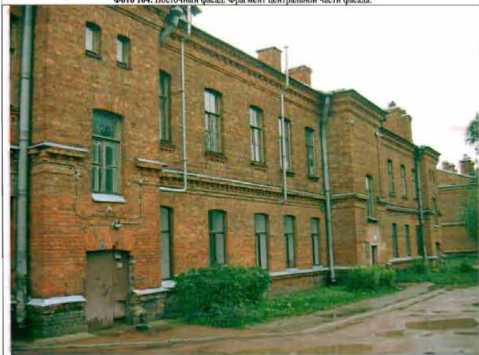
Фото 165. Западный фасад. Общий вид.
