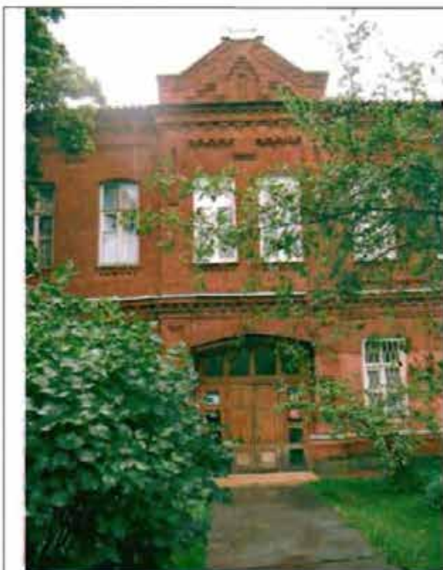
Фото 90. Восточный фасад. Центральная часть. Общий вид.
