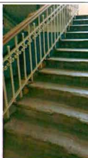
Фото 57. Лестница в центральной части здания. Фрагмент.
