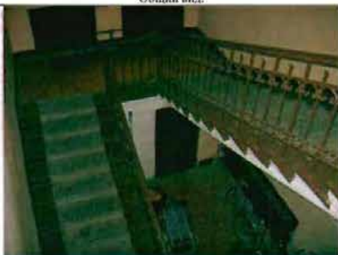
Фото 108. Парадная лестница в центральной части здания. Общий вид.
