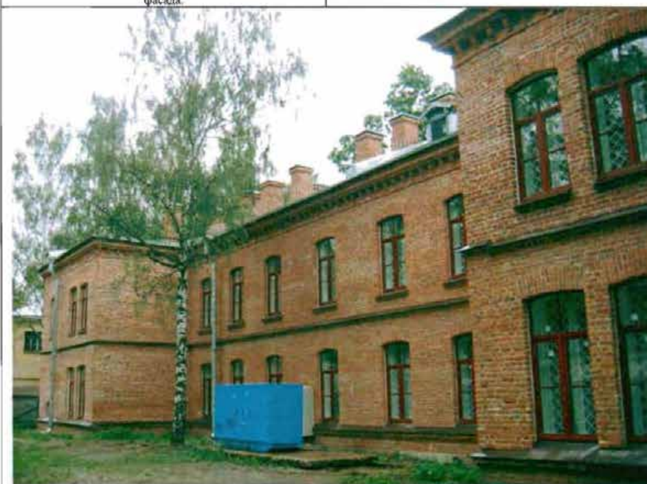
Фото 42. Западный фасад. Общий вид.
