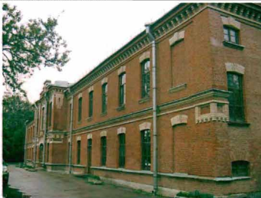
Фото 64. Северный фасад. Общий вид.
