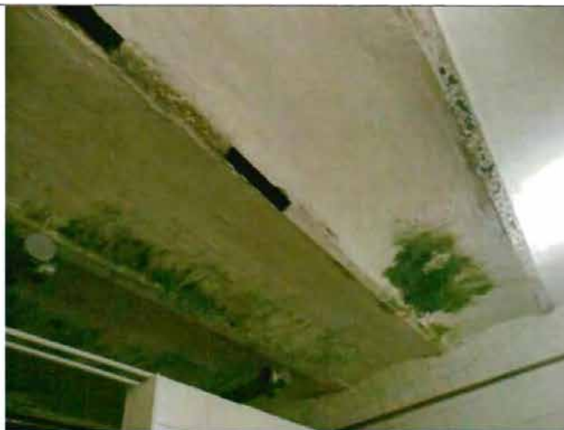
Своды по металлическим балкам. Съемка 27.11.2012, Воронина Н.В.
