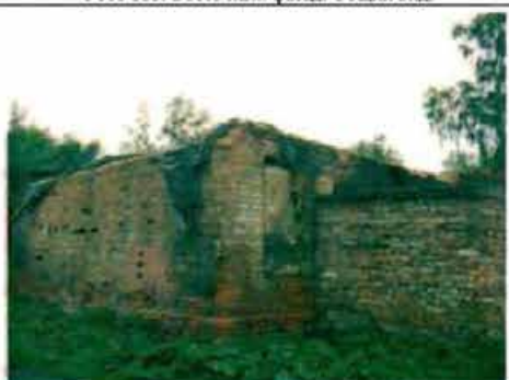
Фото 187. Северный фасад. Общий вид.
