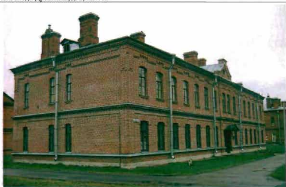
Фото 132. Западный, северный фасады. Общий вид.
