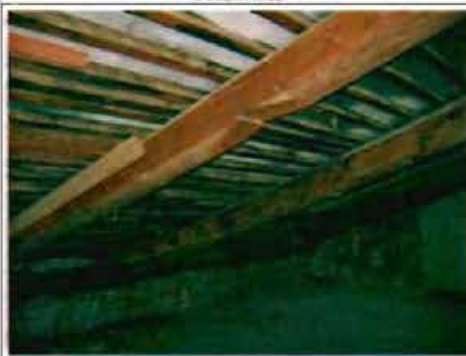
Фото 151. Конструкции крыши. Фрагмент.
