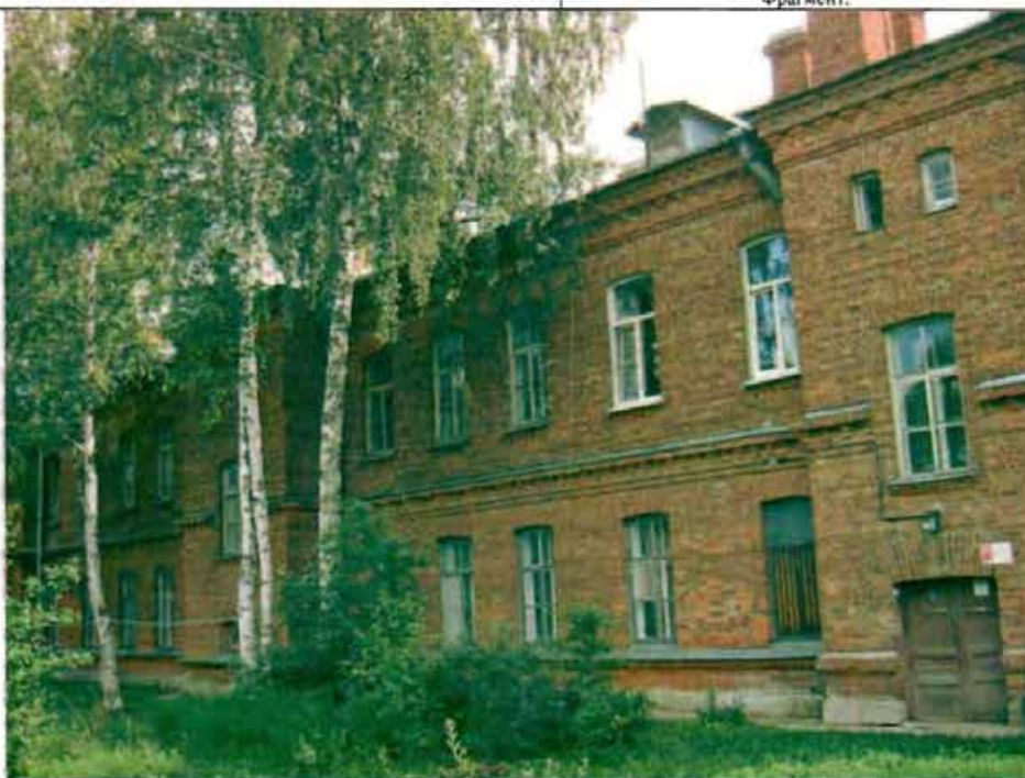
Фото 179. Западный фасад. Общий вид.
