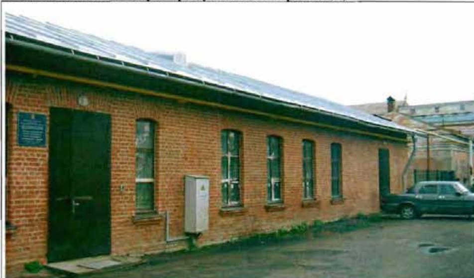
Фото 18. Западный фасад. Общий вид.
