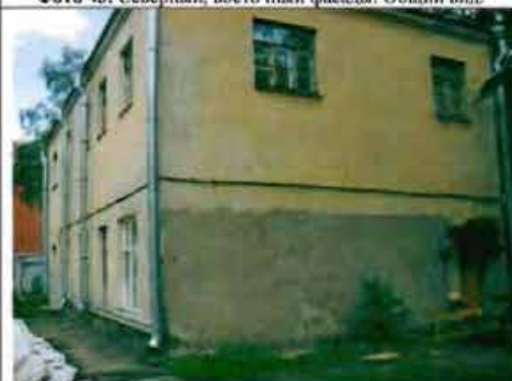
Фото 45. Южный, западный фасад. Общий вид.
