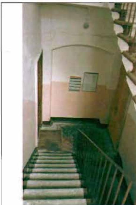
Фото 130. Лестница № 1 в южной части здания. Общий вид.
