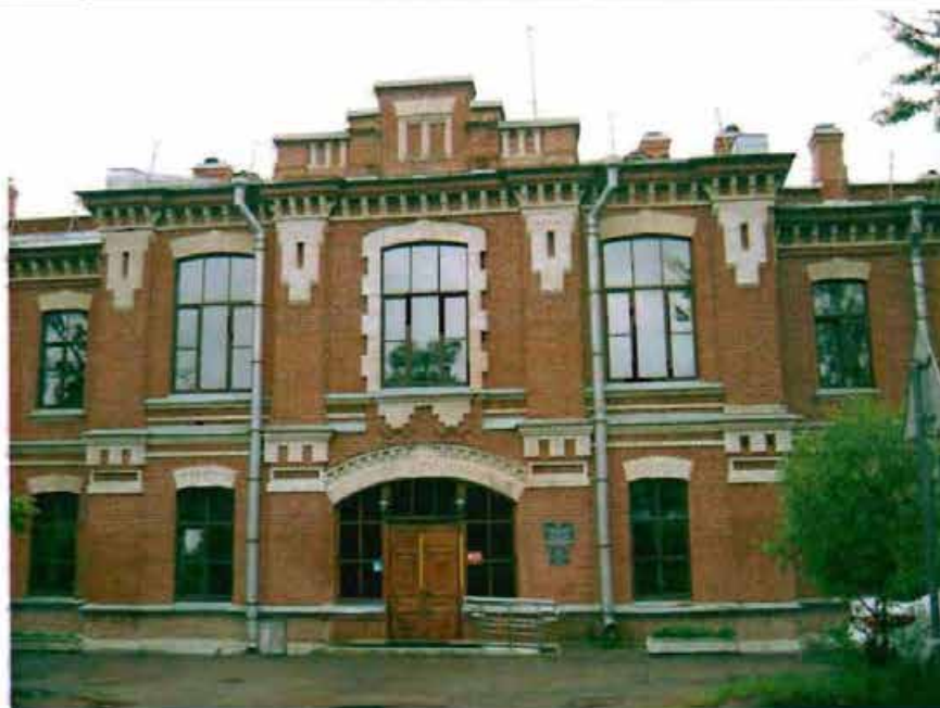
Фото 65. Северный фасад. Фрагмент центральной части фасада.
