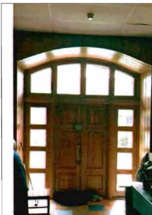
Фото 92. Помещение в уровне 1-го этажа.
