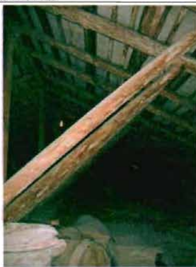
Фото 27. Конструкции крыши. Фрагмент.
