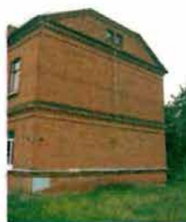
Фото 86. Западный фасад. Общий вид.
