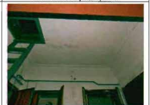
Фото 102. Отделка потолка тамбура. Общий вид.
