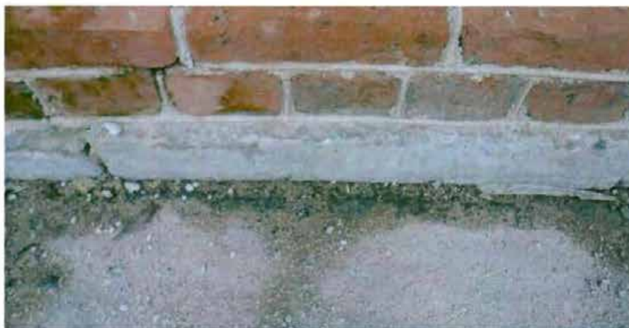
Цоколь, облицованный известняковой скобой. Съемка 20.11.2012, Воронина Н.В.
