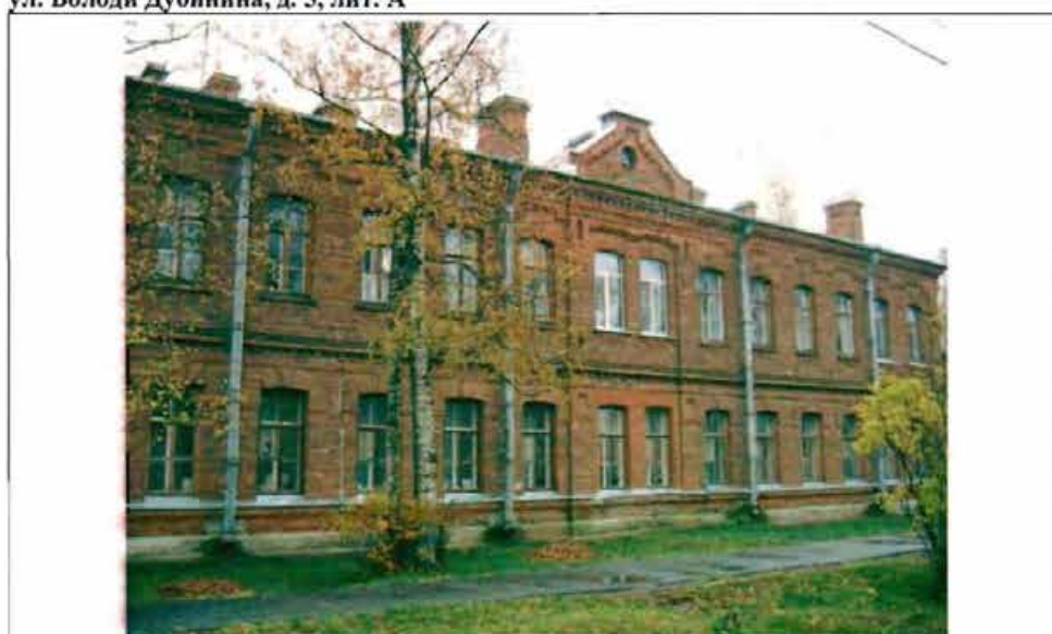
Фото 157. Западный фасад. Общий вид.
