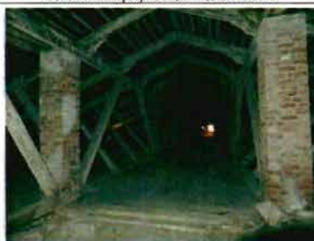
Фото 12. Конструкции крыши. Общий вид. 29.12.2015.
