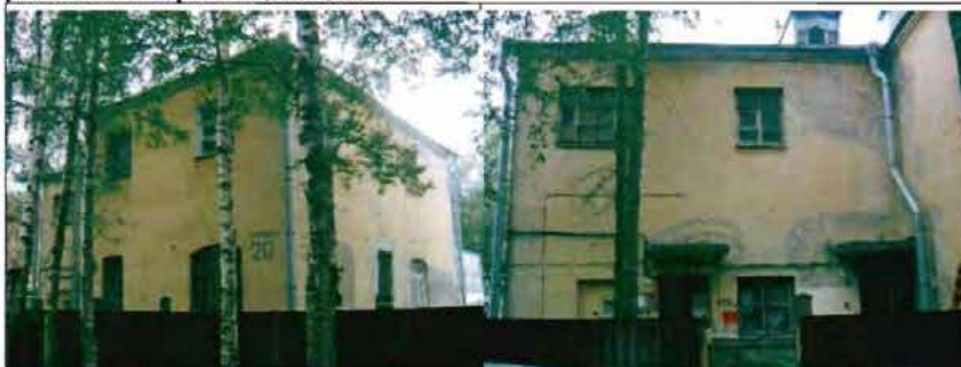
Фото 43. Северный, восточный фасады. Общий вид.
