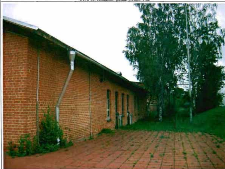
Фото 19. Восточный фасад. Общий вид.
