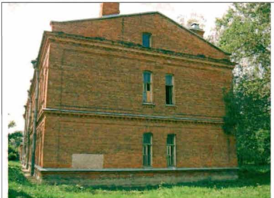
Фото 180. Северный фасад. Общий вид.
