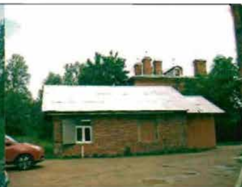
Фото 154. Южный фасад. Общий вид.
