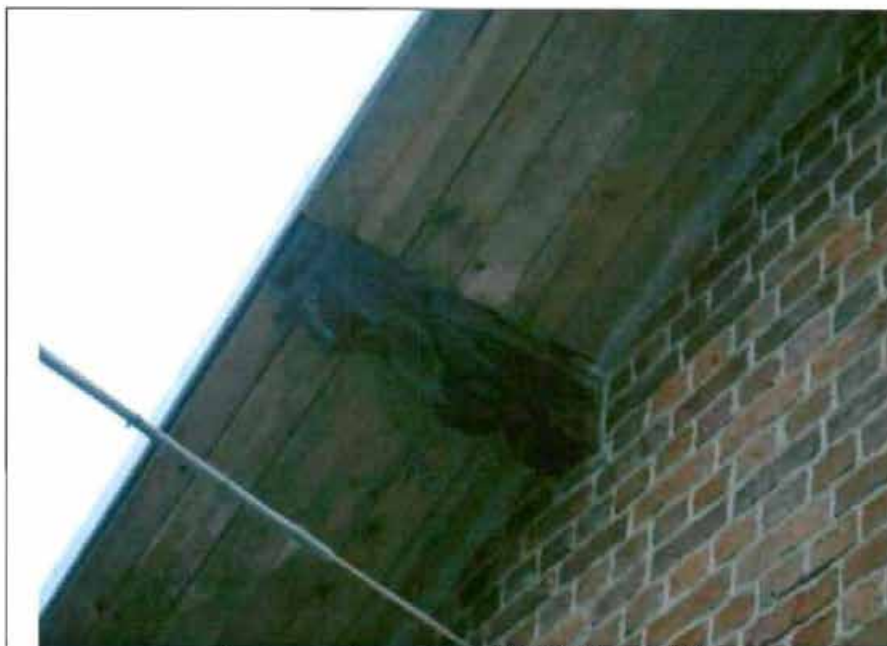
Деревянные кобылки. Съёмка 20.11.2012, Воронина Н.В.
