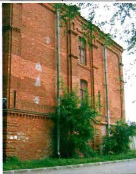
Фото 5. Южный фасад. Общий вид.
