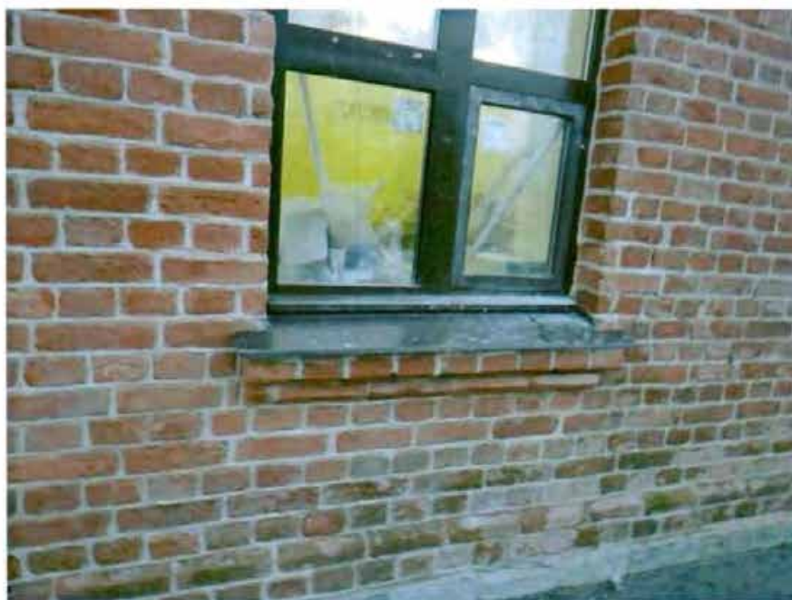
Ступенчатые подоконные доски. Съемка 20.11.2012, Воронина Н.В.
