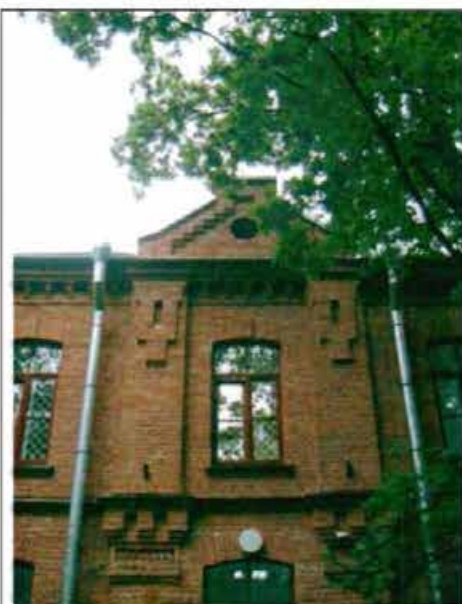
Фото 40. Восточный фасад. Фрагмент центральной части фасада.
