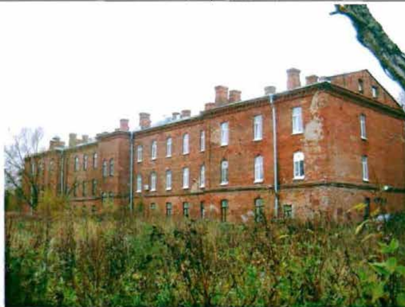
Фото 14. Восточный фасад. Общий вид.
