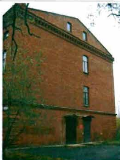
Фото 16. Южный фасад. Общий вид.
