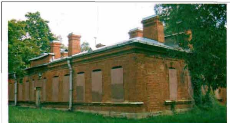
Фото 98. Западный фасад. Общий вид.
