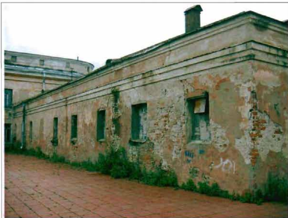
Фото 25. Восточный фасад. Общий вид.
