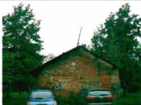
Фото 94. Восточный фасад. Общий вид.
