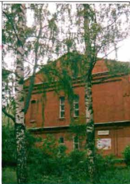
Фото 91. Северный фасад. Общий вид.
