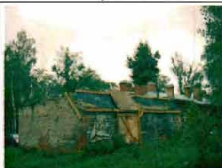
Фото 186. Западный, северный фасады. Общий вид.
