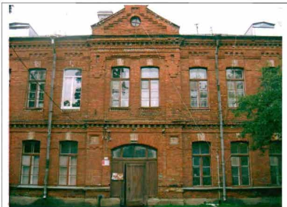
Фото 104. Восточный фасад. Центральная часть. Общий вид.
