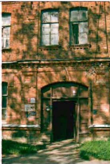
Фото 178. Восточный фасад. Центральная часть. Фрагмент.
