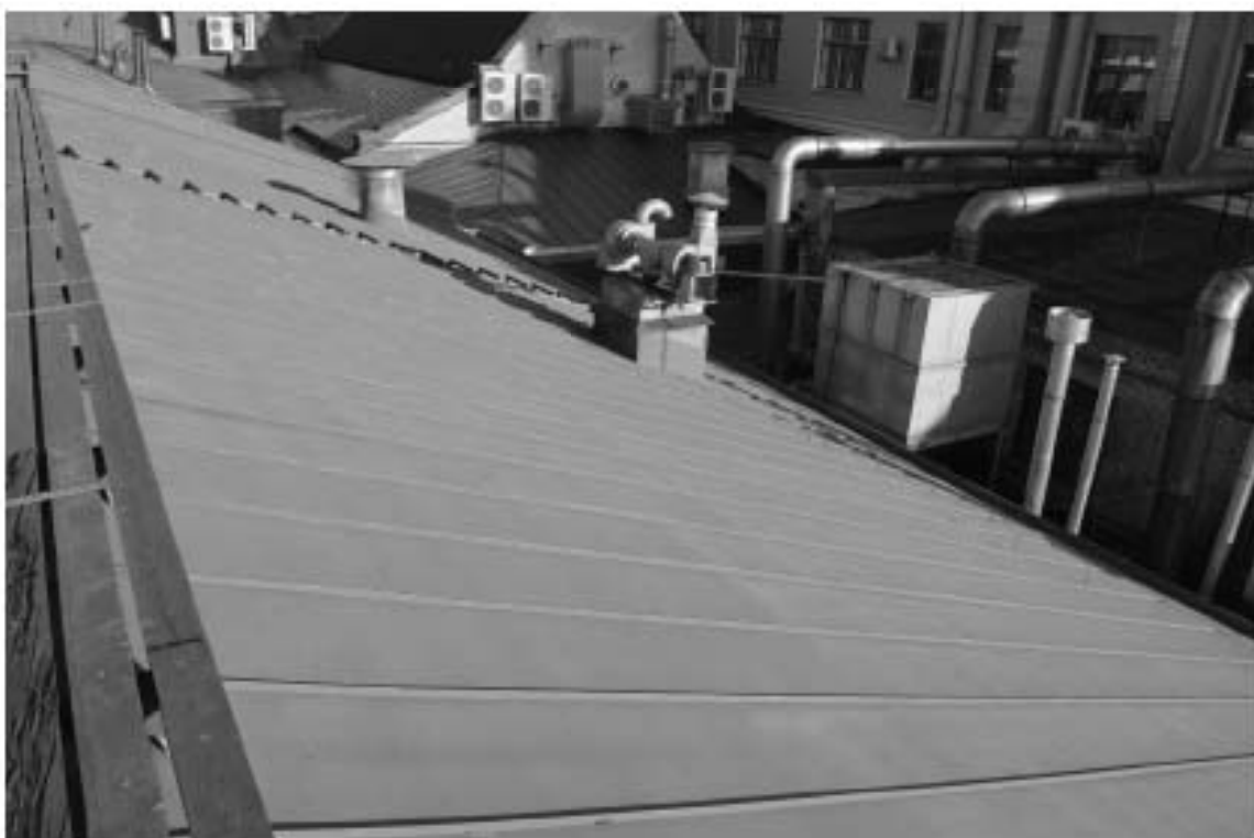
Фото 8. ОКН федерального значения «Монетный двор». Корпус № 5. Кровля. Общий вид. Съёмка 24.11.2022 г.
