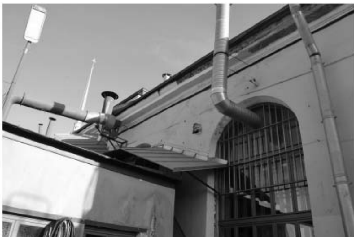
Фото 1. ОКН федерального значения «Монетный двор». Корпус № 5. Фасады. Фрагмент. Съёмка 24.11.2022 г.
