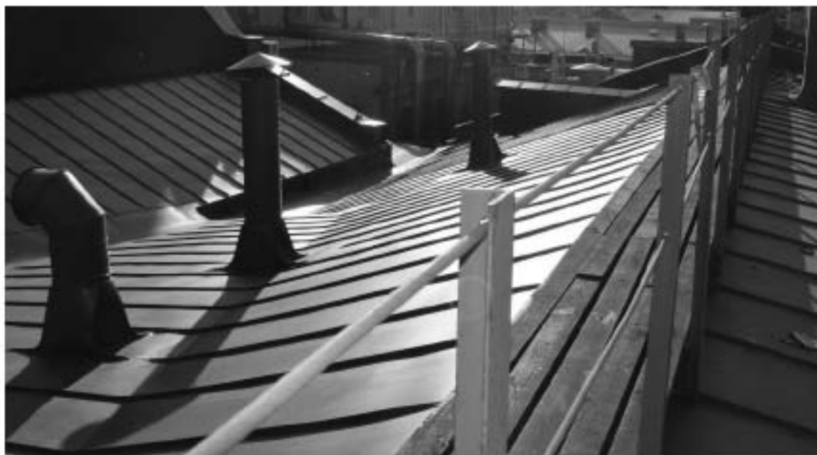
Фото 9. ОКН федерального значения «Монетный двор». Корпус № 5. Кровля. Общий вид. Съёмка 24.11.2022 г.
