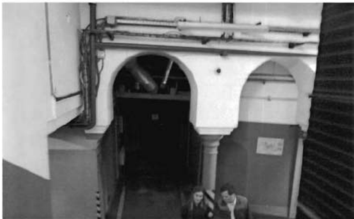
10. Арочное перекрытие центральной части вестибюля (корпус № 2).
