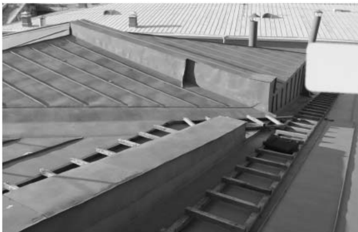
Фото 10. ОКН федерального значения «Монетный двор». Корпус № 5. Кровля. Фрагмент. Съёмка 24.11.2022 г.
