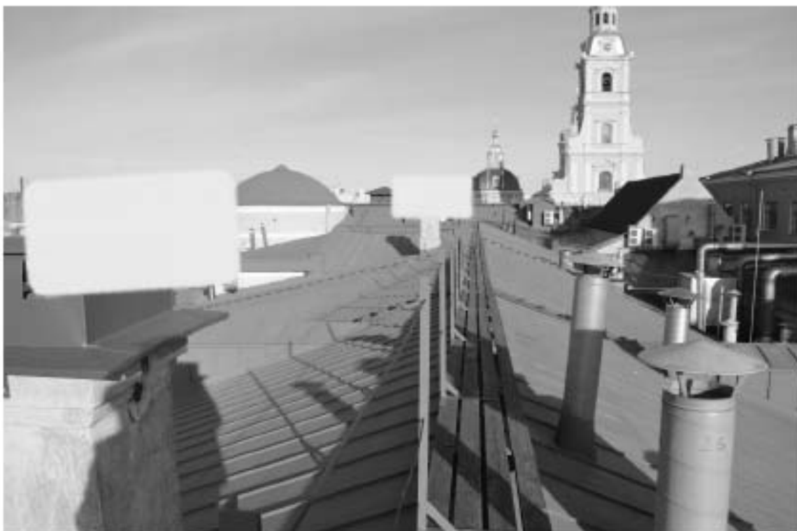
Фото 7. ОКН федерального значения «Монетный двор». Корпус № 5. Кровля. Общий вид. Съёмка 24.11.2022 г.
