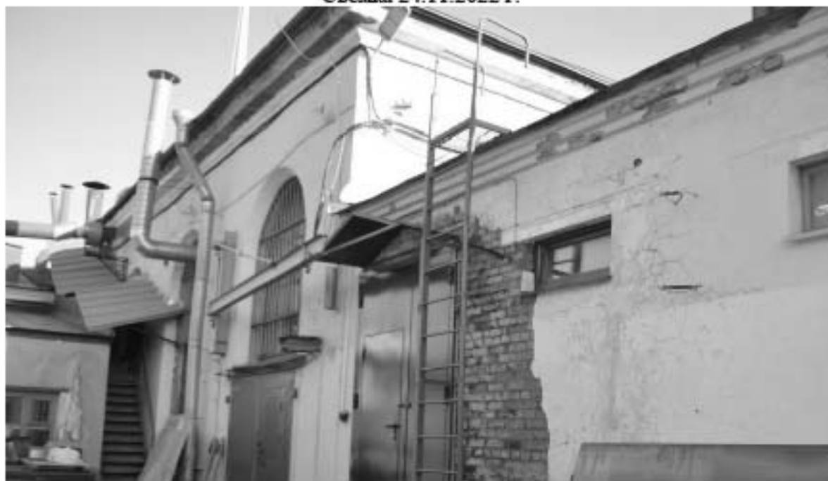
Фото 5. ОКН федерального значения «Монетный двор». Корпус № 5. Фасады. Фрагмент. Съёмка 24.11.2022 г.
