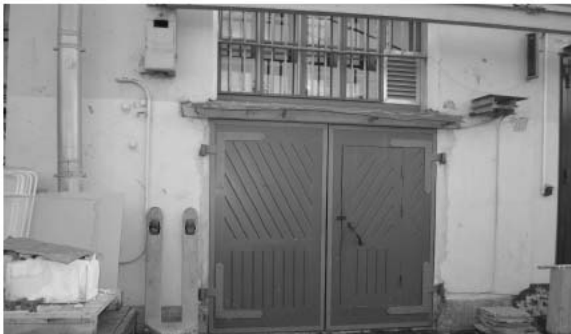
Фото 4. ОКН федерального значения «Монетный двор». Корпус № 5. Фасады. Фрагмент. Съёмка 24.11.2022 г.
