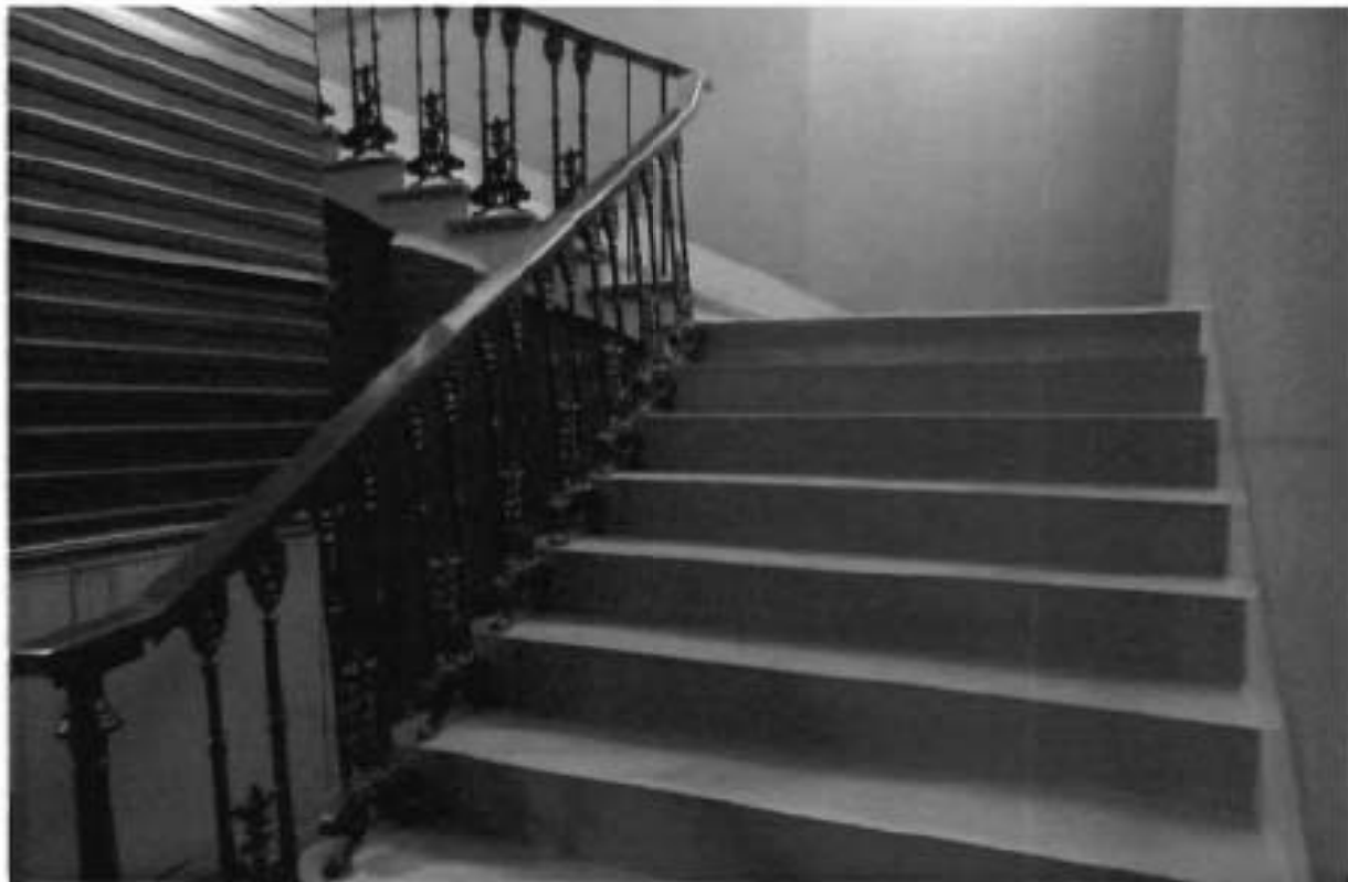
9. Историческая межэтажная лестница (корпус № 2).
