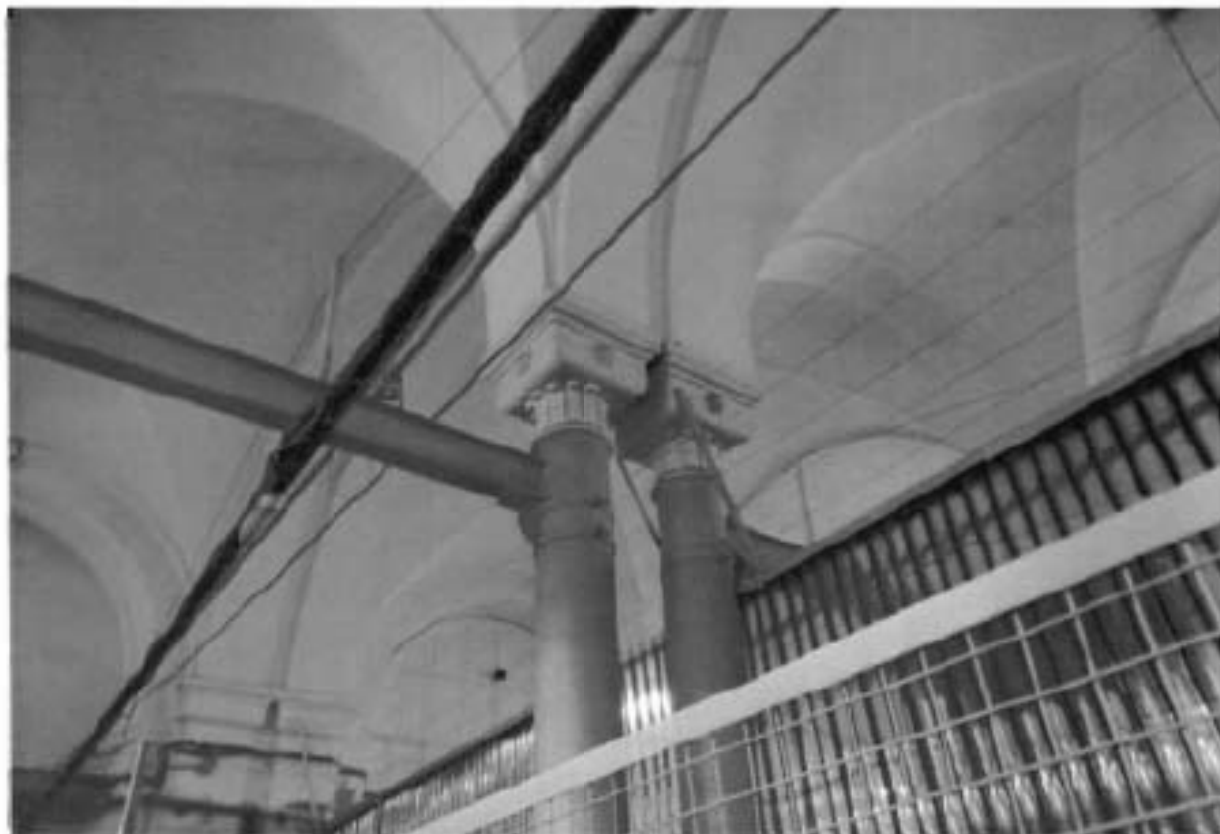
12. Чугунные опорные колонны (корпус № 3).
