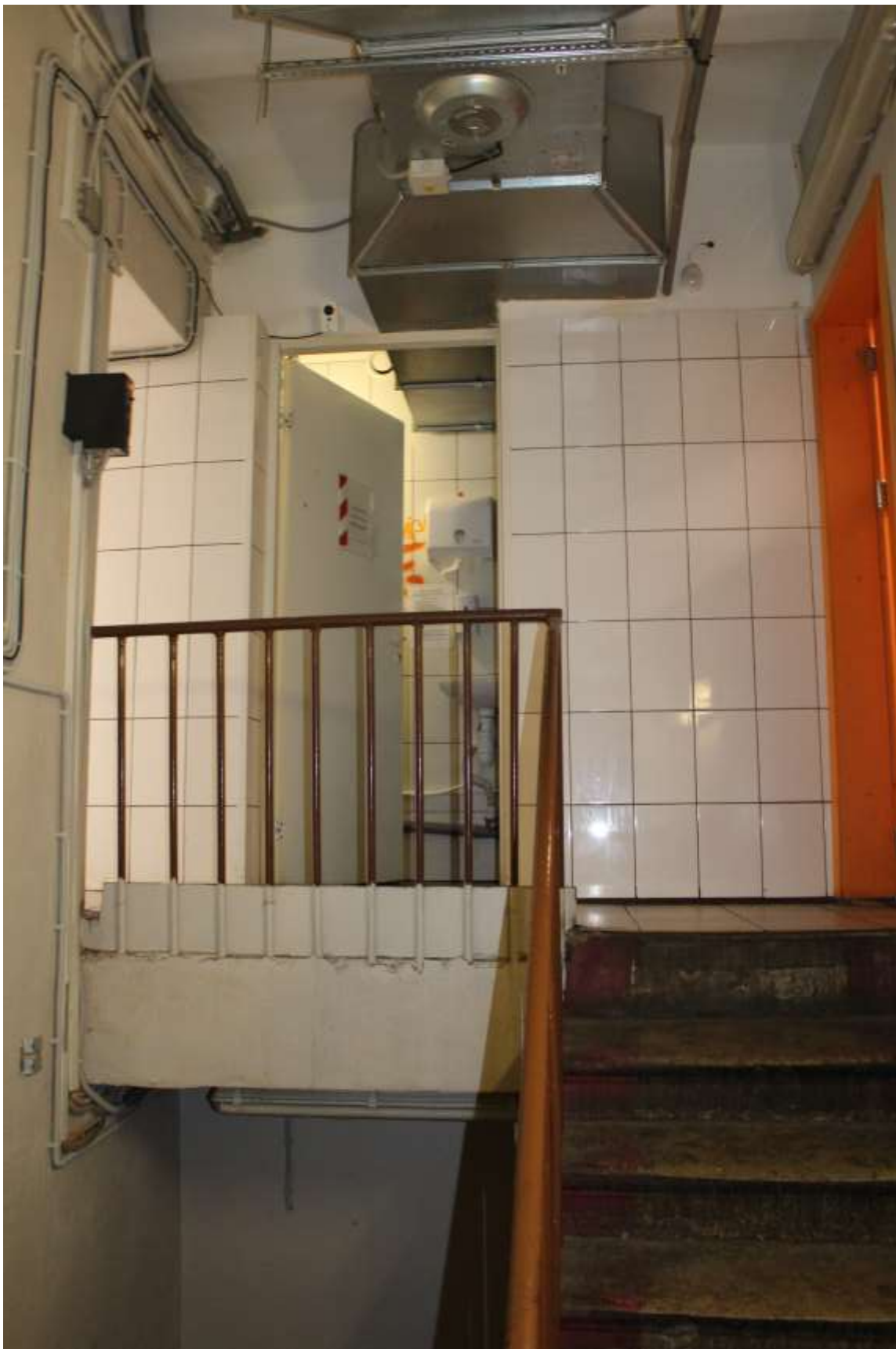
24. Помещение 1-Н. Служебная лестница (пом. № 9).
