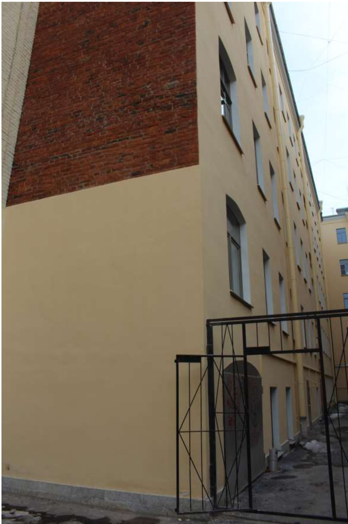
15. Вид на северную стену и западный фасад западного дворового корпуса объекта культурного наследия федерального значения «Дом, где в 1904-1905 гг. жил писатель Горький А.М. и в ноябре-декабре 1905 г. состоялись совещания ЦК РСДРП(б) о вооруженном восстании в Москве».
