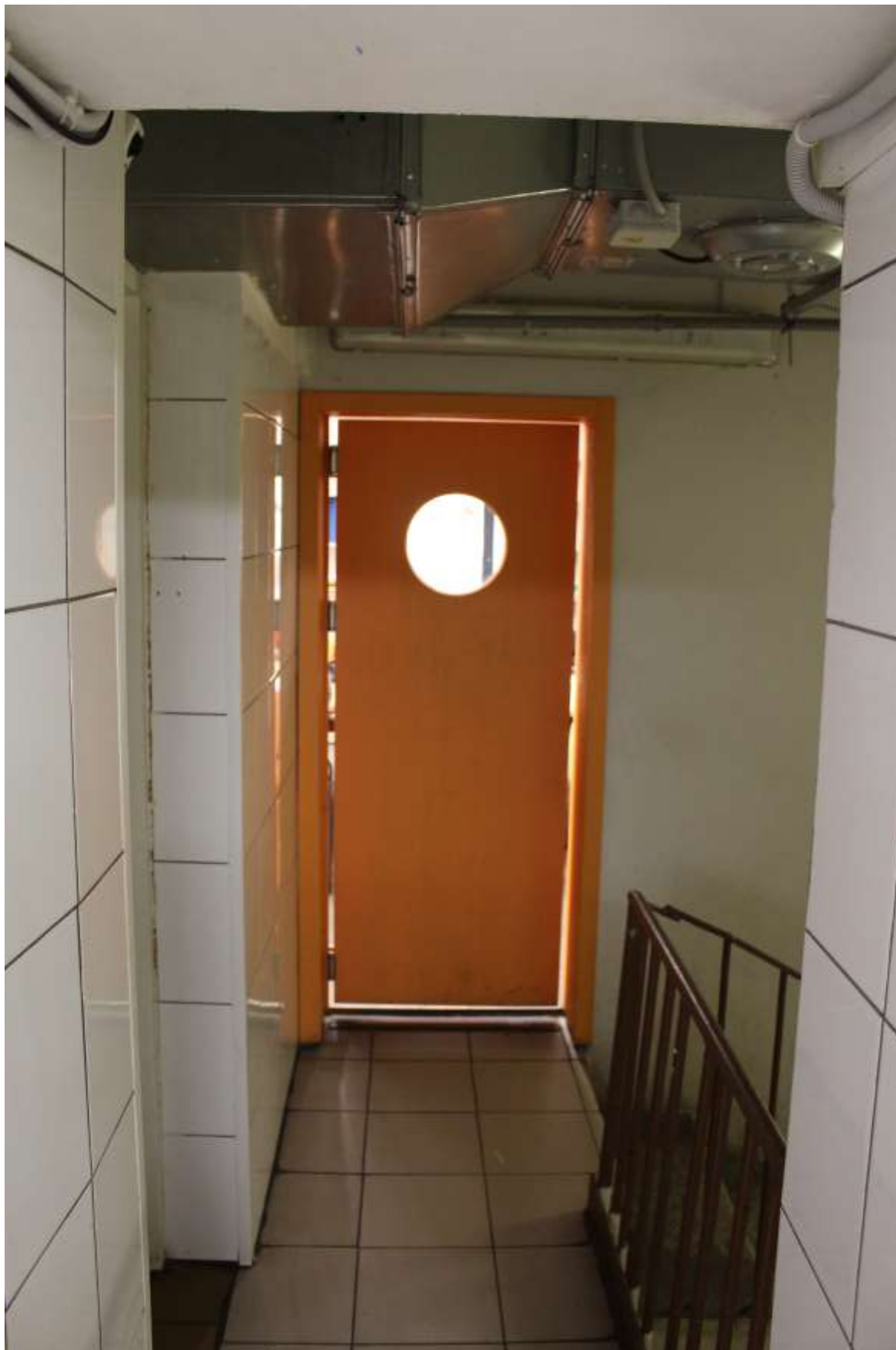
22. Помещение 1-Н. Служебная лестница (пом. № 9).
