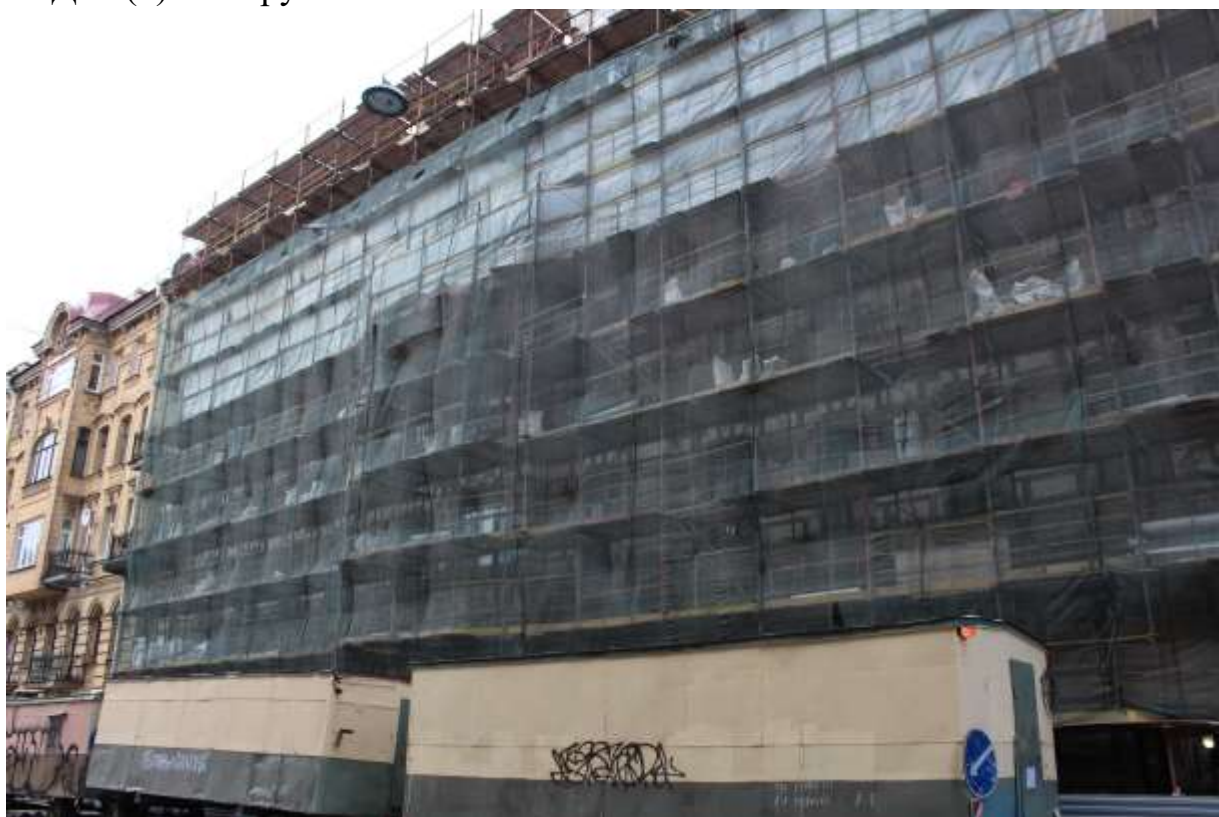
6. Вид на южный фасад западного лицевого корпуса объекта культурного наследия федерального значения «Дом, где в 1904-1905 гг. жил писатель Горький А.М. и в ноябре-декабре 1905 г. состоялись совещания ЦК РСДРП(б) о вооруженном восстании в Москве».
