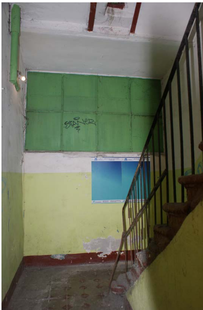
Фото 121. Лестница № 4. 1-й этаж. Съемка 19.04.2021 г. Кириков Б. М.
