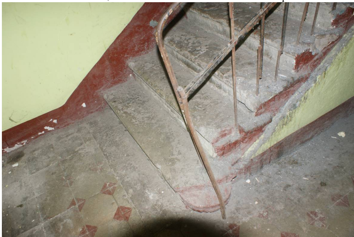
Фото 122. Лестница № 4. 1-й этаж. Ступени лестничного марша. Съемка 19.04.2021 г. Кириков Б. М.
