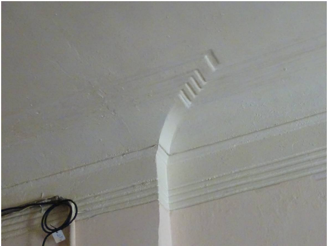
Фото 68. Лестница № 2. 6-й этаж. Оформление стен. Съемка 19.04.2021 г. Кириков Б. М.
