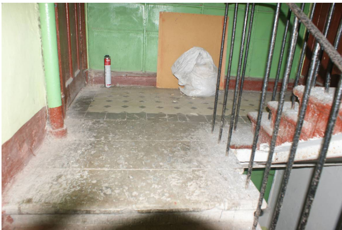
Фото 128. Лестница № 4. 2-й этаж. Съемка 19.04.2021 г. Кириков Б. М.
