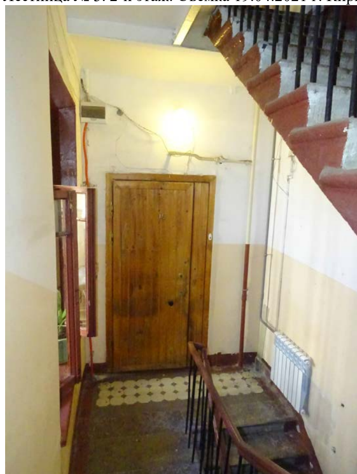
Фото 90. Лестница № 3. 3-й этаж. Съемка 19.04.2021 г. Кириков Б. М.
