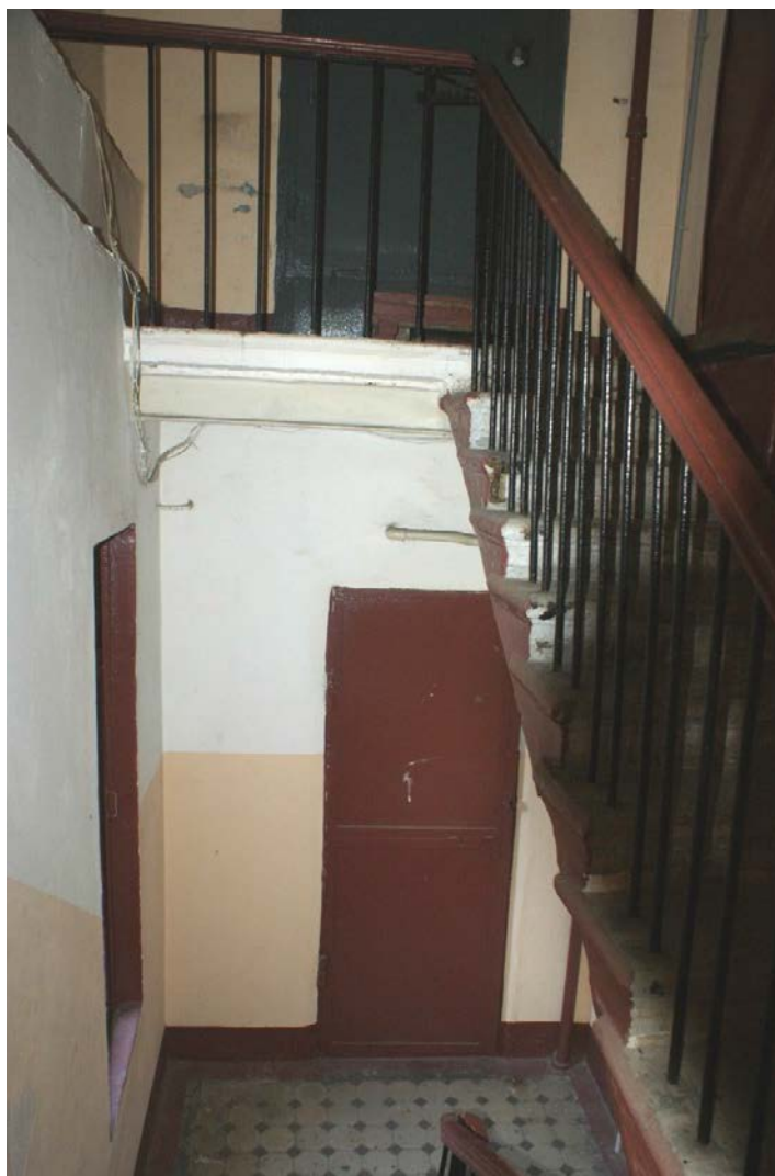
Фото 111. Лестница № 3. 6-й этаж. Съемка 19.04.2021 г. Кириков Б. М.
