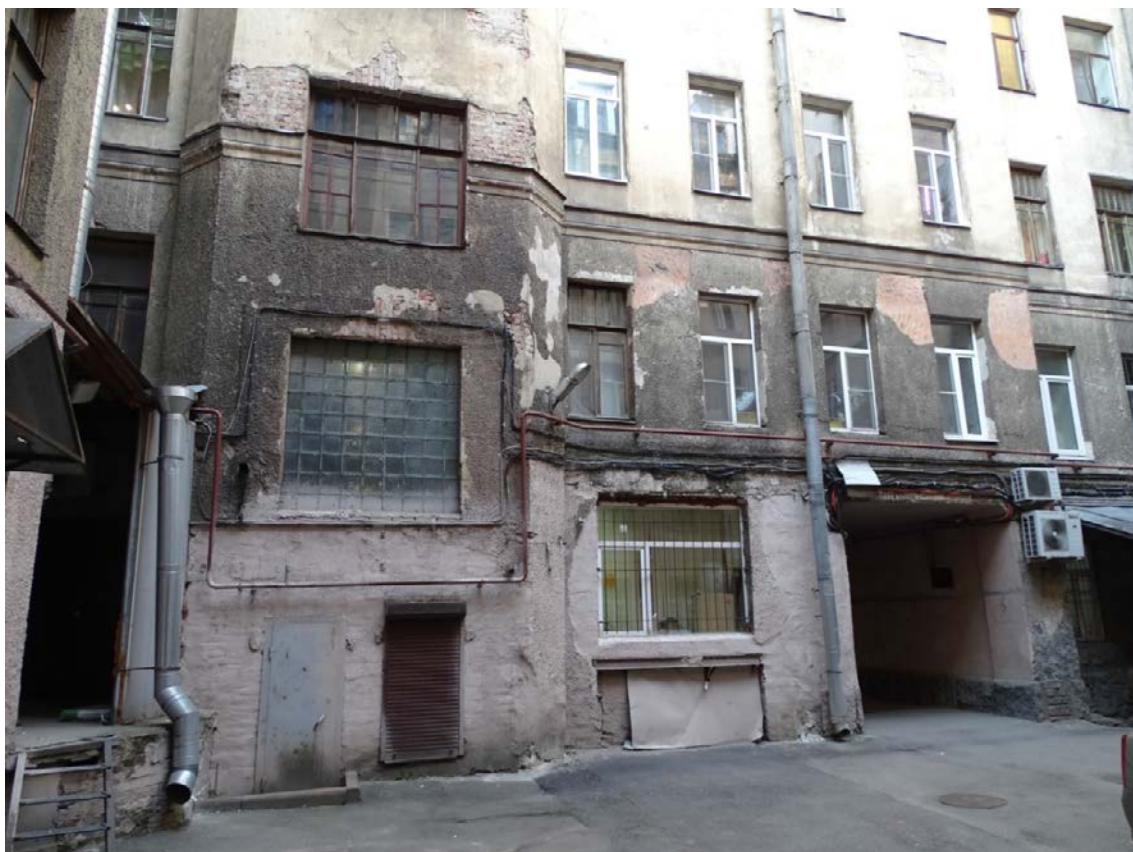
Фото 37. Здание по адресу: г. Санкт-Петербург, 11-я линия В. О., 34/47, литера А. Фрагмент восточного дворового фасада. Съемка 19.04.2021 г. Кириков Б. М.
