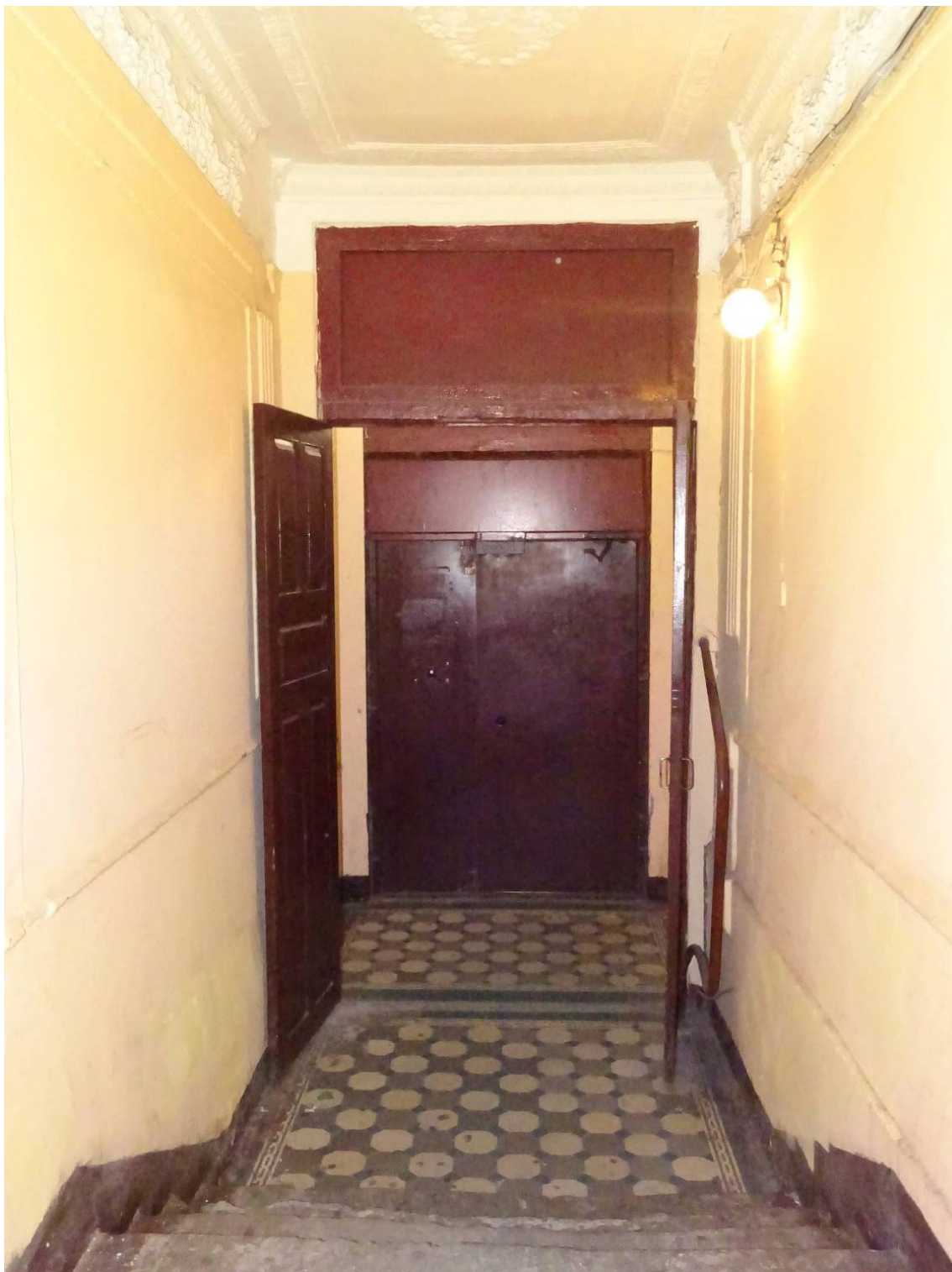
Фото 1. Лестница № 1. 1-й этаж. Съемка 19.04.2021 г. Кириков Б. М.
