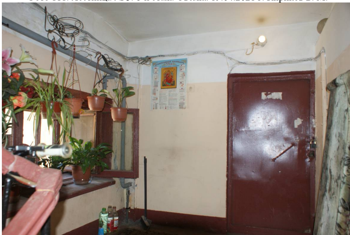
Фото 112. Лестница № 3. 7-й этаж. Покрытие пола. Съемка 19.04.2021 г. Кириков Б. М.
