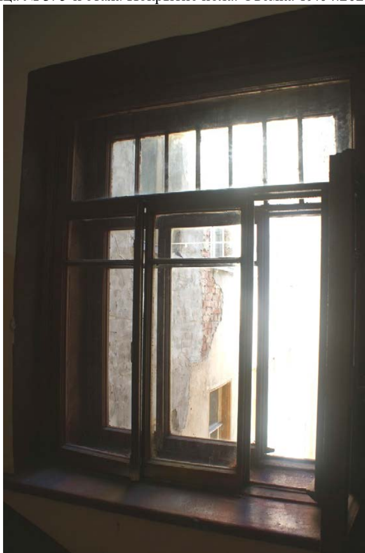
Фото 104. Лестница № 3. 5-й этаж. Съёмка 19.04.2021 г. Кириков Б. М.
