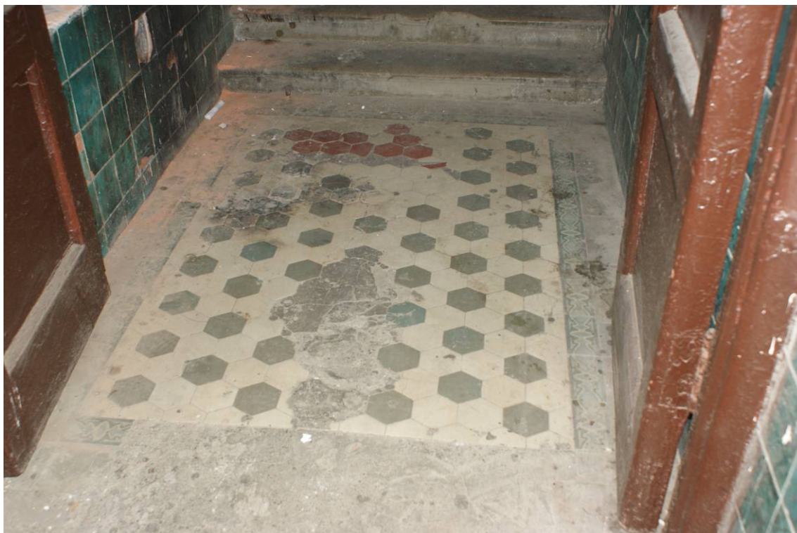
Фото 39. Лестница № 2. 1-й этаж. Вестибюль. Покрытие пола. Съемка 19.04.2021 г. Кириков Б. М.
