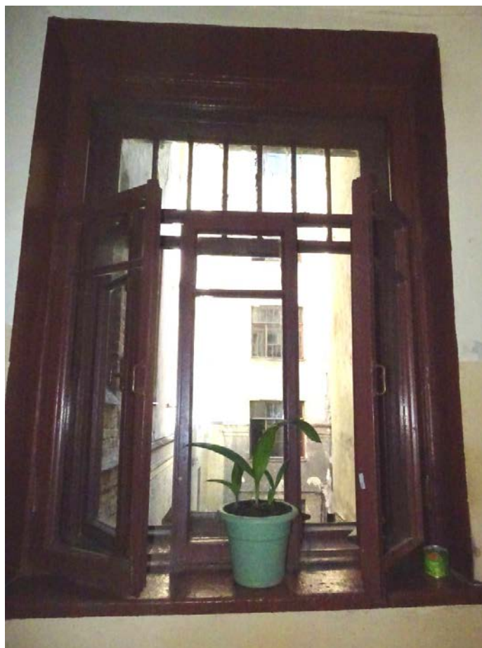
Фото 91. Лестница № 3. 3-й этаж. Съемка 19.04.2021 г. Кириков Б. М.
