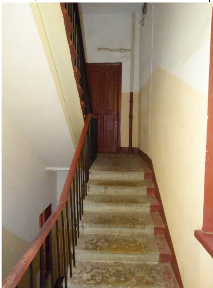
Фото 92. Лестница № 3. 3-й этаж. Съемка 19.04.2021 г. Кириков Б. М.
