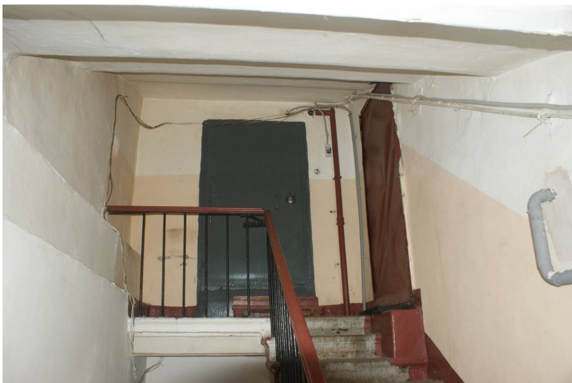
Фото 116. Лестница № 3. Чердачный этаж. Покрытие пола. Съемка 19.04.2021 г. Кириков Б. М.
