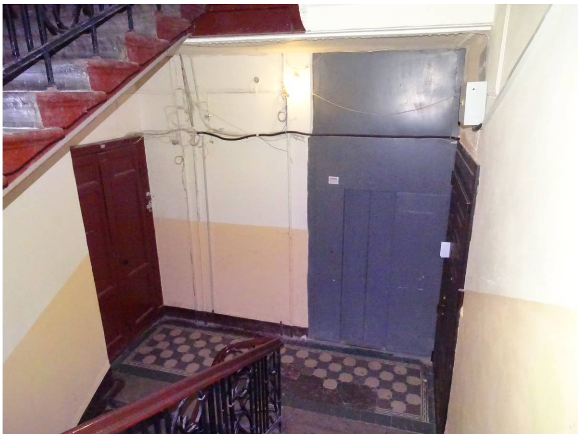
Фото 27. Лестница № 1. 4-й этаж. Съемка 19.04.2021 г. Кириков Б. М.
