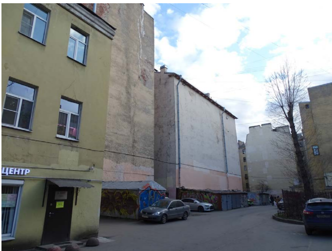
Фото 28. Здание по адресу: г. Санкт-Петербург, 11-я линия В. О., 34/47, литера А. Дворовые фасады. Съемка 19.04.2021 г. Кириков Б. М.
