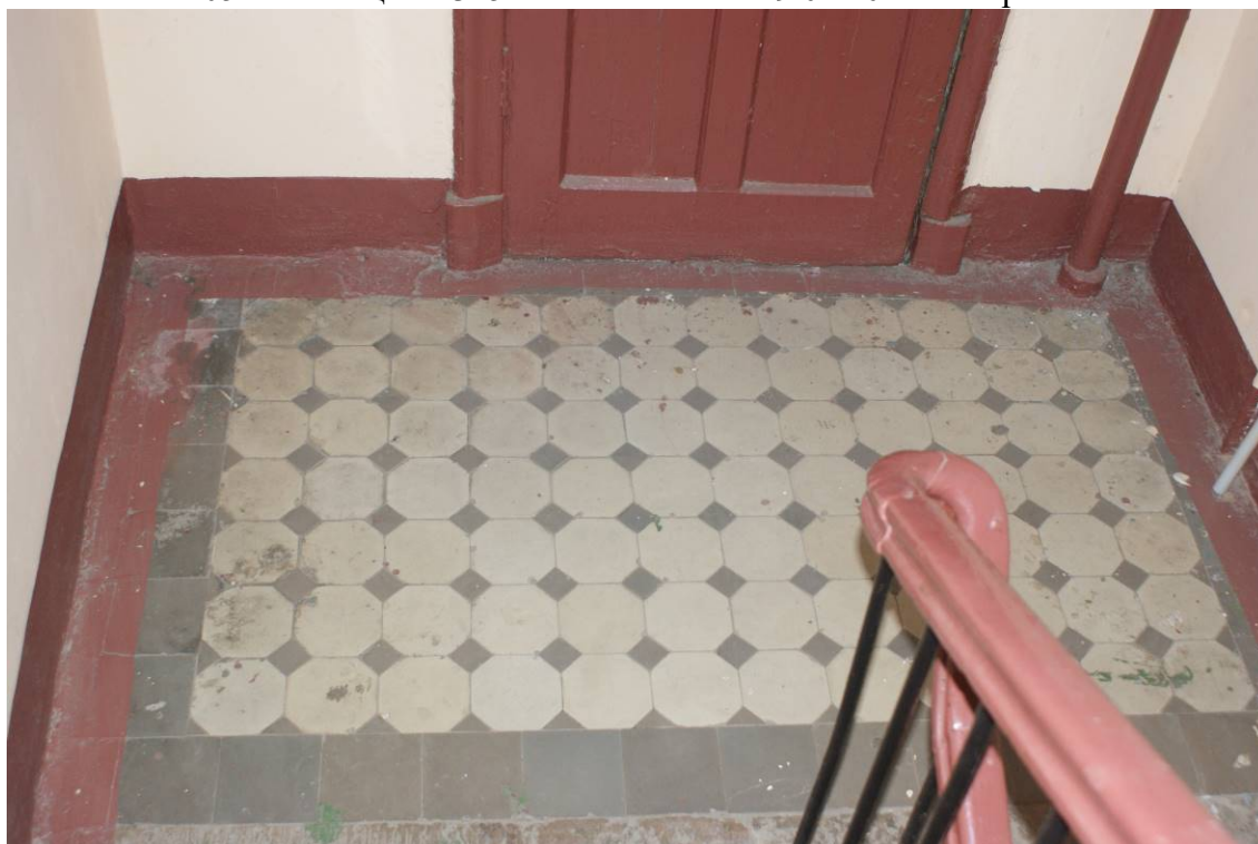
Фото 106. Лестница № 3. 5-й этаж. Покрытие пола. Съемка 19.04.2021 г. Кириков Б. М.
