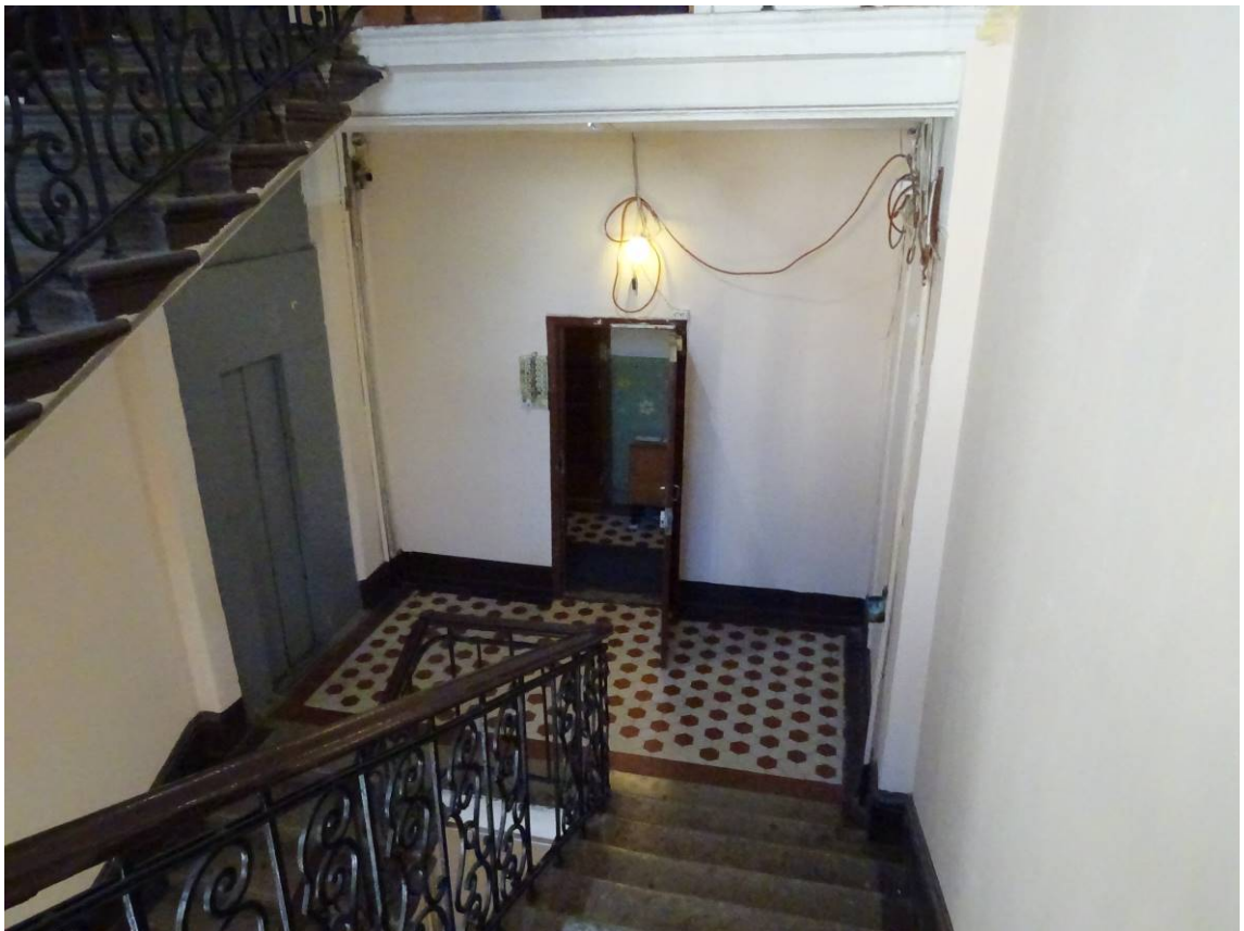
Фото 61. Лестница № 2. 5-й этаж. Съемка 19.04.2021 г. Кириков Б. М.
