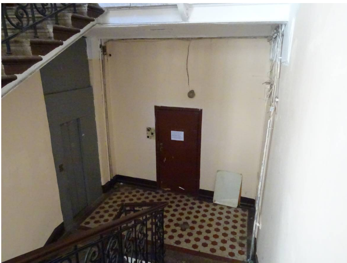
Фото 55. Лестница № 2. 3-й этаж. Съемка 19.04.2021 г. Кириков Б. М.
