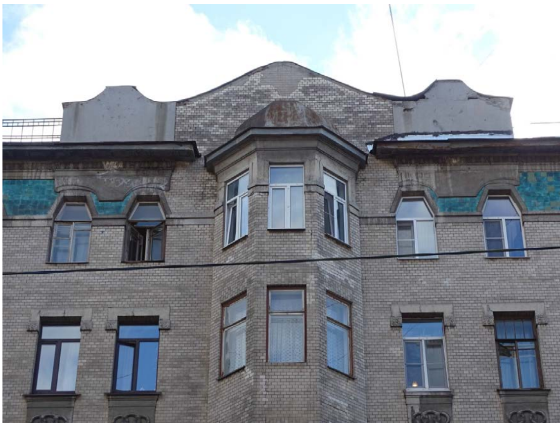
Фото 7. Здание по адресу: г. Санкт-Петербург, 11-я линия В. О., 34/47, литера А. Фрагмент фасада по 11-й линии. Съемка 19.04.2021 г. Кириков Б. М.
