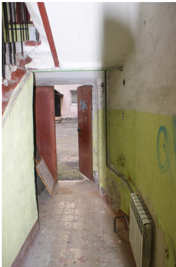
Фото 119. Лестница № 4. 1-й этаж. Вход. Съемка 19.04.2021 г. Кириков Б. М.
