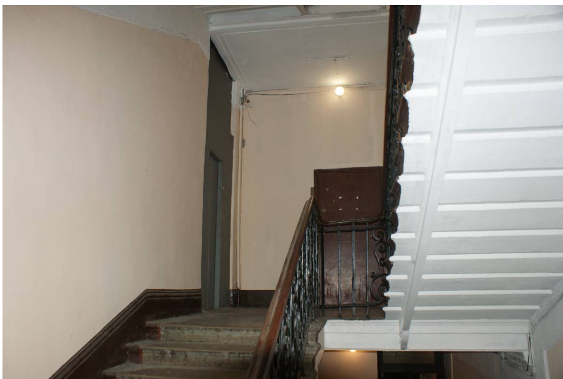
Фото 49. Лестница № 2. 2-й этаж. Съемка 19.04.2021 г. Кириков Б. М.
