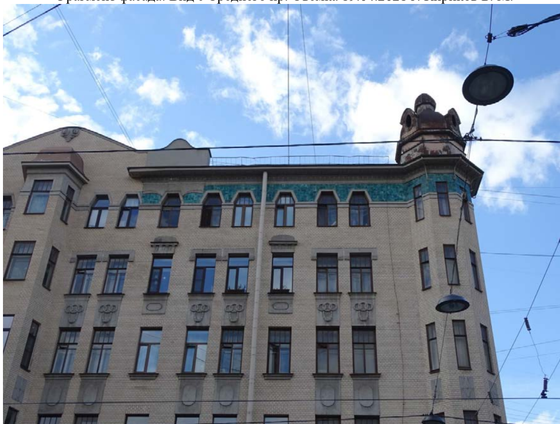
Фото 16. Здание по адресу: г. Санкт-Петербург, 11-я линия В. О., 34/47, литера А. Фрагмент фасада. Вид с Среднего пр. Съемка 19.04.2021 г. Кириков Б. М.
