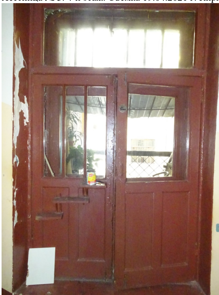
Фото 98. Лестница № 3. 4-й этаж. Съемка 19.04.2021 г. Кириков Б. М.
