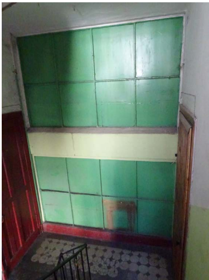
Фото 137. Лестница № 4. 4-й этаж. Съемка 19.04.2021 г. Кириков Б. М.
