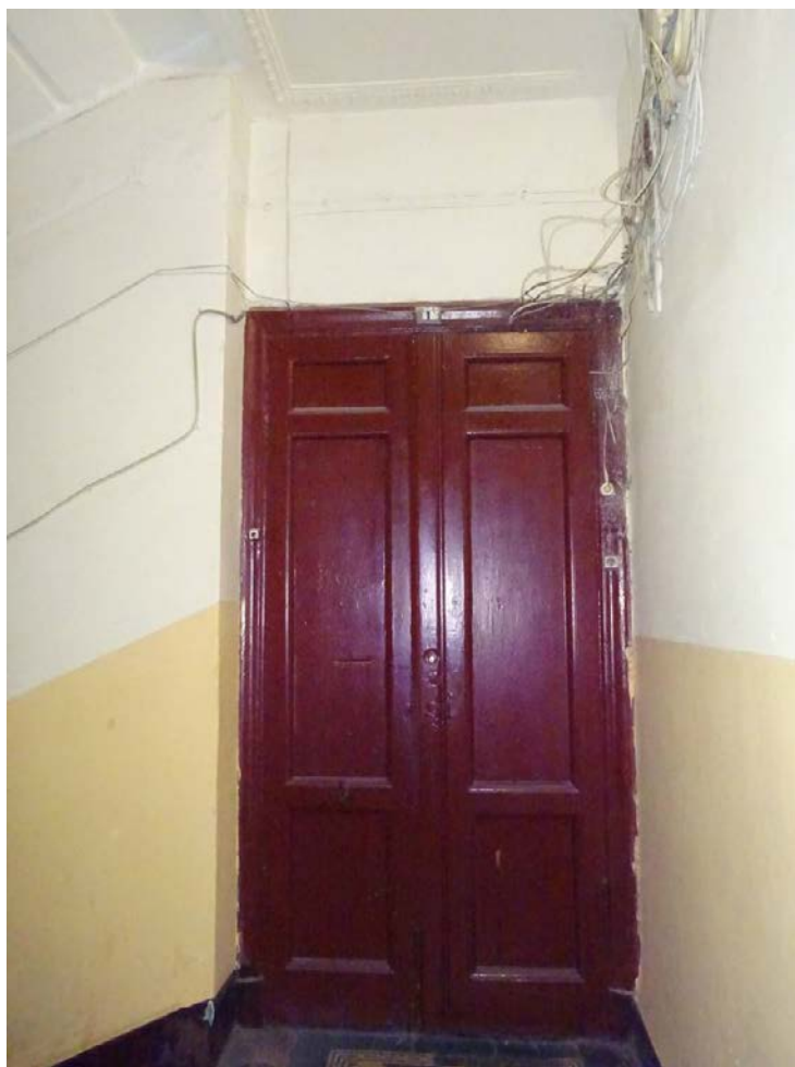
Фото 21. Лестница № 1. 2-й этаж. Съёмка 19.04.2021 г. Кириков Б. М.
