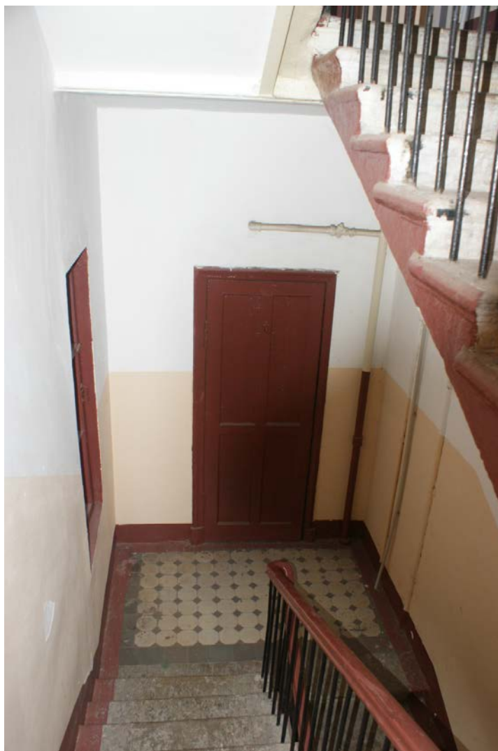
Фото 105. Лестница № 3. 5-й этаж. Съемка 19.04.2021 г. Кириков Б. М.
