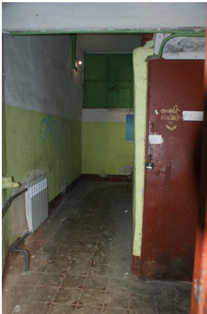
Фото 117. Лестница № 4. 1-й этаж. Съемка 19.04.2021 г. Кириков Б. М.
