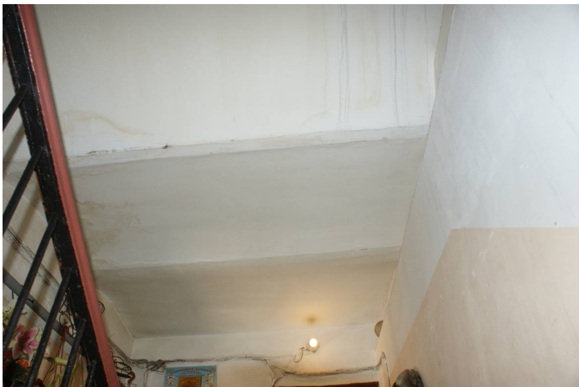
Фото 115. Лестница № 3. 7-й этаж. Своды. Съемка 19.04.2021 г. Кириков Б. М.
