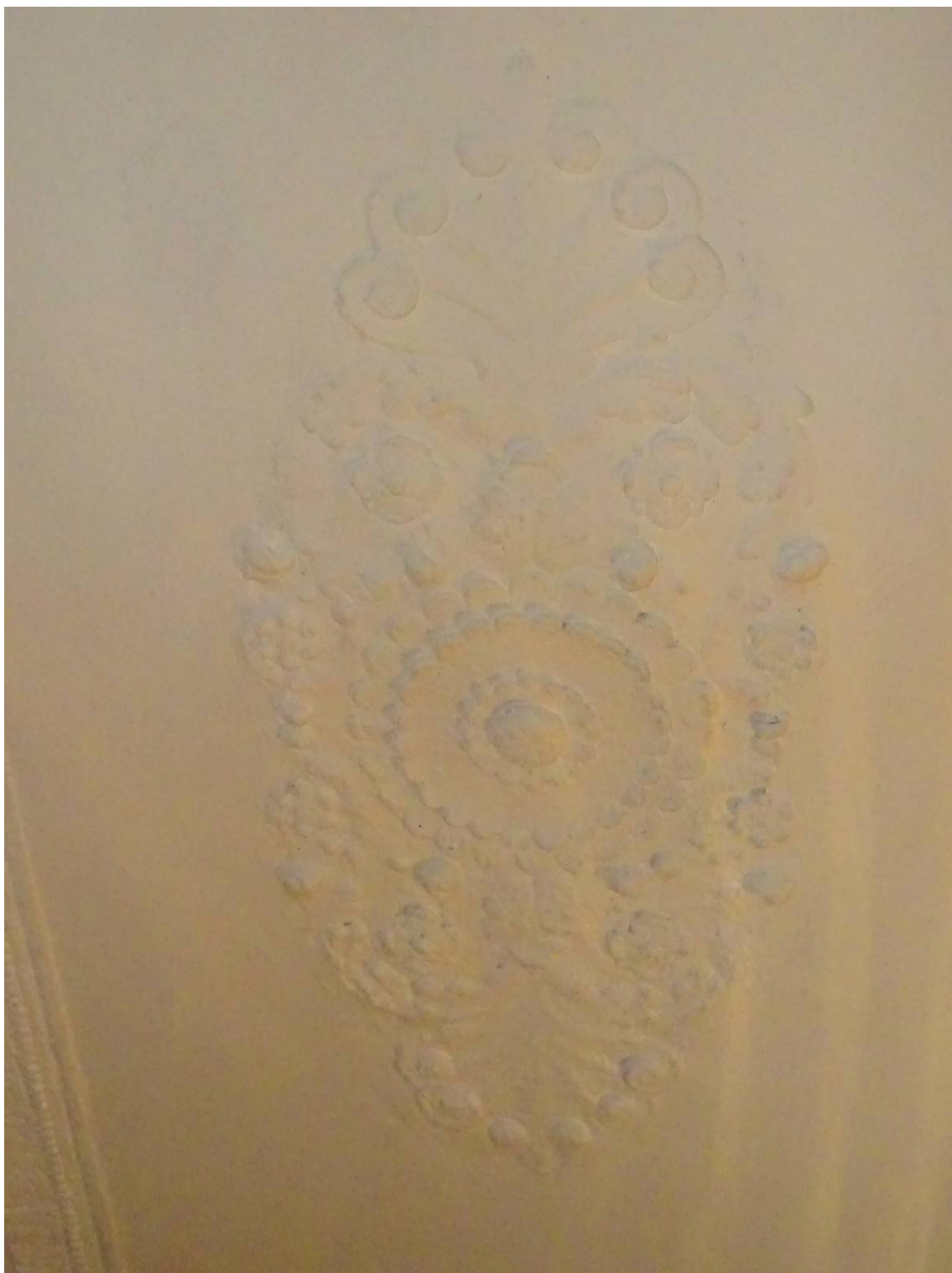
Фото 10. Лестница № 1. 1-й этаж. Вестибюль. Розетка. Съемка 19.04.2021 г. Кириков Б. М.
