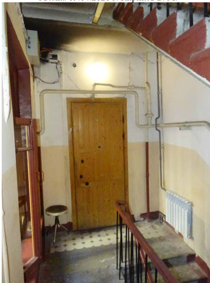
Фото 82. Лестница № 3. 2-й этаж. Съемка 19.04.2021 г. Кириков Б. М.
