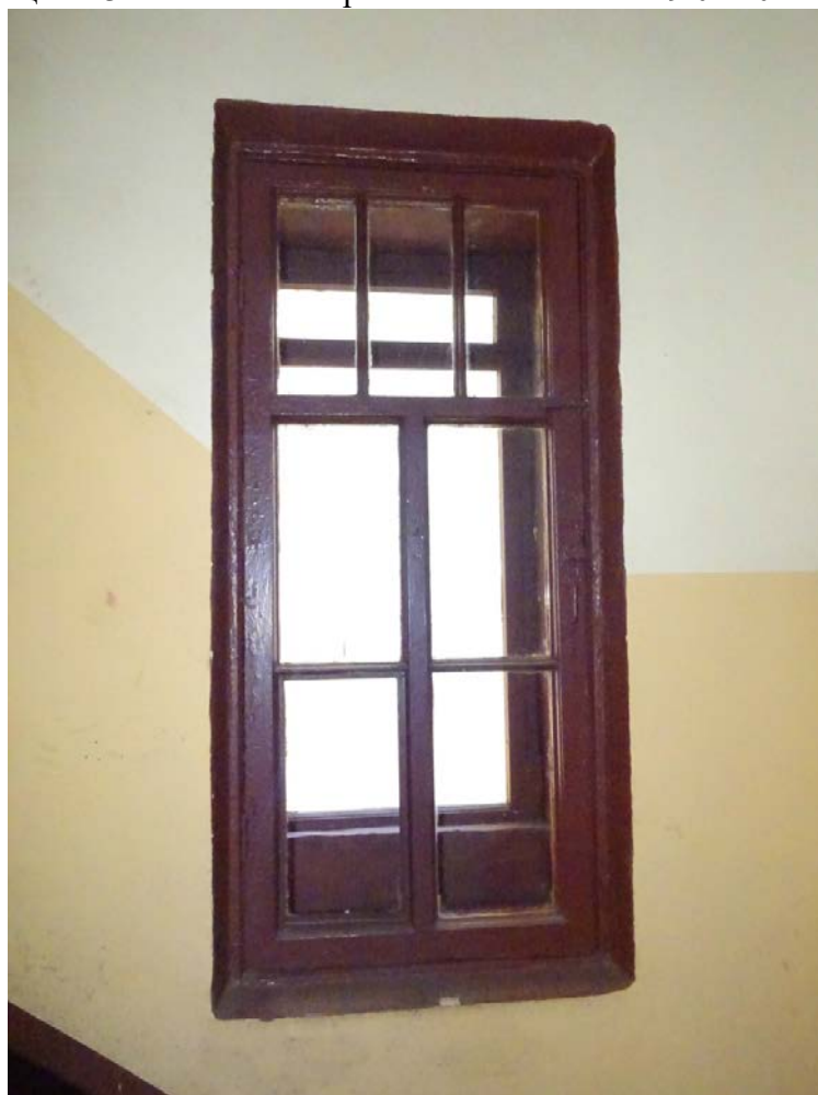
Фото 88. Лестница № 3. 2-й этаж. Съёмка 19.04.2021 г. Кириков Б. М.
