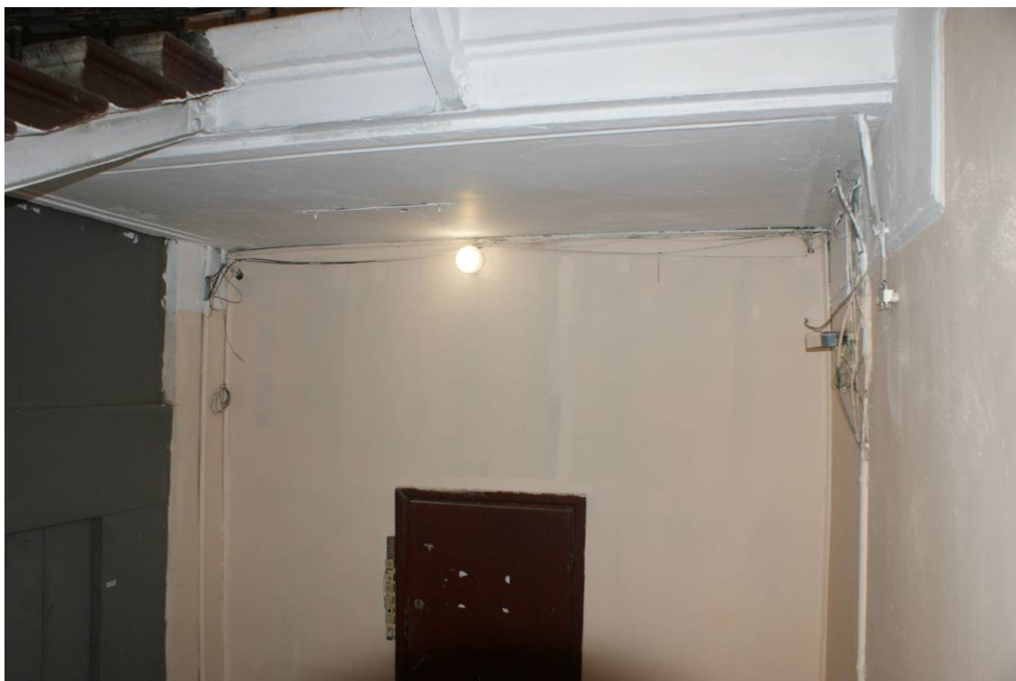
Фото 50. Лестница № 2. 2-й этаж. Съемка 19.04.2021 г. Кириков Б. М.
