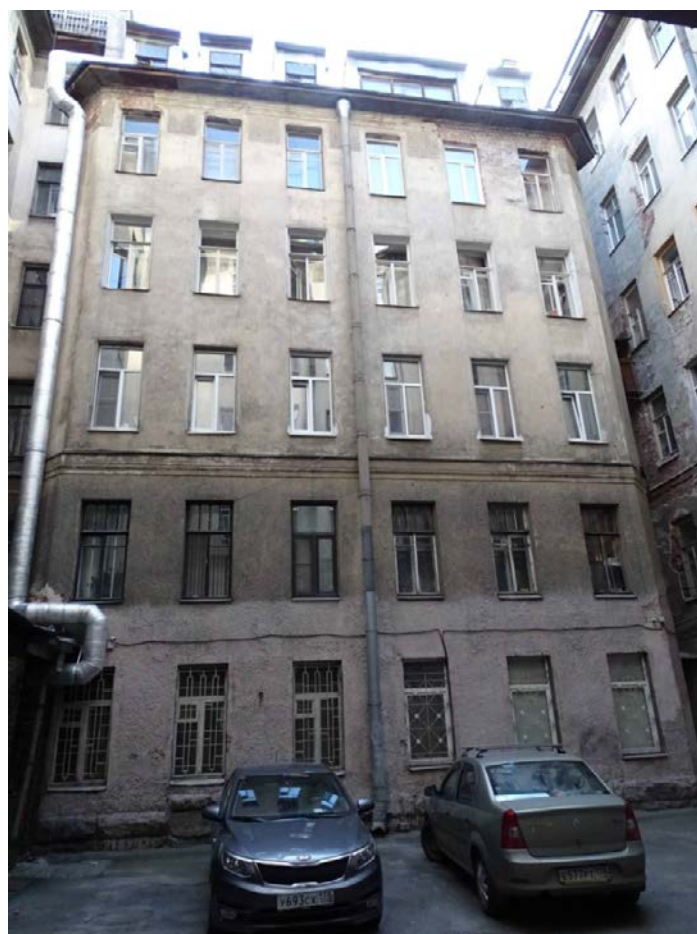
Фото 31. Здание по адресу: г. Санкт-Петербург, 11-я линия В. О., 34/47, литера А. Западный дворовый фасад. Съемка 19.04.2021 г. Кириков Б. М.
