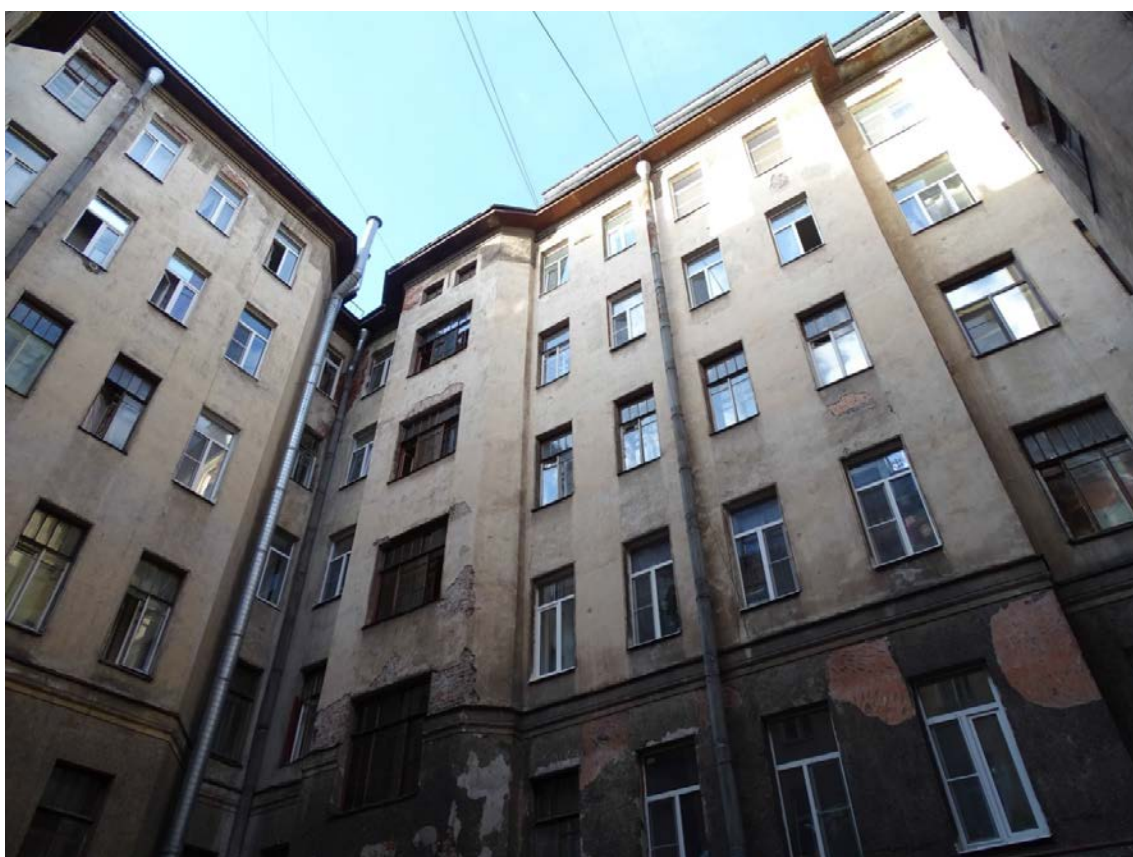
Фото 38. Здание по адресу: г. Санкт-Петербург, 11-я линия В. О., 34/47, литера А. Северо-восточный дворовой фасад. Съемка 19.04.2021 г. Кириков Б. М.
