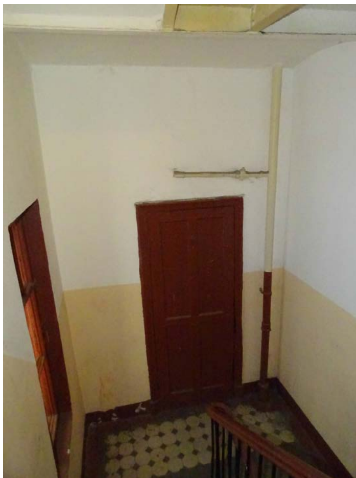
Фото 89. Лестница № 3. 2-й этаж. Съемка 19.04.2021 г. Кириков Б. М.
