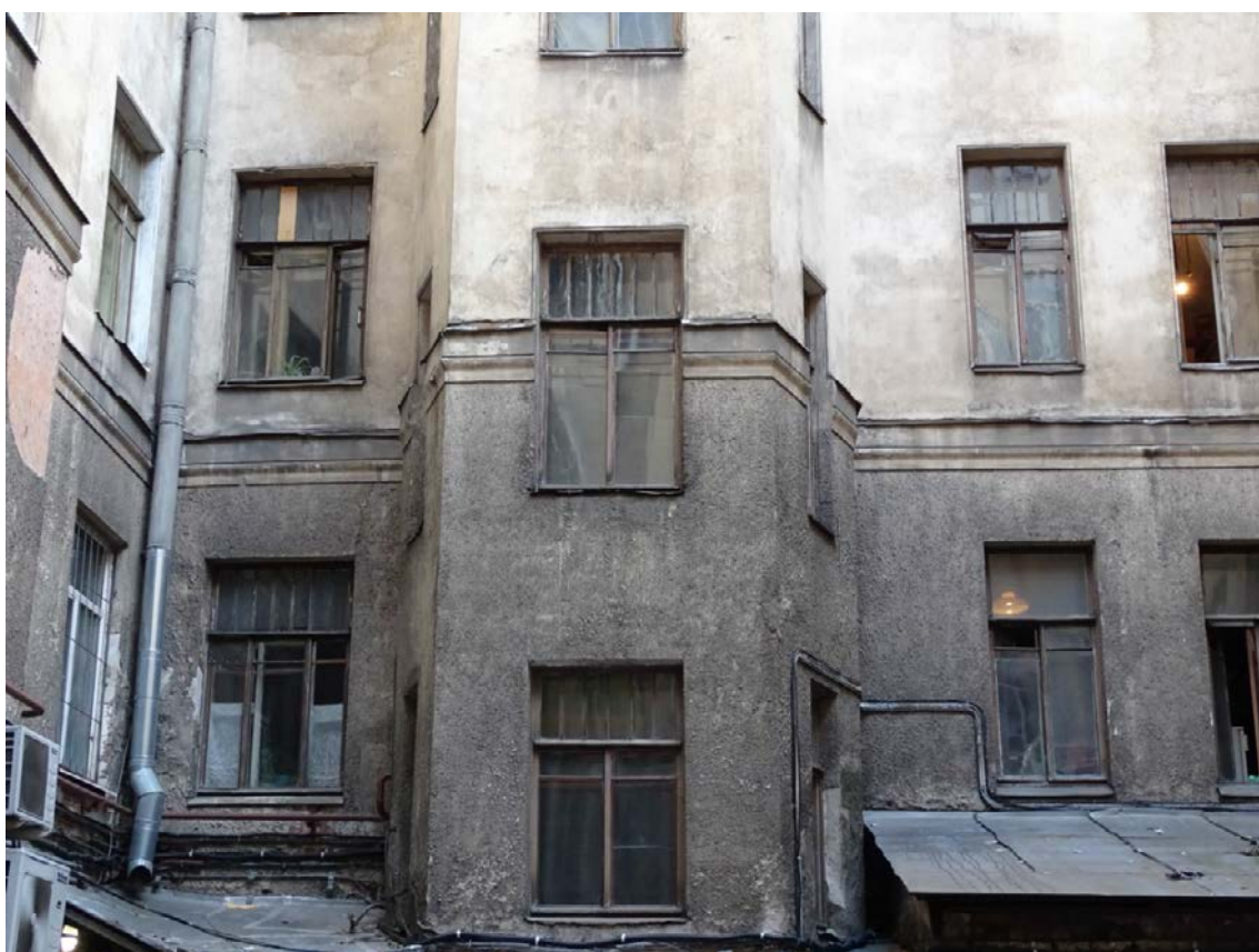
Фото 42. Здание по адресу: г. Санкт-Петербург, 11-я линия В. О., 34/47, литера А. Фрагмент южного дворового фасада. 2-й, 3-й этаж. Съемка 19.04.2021 г. Кириков Б. М.
