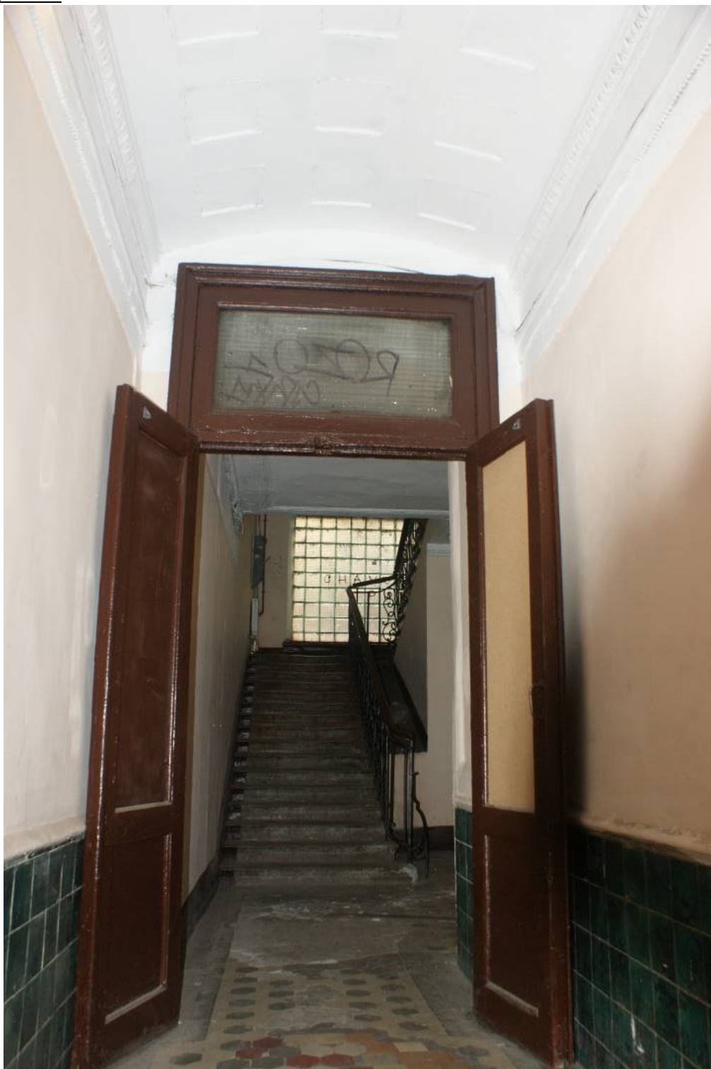
Фото 37. Лестница № 2. 1-й этаж. Вестибюль. Съемка 19.04.2021 г. Кириков Б. М.
