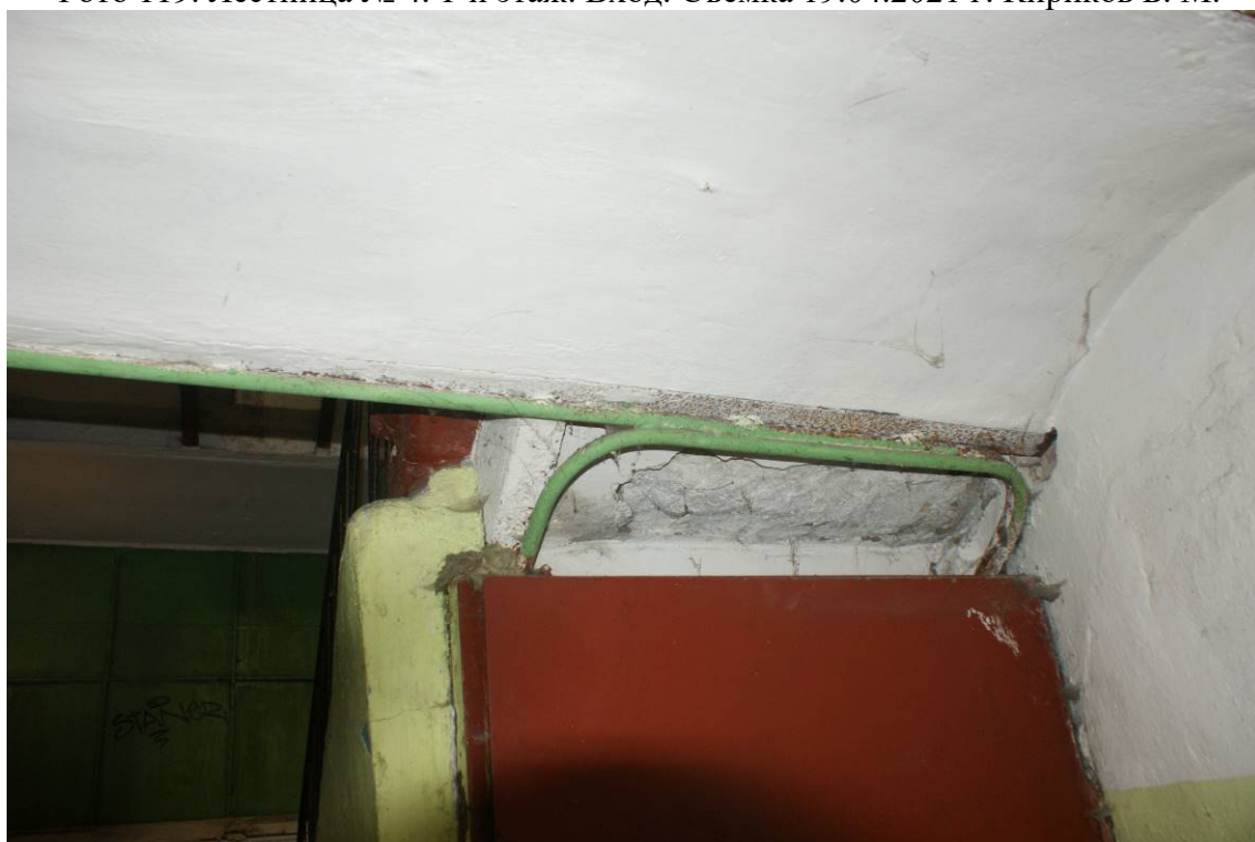
Фото 120. Лестница № 4. 1-й этаж. Свод. Съемка 19.04.2021 г. Кириков Б. М.
