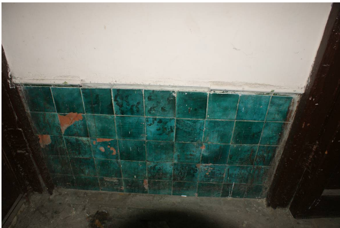
Фото 40. Лестница № 2. 1-й этаж. Вестибюль. Покрытие стен. Съемка 19.04.2021 г. Кириков Б. М.
