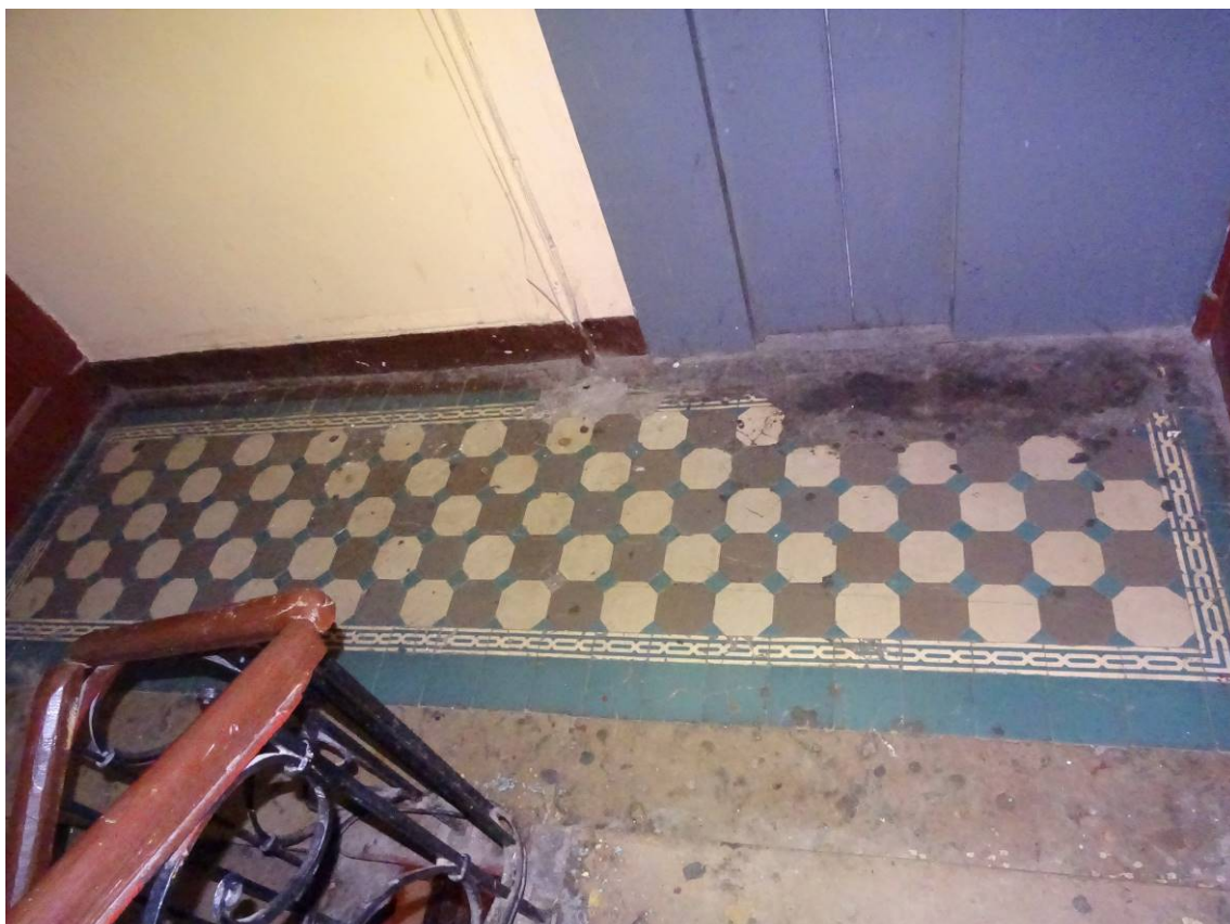
Фото 20. Лестница № 1. 2-й этаж. Покрытие пола. Съемка 19.04.2021 г. Кириков Б. М.
