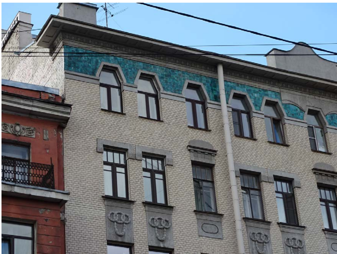
Фото 26. Здание по адресу: г. Санкт-Петербург, 11-я линия В. О., 34/47, литера А. Фрагмент фасада. Вид с Среднего пр. Съемка 19.04.2021 г. Кириков Б. М.
