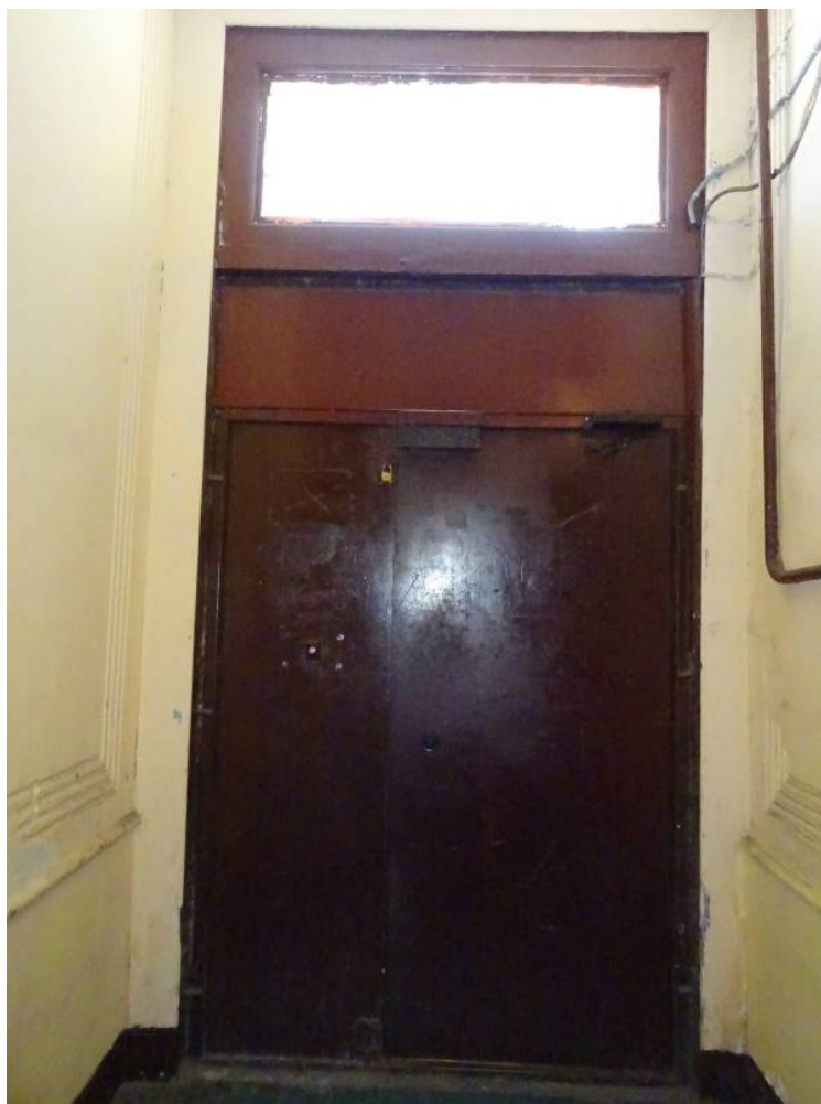
Фото 4. Лестница № 1. 1-й этаж. Вестибюль. Съемка 19.04.2021 г. Кириков Б. М.
