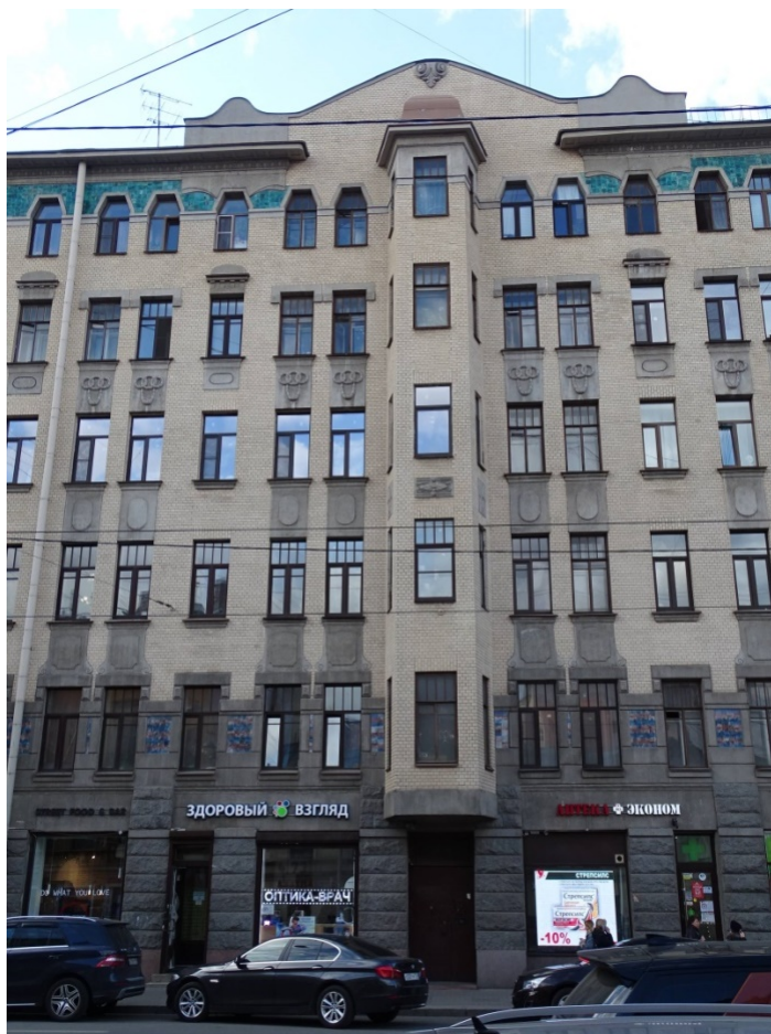
Фото 21. Здание по адресу: г. Санкт-Петербург, 11-я линия В. О., 34/47, литера А. Фрагмент фасада. Вид с Среднего пр. Съемка 19.04.2021 г. Кириков Б. М.
