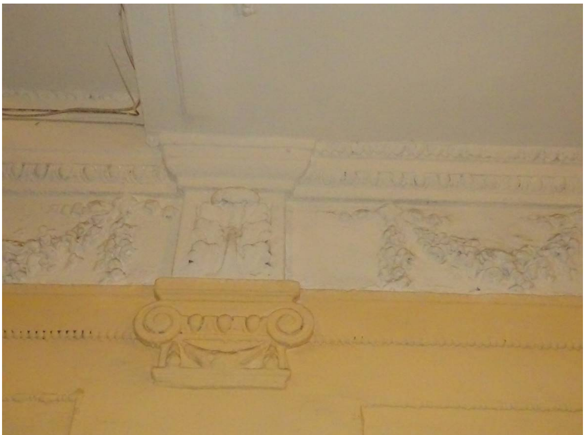
Фото 9. Лестница № 1. 1-й этаж. Вестибюль. Оформление стен. Съемка 19.04.2021 г. Кириков Б. М.
