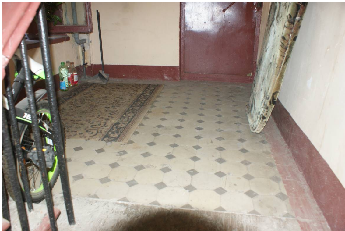
Фото 113. Лестница № 3. 7-й этаж. Покрытие пола. Съемка 19.04.2021 г. Кириков Б. М.
