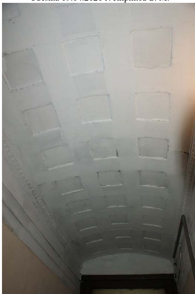
Фото 41. Лестница № 2. 1-й этаж. Вестибюль. Оформление потолка. Съемка 19.04.2021 г. Кириков Б. М.
