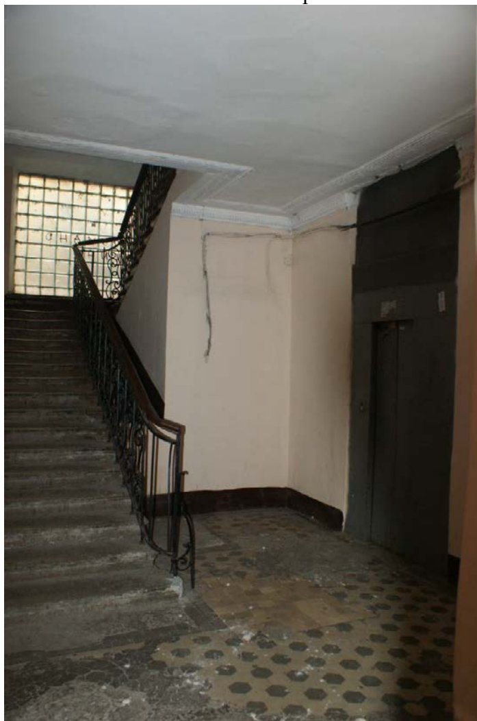
Фото 43. Лестница № 2. 1-й этаж. Вестибюль. Съемка 19.04.2021 г. Кириков Б. М.
