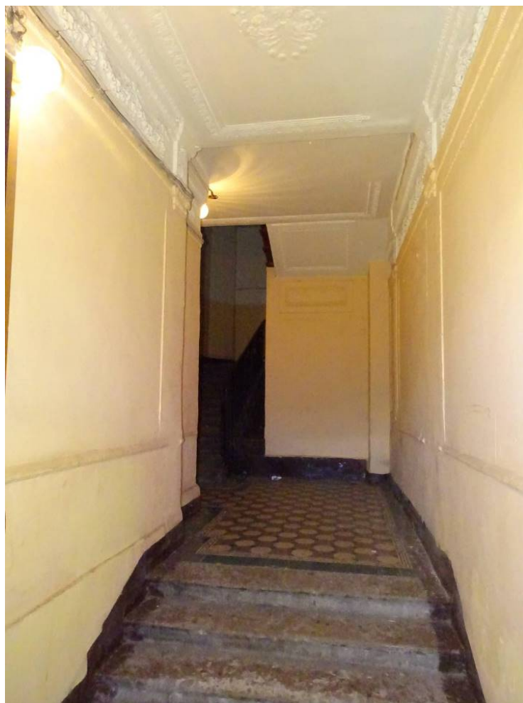
Фото 2. Лестница № 1. 1-й этаж. Вестибюль. Съемка 19.04.2021 г. Кириков Б. М.
