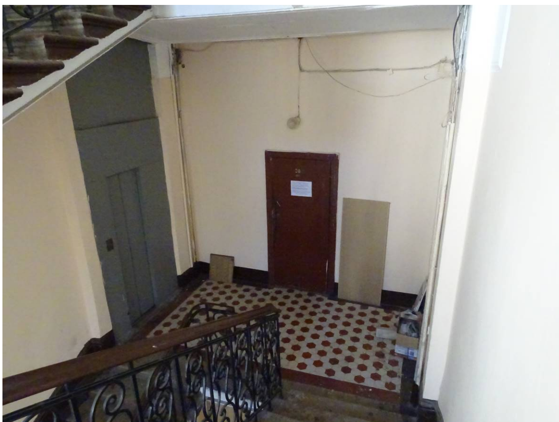
Фото 59. Лестница № 2. 4-й этаж. Съемка 19.04.2021 г. Кириков Б. М.
