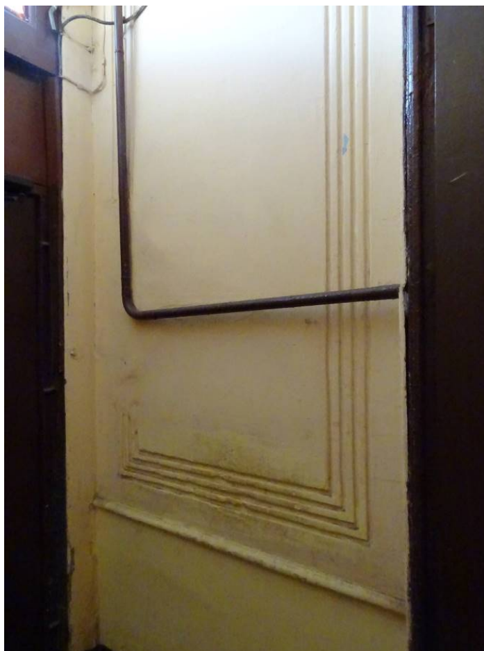
Фото 6. Лестница № 1. 1-й этаж. Входной тамбур. Оформление стен. Съемка 19.04.2021 г. Кириков Б. М.
