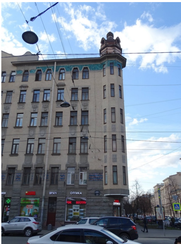
Фото 15. Здание по адресу: г. Санкт-Петербург, 11-я линия В. О., 34/47, литера А. Фрагмент фасада. Вид с Среднего пр. Съемка 19.04.2021 г. Кириков Б. М.
