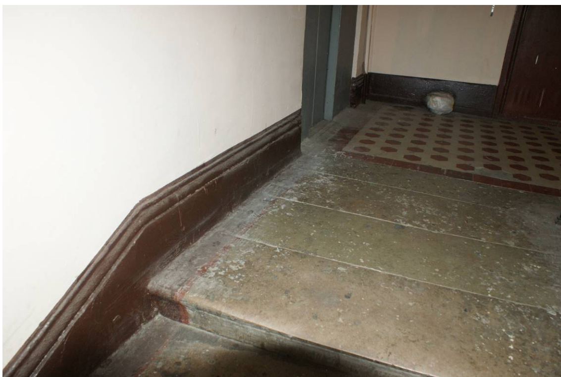
Фото 51. Лестница № 2. 2-й этаж. Съемка 19.04.2021 г. Кириков Б. М.
