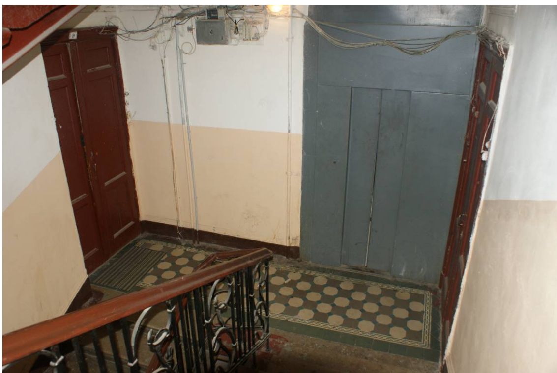
Фото 32. Лестница № 1. 6-й этаж. Съемка 19.04.2021 г. Кириков Б. М.
