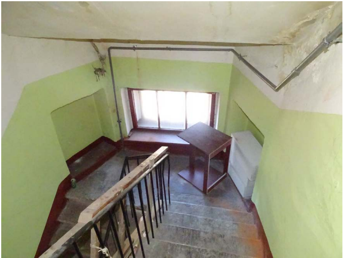
Фото 145. Лестница № 4. Площадка м/у 6-м и чердачным этажом. Съемка 19.04.2021 г. Кириков Б. М.
