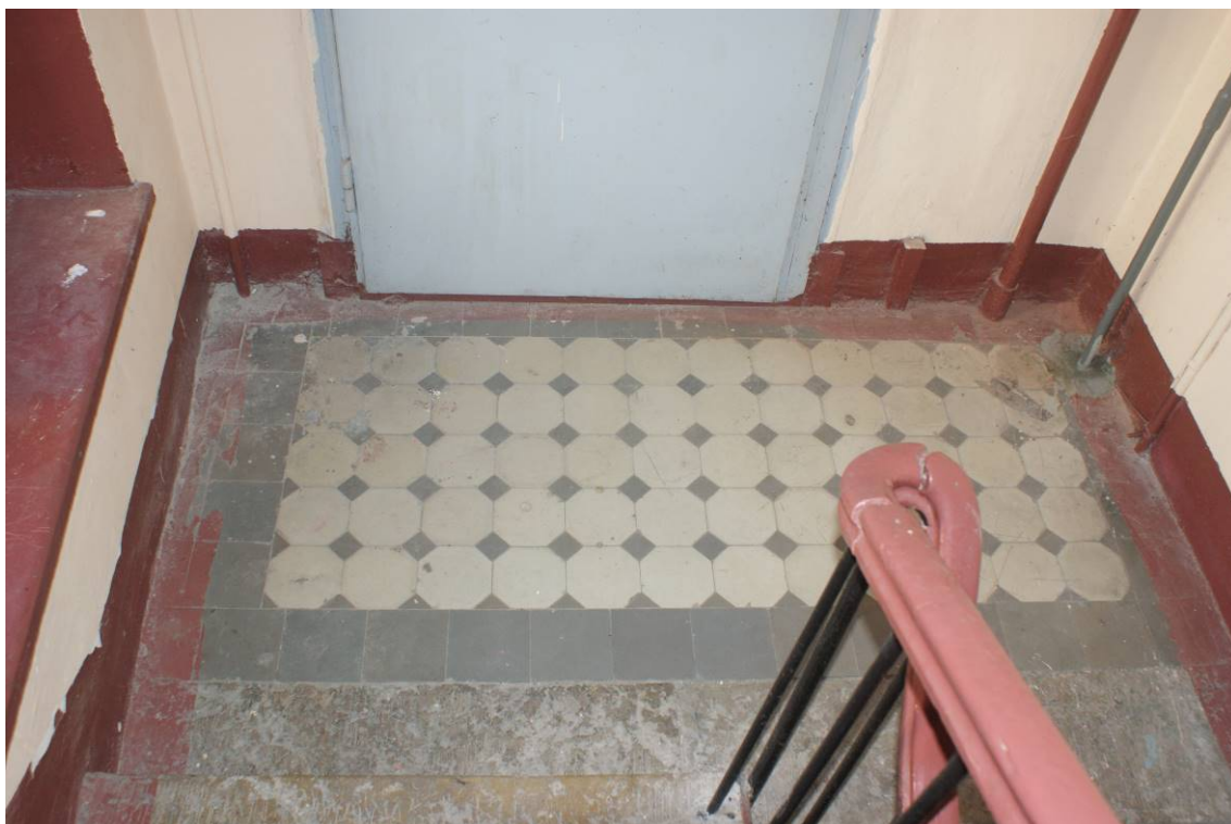
Фото 109. Лестница № 3. 6-й этаж. Покрытие пола. Съёмка 19.04.2021 г. Кириков Б. М.
