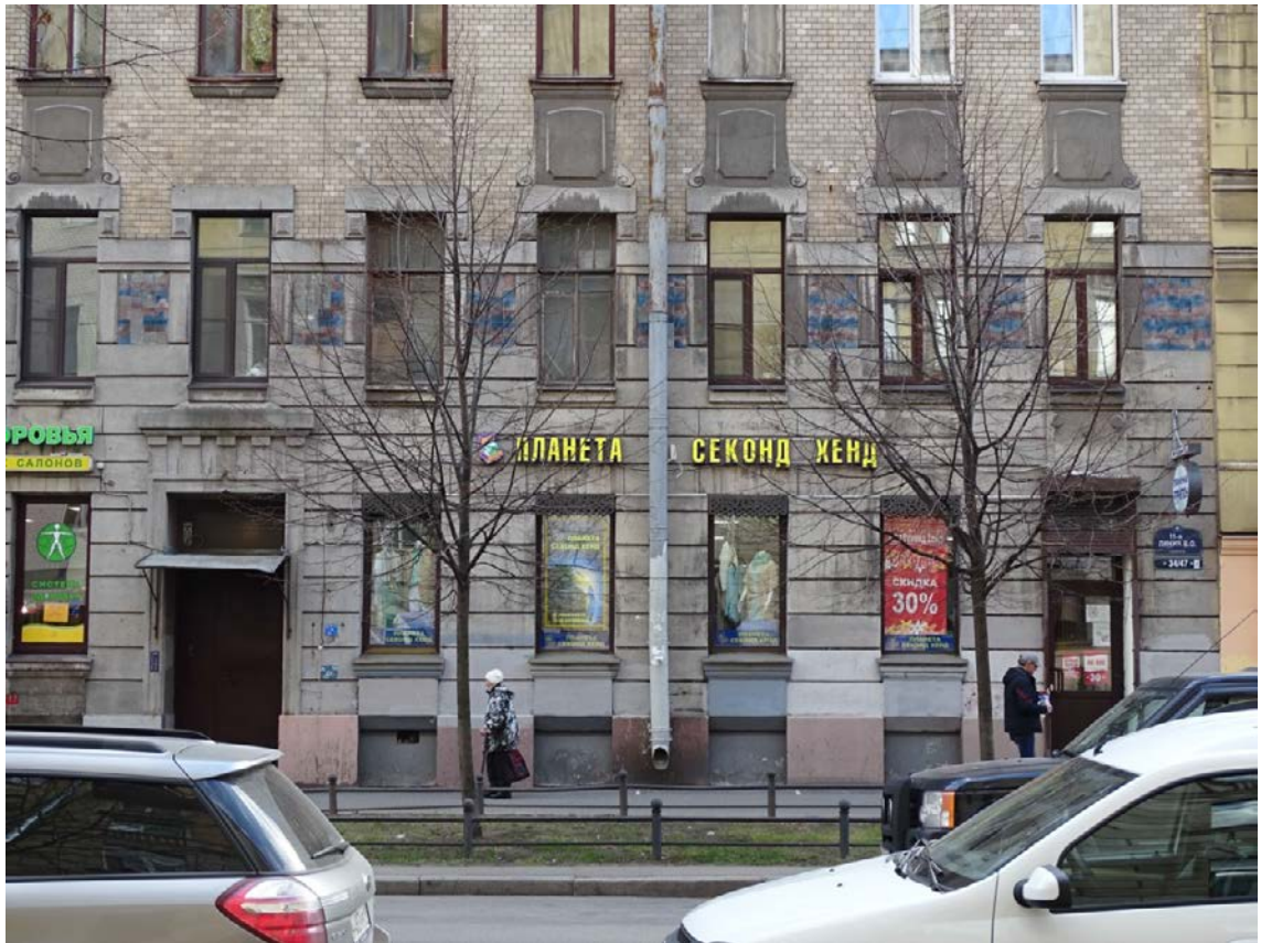
Фото 5. Здание по адресу: г. Санкт-Петербург, 11-я линия В. О., 34/47, литера А. Фрагмент фасада по 11-й линии. Съемка 19.04.2021 г. Кириков Б. М.
