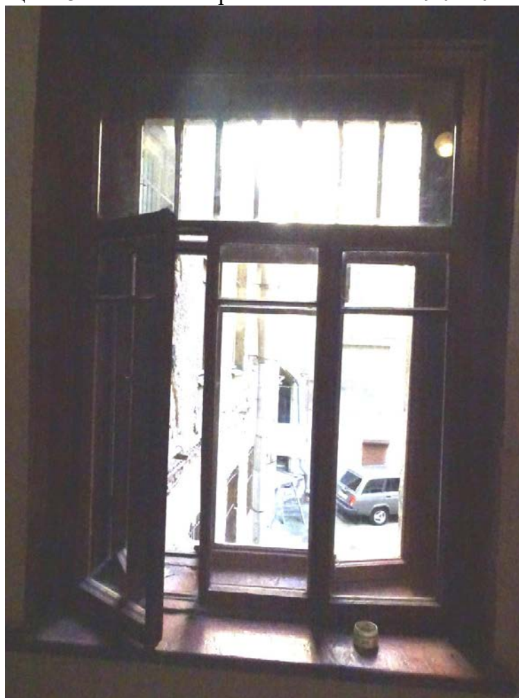
Фото 84. Лестница № 3. 2-й этаж. Съёмка 19.04.2021 г. Кириков Б. М.
