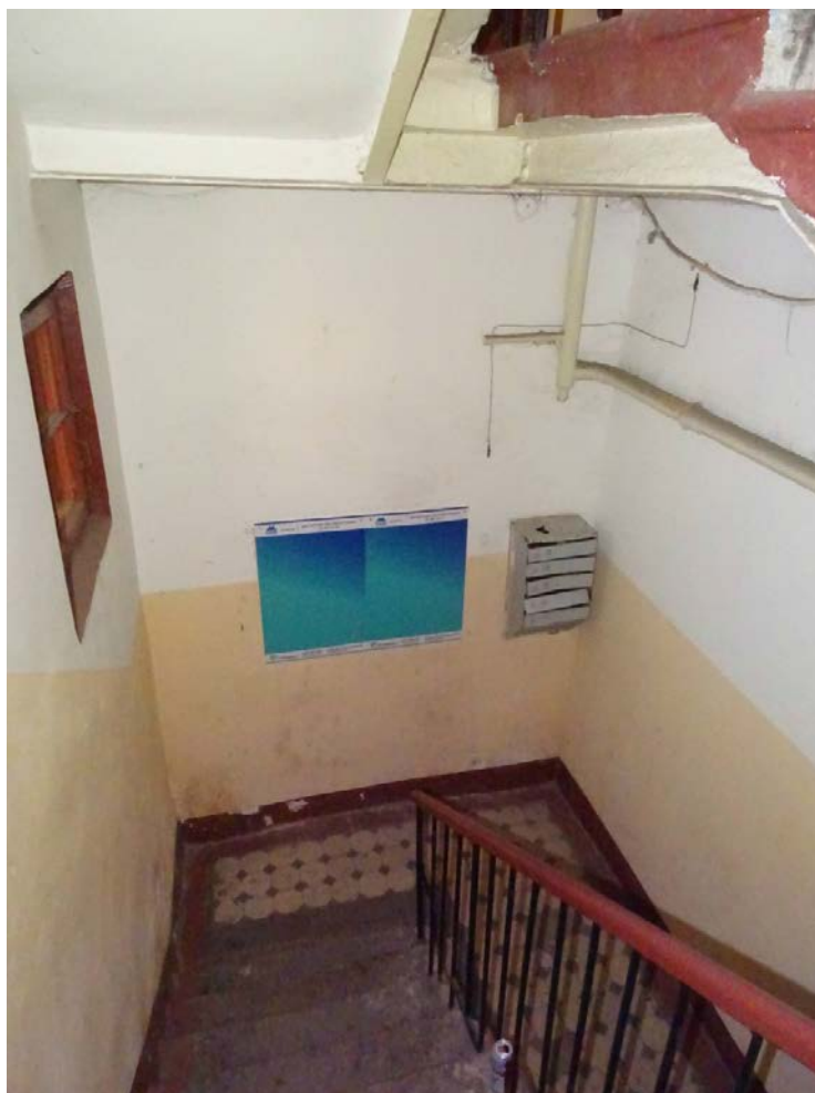
Фото 79. Лестница № 3. 1-й этаж. Съёмка 19.04.2021 г. Кириков Б. М.
