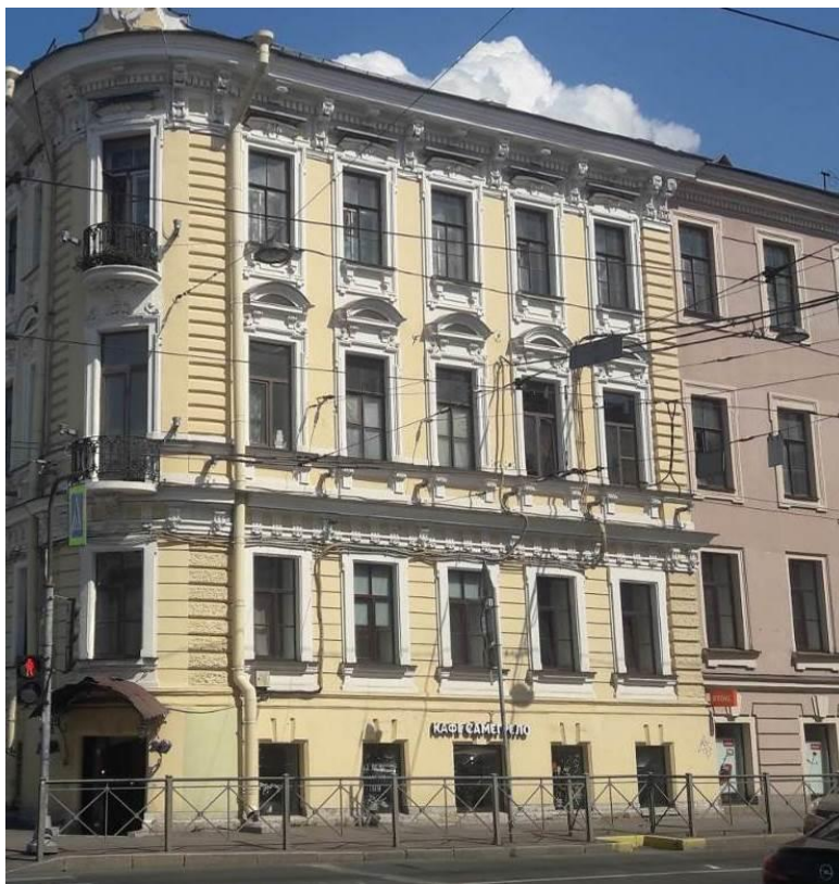
9. Дом, в котором жили: Попов Александр Степанович в 1901-1902 гг., Козлов Петр Кузьмич в 1903-1905 гг., Дубовский Николай Никонорович в 1894-1896 гг. и Введенский Николай Евгеньевич в 1915-1917 гг. Лицевой фасад (вид на торец). Штиглиц М.С. 18.06.2021.
