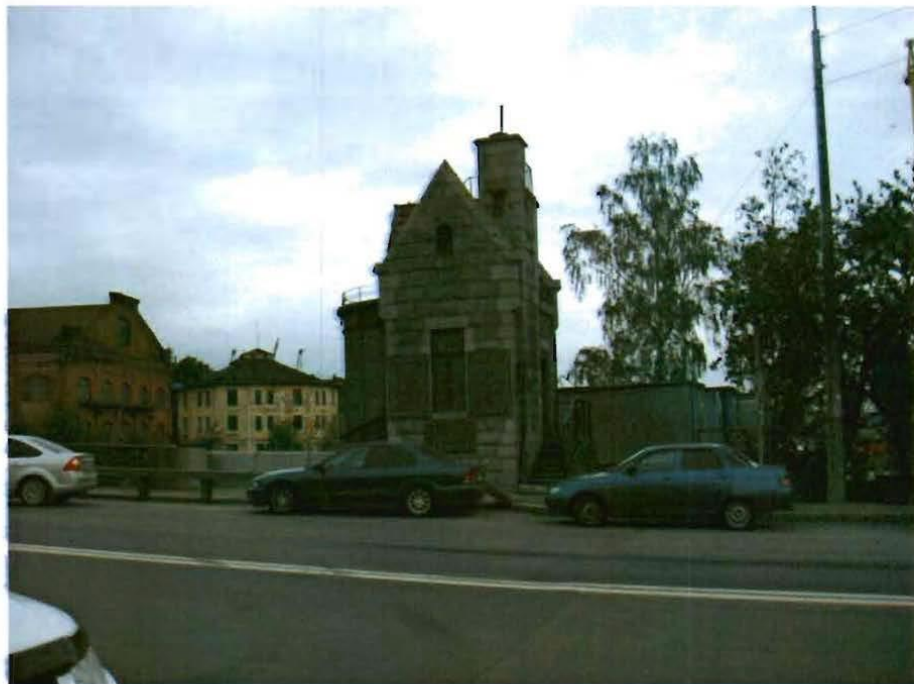
6. Маневровый павильон на левобережном устье верховой стороны (южный фасад)
