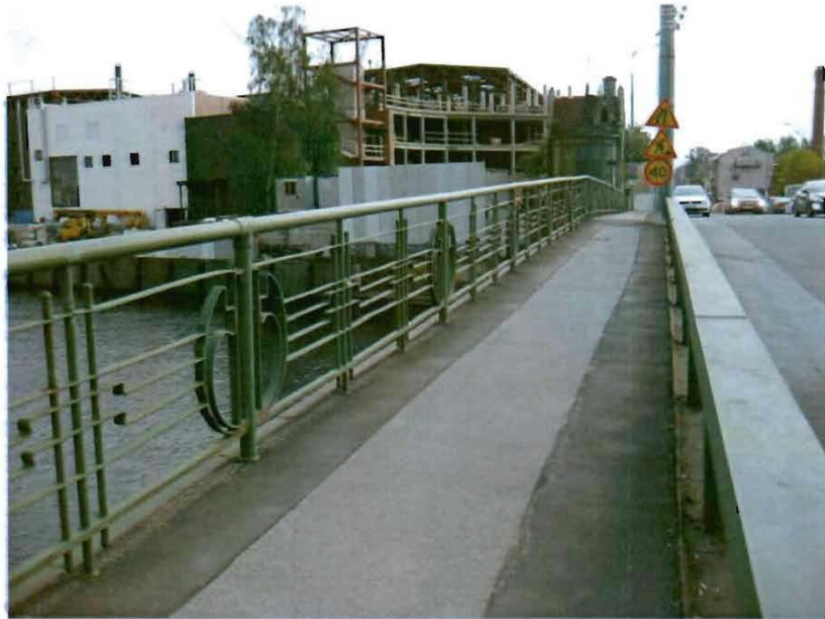
3. Тротуарное покрытие, перильное ограждение (верховой фасад)
