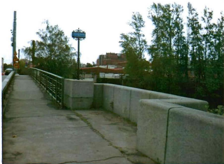
4. Тротуарное покрытие, перильное ограждение (низовой фасад)
