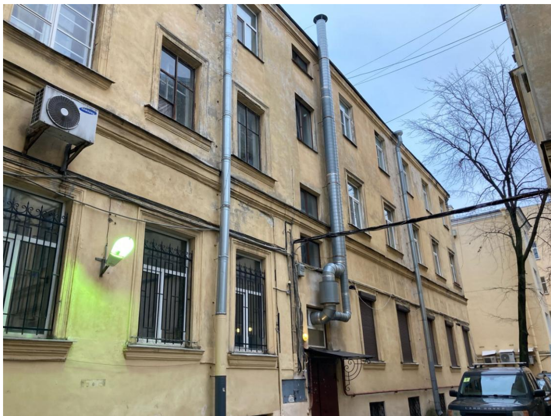
Фото 3. Фрагмент дворового фасада выявленного объекта культурного наследия «Дом, в котором в 1944-1978 годах жил артист В.В. Меркурьев»
