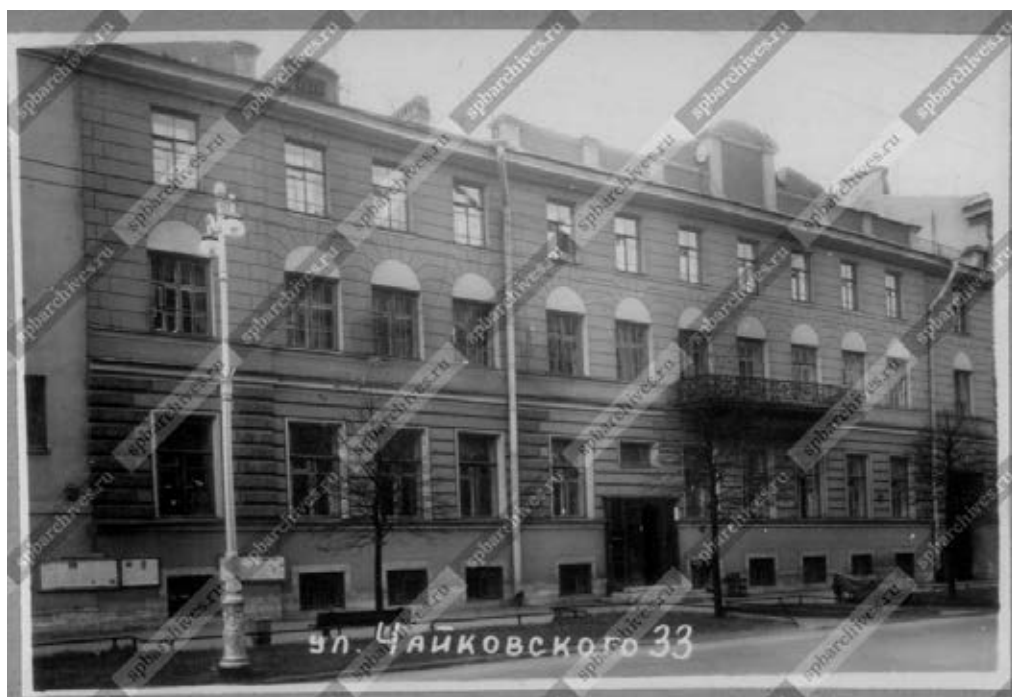
14. Фасад дома №33 на ул. Чайковского. 1960 г. // ЦГАКФФД СПб Гр 76010.
