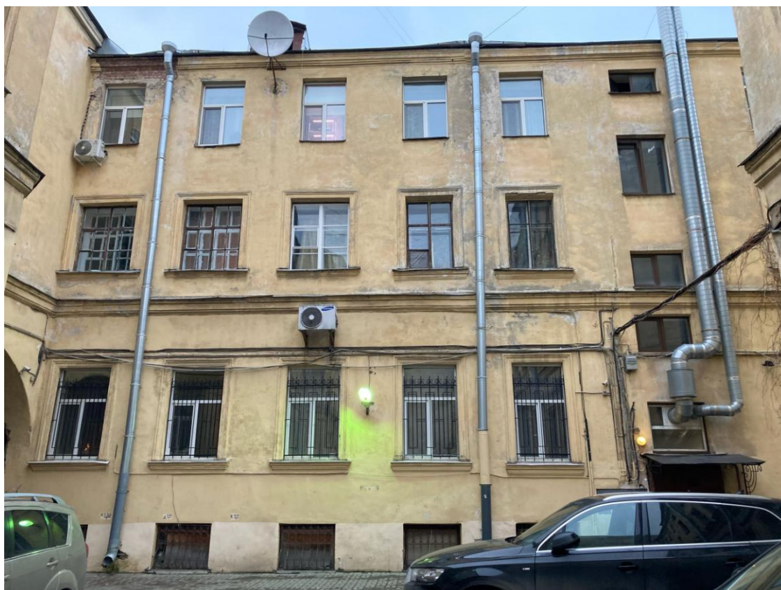
Фото 2. Фрагмент дворового фасада выявленного объекта культурного наследия «Дом, в котором в 1944-1978 годах жил артист В.В. Меркурьев»
