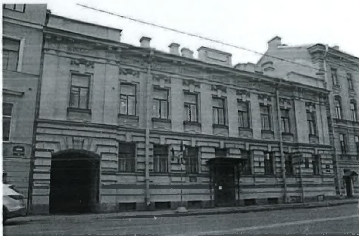
Фото №1. Вид на лицевой фасад со стороны ул. Глинки.
