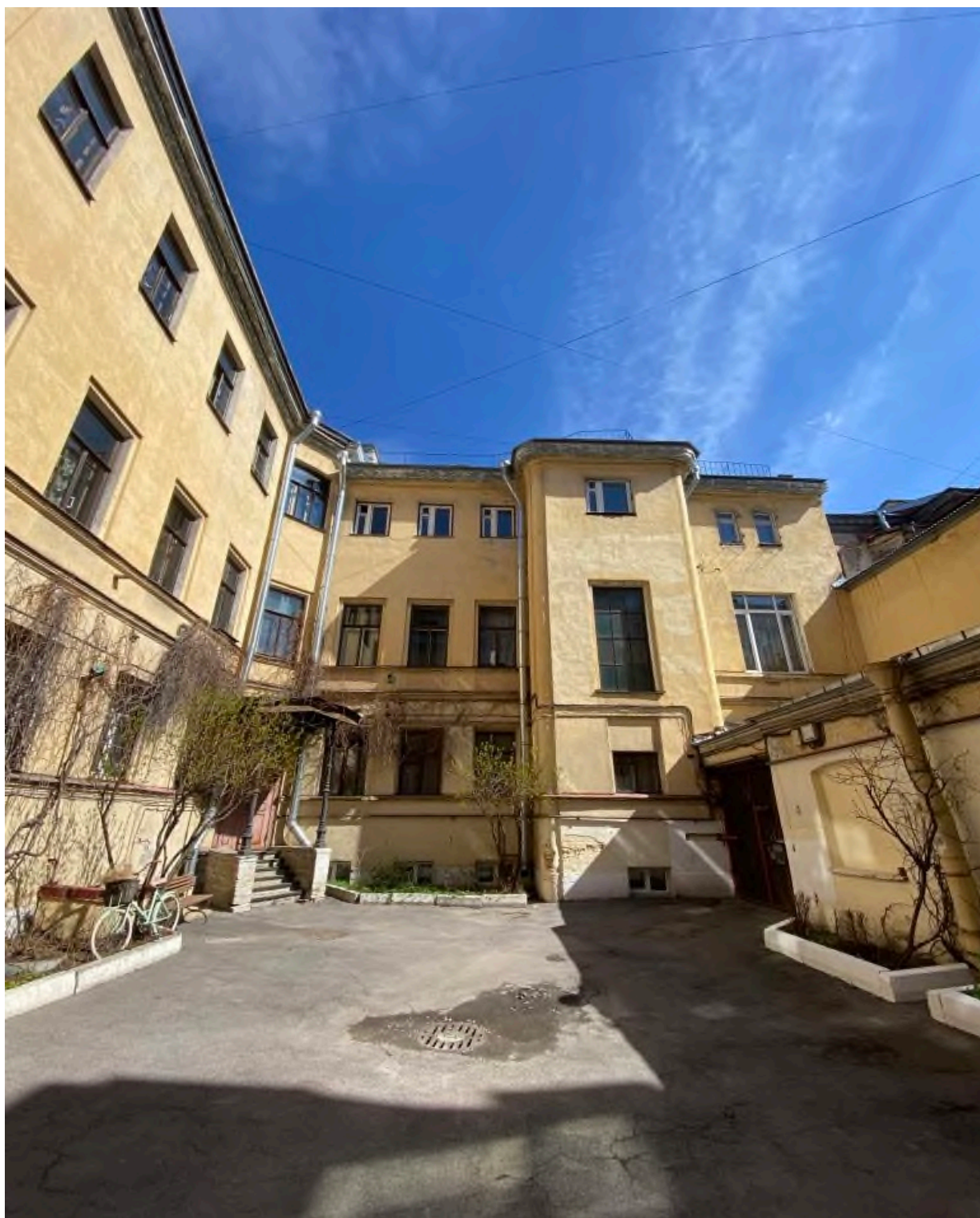
6. “Дворец вел.кн.Кирилл Владимировича». Санкт-Петербург, ул. Глинки, 13, литера А. Дворовый фасад. Фото: 20.07.2021.
