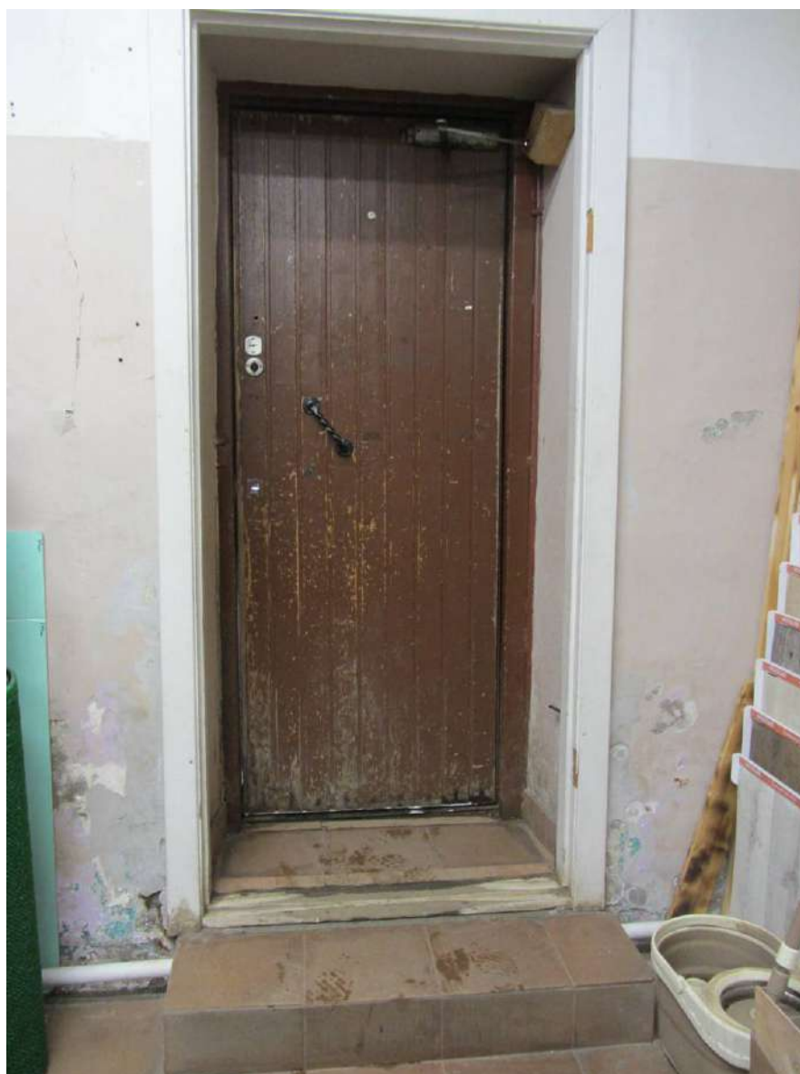
8. Казарма Офицерской стрелковой школы по адресу: г. Ломоносов, Александровская ул., д. 19. Фрагмент интерьера. Вход в здание. Фото 25.01.2023.
