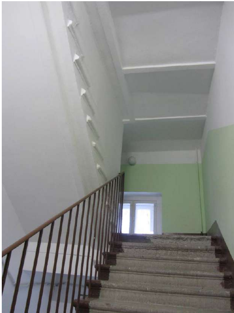
10. Казарма Офицерской стрелковой школы по адресу: г. Ломоносов, Александровская ул., д. 15. Фрагмент интерьера. Фрагмент лестницы. Фото 25.01.2023.
