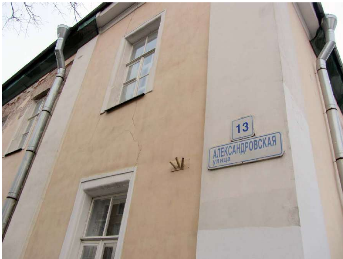
4. Казарма Офицерской стрелковой школы по адресу: г. Ломоносов, Александровская ул., д. 13. Фрагмент лицевого фасада. Фото 25.01.2023.
