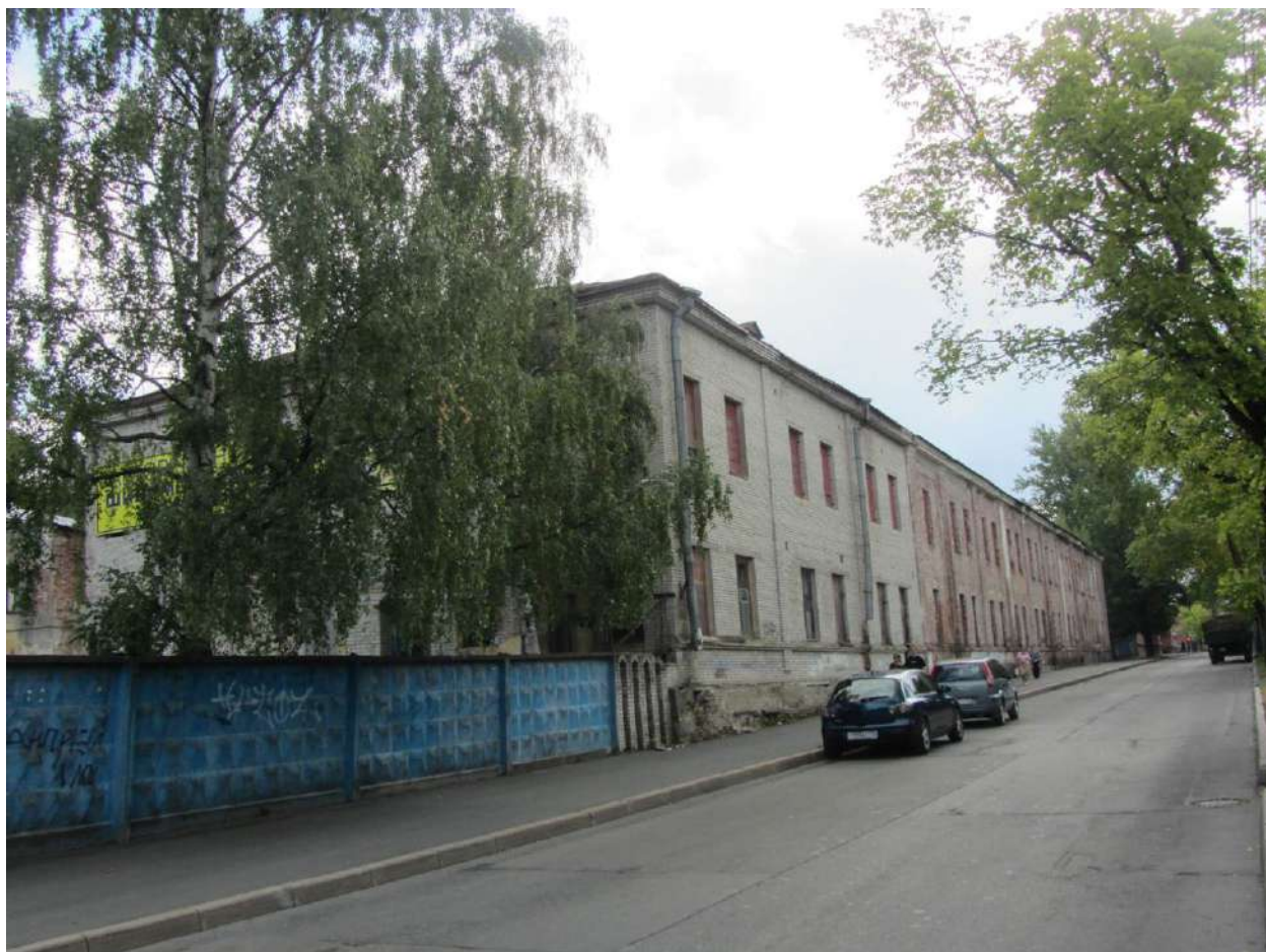
1. Казарма Офицерской стрелковой школы по адресу: г. Ломоносов, Владимирская ул., 10. Общий вид здания от улицы Костылева с северо-запада. Фото 01.06.2022.
