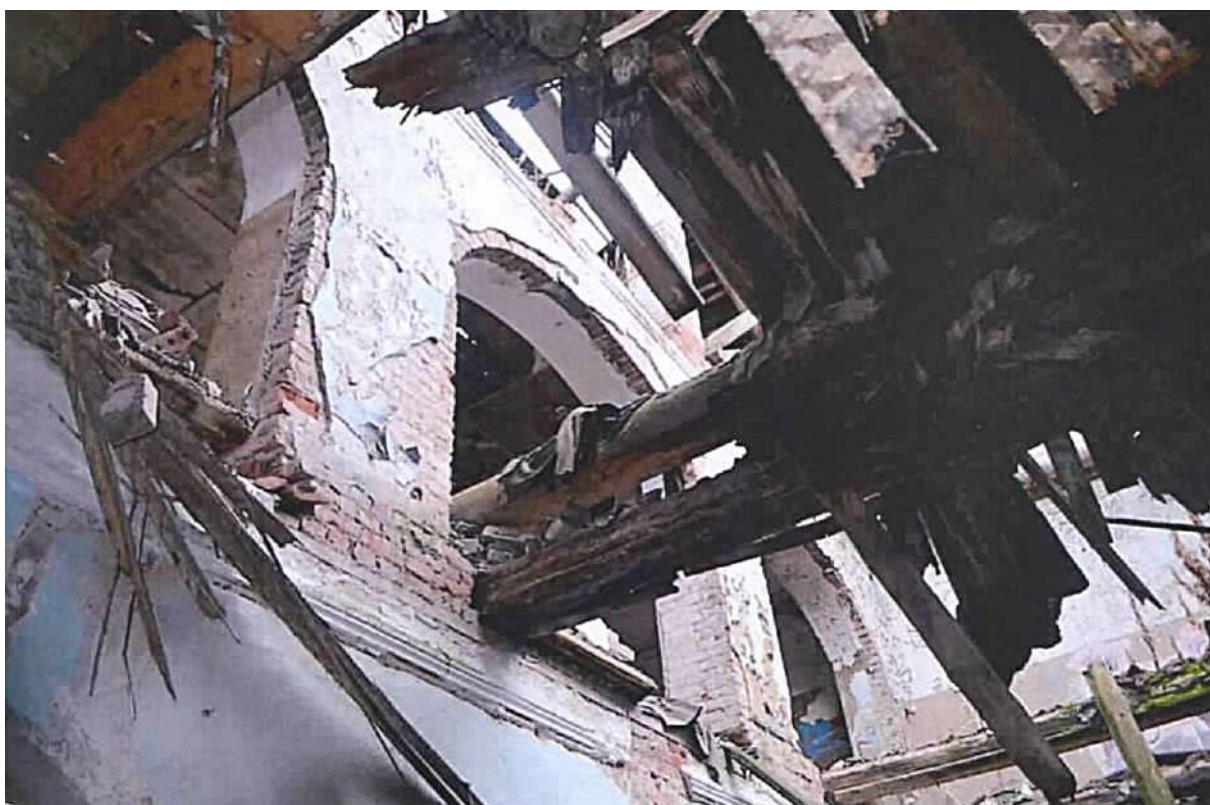
16, 17. Казарма Офицерской стрелковой школы по адресу: г. Ломоносов, Владимирская ул., 10. Фрагменты деревянных перекрытий. Фото 01.06.2022.
