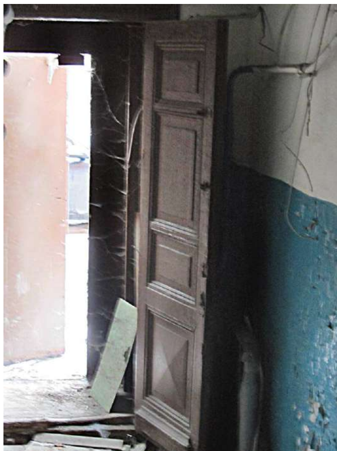
11. Казарма Офицерской стрелковой школы по адресу: г. Ломоносов, Владимирская ул., 12. Вход в здание, дверное заполнение. Фото 01.06.2022.
