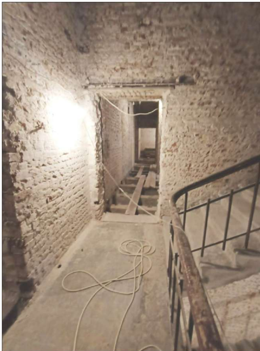
21. Казарма Офицерской стрелковой школы по адресу: г. Ломоносов, Владимирская ул., 15 Фрагмент интерьера. Фрагмент лестничной клетки. Фото 01.06.2022.
