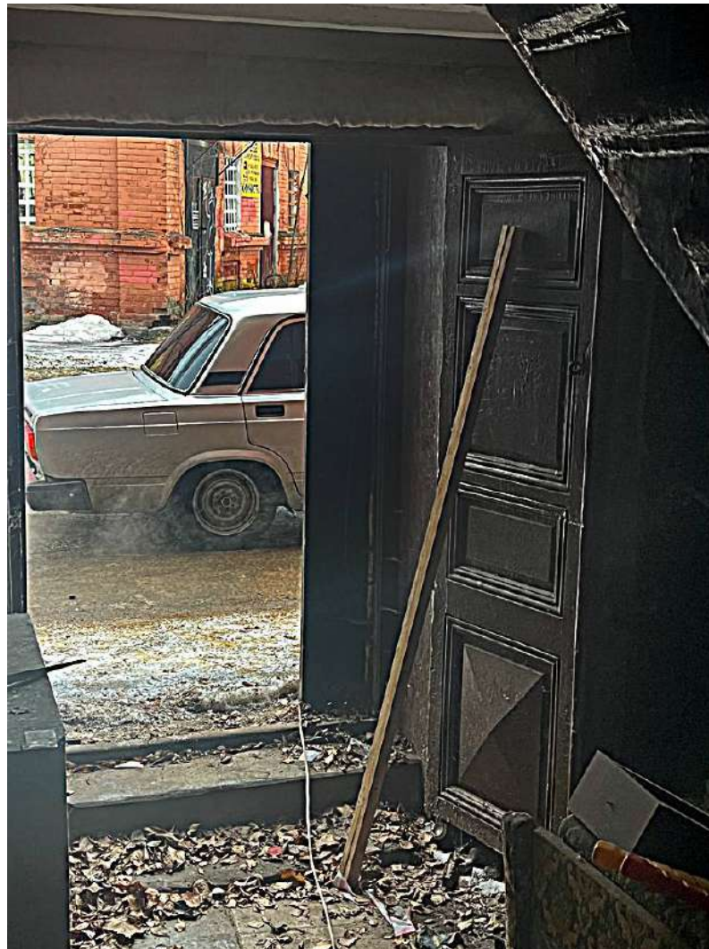
3. Казарма Офицерской стрелковой школы по адресу: г. Ломоносов, Александровская ул., 24а. Фрагмент интерьера. Входная зона. Дверное заполнение. Фото 25.01.2023.
