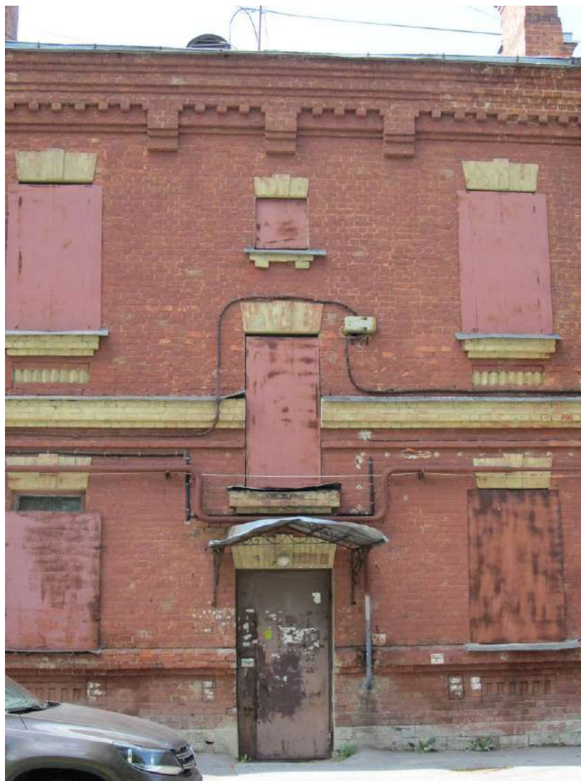
8. Казарма Офицерской стрелковой школы по адресу: г. Ломоносов, Владимирская ул., 12. Фрагмент дворового восточного фасада. Вход на лестницу. Фото 01.06.2022.
