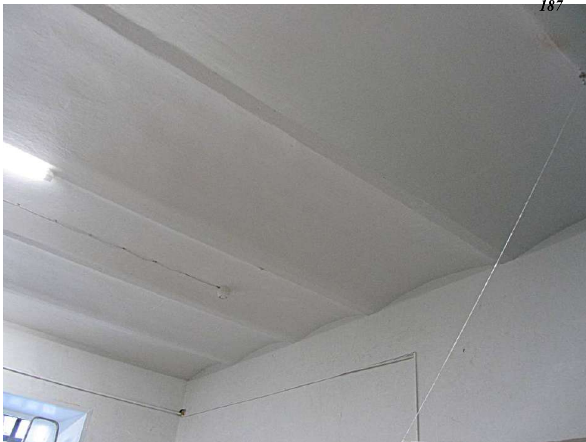
12. Казарма Офицерской стрелковой школы по адресу: г. Ломоносов, Александровская ул., д. 19. Фрагмент интерьера. Фрагмент потолка с прусскими сводами. Фото 25.01.2023.
