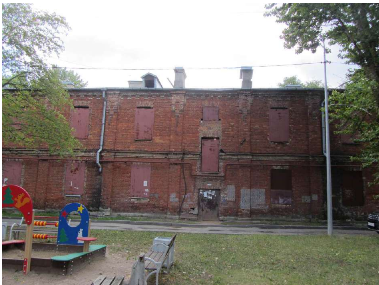
6. Казарма Офицерской стрелковой школы по адресу: г. Ломоносов, Владимирская ул., 15 Общий вид дворового фасада здания. Вид с запада. Фото 01.06.2022.
