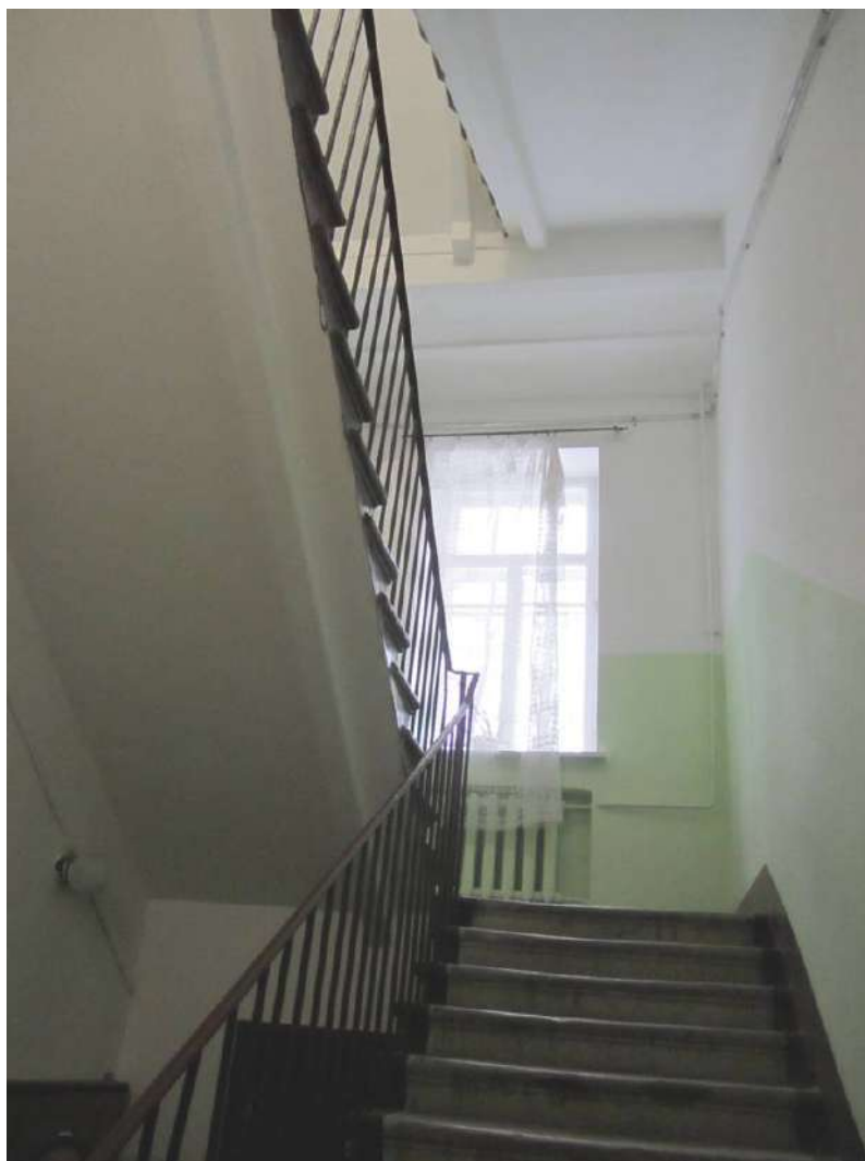
12. Казарма Офицерской стрелковой школы по адресу: г. Ломоносов, Александровская ул., д. 15. Фрагмент интерьера. Фрагмент лестницы. Фото 25.01.2023.
