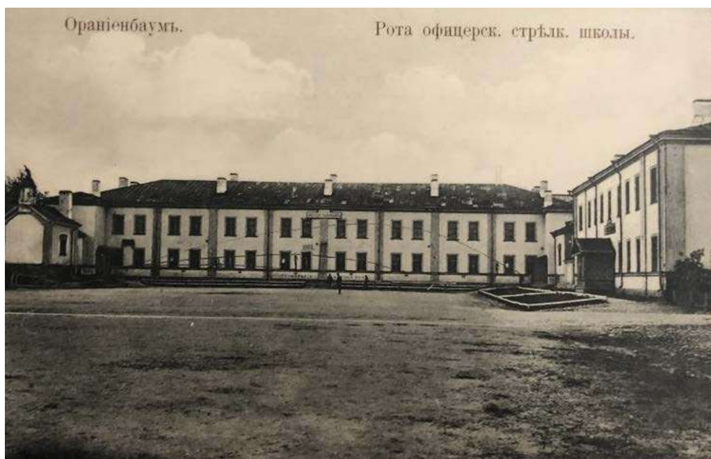
13. Здание Стрелковой роты ОСШ, плац и кухонный флигель постройки до 1882 г. Современный адрес ул. Владимирская, д. 10, литера В. Справа: кухонный флигель, столовая ОСШ – литера Б. Открытка 1900-1910-х гг. Из архива А.С. Подколзина.
