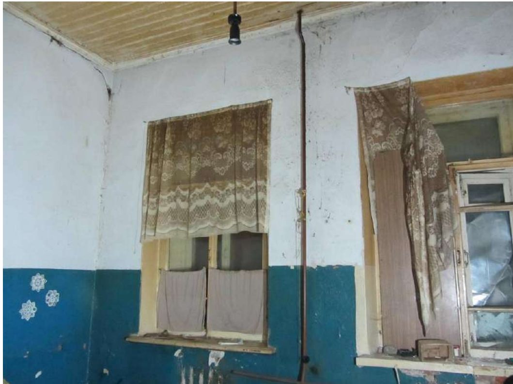
7, 8. Казарма Офицерской стрелковой школы по адресу: г. Ломоносов, Александровская ул., 24а. Фрагменты интерьера. Фото 25.01.2023.
