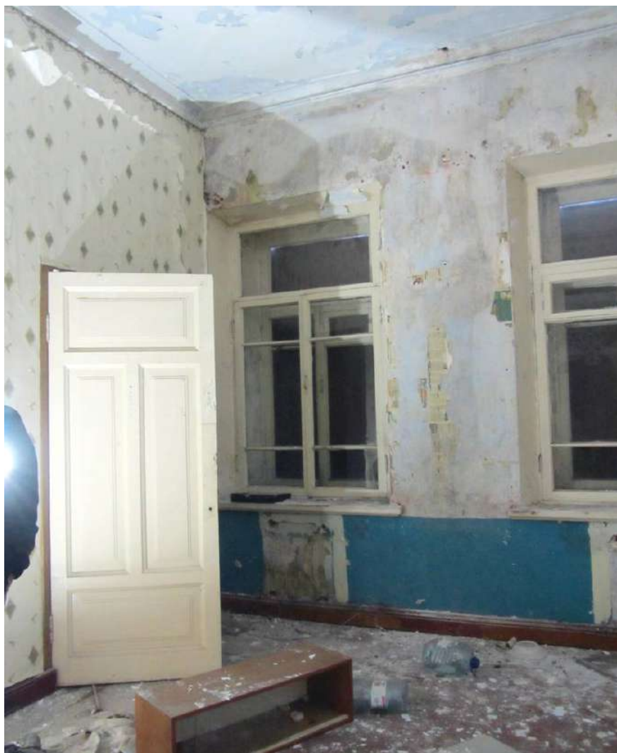
16. Казарма Офицерской стрелковой школы по адресу: г. Ломоносов, Владимирская ул., 12. Фрагмент интерьера. Фото 01.06.2022.
