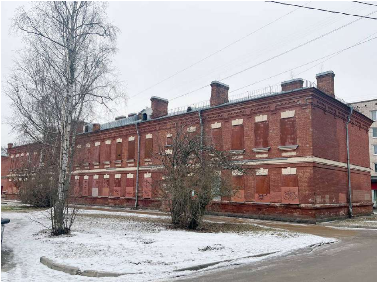
2. Казарма Офицерской стрелковой школы по адресу: г. Ломоносов, Александровская ул., д. 17. Общий вид дворового фасада с юго-запада. Фото 25.01.2023.
