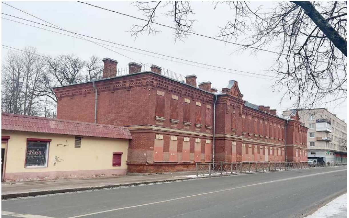
1. Казарма Офицерской стрелковой школы по адресу: г. Ломоносов, Александровская ул., 24а. Общий вид здания с улицы Александровской. Фото 25.01.2023.
