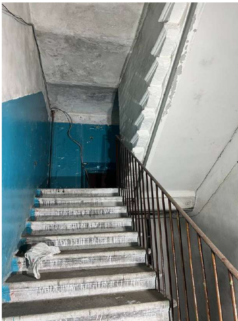
14. Казарма Офицерской стрелковой школы по адресу: г. Ломоносов, Владимирская ул., 12. Фрагмент интерьера. Общий вид лестницы. Фото 01.06.2022.
