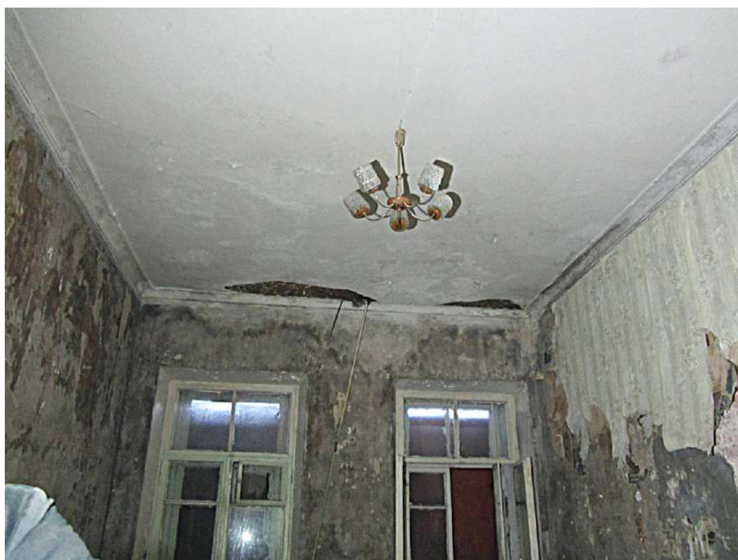
19, 20. Казарма Офицерской стрелковой школы по адресу: г. Ломоносов, Владимирская ул., 12. Фрагменты интерьера. Фото 01.06.2022.
