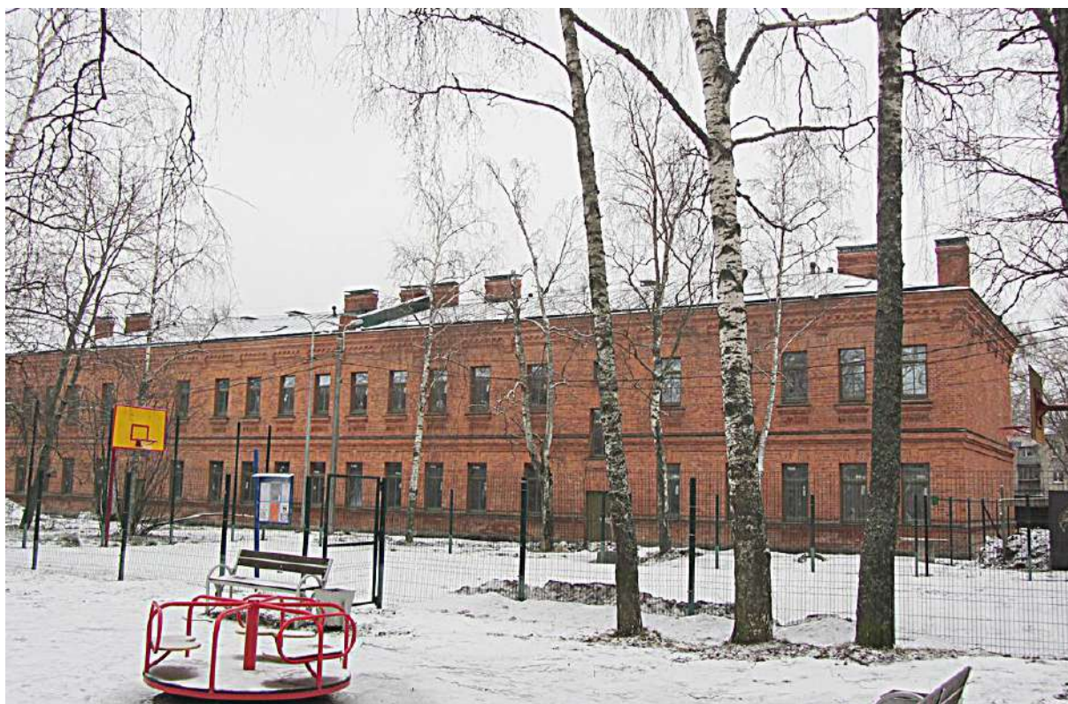
3. Казарма Офицерской стрелковой школы по адресу: г. Ломоносов, Владимирская ул., 16а. Общий вид северного фасада. Фото 25.01.2023.
