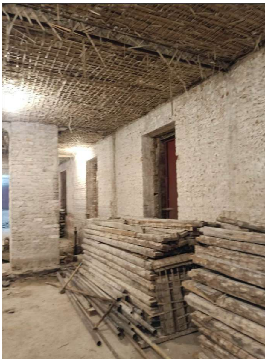
16. Казарма Офицерской стрелковой школы по адресу: г. Ломоносов, Владимирская ул., 15 Фрагмент интерьера 1-го этажа. Существующая кладка наружной стены. Фото 01.06.2022.
