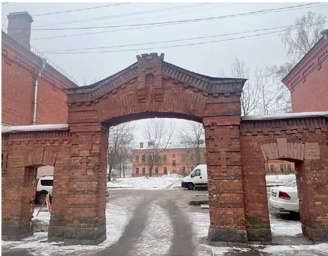
4. Казарма Офицерской стрелковой школы по адресу: г. Ломоносов, Александровская ул., д. 17. Ограда между Казармами Офицерской стрелковой школы по ул. Александровской, д. 15 и д. 17. Вид с севера. Фото 25.01.2023.
