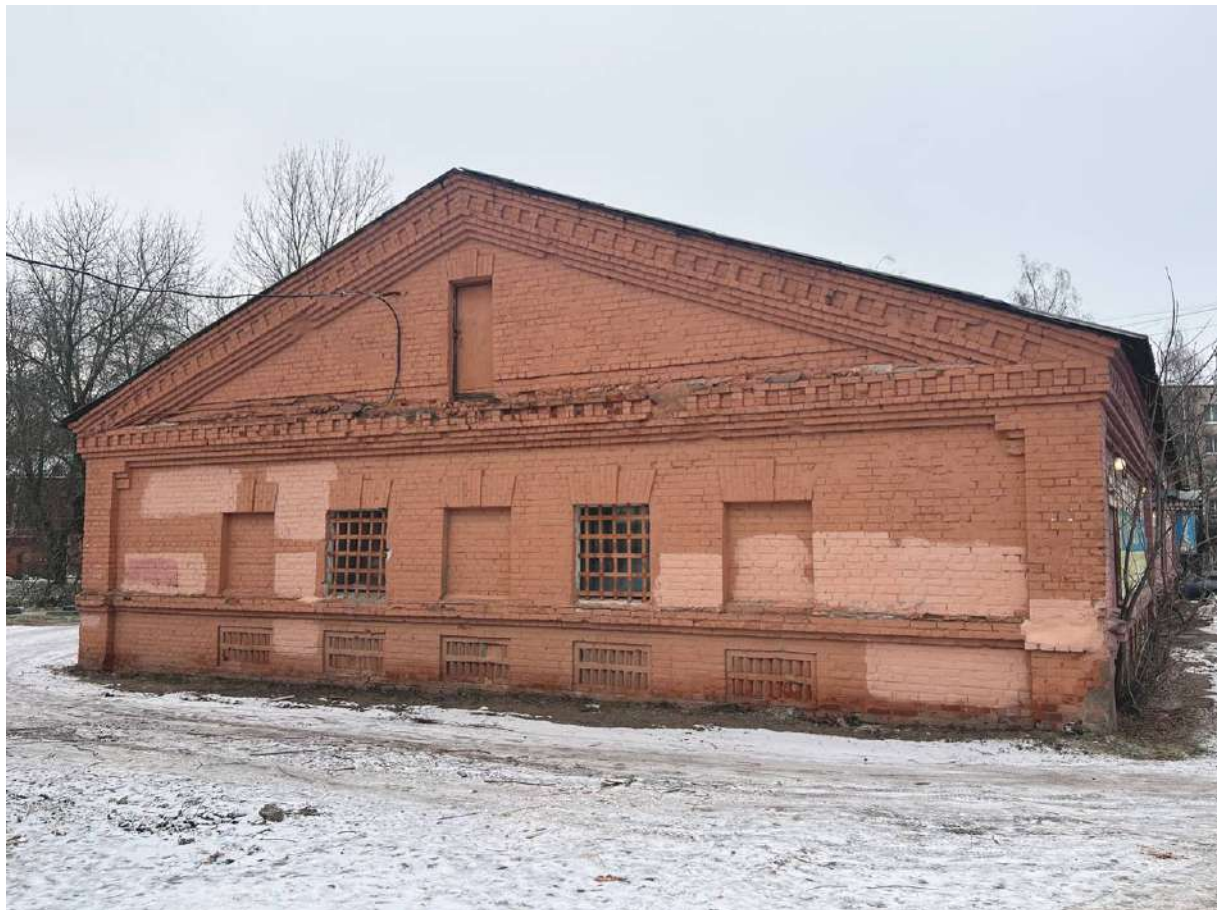
5. Казарма Офицерской стрелковой школы по адресу: г. Ломоносов, Александровская ул., д. 19. Общий вид торцевого юго-западного фасада. Фото 25.01.2023.
