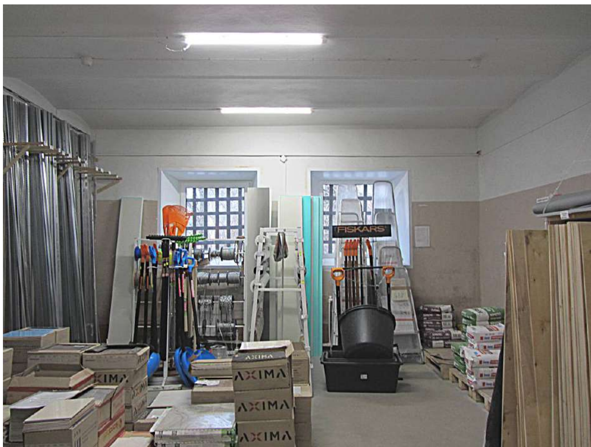
10. Казарма Офицерской стрелковой школы по адресу: г. Ломоносов, Александровская ул., д. 19. Фрагмент интерьера. Общий вид помещения с прусскими сводами. Фото 25.01.2023.
