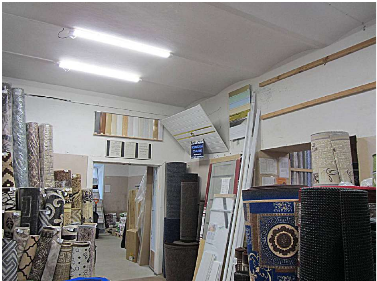
9. Казарма Офицерской стрелковой школы по адресу: г. Ломоносов, Александровская ул., д. 19. Фрагмент интерьера. Общий вид помещения с прусскими сводами. Фото 25.01.2023.
