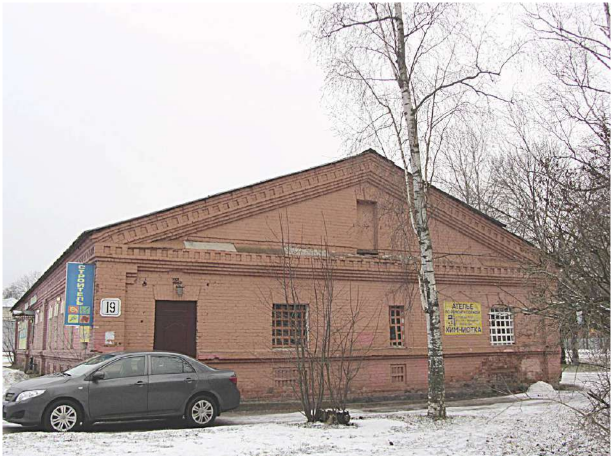
2. Казарма Офицерской стрелковой школы по адресу: г. Ломоносов, Александровская ул., д. 19. Общий вид торцевого северо-восточного фасада. Фото 25.01.2023.
