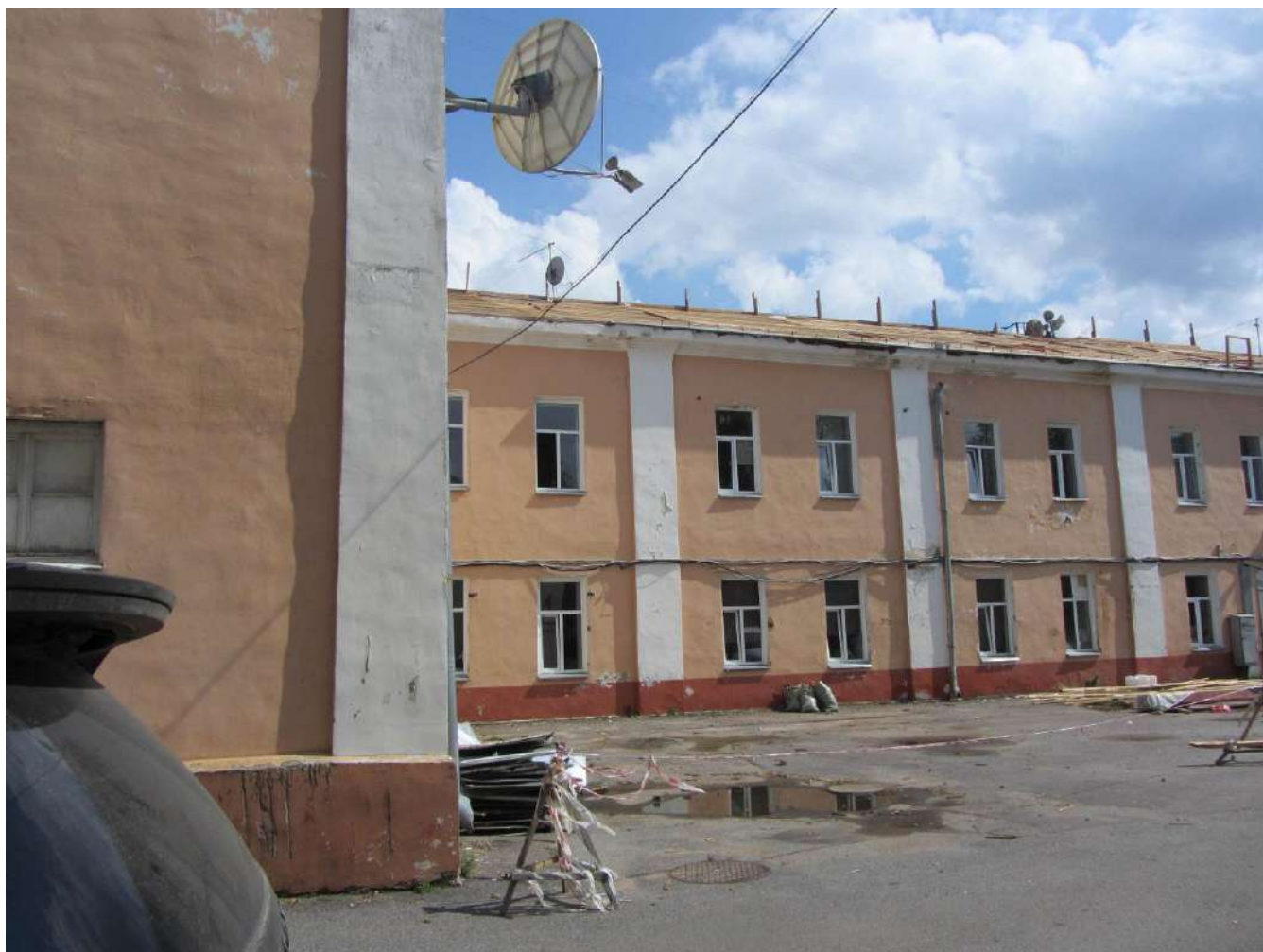
5. Казарма Офицерской стрелковой школы по адресу: г. Ломоносов, Владимирская ул., 19. Общий вид дворовых фасадов. Вид с северо-запада. Фото 01.06.2022.
