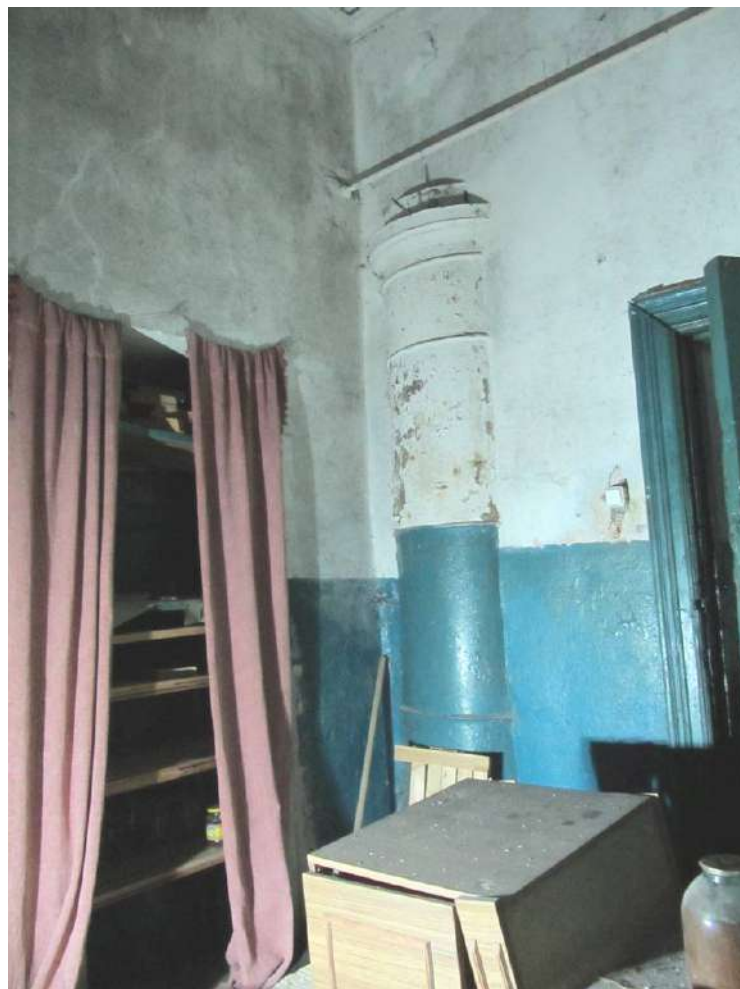
9, 10. Казарма Офицерской стрелковой школы по адресу: г. Ломоносов, Александровская ул., 24а. Фрагменты интерьера. Фото 25.01.2023.
