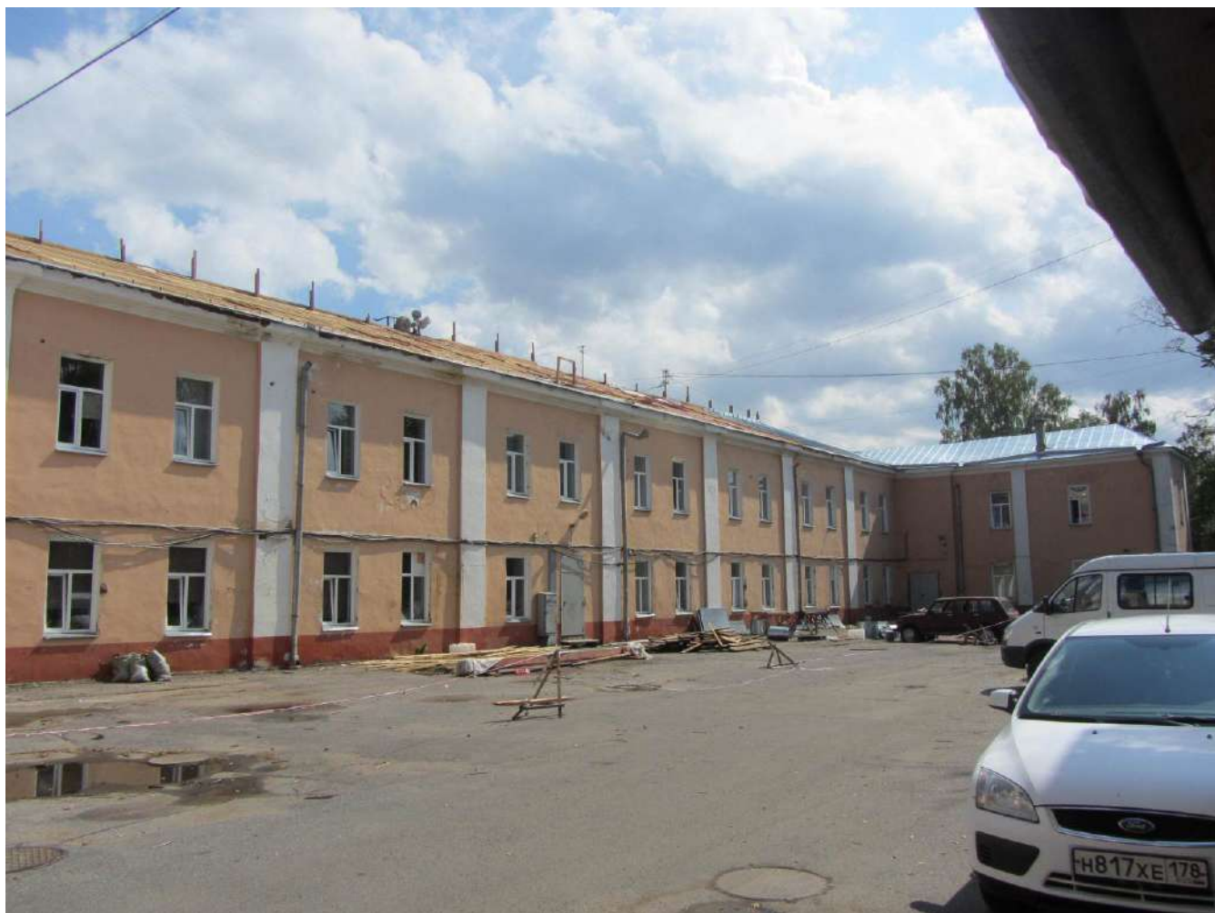
3. Казарма Офицерской стрелковой школы по адресу: г. Ломоносов, Владимирская ул., 19. Общий вид дворового фасада. Вид с северо-запада. Фото 01.06.2022.
