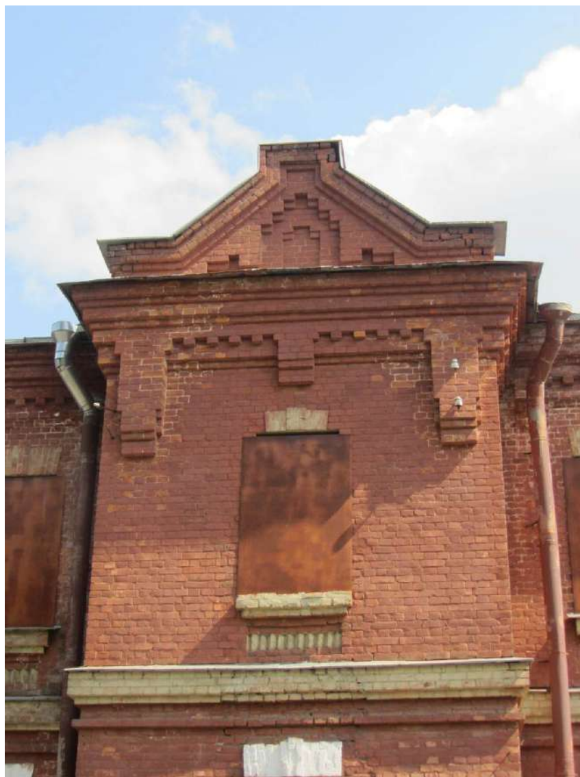
5. Казарма Офицерской стрелковой школы по адресу: г. Ломоносов, Владимирская ул., 12. Фрагмент лицевого фасада. Южный ризалит. Завершение. Фото 01.06.2022.
