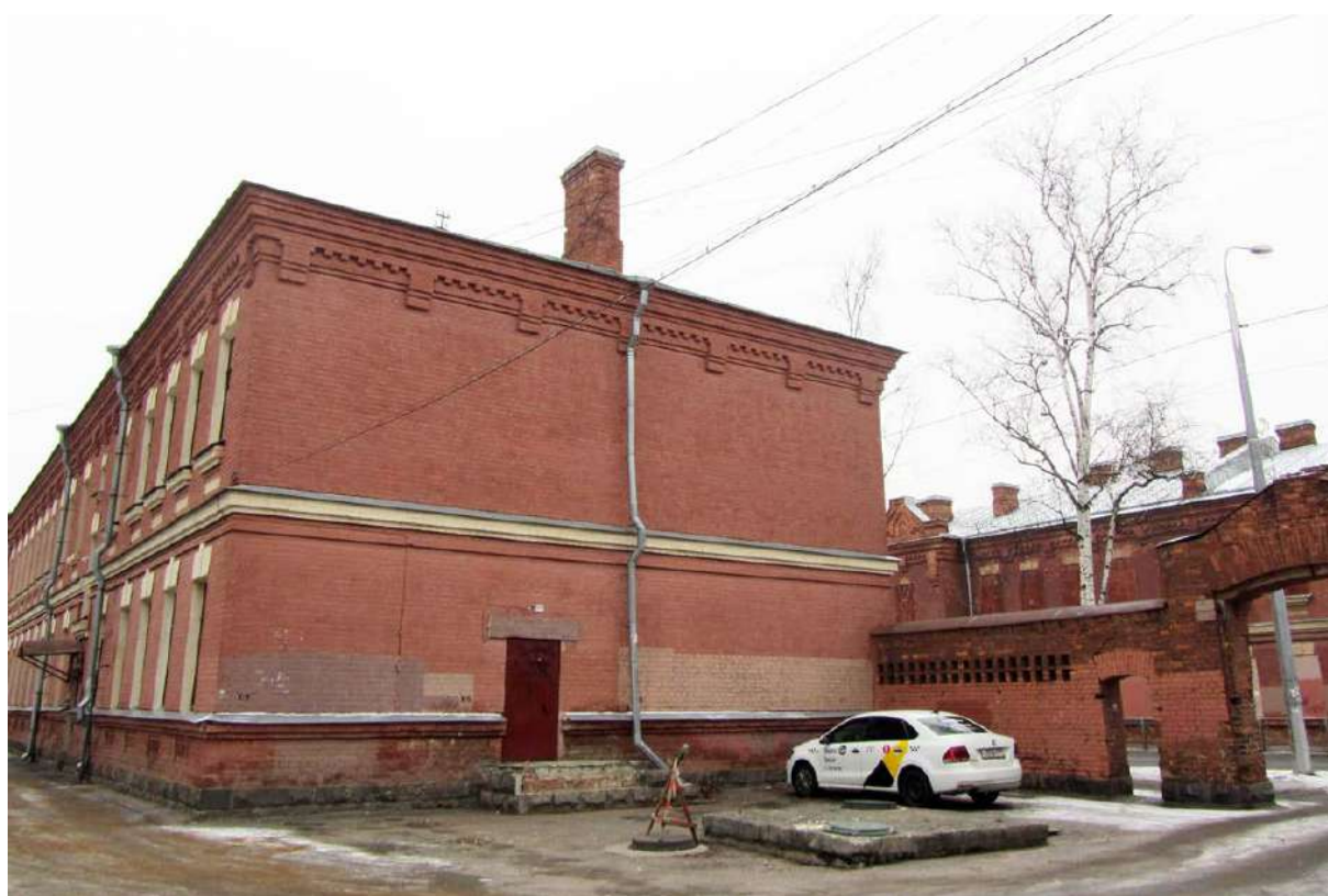
8. Казарма Офицерской стрелковой школы по адресу: г. Ломоносов, Александровская ул., д. 15. Торцевой восточный фасад. Фото 25.01.2023.
