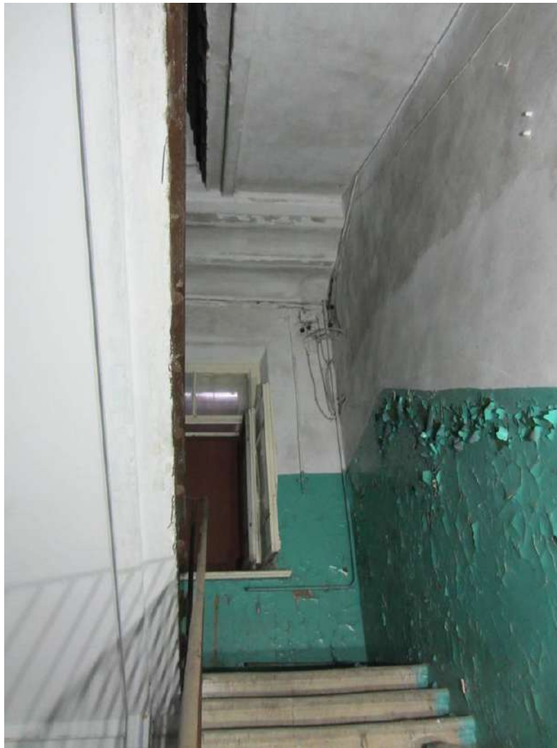
5. Казарма Офицерской стрелковой школы по адресу: г. Ломоносов, Александровская ул., 24а. Фрагмент интерьера. Общий вид лестницы. Фото 25.01.2023.
