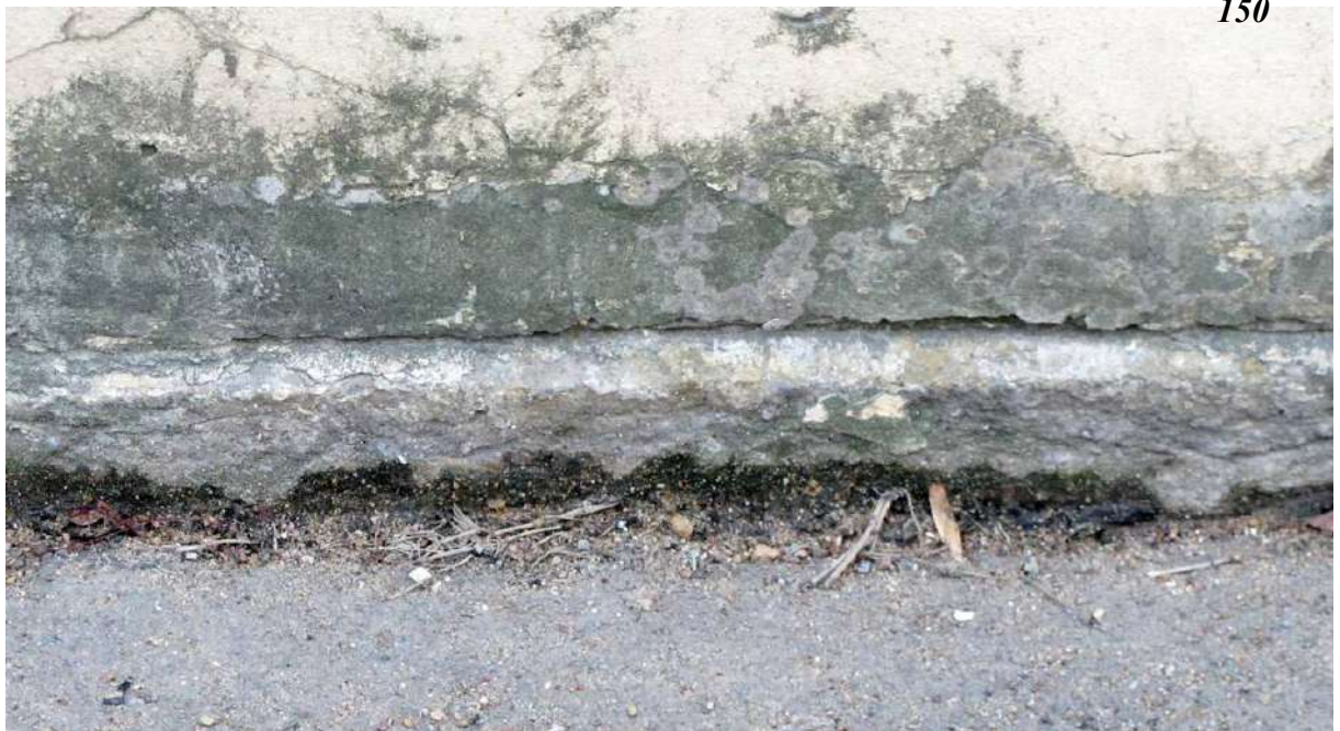
5. Казарма Офицерской стрелковой школы по адресу: г. Ломоносов, Александровская ул., д. 13. Фрагмент лицевого фасада. Цокольная часть. Фото 25.01.2023.
