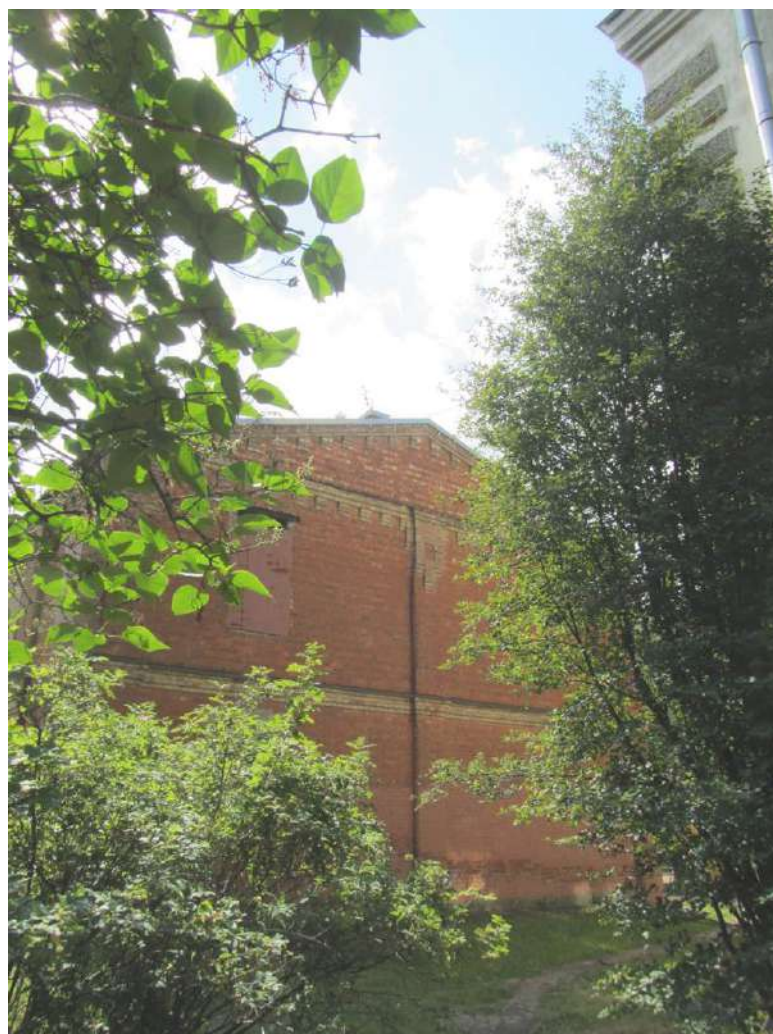
4. Казарма Офицерской стрелковой школы по адресу: г. Ломоносов, Владимирская ул., 15 Общий вид северного торцевого фасада здания. Фото 01.06.2022.
