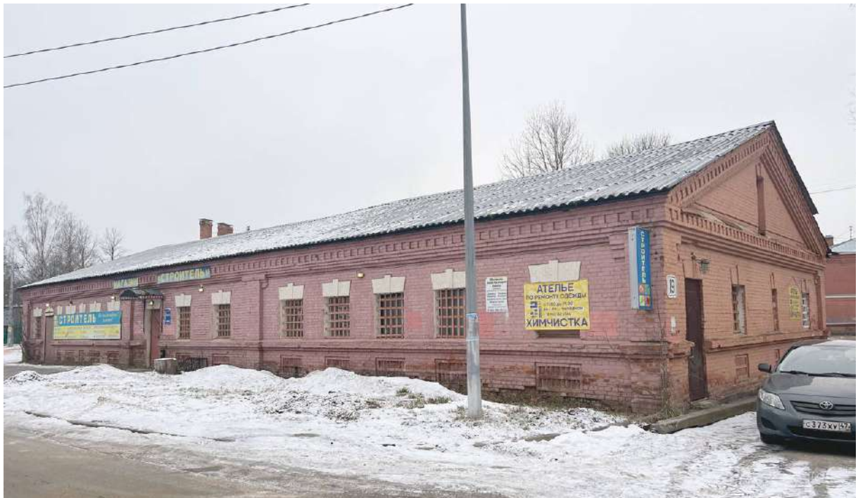
3. Казарма Офицерской стрелковой школы по адресу: г. Ломоносов, Александровская ул., д. 19. Общий вид здания с востока. Фото 25.01.2023.
