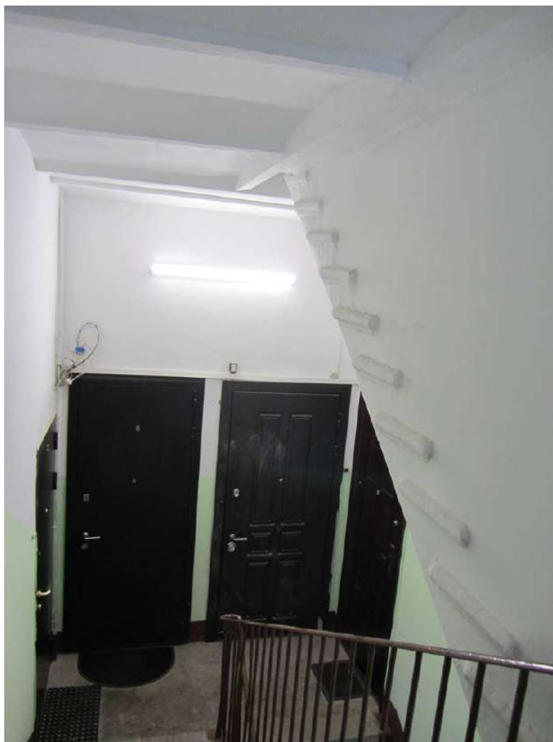
11. Казарма Офицерской стрелковой школы по адресу: г. Ломоносов, Александровская ул., д. 15. Фрагмент интерьера. Лестничная площадка второго этажа. Фото 25.01.2023.
