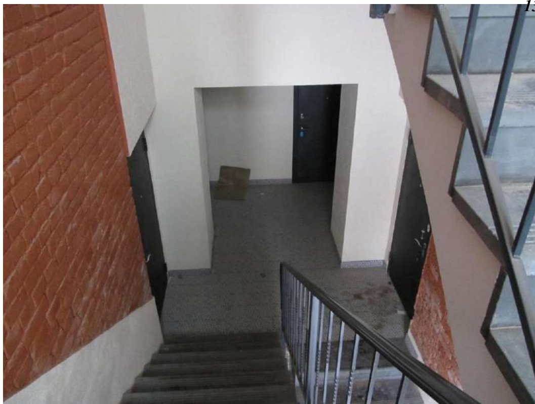
8. Казарма Офицерской стрелковой школы по адресу: г. Ломоносов, Владимирская ул., 16а. Фрагмент интерьера. Лестница. Вид на площадку 1-го этажа. Фото 25.01.2023.
