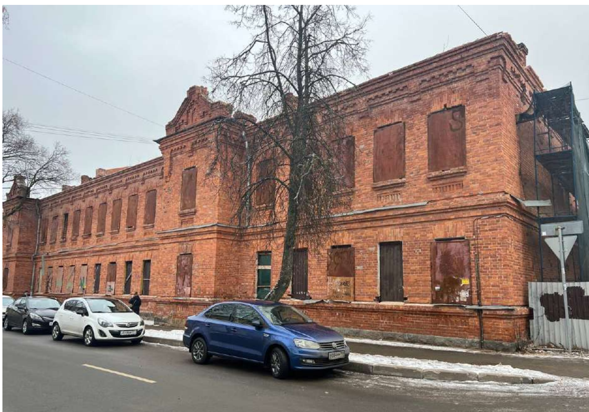
1. Казарма Офицерской стрелковой школы по адресу: г. Ломоносов, Владимирская ул., д. 16. Общий вид лицевого фасада с юга. Фото 25.01.2023.
