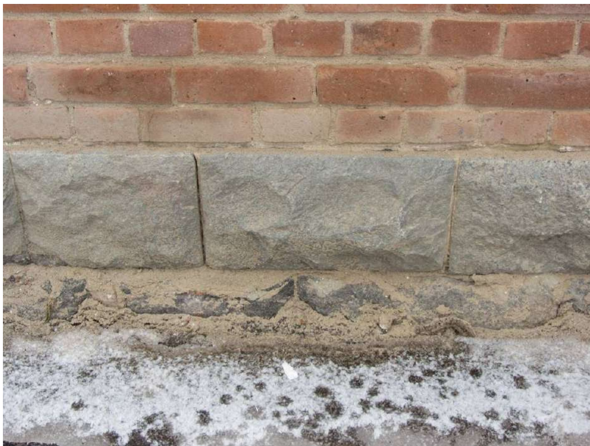
7. Казарма Офицерской стрелковой школы по адресу: г. Ломоносов, Владимирская ул., 16а. Фрагмент северного фасада. Цоколь. Фото 25.01.2023.
