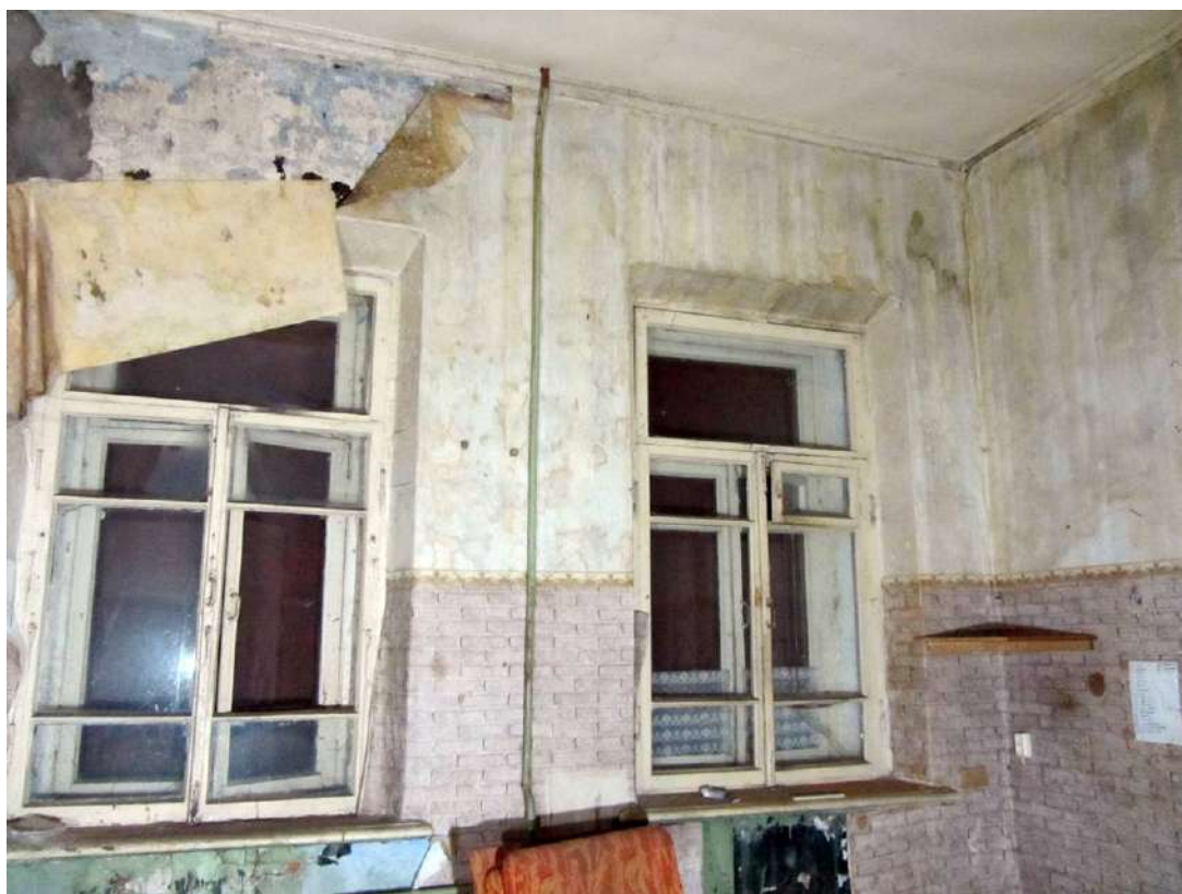
17, 18. Казарма Офицерской стрелковой школы по адресу: г. Ломоносов, Владимирская ул., 12. Фрагменты интерьера. Фото 01.06.2022.
