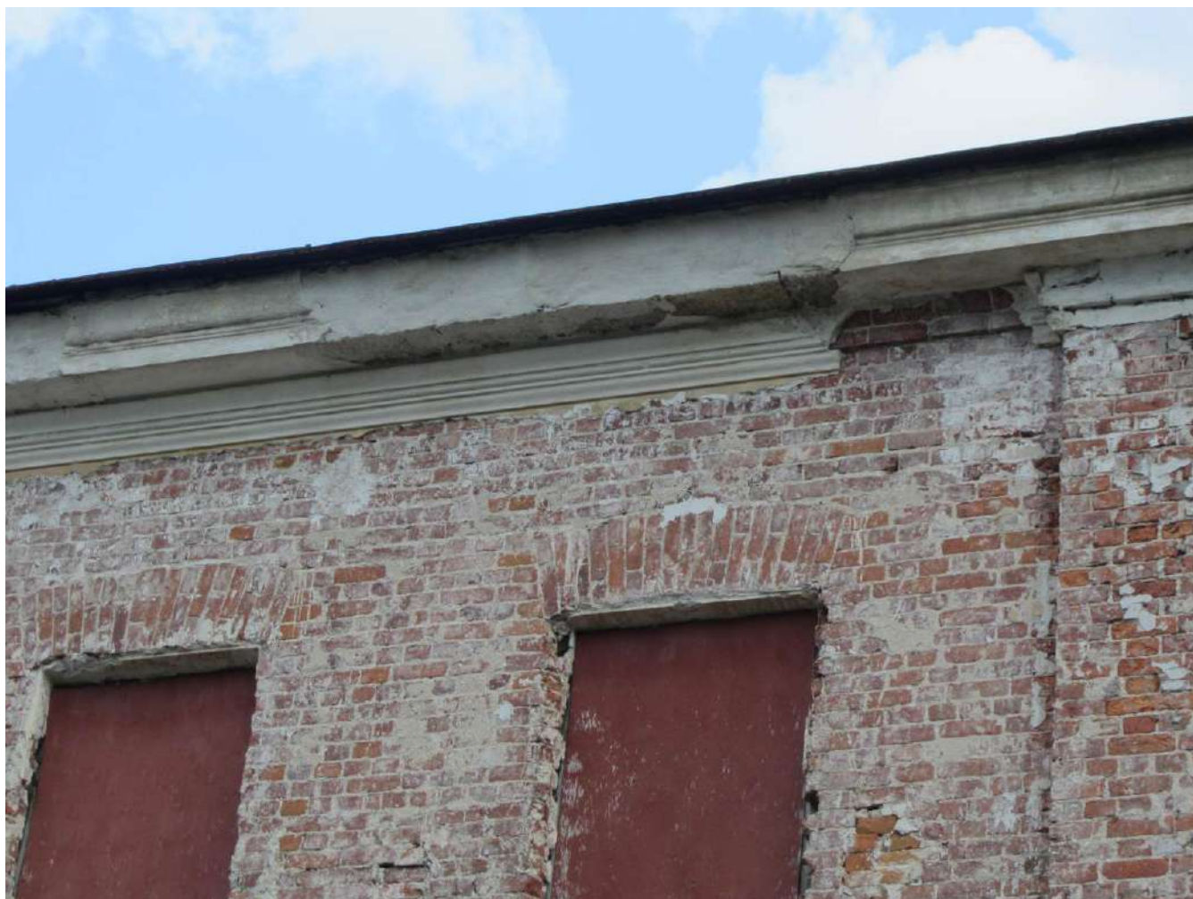
7. Казарма Офицерской стрелковой школы по адресу: г. Ломоносов, Владимирская ул., 10. Фрагмент западного лицевого фасада. Карнизная часть. Фото 01.06.2022.
