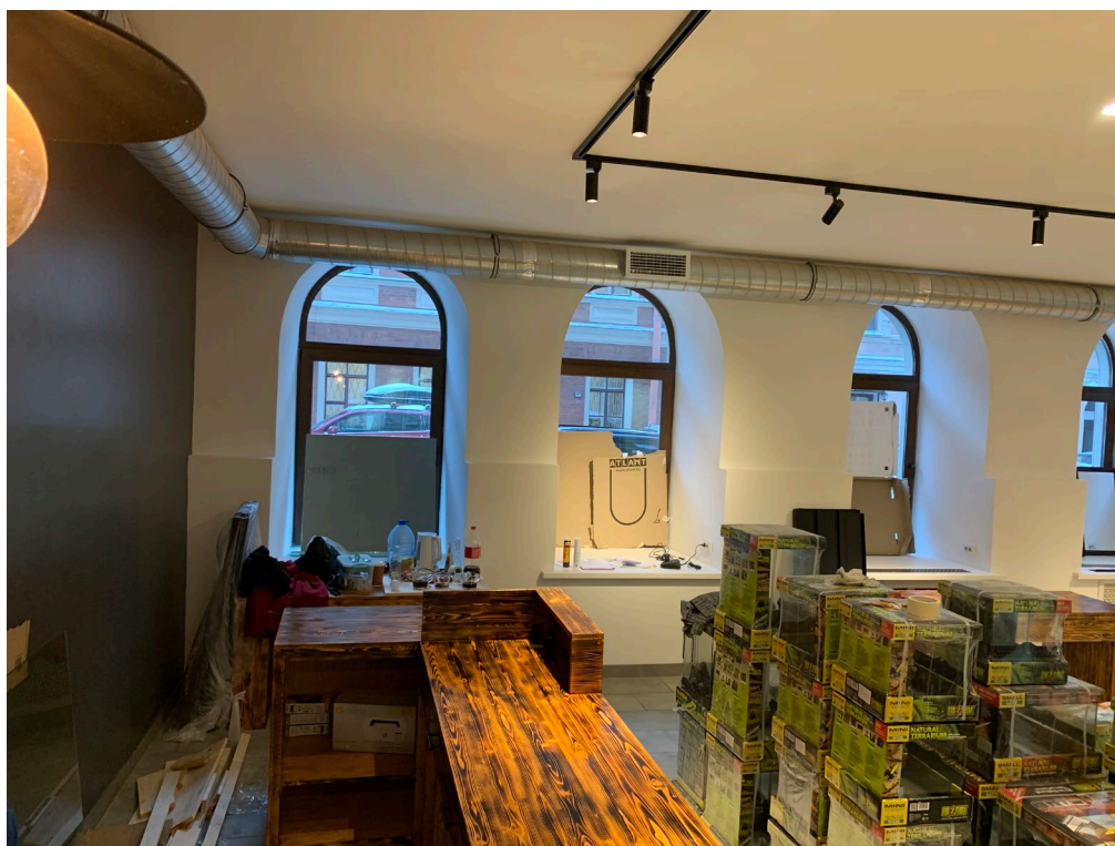
Фото 8. Торговый зал. Общий вид со стороны входа в кормовую. Окна.
