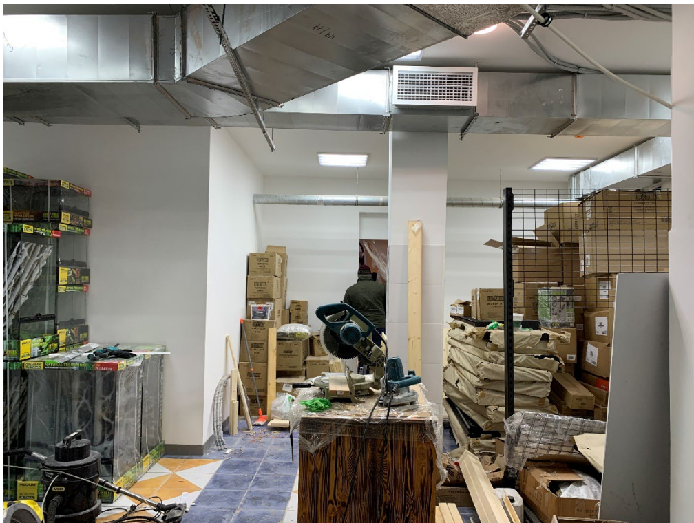
Фото 14. Общий вид склада.
