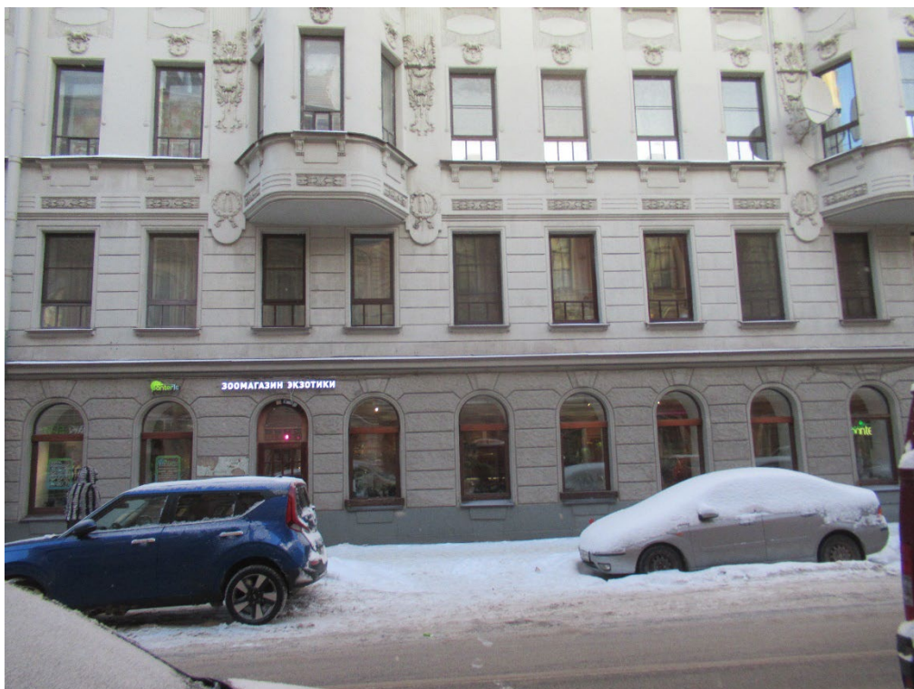
Фото 1. Общий вид здания со стороны ул. Зверинская.
