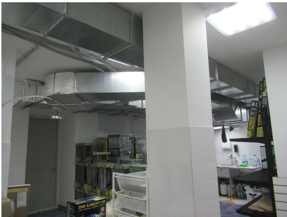
Фото 13. Общий вид склада.
