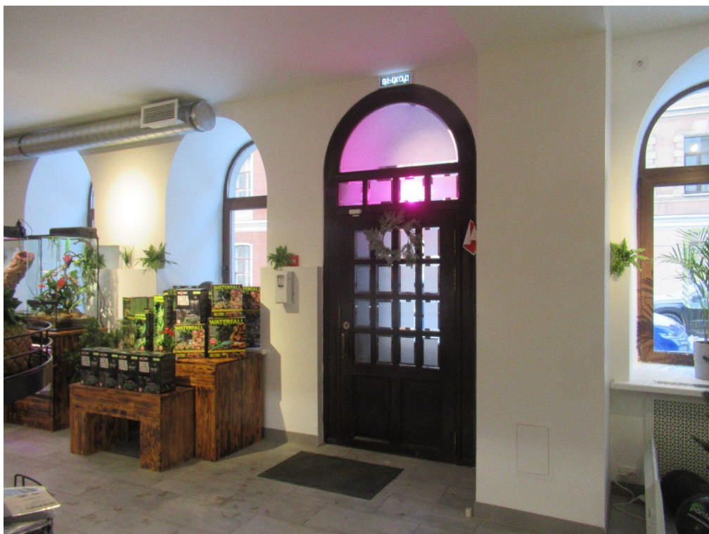
Фото 2. Вид на фрагмент входной группы.
