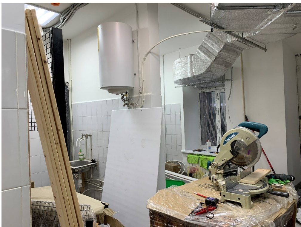
Фото 15. Общий вид склада.
