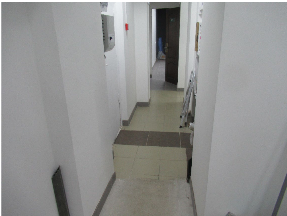
Фото 10. Общий вид коридора.
