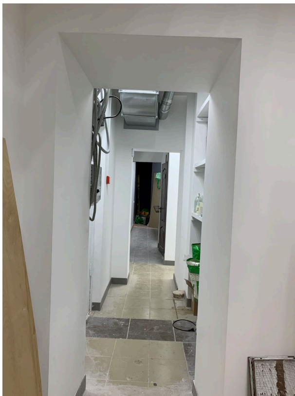
Фото 13. Коридор. Общий вид со стороны склада.
