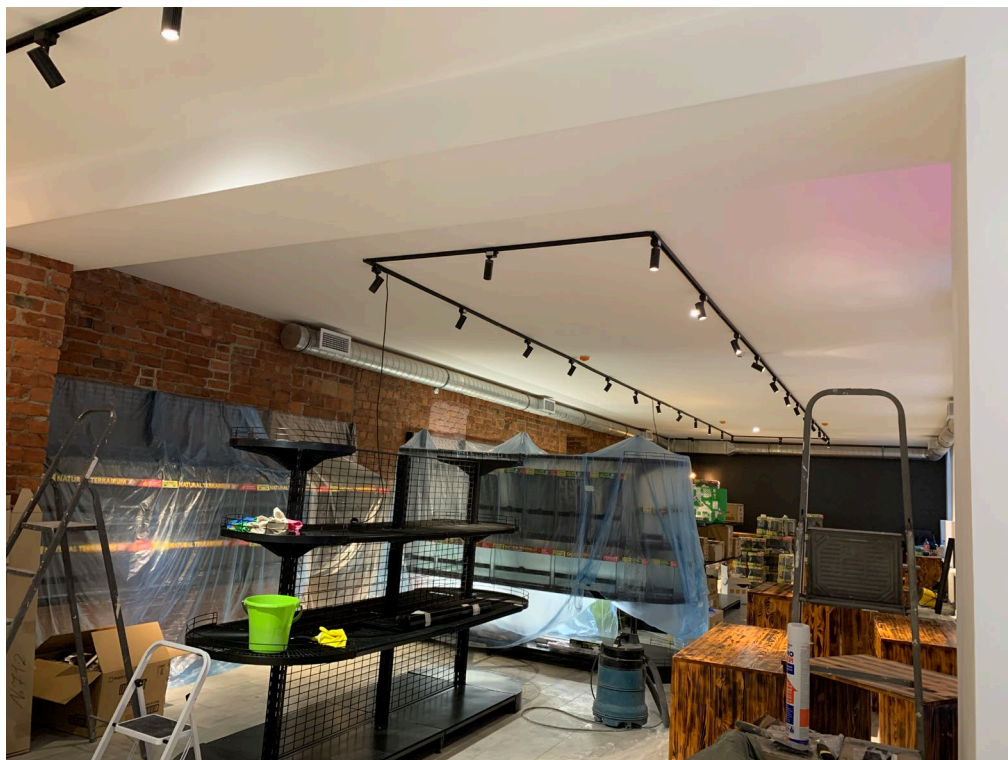
Фото 1. Торговый зал. Общий вид со стороны главного входа.
