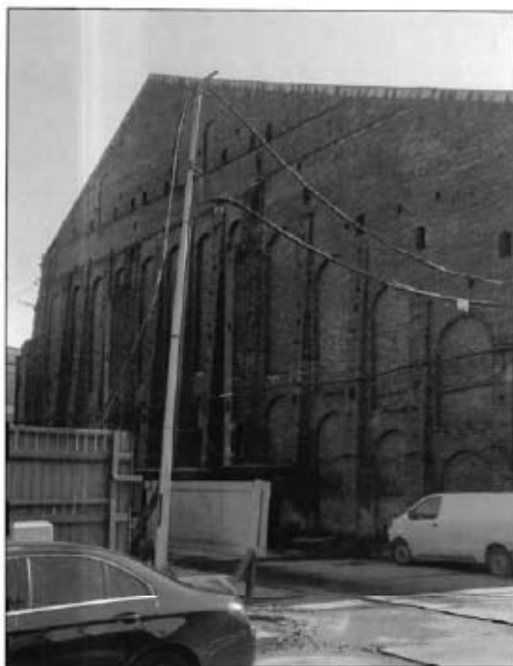
18. Северный торцевой фасад объекта культурного наследия.
