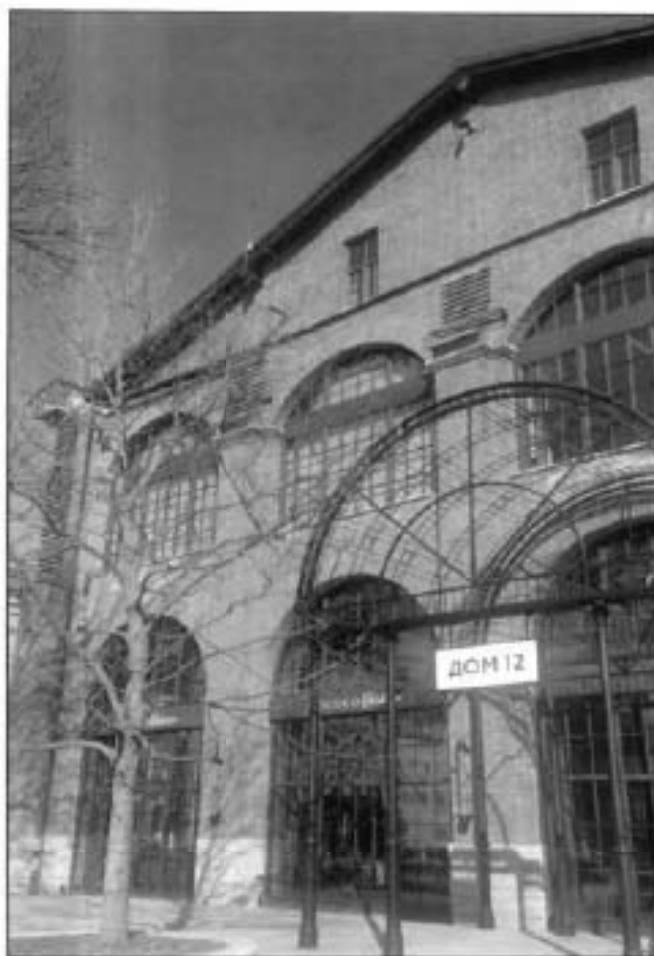
6. Фрагмент западного фасада объекта культурного наследия.
