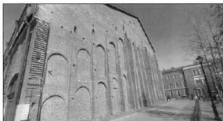
7. Южный фасад объекта культурного наследия.
