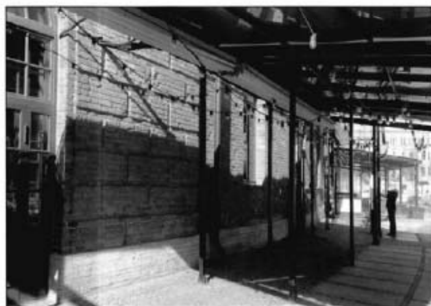
4. Фрагмент восточного фасада объекта культурного наследия.
