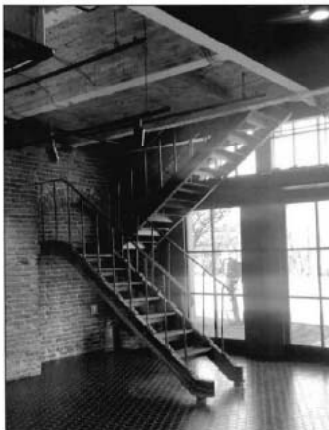
9. Металлическая лестница (пом. 1-Н (21)).
