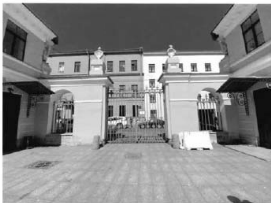
2. Южный фасад объекта культурного наследия.
