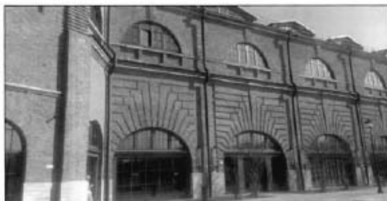
5. Фрагмент западного фасада объекта культурного наследия.
