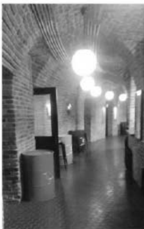
5. Вид на пом. 1-Н (31) объекта культурного наследия (фотография от 18.03.2022)
