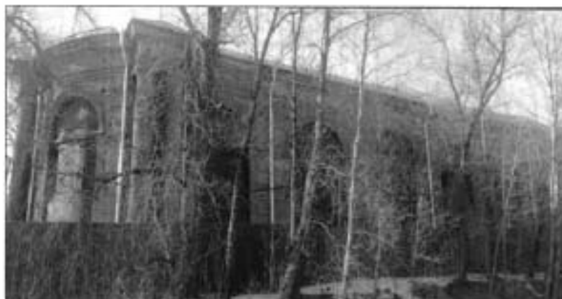
15. Фрагмент восточного фасада объекта культурного наследия.
