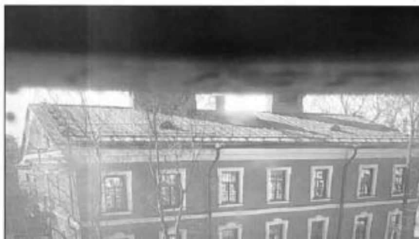
5. Кровля объекта культурного наследия.
