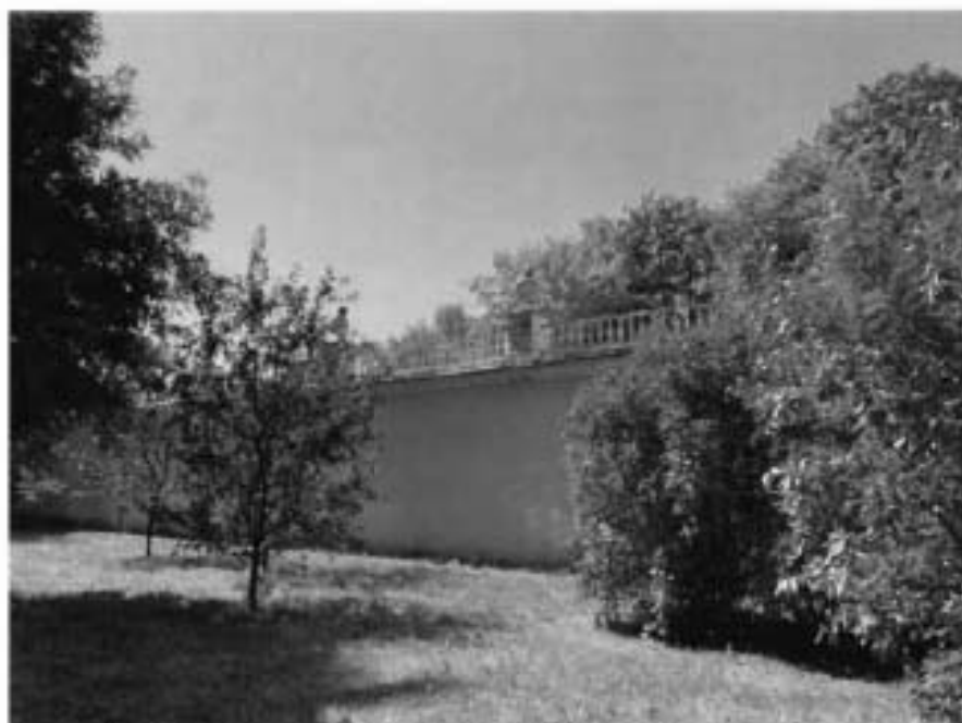
2. Фрагмент восточного фасада объекта культурного наследия.
