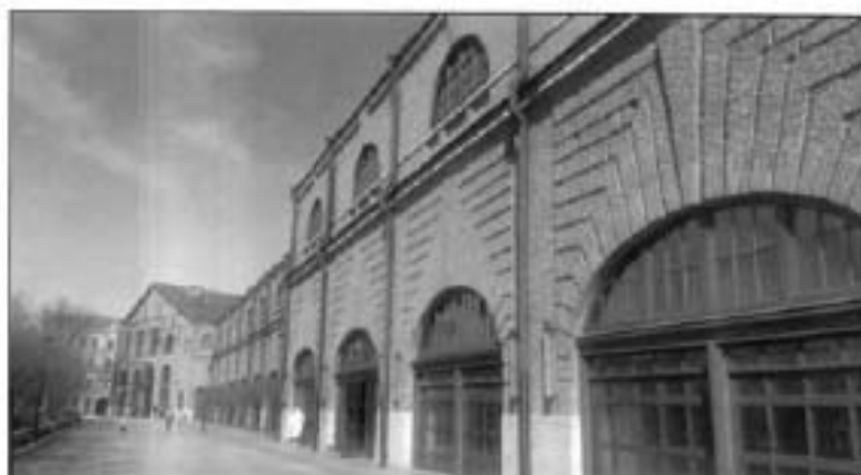
3. Западный фасад объекта культурного наследия.
