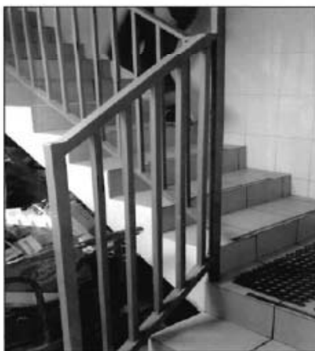
6. Лестница (пом. 1-Н (24, 30)).
