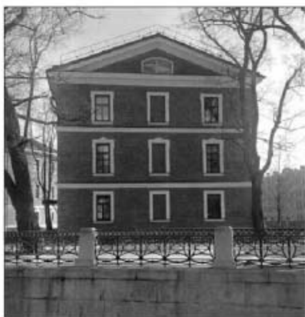
4. Западный фасад объекта культурного наследия.
