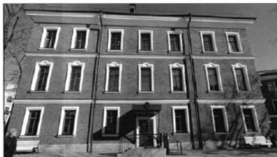
2. Южный фасад объекта культурного наследия.
