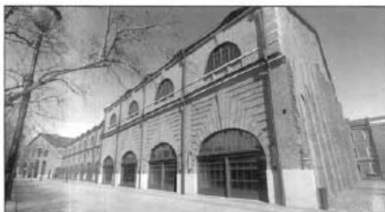
4. Западный фасад объекта культурного наследия.
