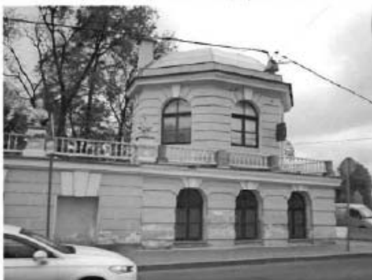
1. Западный фасад со стороны Ново-Адмиралтейского канала
