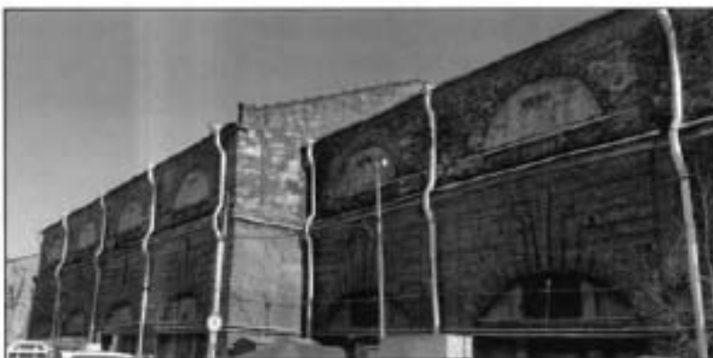
17. Фрагмент западного дворового фасада объекта культурного наследия.
