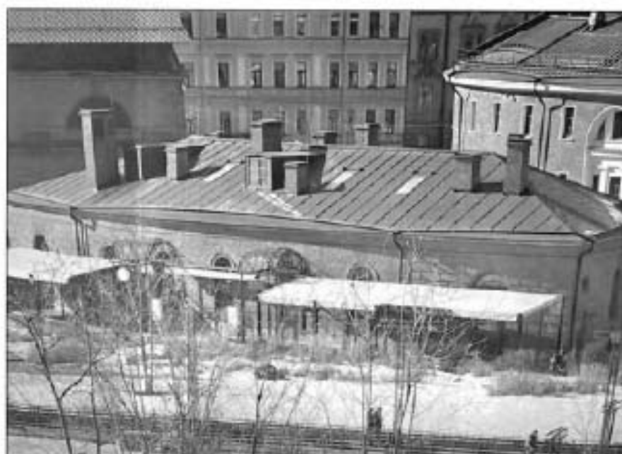
3. Вид на восточный фасад и кровлю объекта культурного наследия.
