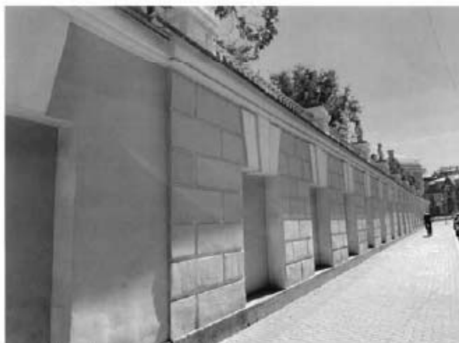
3. Фрагмент западного фасада объекта культурного наследия.
