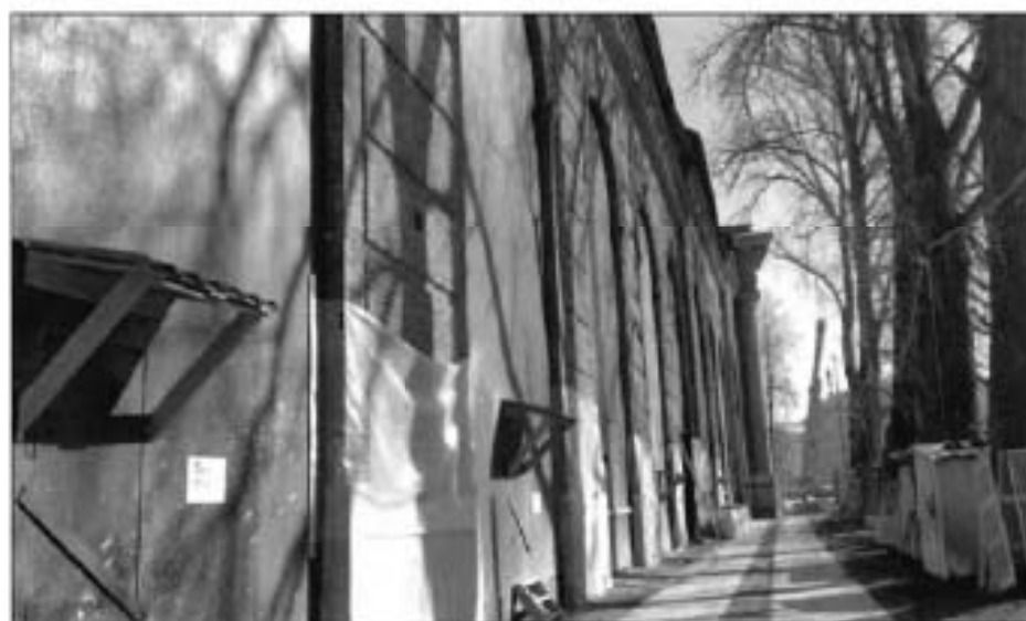
27. Фрагмент южного дворового фасада объекта культурного наследия.
