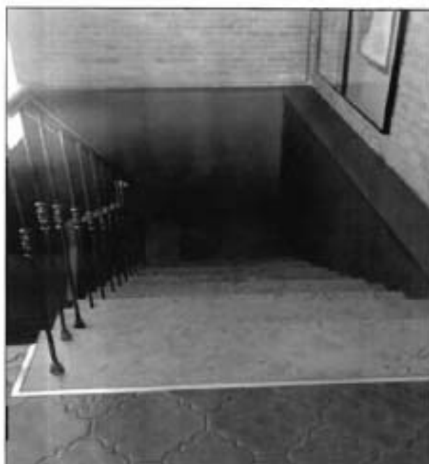
5. Лестница (пом. 1-Н (11, 25, 40)).
