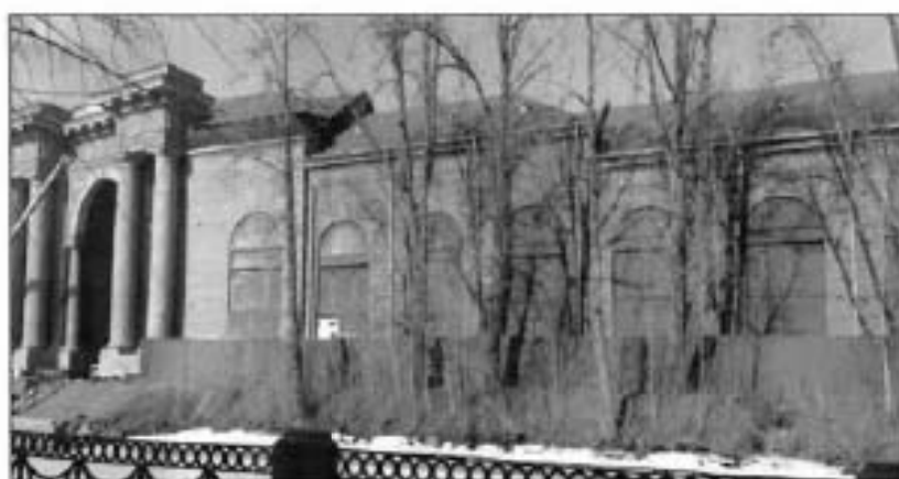
14. Фрагмент южного лицевого фасада объекта культурного наследия.
