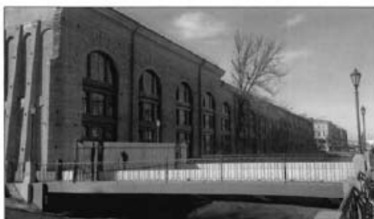
1. Лицевой фасад объекта культурного наследия.
