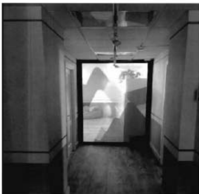
10. Интерьера. Помещение 1-Н (16).
