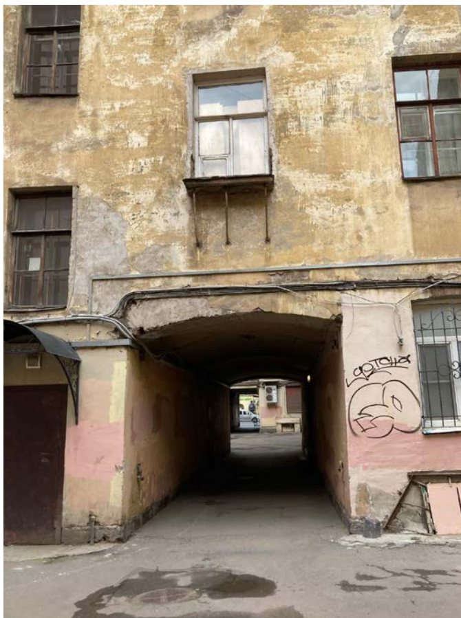
Фото 9. Фрагмент дворового фасада объекта культурного наследия регионального значения «Дом Единоверческой церкви Св. Николая», воротный проезд во дворе
