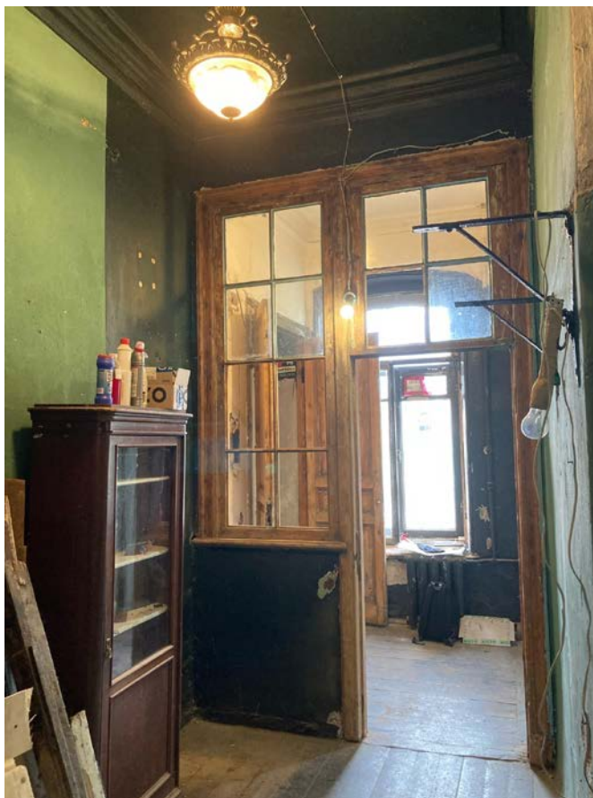
Фото 21. Интерьер квартиры №39 объекта культурного наследия регионального значения «Дом Единоверческой церкви Св. Николая».
