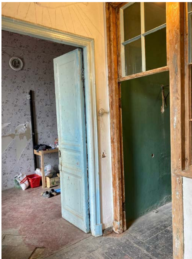
Фото 17. Интерьер квартиры №39 объекта культурного наследия регионального значения «Дом Единоверческой церкви Св. Николая».
