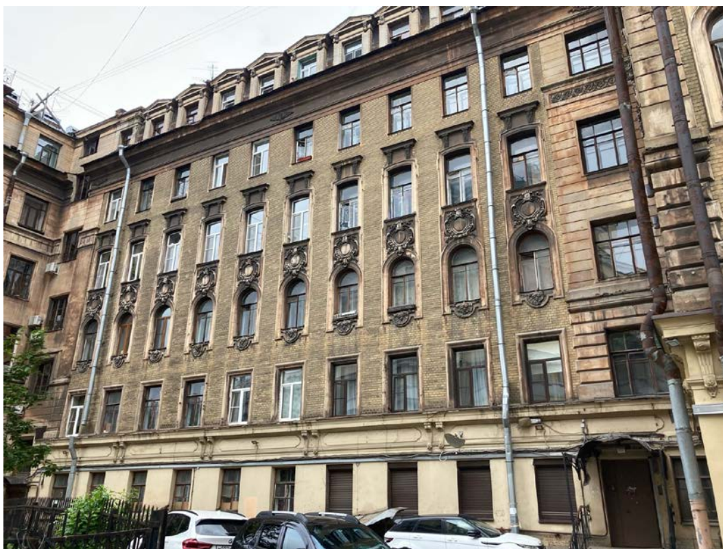
Фото 5. Лицевой фасад объекта культурного наследия регионального значения «Дом Единоверческой церкви Св. Николая».
