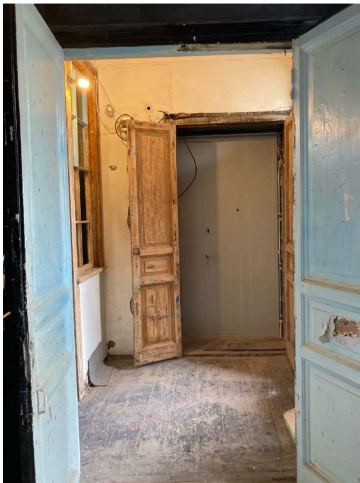
Фото 19. Интерьер квартиры №39 объекта культурного наследия регионального значения «Дом Единоверческой церкви Св. Николая».
