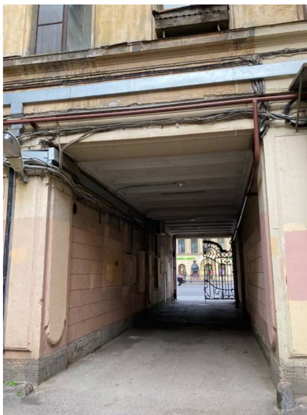
Фото 12. Фрагмент дворового фасада объекта культурного наследия регионального значения «Дом Единоверческой церкви Св. Николая», воротный проезд на ул. Марата
