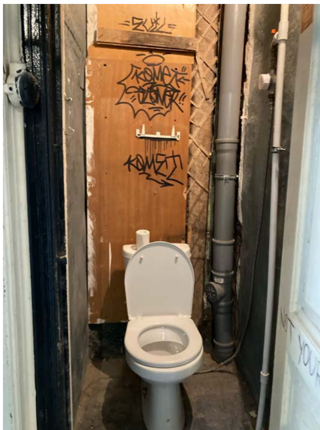
Фото 25. Интерьер квартиры №39 объекта культурного наследия регионального значения «Дом Единоверческой церкви Св. Николая».
