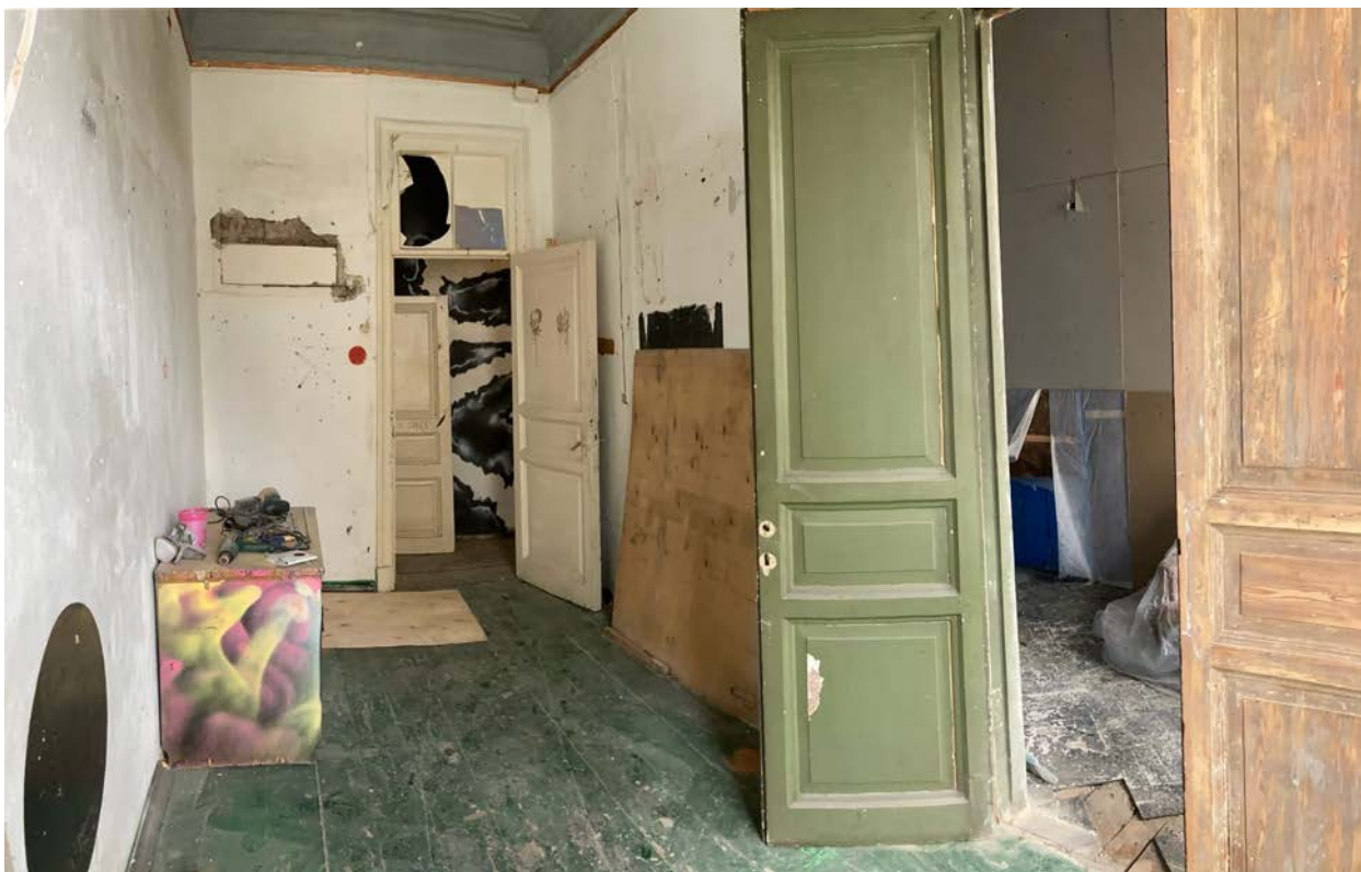
Фото 29. Интерьер квартиры №39 объекта культурного наследия регионального значения «Дом Единоверческой церкви Св. Николая».
