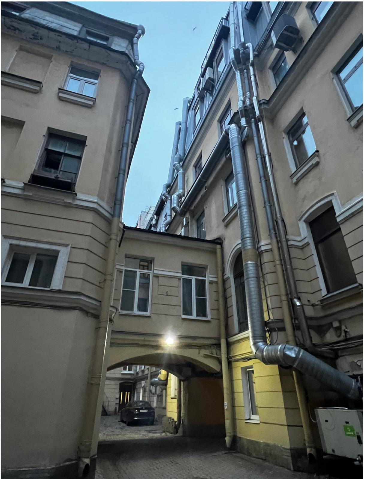
Фото 9. Вид на часть дворового фасада, наблюдается установка дополнительного оборудования, замена оконных заполнений.
