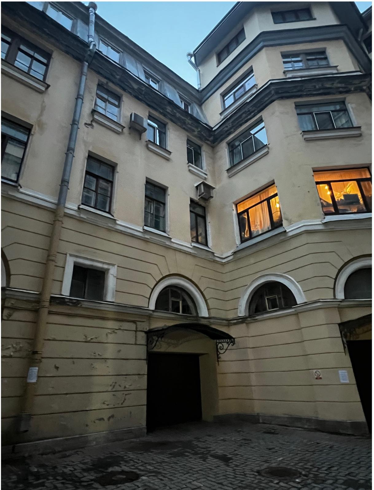
Фото 5. Вид на часть дворового фасада, наблюдается установка дополнительного оборудования, замена оконных заполнений.
