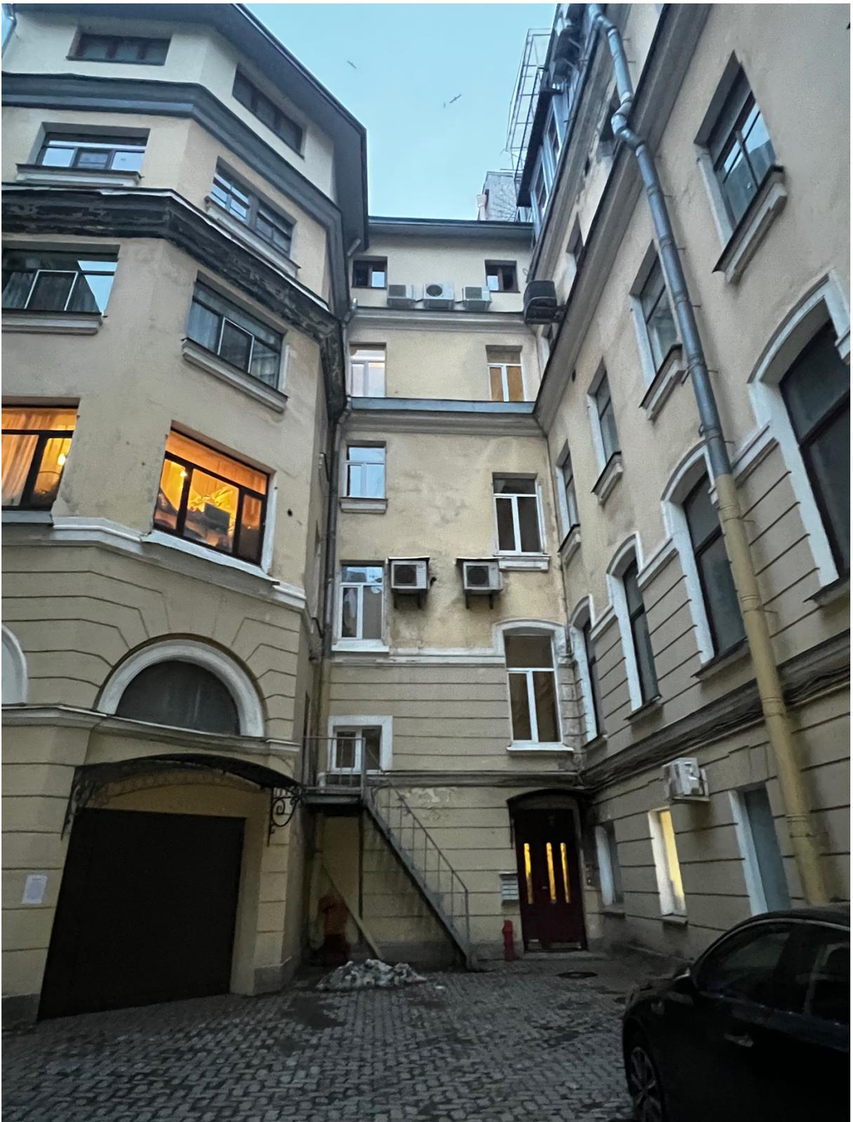
Фото 4. Вид на часть дворового фасада, наблюдается установка дополнительного оборудования, замена оконных заполнений.
