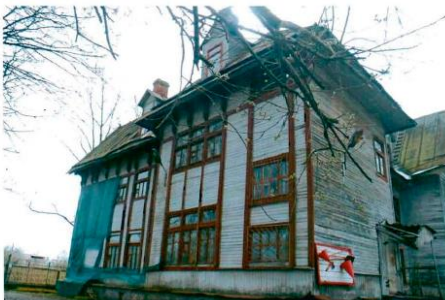
4. Вид на северный фасад.
