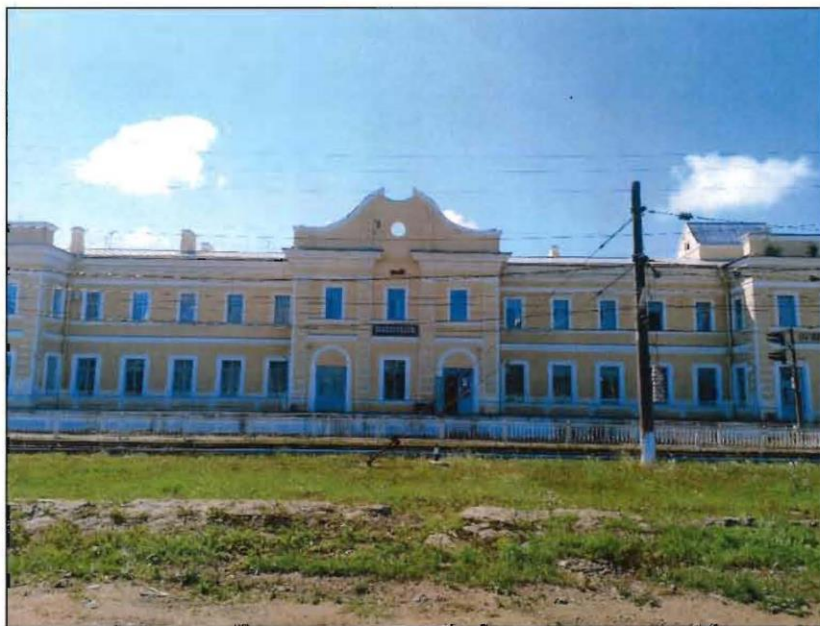
2. Северный фасад объекта культурного наследия.
