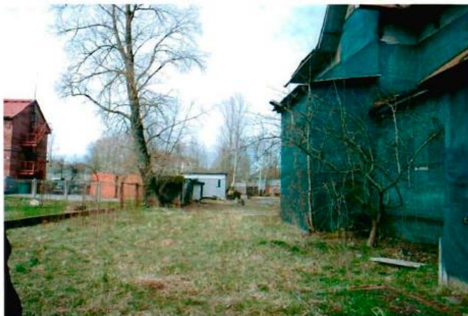
6. Вид на территорию со стороны южного фасада.
