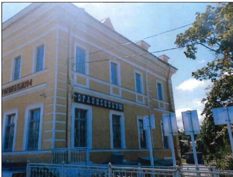
3. Западный фасад объекта культурного наследия.
