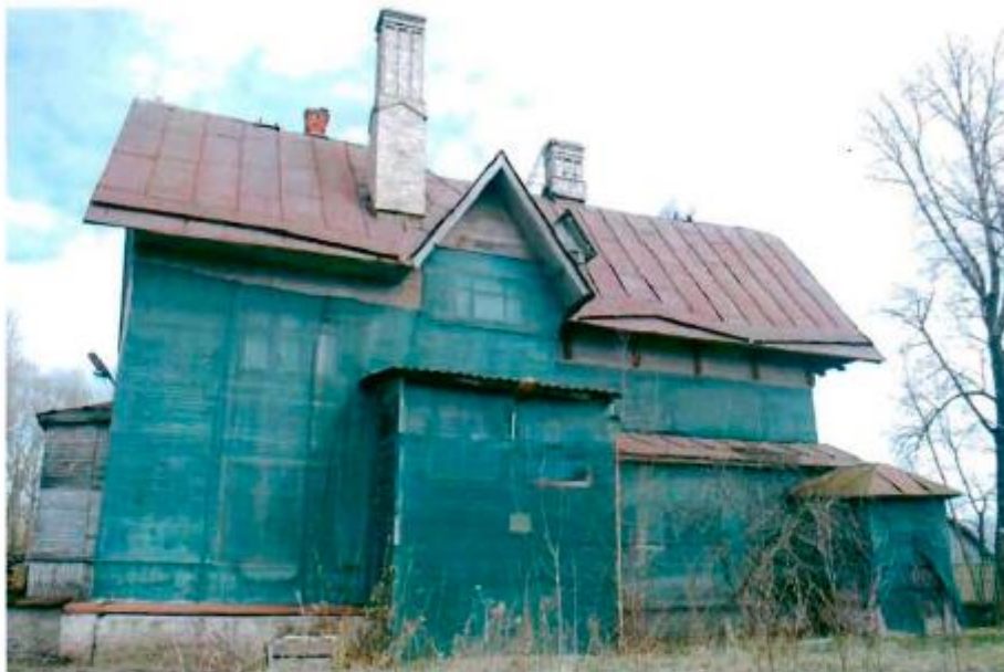
3. Вид на южный фасад.
