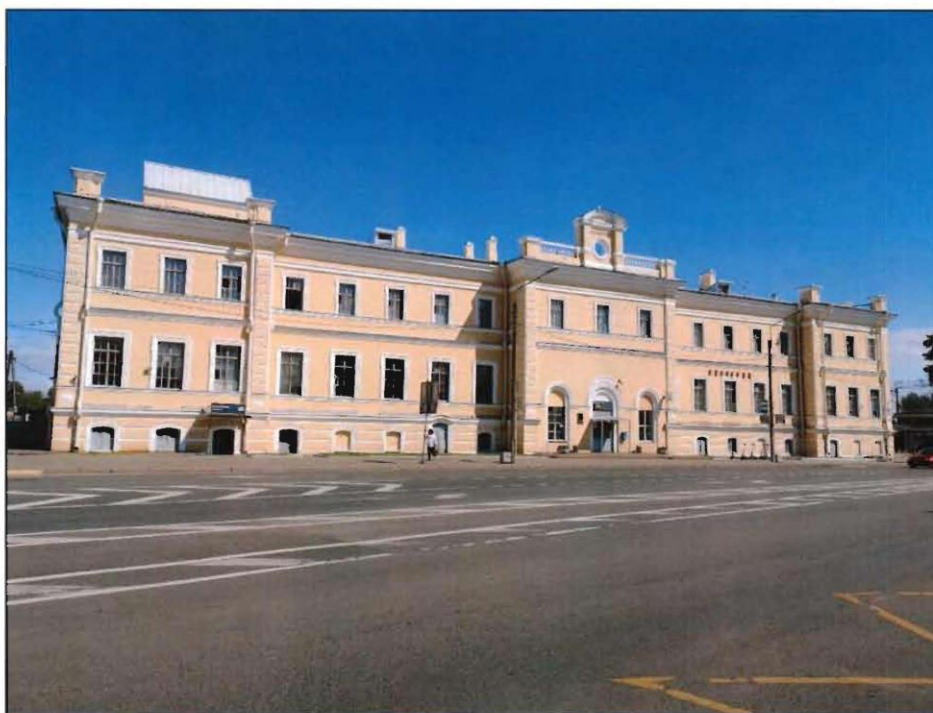
1. Общий вид на объект культурного наследия с южной стороны.
