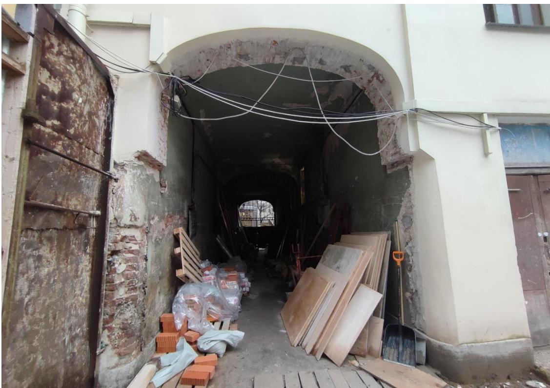
5. Объект культурного наследия федерального значения «Дом, где жили в 1912-1936 гг. – путешественник Грум-Гржимайло Г.Е., в 1914-1922 гг. – певец Шаляпин Ф.И.», по адресу: г. Санкт-Петербург, улица Графтио, дом 2б, литера А. Общий вид воротного проезда со стороны двора.
