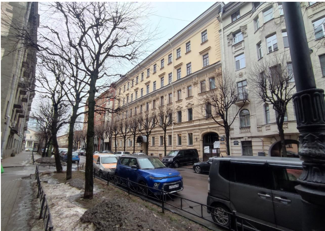
3. Объект культурного наследия федерального значения «Дом, где жили в 1912-1936 гг. – путешественник Грум-Гржимайло Г.Е., в 1914-1922 гг. – певец Шаляпин Ф.И.», по адресу: г. Санкт-Петербург, улица Графтио, дом 2б, литера А. Общий вид лицевого фасада по ул. Графтио.
