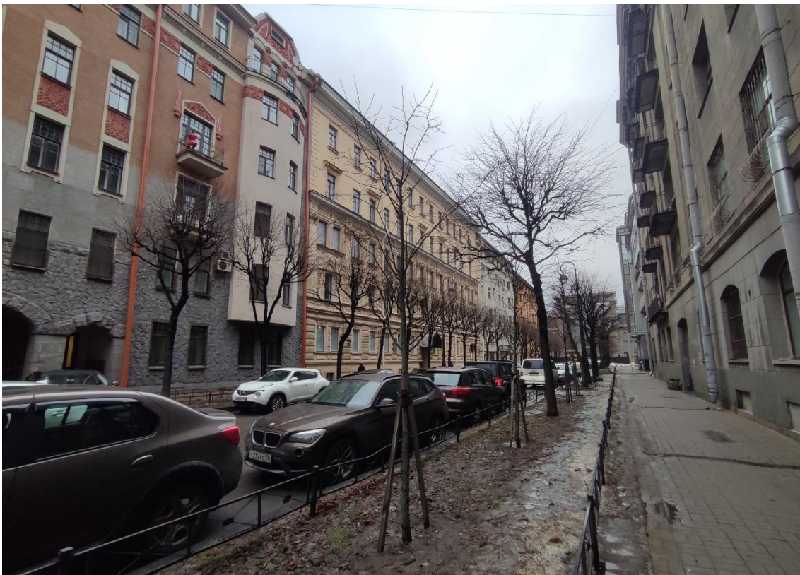
1. Объект культурного наследия федерального значения «Дом, где жили в 1912-1936 гг. – путешественник Грум-Гржимайло Г.Е., в 1914-1922 гг. – певец Шаляпин Ф.И.», по адресу: г. Санкт-Петербург, улица Графтио, дом 26, литера А. Общий вид в перспективе ул. Графтио.
