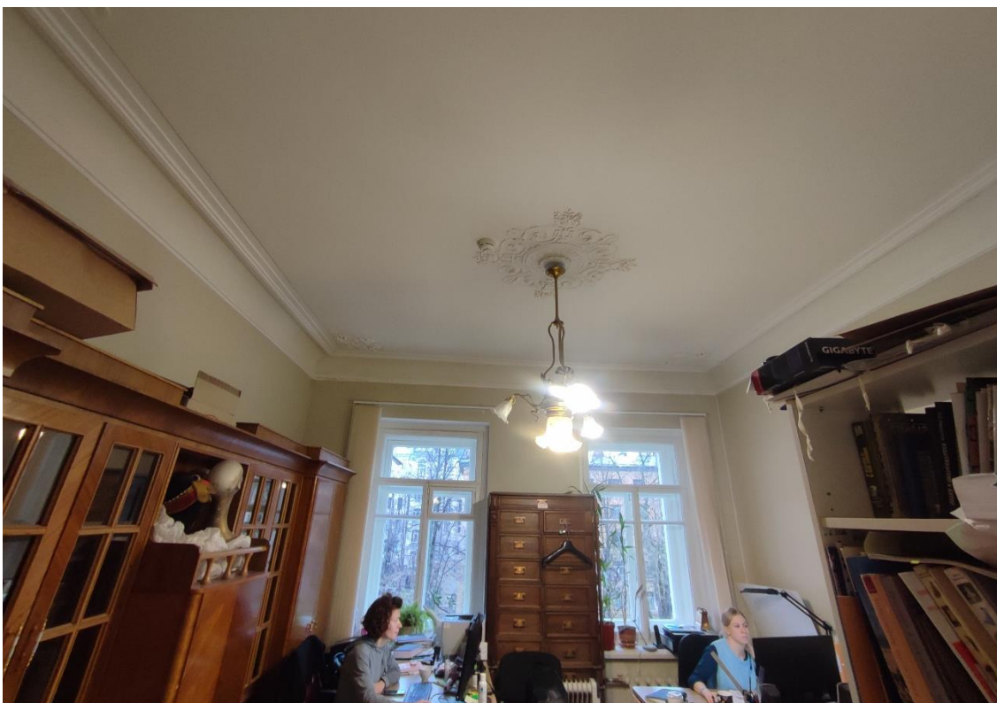
56. Объект культурного наследия федерального значения «Дом, где жили в 1912-1936 гг. – путешественник Грум-Гржимайло Г.Е., в 1914-1922 гг. – певец Шаляпин Ф.И.», по адресу: г. Санкт-Петербург, улица Графтио, дом 2б, литера А. Фрагмент пом. 1-Н (68) в уровне 3-го этажа.
