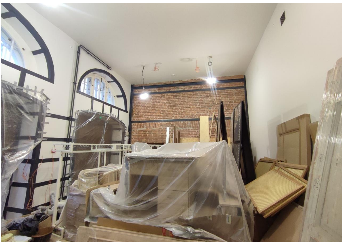
33. Объект культурного наследия федерального значения «Дом, где жили в 1912-1936 гг. – путешественник Грум-Гржимайло Г.Е., в 1914-1922 гг. – певец Шаляпин Ф.И.», по адресу: г. Санкт-Петербург, улица Графтио, дом 2б, литера А. Общий вид пом. 3-Н (1) и 4-Н (1) в уровне 1-го этажа.
