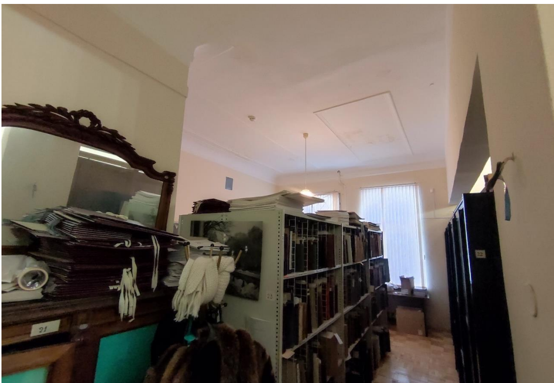
78. Объект культурного наследия федерального значения «Дом, где жили в 1912-1936 гг. – путешественник Грум-Гржимайло Г.Е., в 1914-1922 гг. – певец Шаляпин Ф.И.», по адресу: г. Санкт-Петербург, улица Графтио, дом 2б, литера А. Фрагмент пом. 1-Н (110) в уровне 5-го этажа.
