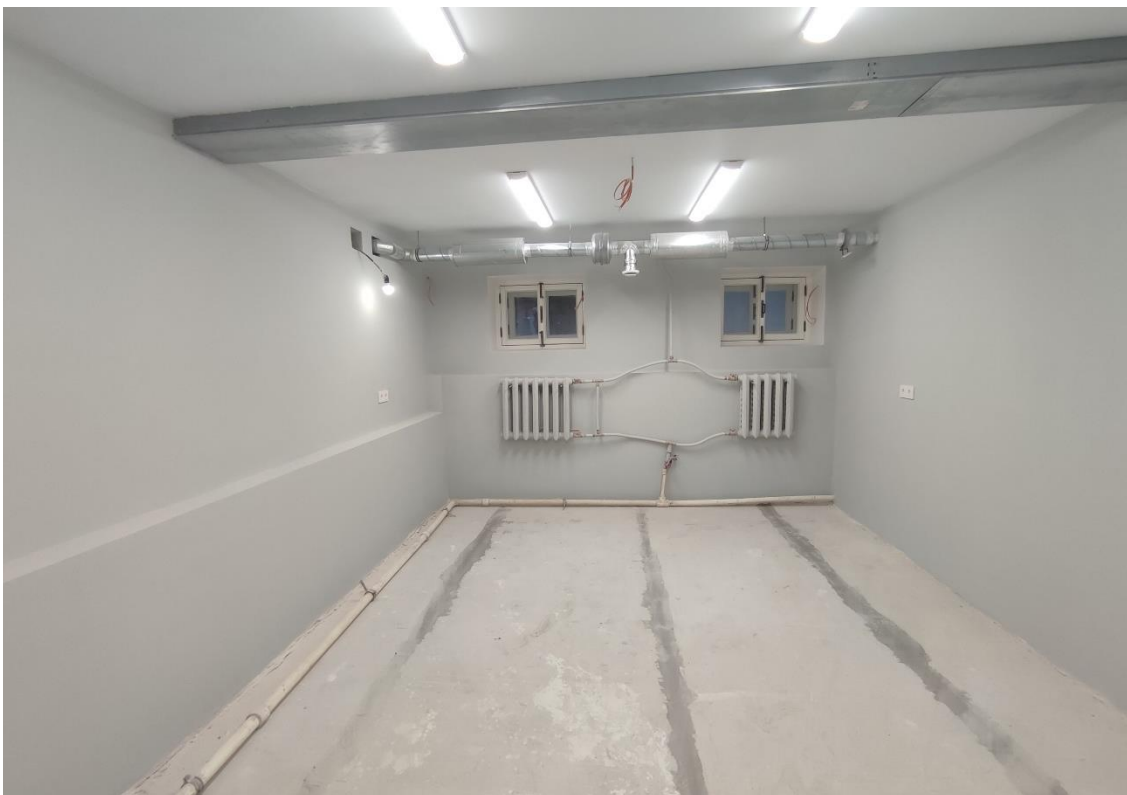
11. Объект культурного наследия федерального значения «Дом, где жили в 1912-1936 гг. – путешественник Грум-Гржимайло Г.Е., в 1914-1922 гг. – певец Шаляпин Ф.И.», по адресу: г. Санкт-Петербург, улица Графтио, дом 2б, литера А. Фрагмент пом. 1-Н (26) в уровне подвала.
