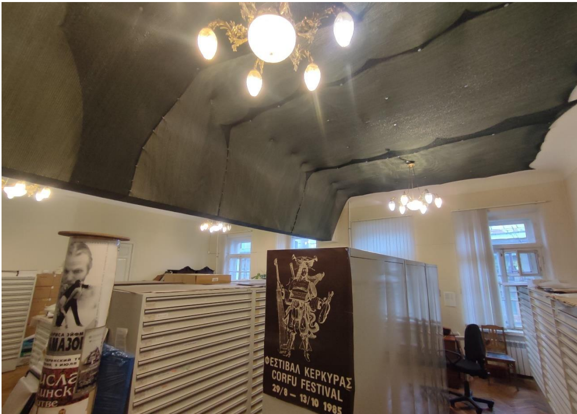
82. Объект культурного наследия федерального значения «Дом, где жили в 1912-1936 гг. – путешественник Грум-Гржимайло Г.Е., в 1914-1922 гг. – певец Шаляпин Ф.И.», по адресу: г. Санкт-Петербург, улица Графтио, дом 2б, литера А. Фрагмент пом. 1-Н (108) в уровне 5-го этажа.
