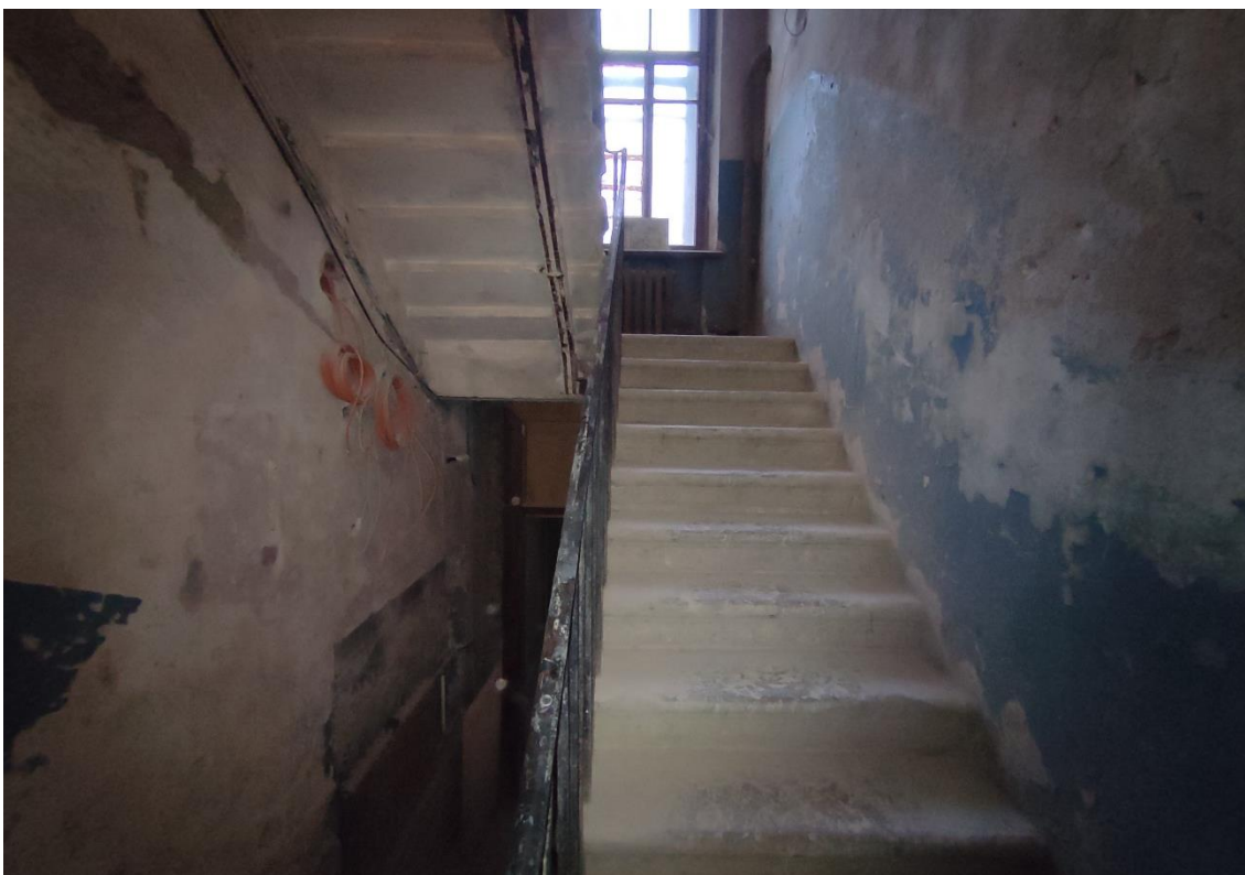
28. Объект культурного наследия федерального значения «Дом, где жили в 1912-1936 гг. – путешественник Грум-Гржимайло Г.Е., в 1914-1922 гг. – певец Шаляпин Ф.И.», по адресу: г. Санкт-Петербург, улица Графтио, дом 2б, литера А. Общий вид двухмаршевой лестницы (пом. 1-Н (14)) в уровне 1-го этажа.
