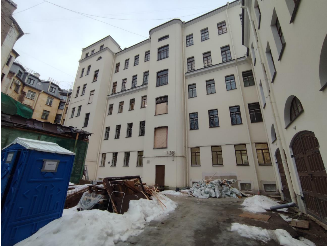
7. Объект культурного наследия федерального значения «Дом, где жили в 1912-1936 гг. – путешественник Грум-Гржимайло Г.Е., в 1914-1922 гг. – певец Шаляпин Ф.И.», по адресу: г. Санкт-Петербург, улица Графтио, дом 26, литера А. Общий вид дворового фасада лицевого корпуса.
