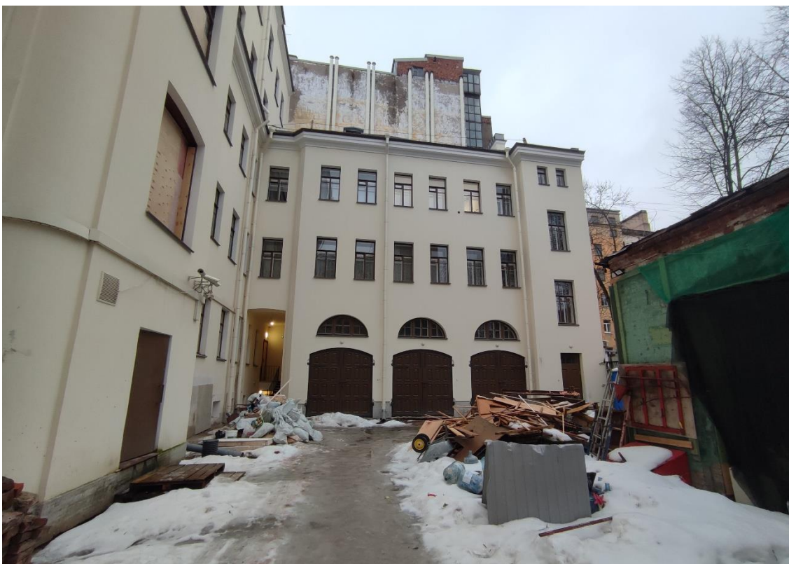
6. Объект культурного наследия федерального значения «Дом, где жили в 1912-1936 гг. – путешественник Грум-Гржимайло Г.Е., в 1914-1922 гг. – певец Шаляпин Ф.И.», по адресу: г. Санкт-Петербург, улица Графтио, дом 2б, литера А. Общий вид восточного фасада дворового флигеля.
