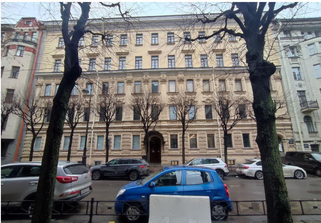
2. Объект культурного наследия федерального значения «Дом, где жили в 1912-1936 гг. – путешественник Грум-Гржимайло Г.Е., в 1914-1922 гг. – певец Шаляпин Ф.И.», по адресу: г. Санкт-Петербург, улица Графтио, дом 26, литера А. Общий вид лицевого фасада по ул. Графтио.
