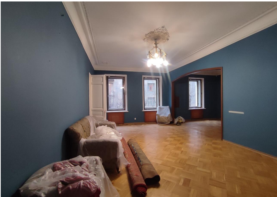
40. Объект культурного наследия федерального значения «Дом, где жили в 1912-1936 гг. – путешественник Грум-Гржимайло Г.Е., в 1914-1922 гг. – певец Шаляпин Ф.И.», по адресу: г. Санкт-Петербург, улица Графтио, дом 2б, литера А. Фрагмент пом. 1-Н (47) в уровне 2-го этажа.
