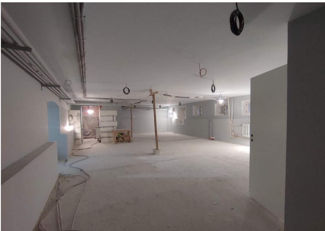
15. Объект культурного наследия федерального значения «Дом, где жили в 1912-1936 гг. – путешественник Грум-Гржимайло Г.Е., в 1914-1922 гг. – певец Шаляпин Ф.И.», по адресу: г. Санкт-Петербург, улица Графтио, дом 26, литера А. Общий вид пом. 1-Н (31) в уровне подвала.
