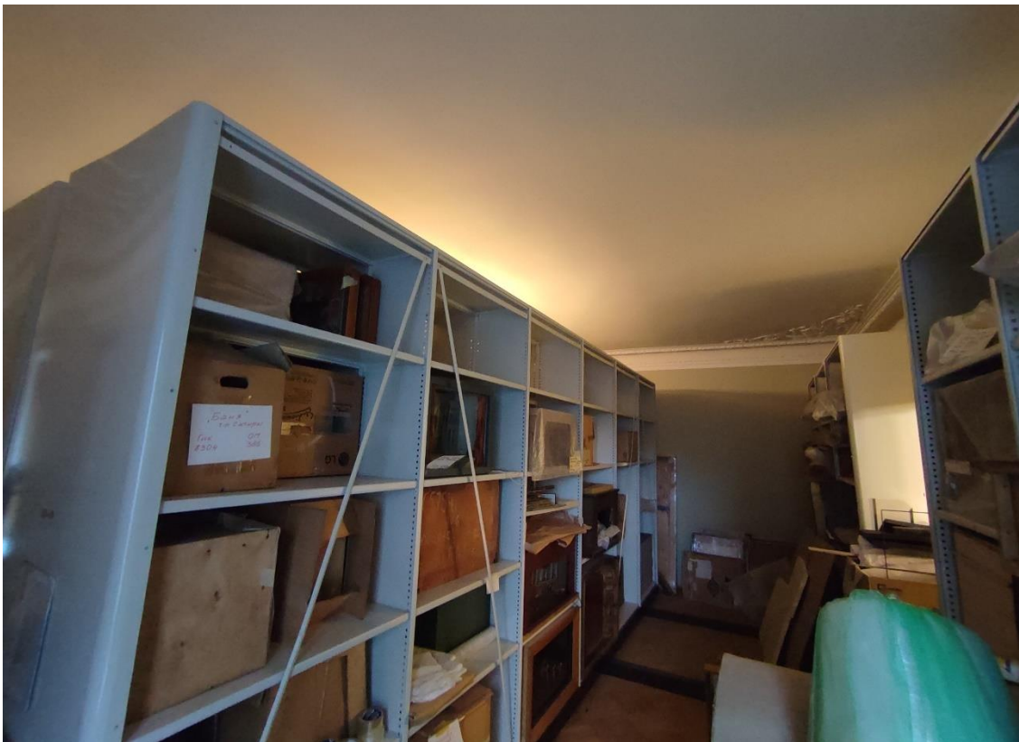
53. Объект культурного наследия федерального значения «Дом, где жили в 1912-1936 гг. – путешественник Грум-Гржимайло Г.Е., в 1914-1922 гг. – певец Шаляпин Ф.И.», по адресу: г. Санкт-Петербург, улица Графтио, дом 2б, литера А. Фрагмент пом. 1-Н (67) в уровне 3-го этажа.
