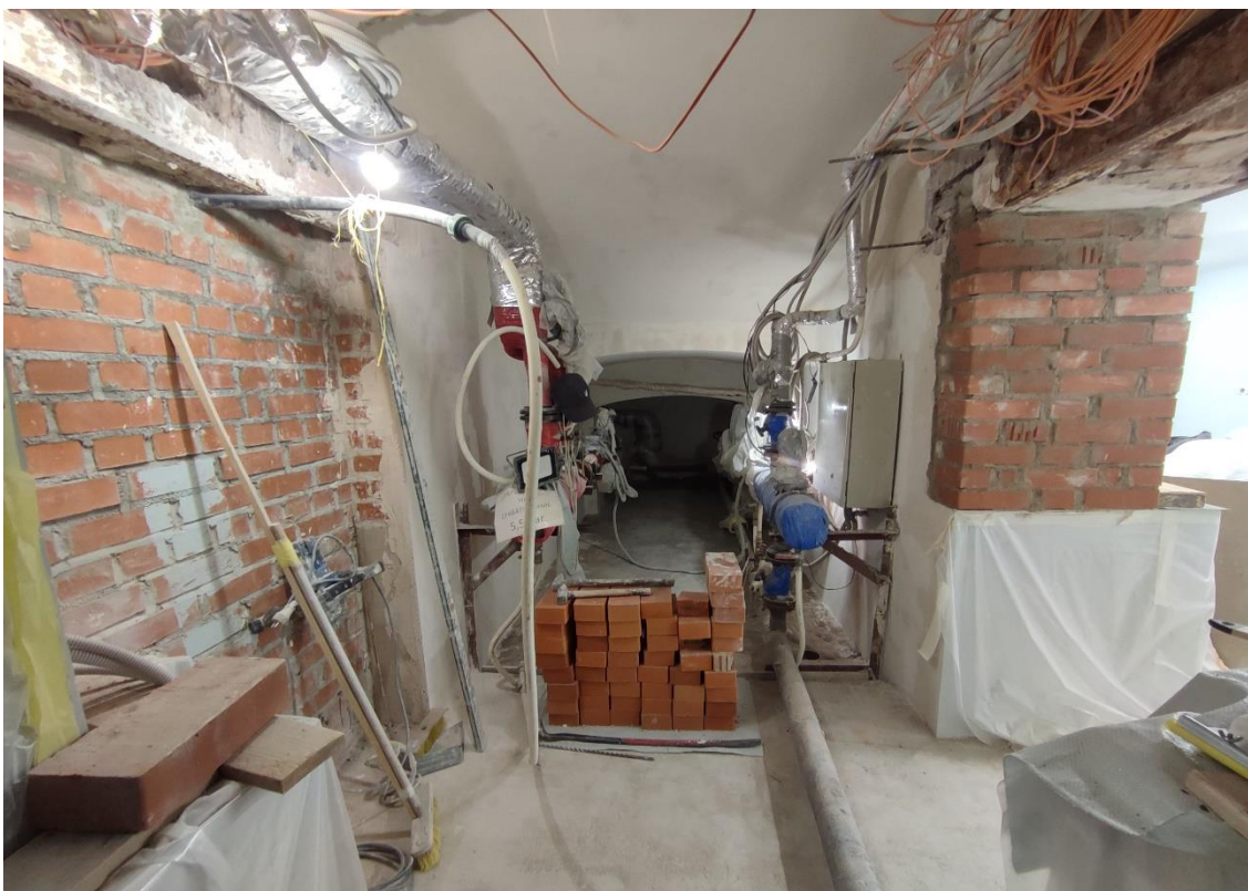
14. Объект культурного наследия федерального значения «Дом, где жили в 1912-1936 гг. – путешественник Грум-Гржимайло Г.Е., в 1914-1922 гг. – певец Шаляпин Ф.И.», по адресу: г. Санкт-Петербург, улица Графтио, дом 26, литера А. Общий вид пом. 1-Н (27) в уровне подвала.
