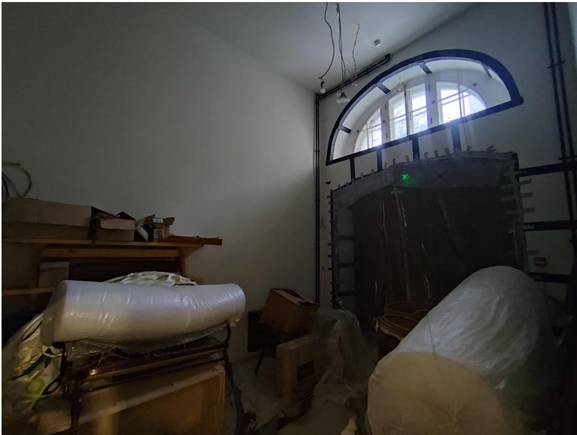
34. Объект культурного наследия федерального значения «Дом, где жили в 1912-1936 гг. – путешественник Грум-Гржимайло Г.Е., в 1914-1922 гг. – певец Шаляпин Ф.И.», по адресу: г. Санкт-Петербург, улица Графтио, дом 2б, литера А. Фрагмент пом. 2-Н (1) в уровне 1-го этажа.
