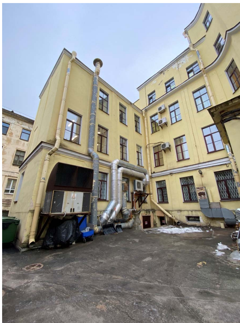
Фото №14. Северо-западный дворовый фасад, фрагмент.
