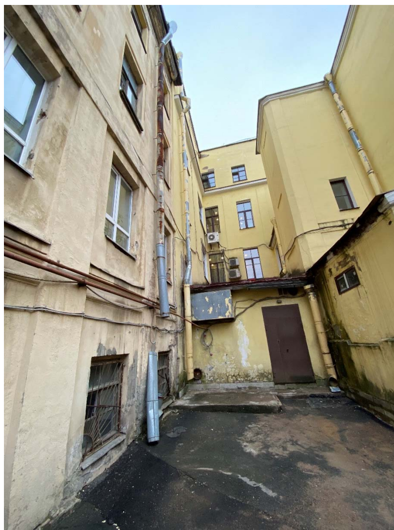
Фото №18. Северо-западный дворовый фасад, поздняя пристройка.
