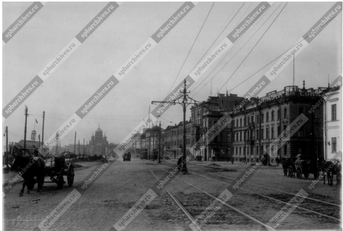
Илл. 40. Вид фасада здания Совторгфлота на набережной Лейтенанта Шмидта, дом №11. 1929 г. ЦГАКФФД СПб. Фотодокумент Гр 57761
