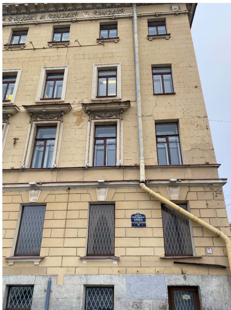
Фото №3. Юго-западный фасад, фрагмент.
