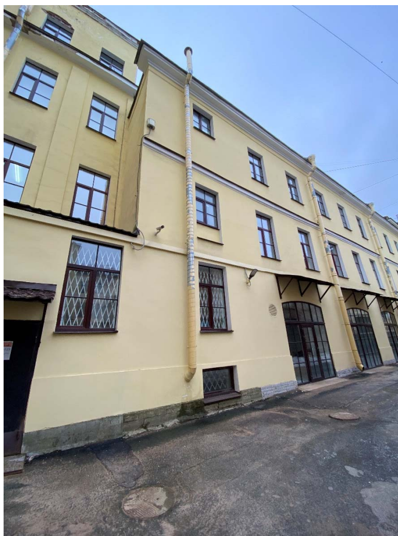
Фото №12. Северо-восточный фасад дворового флигеля, фрагмент.
