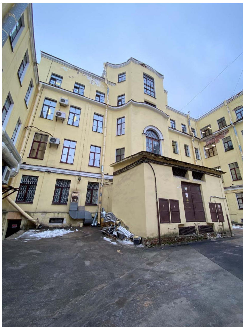
Фото №16. Северо-западный дворовый фасад, общий вид, поздняя пристройка подстанции.
