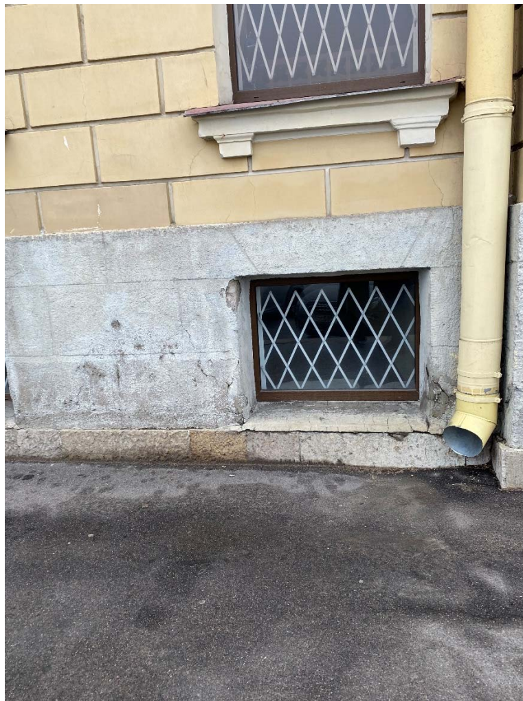
Фото №5. Юго-западный фасад, фрагмент.
