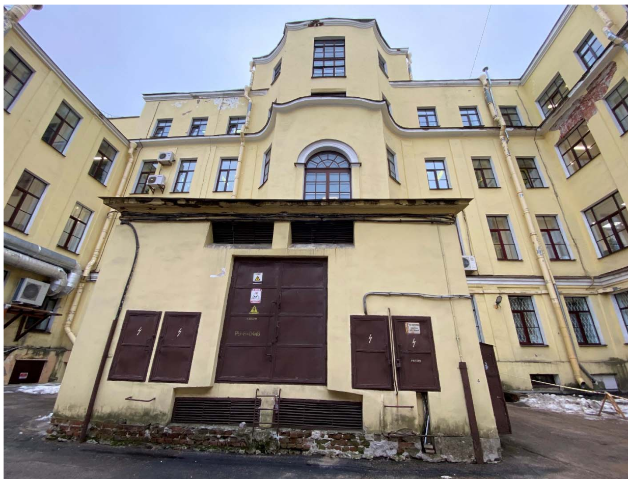
Фото №13. Северо-западный дворовый фасад, поздняя пристройка трансформаторной подстанции.
