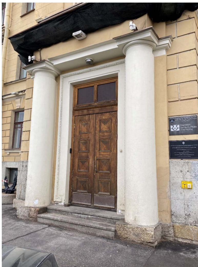
Фото №6. Юго-западный фасад, главный вход в здание.
