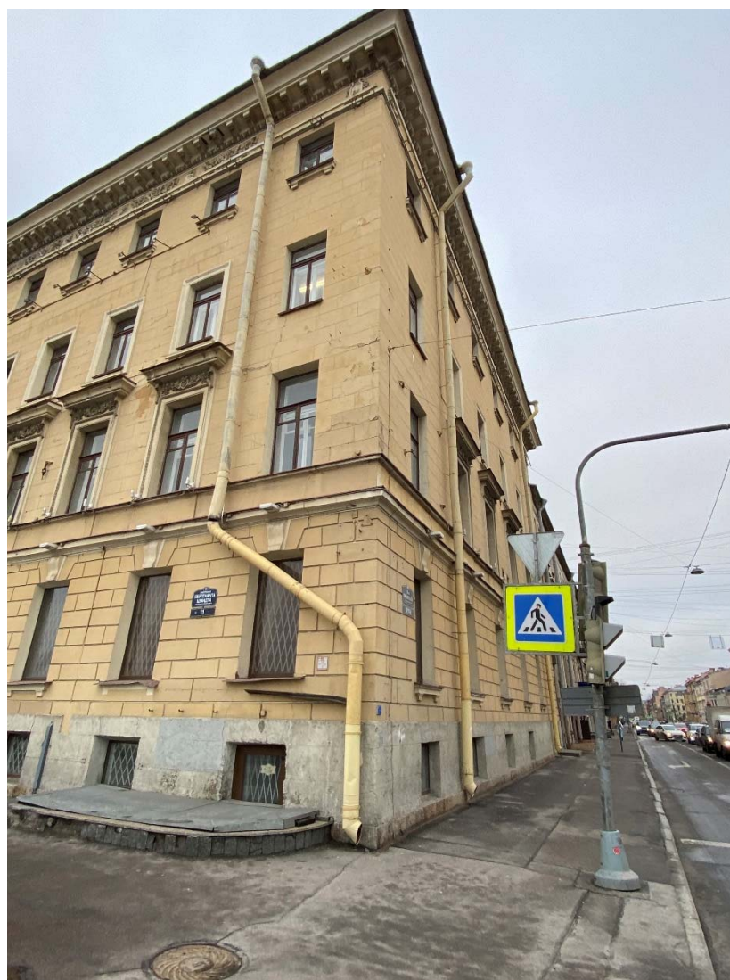
Фото №8. Угол юго-западного и северо-восточного фасадов.
