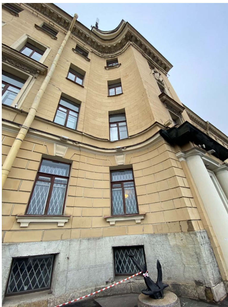
Фото №7. Юго-западный фасад, фрагмент.
