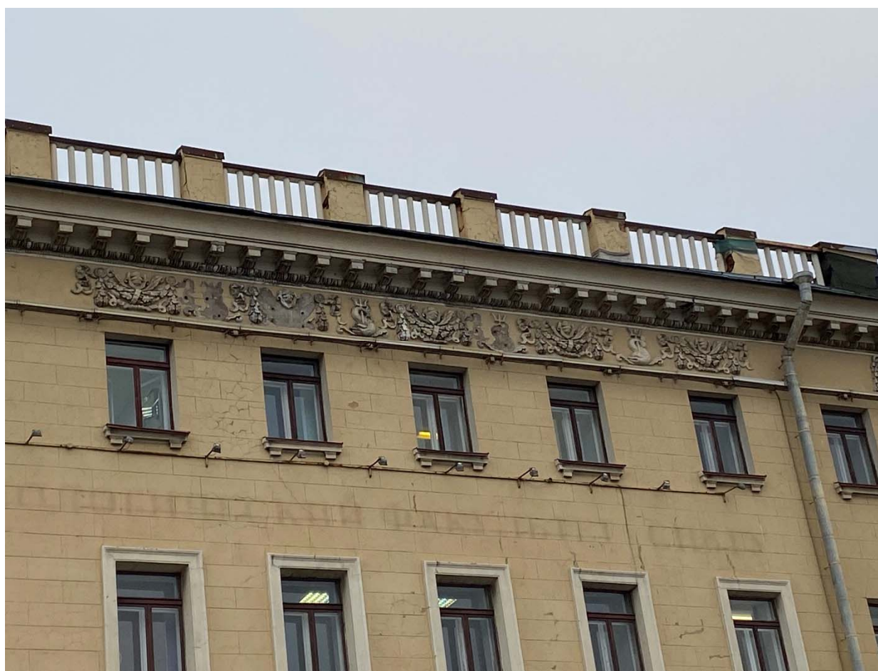
Фото №2. Юго-западный фасад, фрагмент, карнизная часть.
