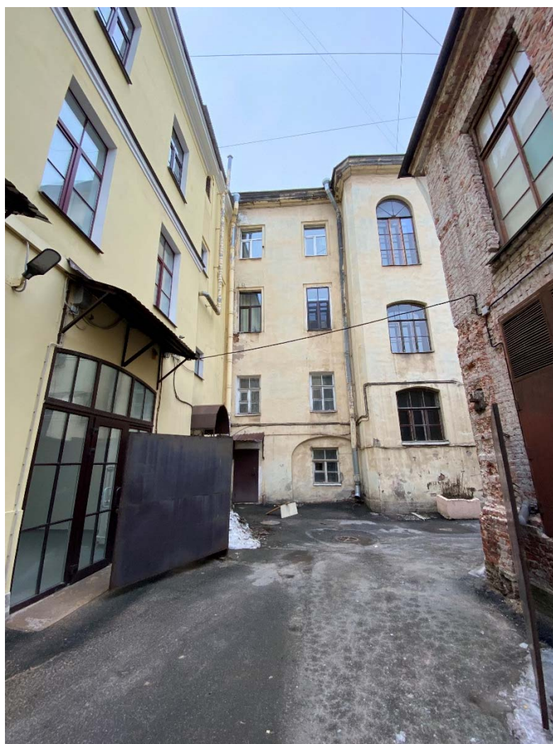
Фото №20. Северо-восточный фасад дворового флигеля, фрагмент.
