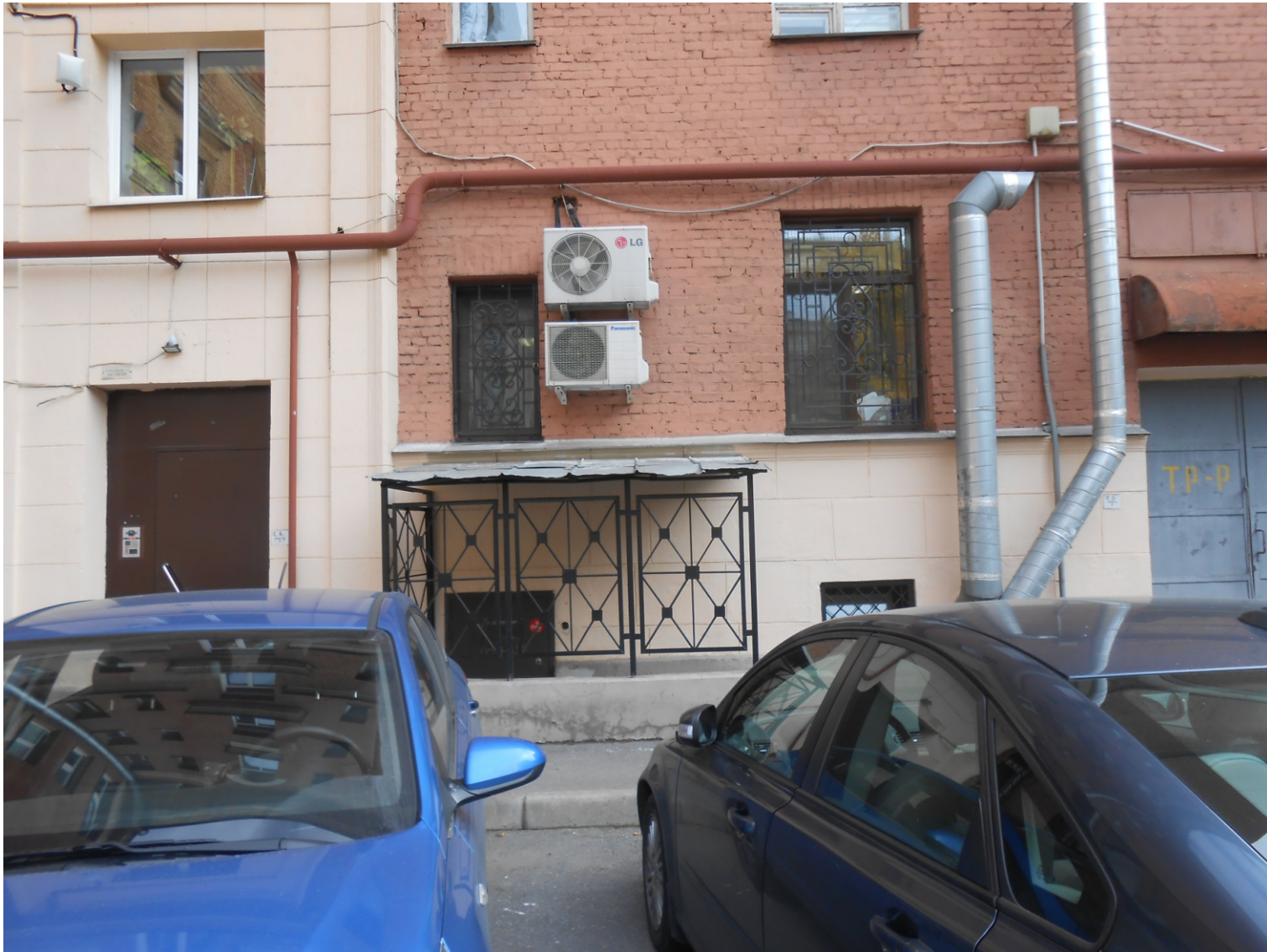
8. “Жилой дом”. Санкт-Петербург, Московский район, ул. Бассейная, д. 41, лит. А. Фасад со стороны двора. Фрагмент. Фото: 01.09.2021г.
