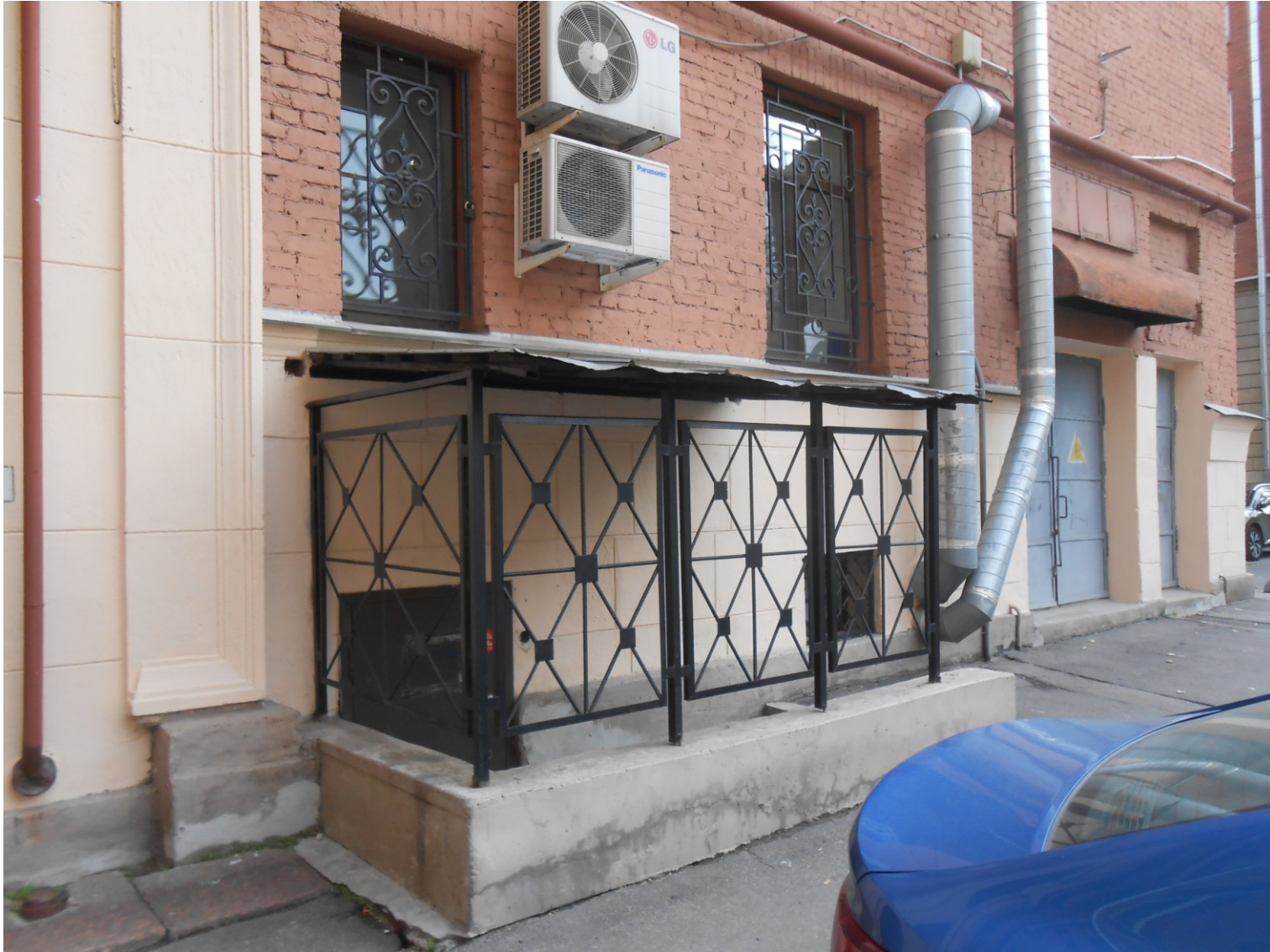
10. “Жилой дом”. Санкт-Петербург, Московский район, ул. Бассейная, д. 41, лит. А. Фасад со стороны двора. Фрагмент. Фото: 01.09.2021г.
