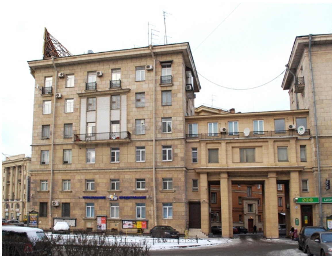
Ил.11 Фасад со стороны ул. Победы. Соединительная галерея к дому 16 по ул. Победы. Фото 24.01.2009 — CityWalls — Архитектурный сайт Санкт-Петербурга [Электронный ресурс]. URL: http://www.citywalls.ru/photo148139.html
