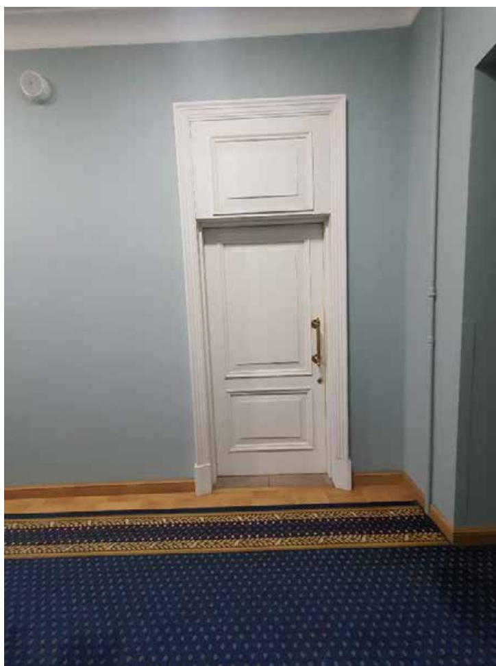
5. Дверное заполнение из помещения 1120 в уровне 1-го этажа объекта культурного наследия федерального значения «Дворец Таврический. Дворец», расположенного по адресу: г. Санкт-Петербург, ул. Шпалерная, д. 47, лит. А. 17.10.2022
