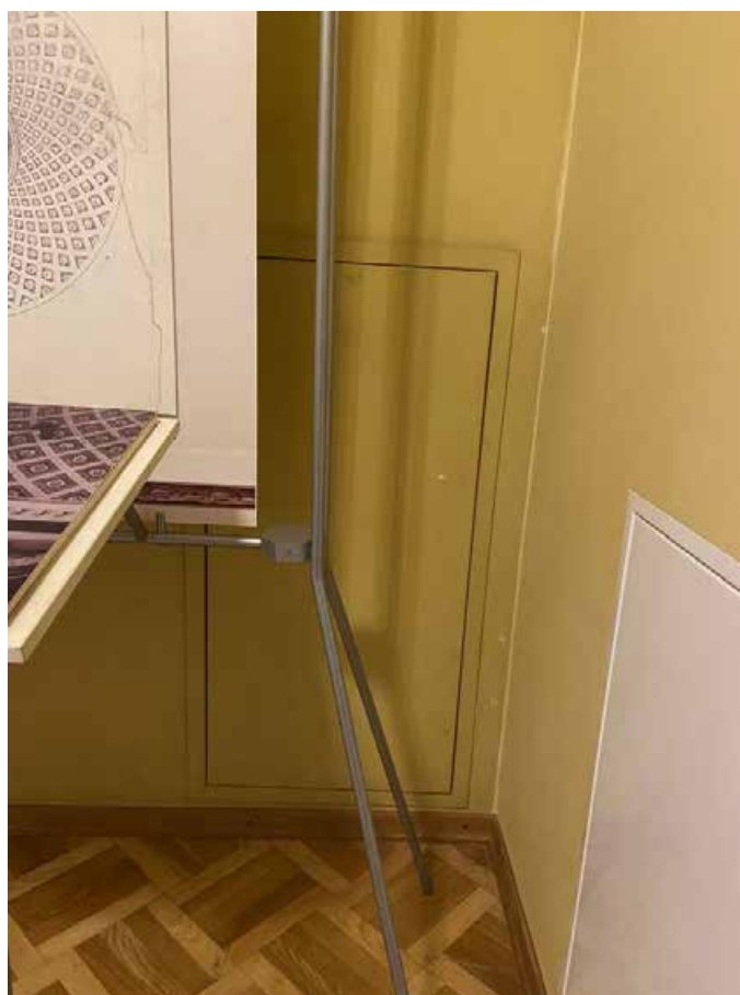
11. Дверное заполнение помещения 2001 в уровне 1-го этажа объекта культурного наследия федерального значения «Дворец Таврический. Дворец», расположенного по адресу: г. Санкт-Петербург, ул. Шпалерная, д. 47, лит. А. 17.10.2022
