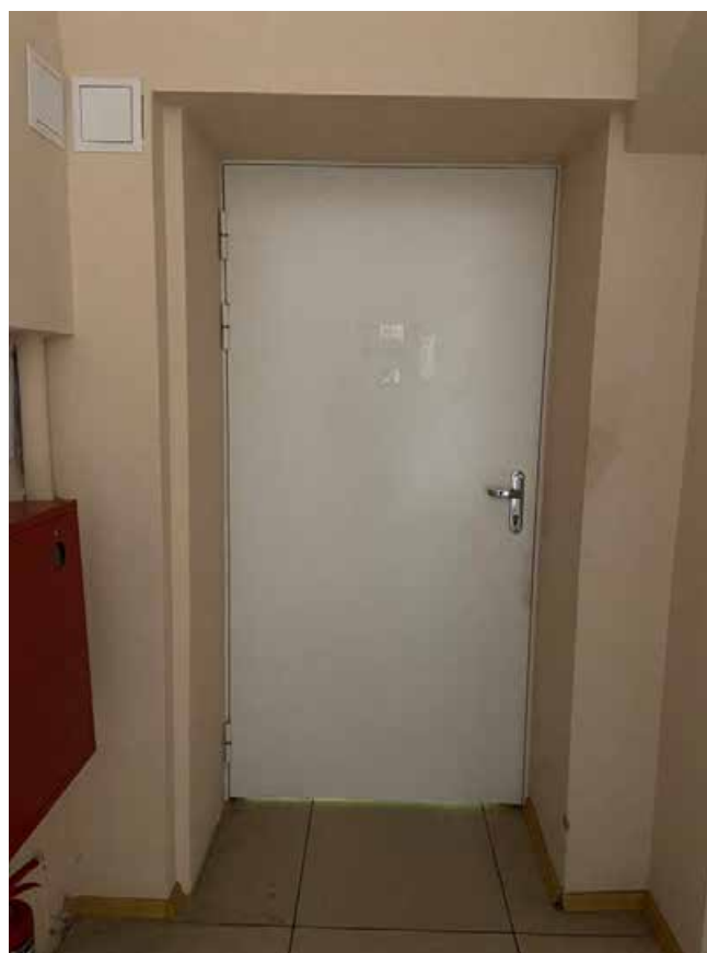
9. Дверное заполнение помещения 1176 в уровне 1-го этажа объекта культурного наследия федерального значения «Дворец Таврический. Дворец», расположенного по адресу: г. Санкт-Петербург, ул. Шпалерная, д. 47, лит. А. 17.10.2022
