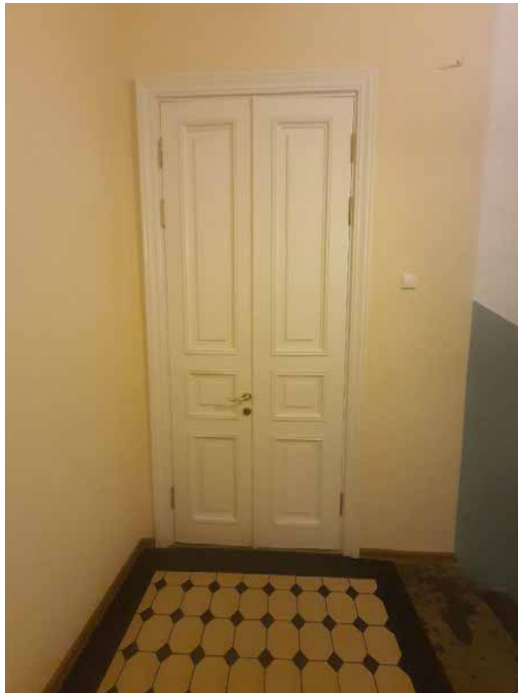
27. Дверное заполнение помещения 3180 в уровне 2-го этажа объекта культурного наследия федерального значения «Дворец Таврический. Дворец», расположенного по адресу: г. Санкт-Петербург, ул. Шпалерная, д. 47, лит. А. 17.10.2022
