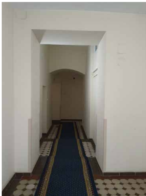
6. Коридор, помещение 1212, в уровне 1-го этажа объекта культурного наследия федерального значения «Дворец Таврический. Дворец», расположенного по адресу: г. Санкт-Петербург, ул. Шпалерная, д. 47, лит. А. 17.10.2022
