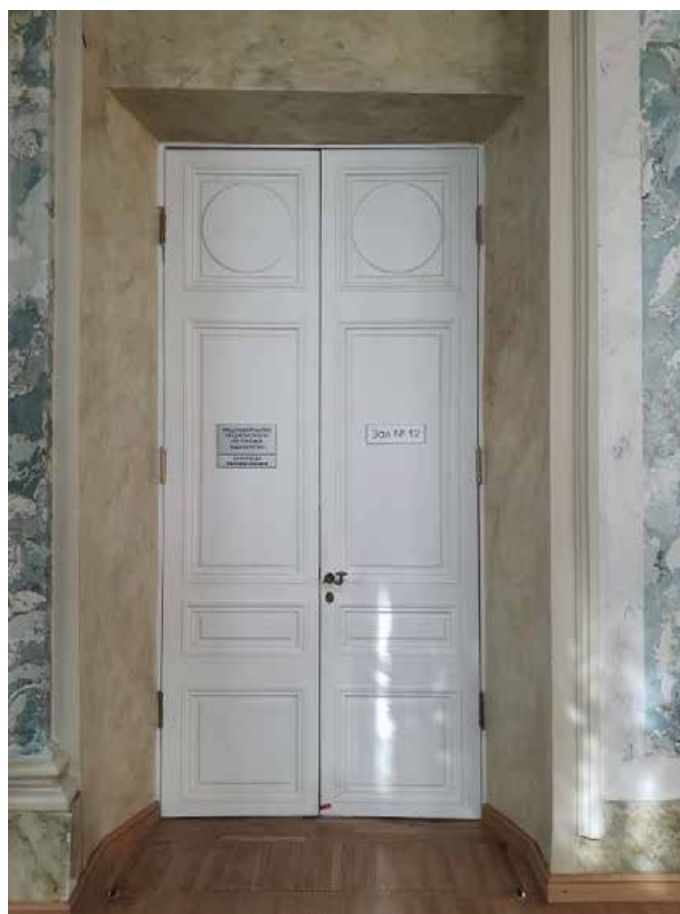
2. Дверное заполнение из помещения 1125 в уровне 1-го этажа объекта культурного наследия федерального значения «Дворец Таврический. Дворец», расположенного по адресу: г. Санкт-Петербург, ул. Шпалерная, д. 47, лит. А. 17.10.2022
