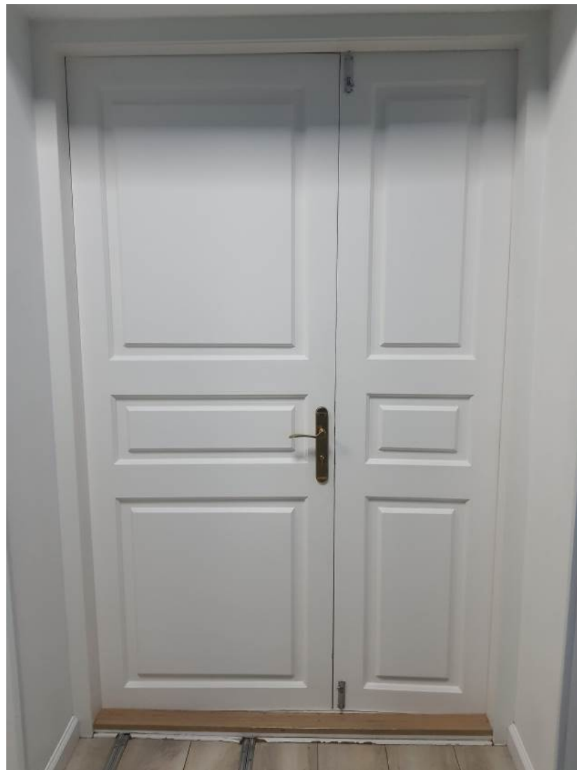
22. Дверное заполнение помещения 3106 в уровне 2-го этажа объекта культурного наследия федерального значения «Дворец Таврический. Дворец», расположенного по адресу: г. Санкт-Петербург, ул. Шпалерная, д. 47, лит. А. 17.10.2022
