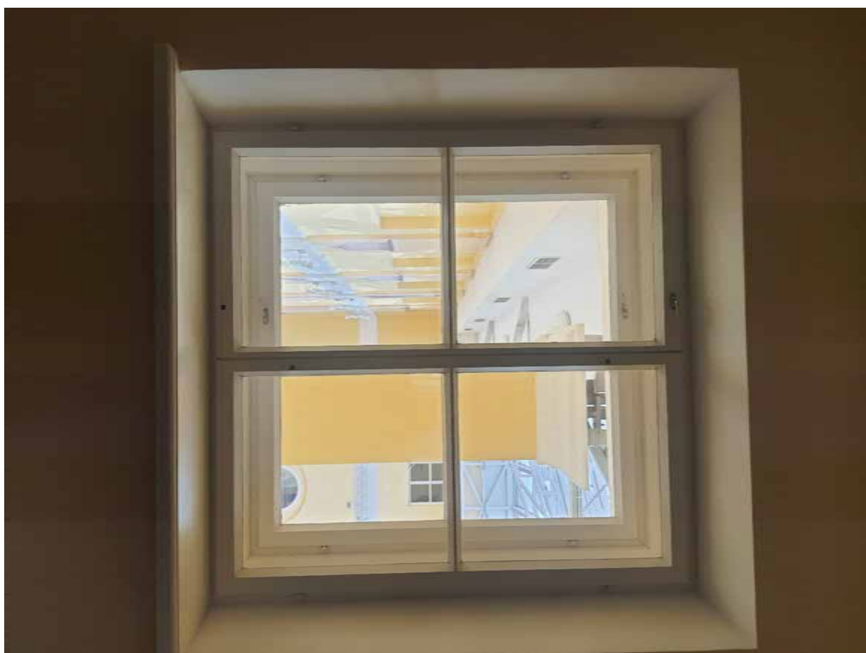
34. Оконное заполнение в уровне 2-го этажа объекта культурного наследия федерального значения «Дворец Таврический. Дворец», расположенного по адресу: г. Санкт-Петербург, ул. Шпалерная, д. 47, лит. А. 17.10.2022
