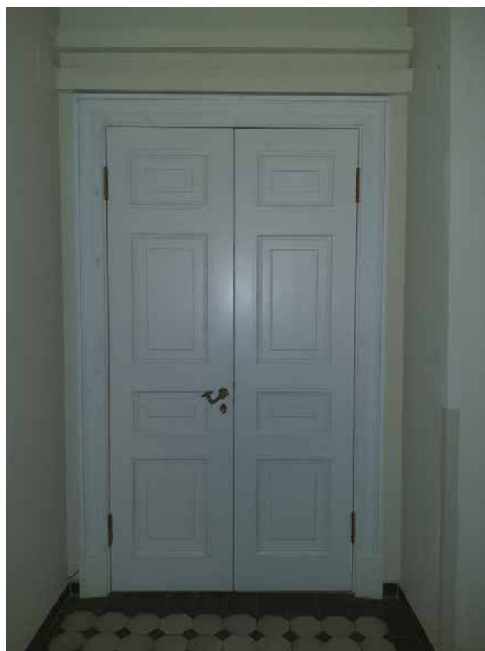
8. Дверное заполнение помещения 1200 в уровне 1-го этажа объекта культурного наследия федерального значения «Дворец Таврический. Дворец», расположенного по адресу: г. Санкт-Петербург, ул. Шпалерная, д. 47, лит. А. 17.10.2022
