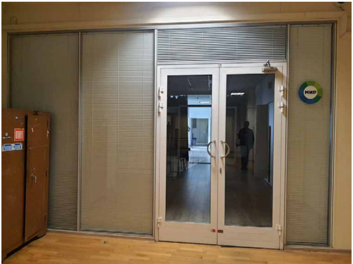
28. Дверное заполнение помещения 3202 в уровне 2-го этажа объекта культурного наследия федерального значения «Дворец Таврический. Дворец», расположенного по адресу: г. Санкт-Петербург, ул. Шпалерная, д. 47, лит. А. 17.10.2022
