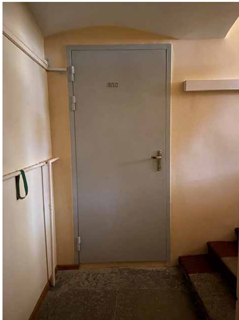
24. Дверное заполнение помещения 3160 в уровне 2-го этажа объекта культурного наследия федерального значения «Дворец Таврический. Дворец», расположенного по адресу: г. Санкт-Петербург, ул. Шпалерная, д. 47, лит. А. 17.10.2022
