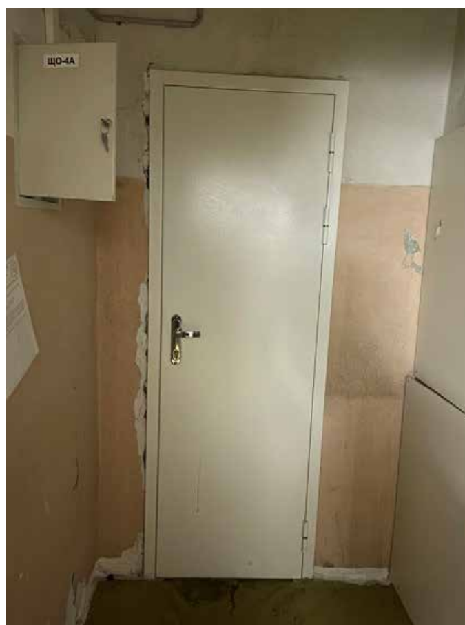
10. Дверное заполнение помещения 1161 в уровне 1-го этажа объекта культурного наследия федерального значения «Дворец Таврический. Дворец», расположенного по адресу: г. Санкт-Петербург, ул. Шпалерная, д. 47, лит. А. 17.10.2022
