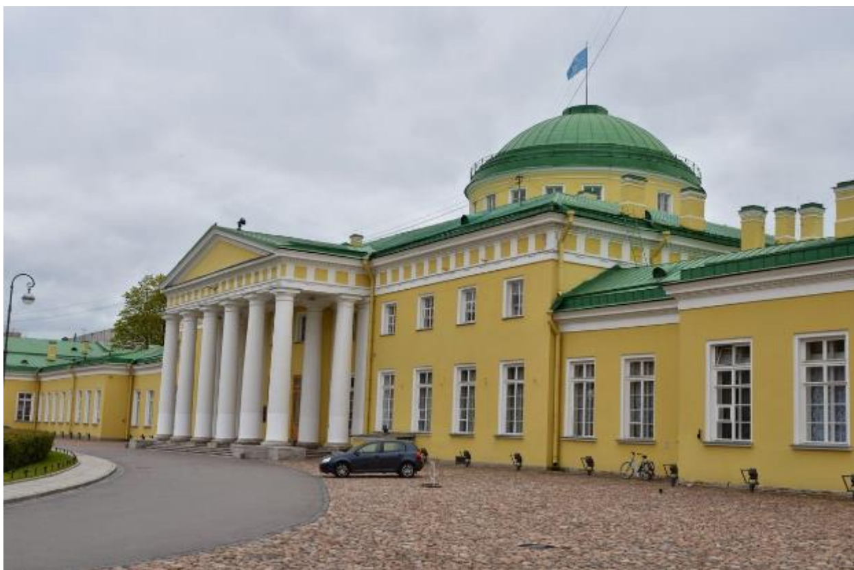
1. Северный фасад объекта культурного наследия федерального значения «Дворец Таврический. Дворец», расположенного по адресу: г. Санкт-Петербург, ул. Шпалерная, д. 47, лит. А. 17.10.2022
