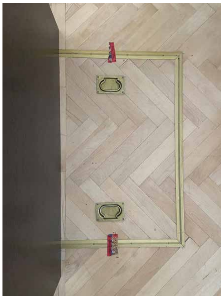
16. Люк помещения 1072 в уровне 1-го этажа объекта культурного наследия федерального значения «Дворец Таврический. Дворец», расположенного по адресу: г. Санкт-Петербург, ул. Шпалерная, д. 47, лит. А. 17.10.2022
