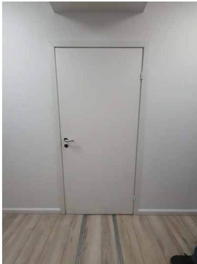
21. Дверное заполнение помещения 3107 в уровне 2-го этажа объекта культурного наследия федерального значения «Дворец Таврический. Дворец», расположенного по адресу: г. Санкт-Петербург, ул. Шпалерная, д. 47, лит. А. 17.10.2022
