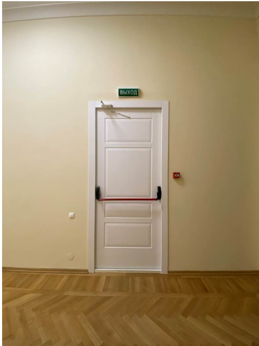
26. Дверное заполнение помещения 3059 в уровне 2-го этажа объекта культурного наследия федерального значения «Дворец Таврический. Дворец», расположенного по адресу: г. Санкт-Петербург, ул. Шпалерная, д. 47, лит. А. 17.10.2022
