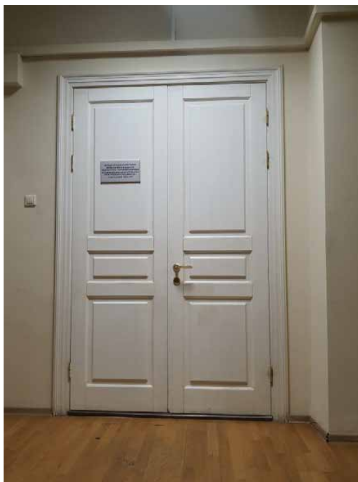
19. Дверное заполнение помещения 3131 в уровне 1-го этажа объекта культурного наследия федерального значения «Дворец Таврический. Дворец», расположенного по адресу: г. Санкт-Петербург, ул. Шпалерная, д. 47, лит. А. 17.10.2022
