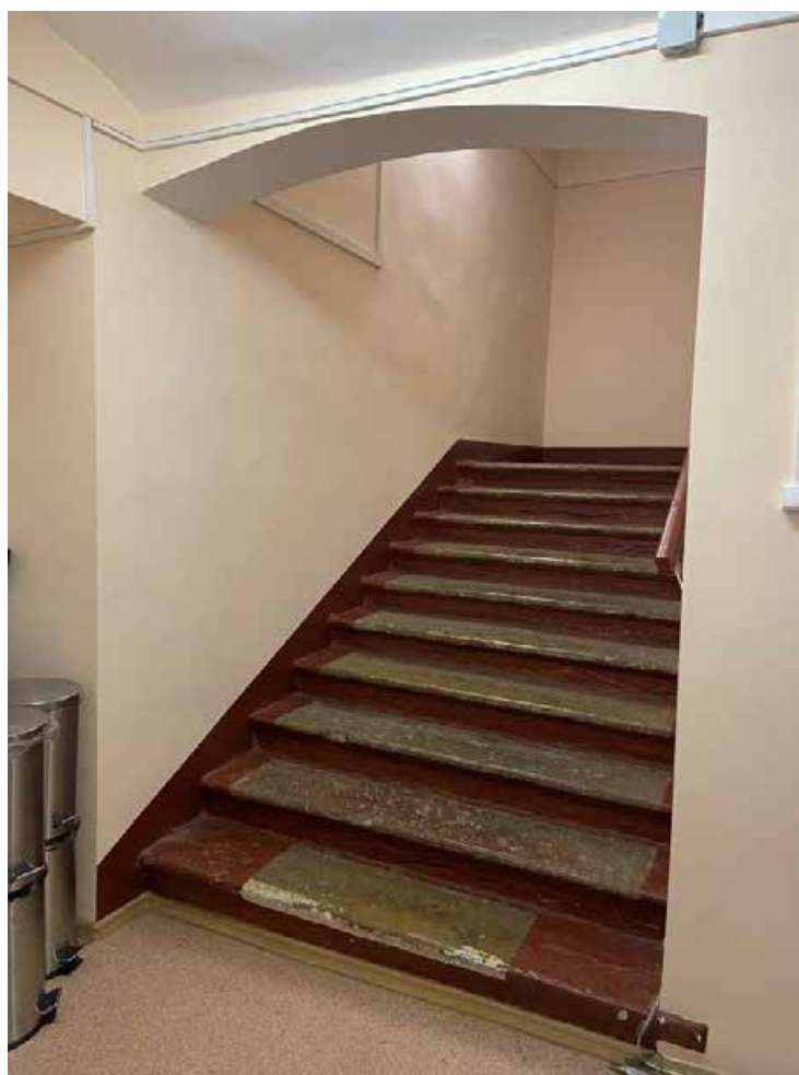
12. Лестничная клетка, помещение 1004, в уровне 1-го этажа объекта культурного наследия федерального значения «Дворец Таврический. Дворец», расположенного по адресу: г. Санкт-Петербург, ул. Шпалерная, д. 47, лит. А. 17.10.2022
