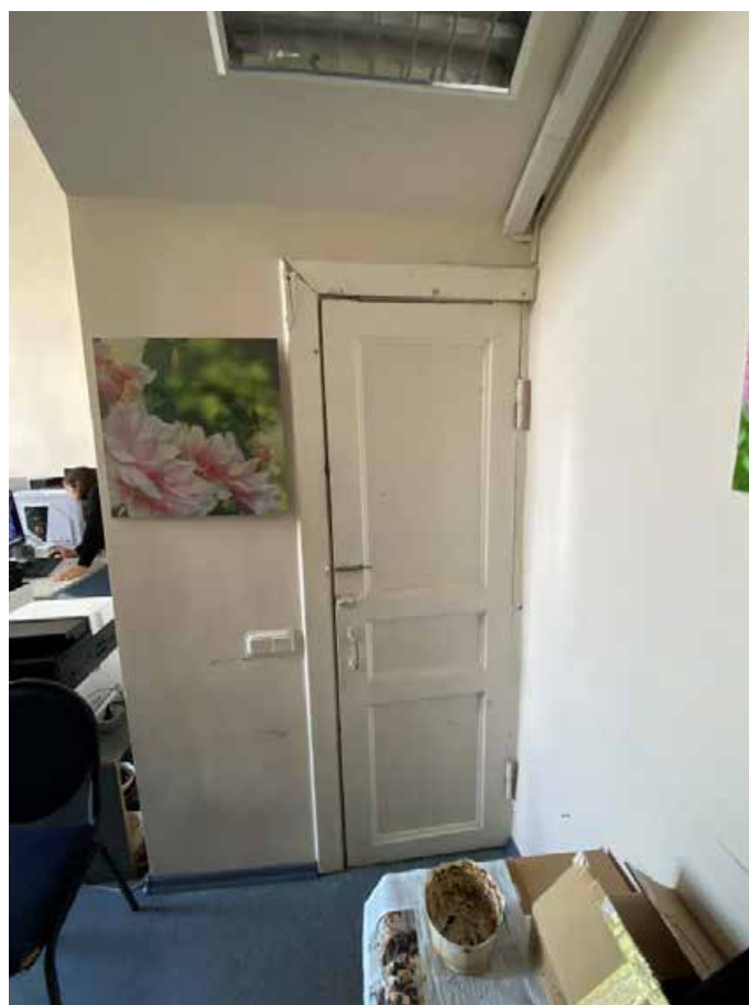
13. Дверное заполнение помещения 1191 в уровне 1-го этажа объекта культурного наследия федерального значения «Дворец Таврический. Дворец», расположенного по адресу: г. Санкт-Петербург, ул. Шпалерная, д. 47, лит. А. 17.10.2022
