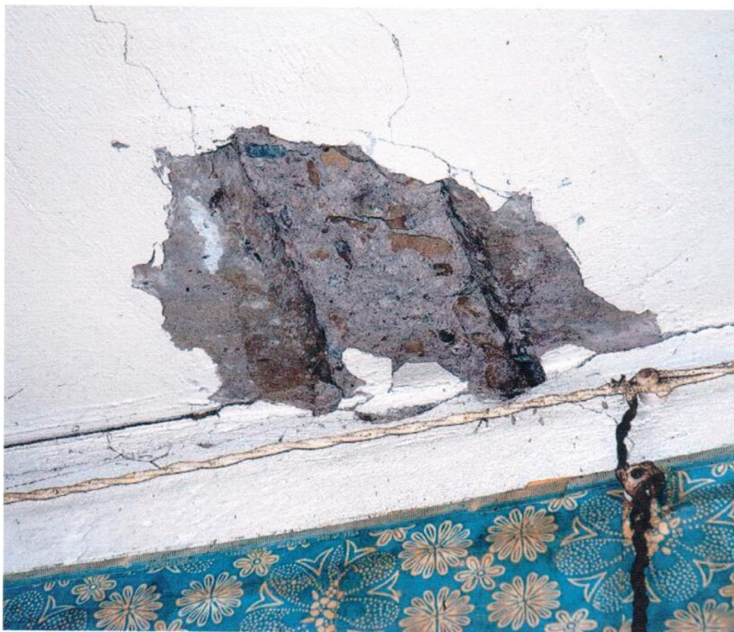
Фрагмент низа чердачного перекрытия
