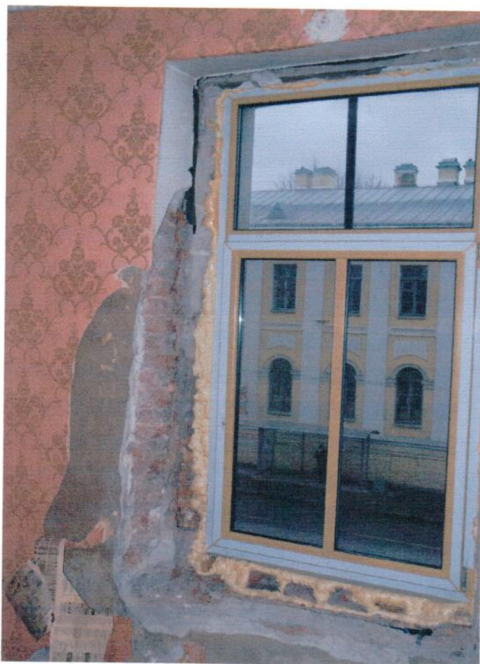
Оконные проемы второго этажа
