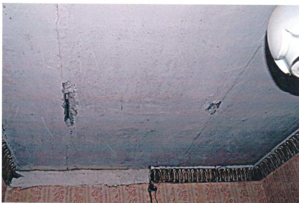
Фрагмент междуэтажного перекрытия
