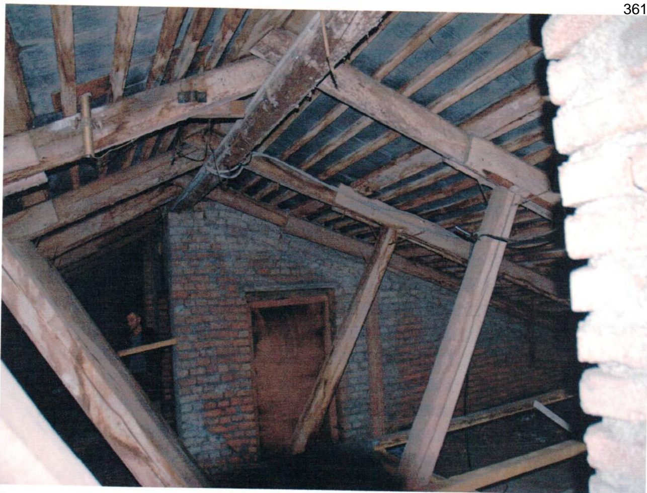
Фрагмент стропильной системы
