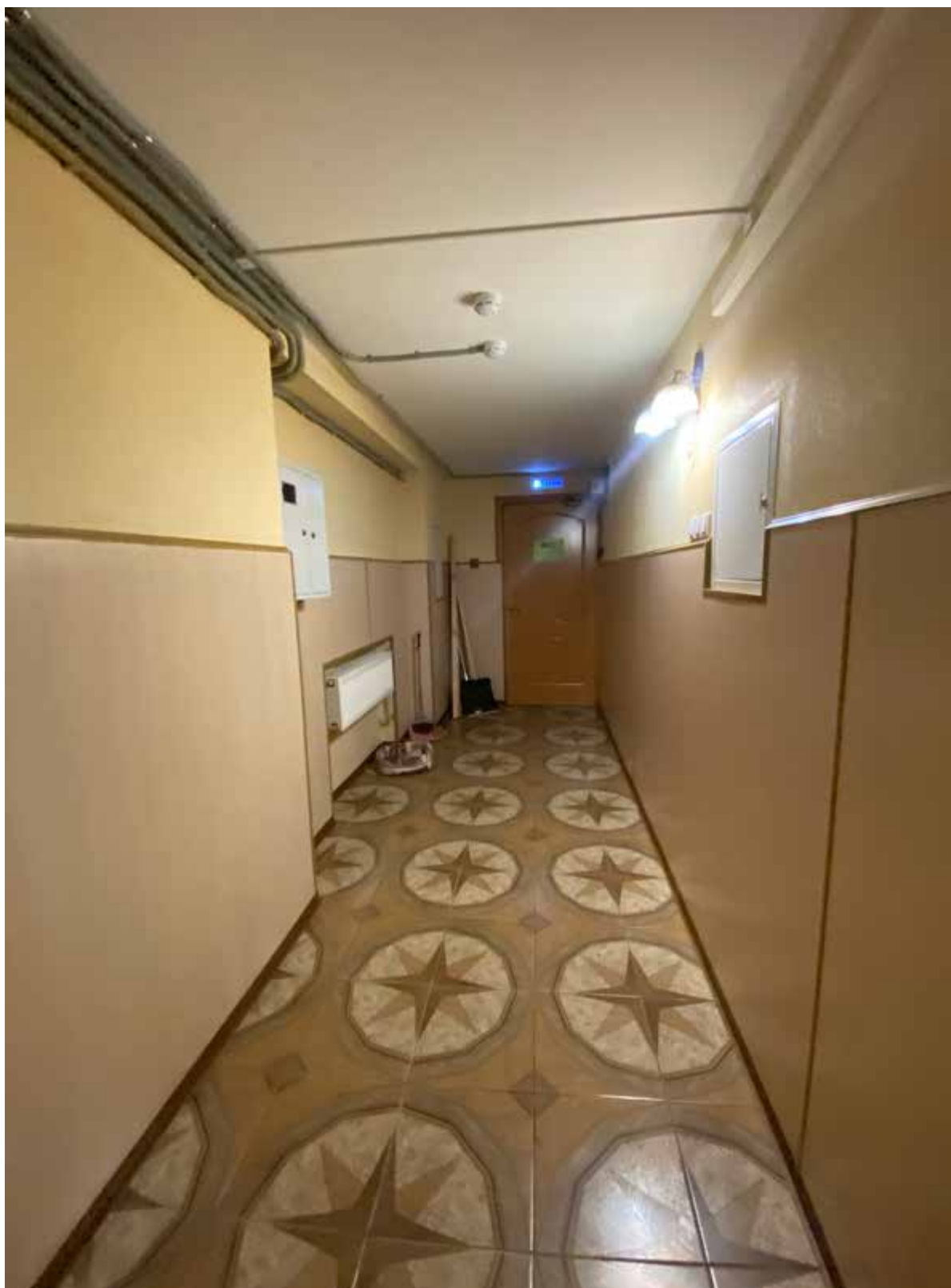
19. Фрагмент интерьера цокольного этажа
