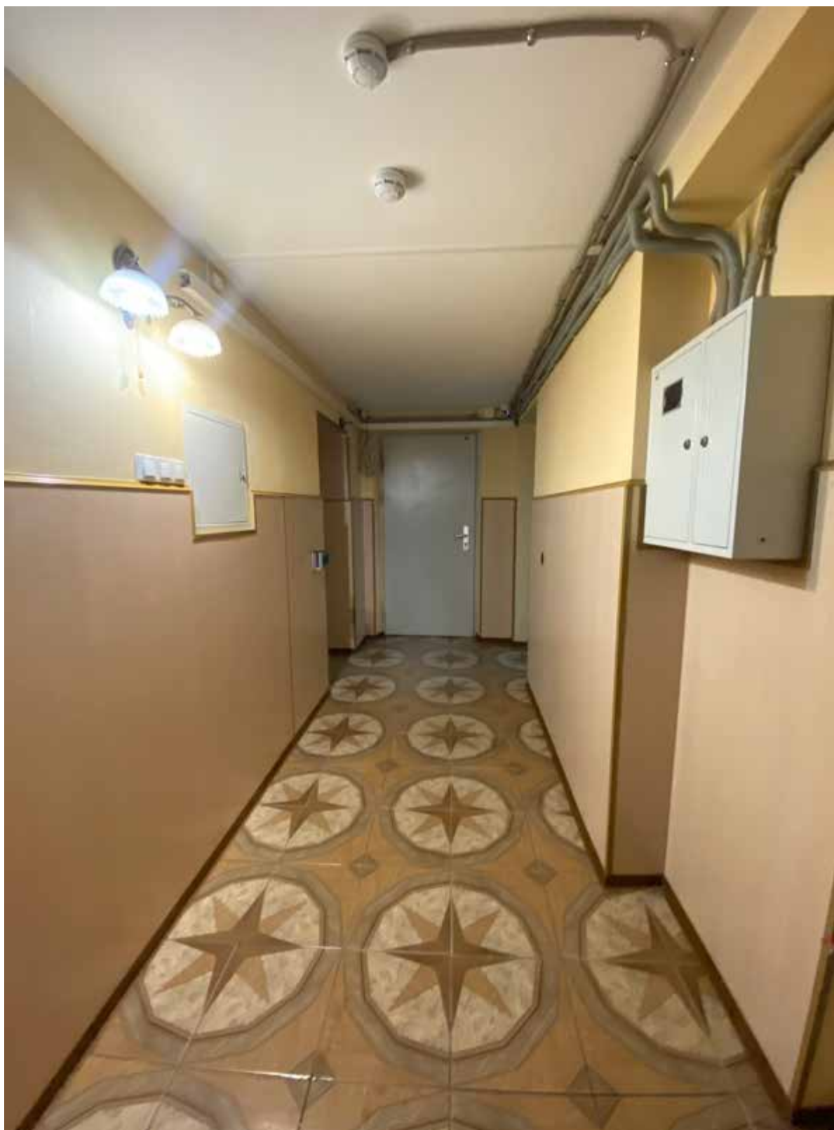
13. Фрагмент интерьера цокольного этажа
