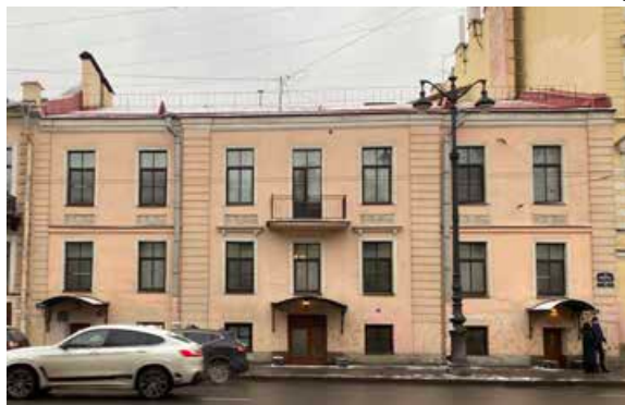
Фасад по 1 линии
