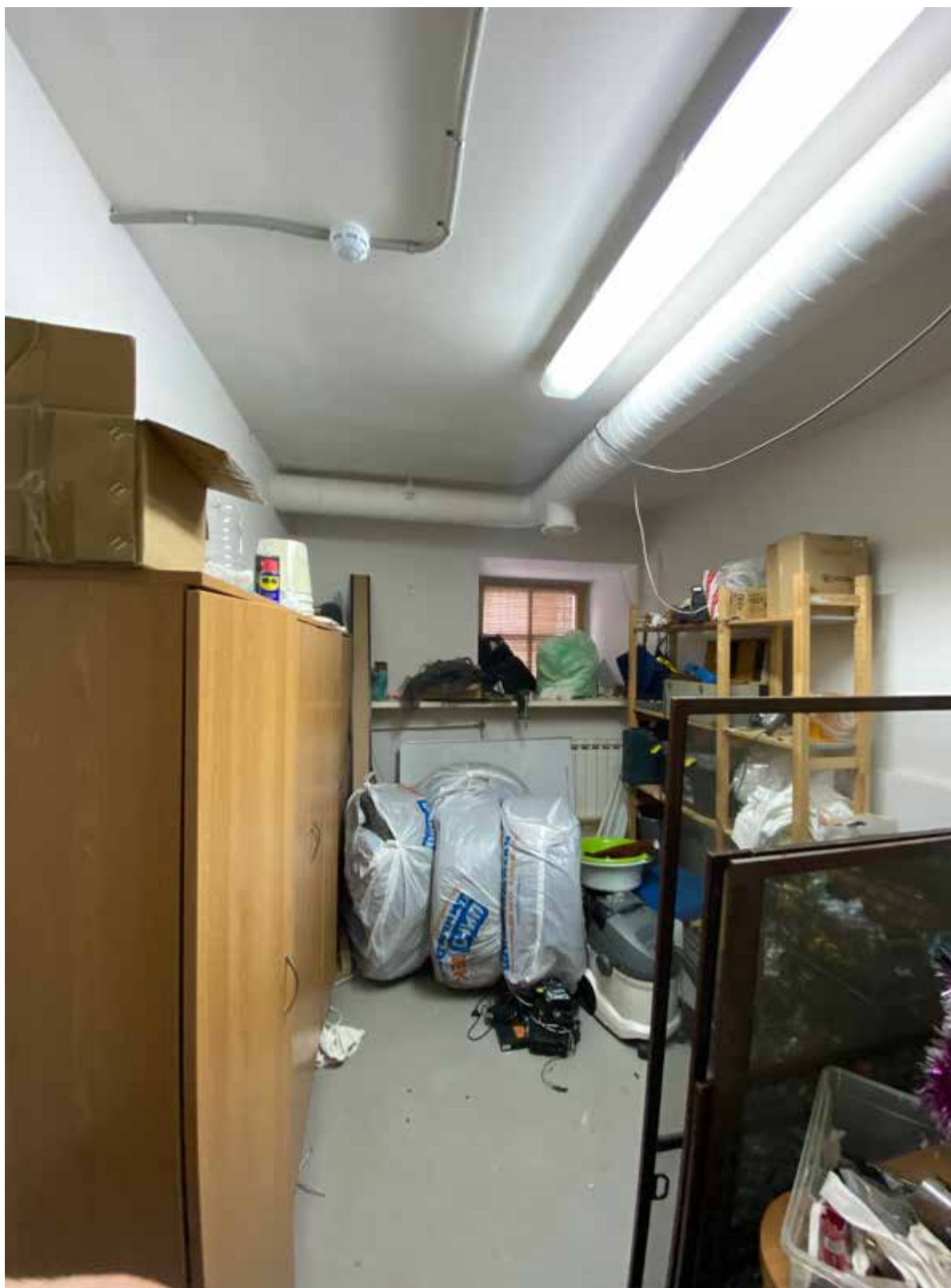
25. Фрагмент интерьера цокольного этажа
