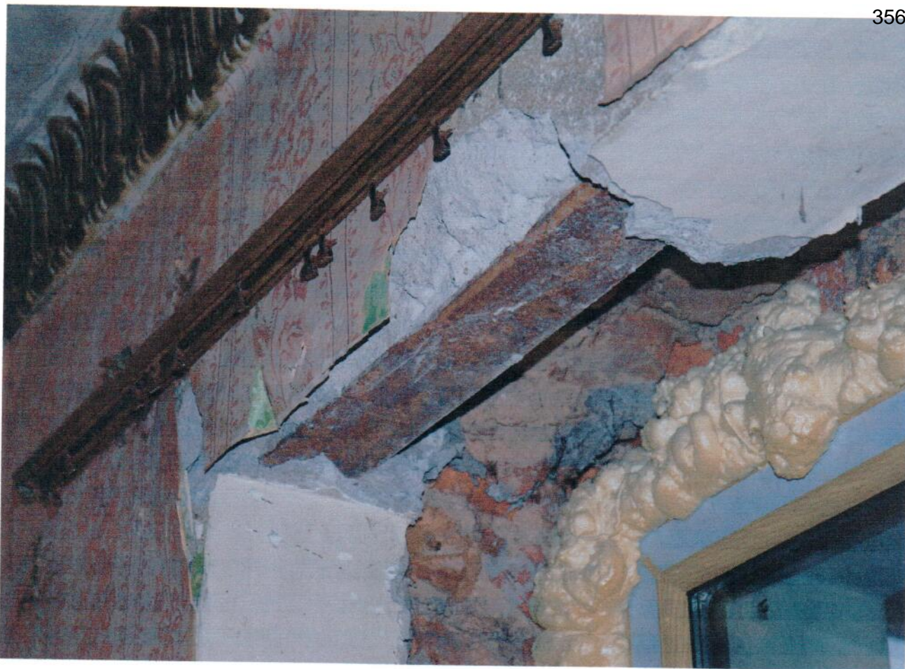
Фрагмент оконного заполнения
