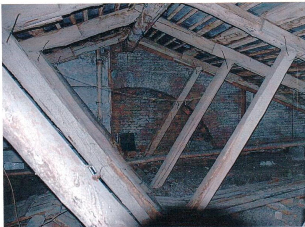
Фрагмент стропильной системы крыши здания
