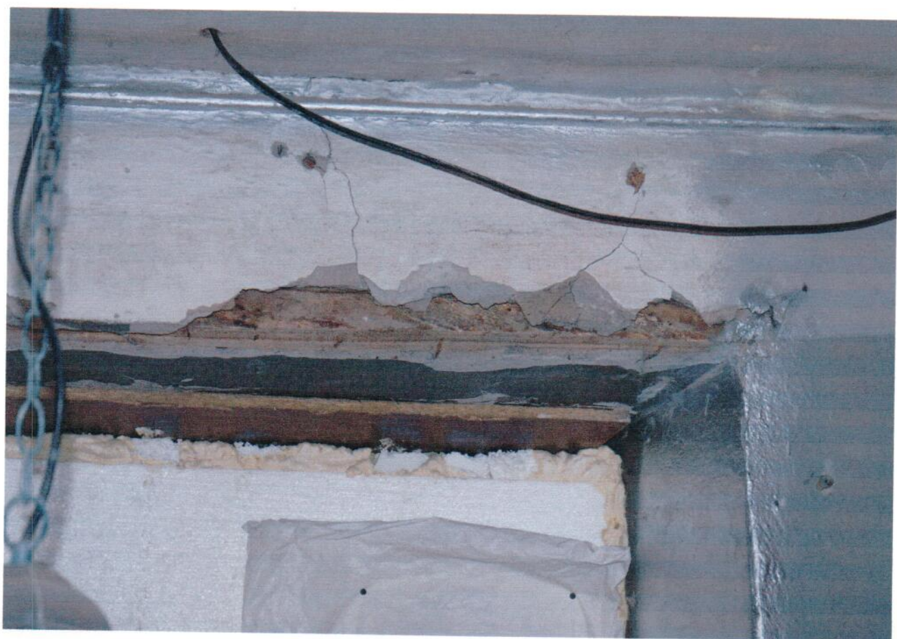
Фрагмент оконного заполнения
