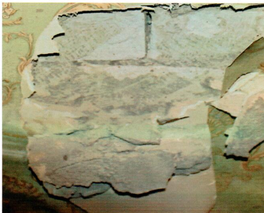
Кладка внутренних стен ( силикатный кирпич на цементно-песчаном растворе)
