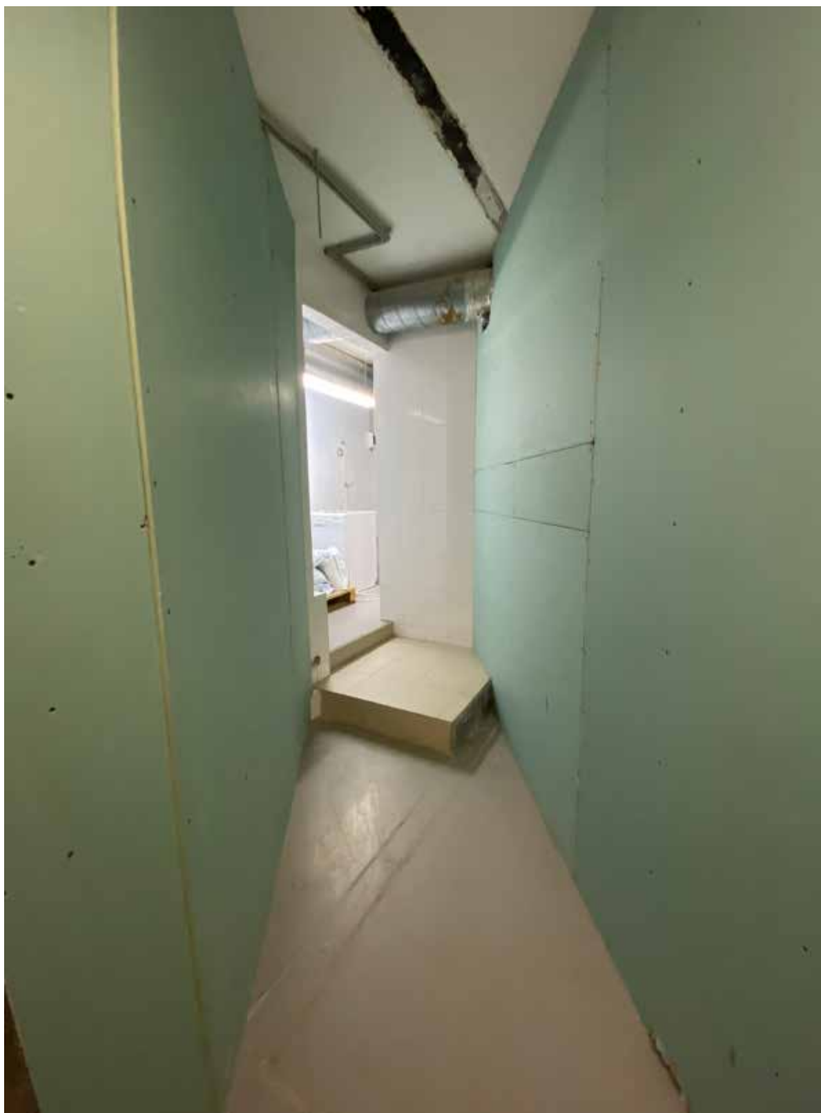
31. Фрагмент интерьера цокольного этажа
