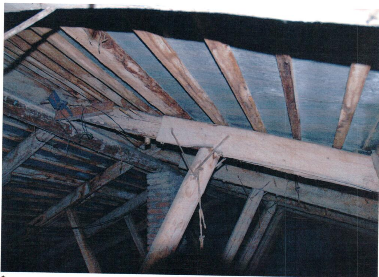
Фрагмент стропильной системы
