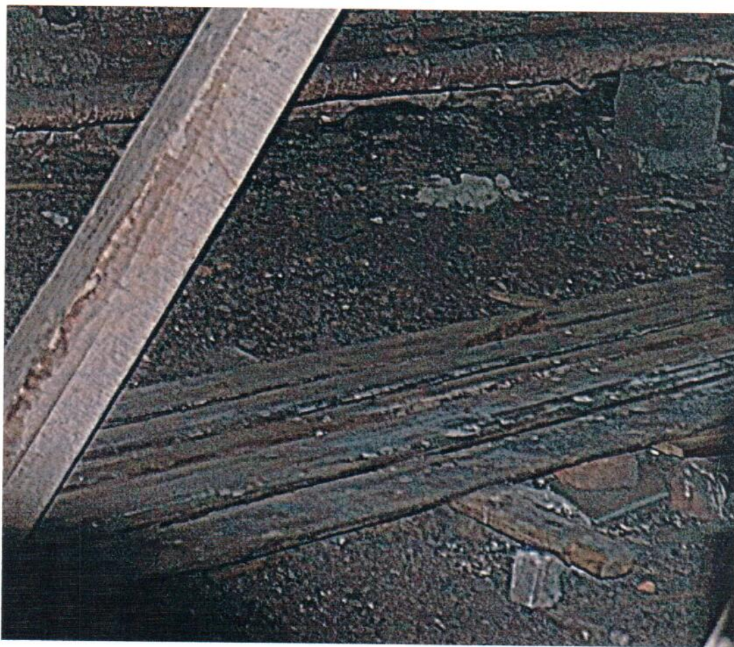
Фрагмент верха чердачного перекрытия
