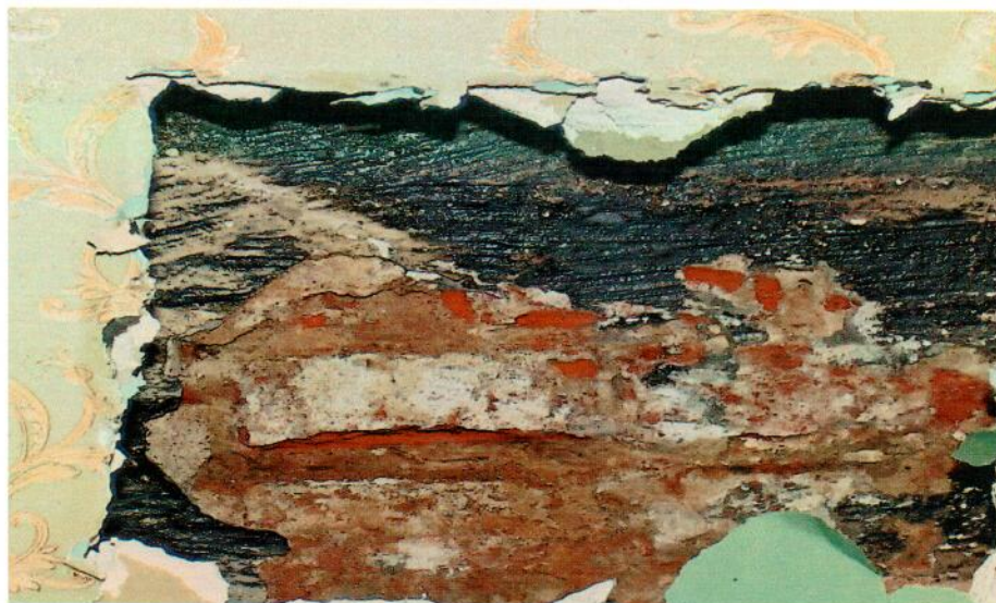
Кладка наружной стены (полнотелый кирпич на известковом растворе)
